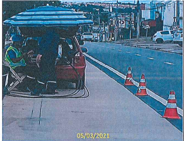
Foto 20 Fusionamento dos cabos de fibra-ótica
