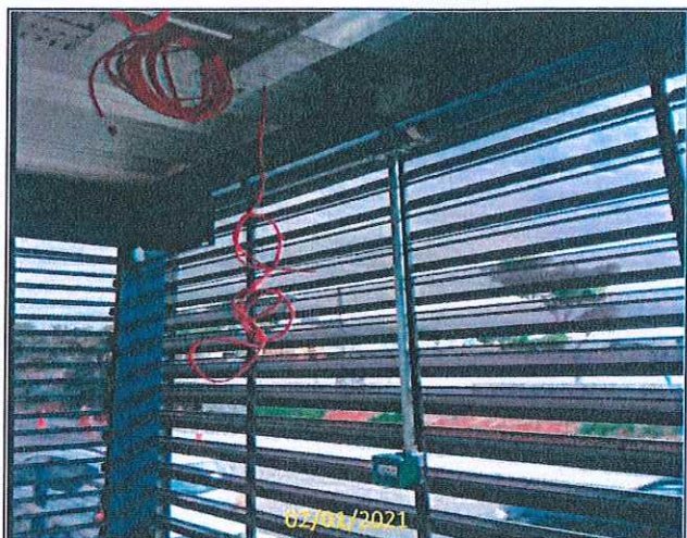
Foto 01 instalação das botoeiras de emergência
