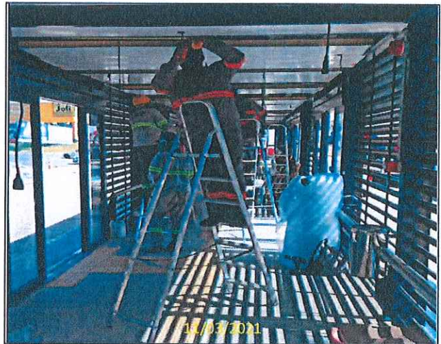
Foto 24 Passagem dos cabos aéreos
