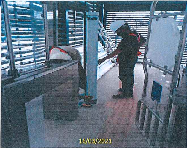
Foto 29 Instalação do Totem de comunicação fixa
