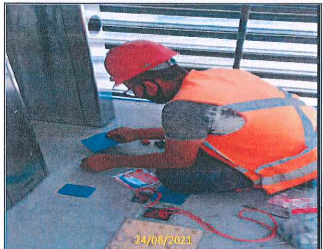
Foto 08 Ligação das catracas a rede de alimentação
