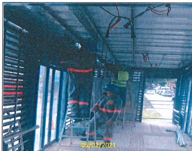
Foto 04 Lançamento dos cabos
