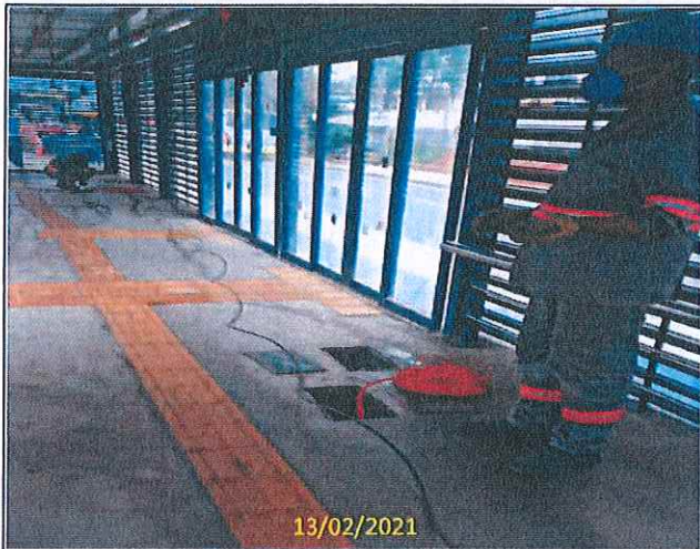
Foto 13 Lançamento dos cabos
