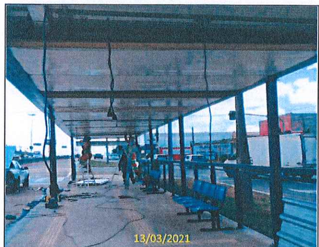
Foto 26 Instalação dos dispositivos de ITS do abrigo da estação Eco
