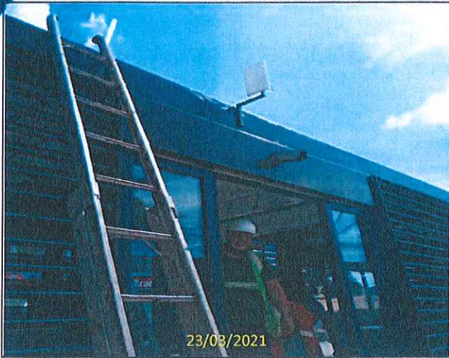
Foto 41 Instalação do sensor de abertura das portas e Wi-fi
