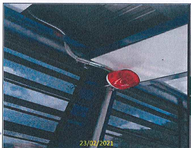
Foto 16 Instalação de dispositivo de emergência
