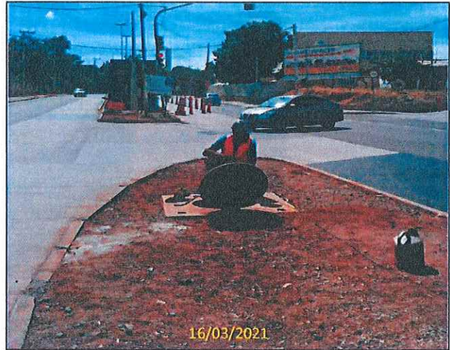
Foto 30 Passagem do cabo-guia da fibra ótica nos dutos
