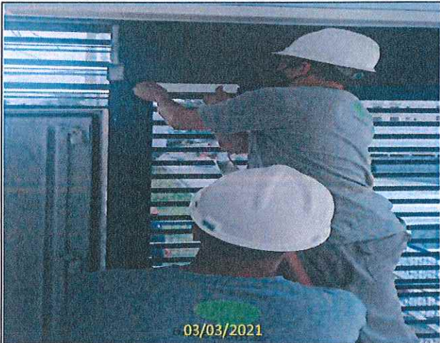
Foto 19 Instalação de dispositivo na porta de emergência
