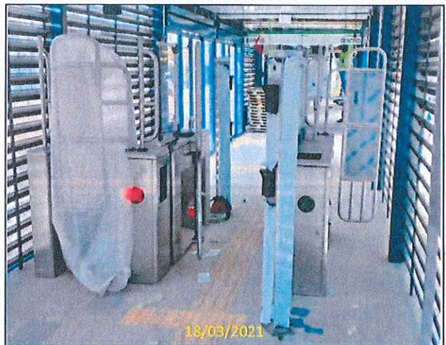
Foto 38 Instalação das catracas anti vandalismo com totem IP
