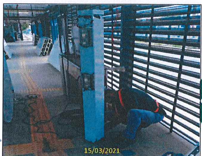
Foto 28 Instalação do Totem de comunicação fixa
