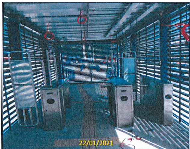
Foto 03 Lançamento dos cabos
