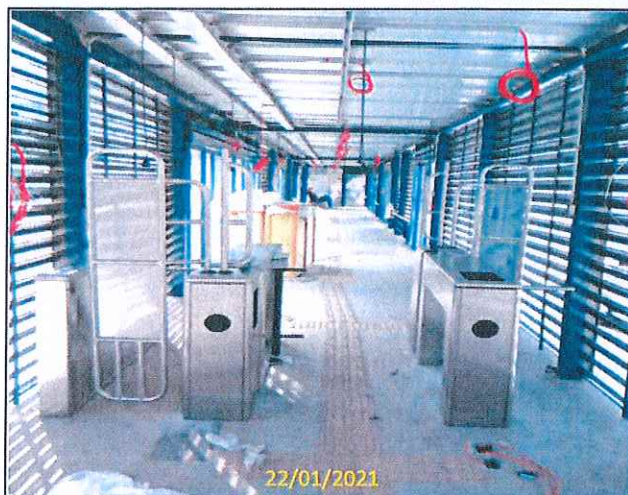
Foto 02 Lançamento dos cabos
