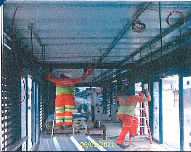
Foto 23 Passagem dos cabos aéreos
