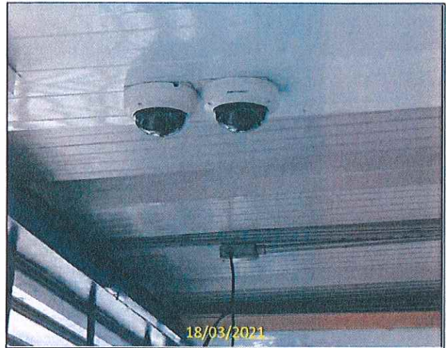
Foto 36 Instalação da câmeras de monitoramento interno (CFTV)
