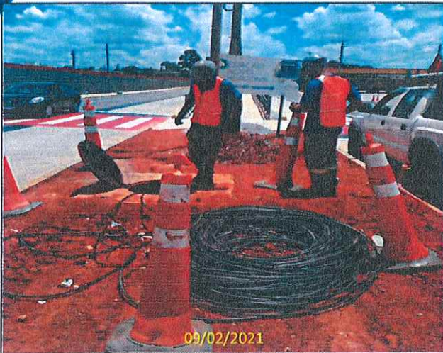
Foto 05 Passagem dos cabos de fibra óptica nas caixas RM
