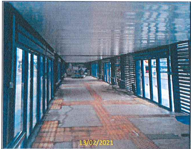
Foto 12 Fechamento do forro após passagem dos cabos
