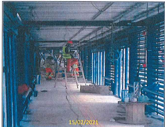
Foto 14 Passagem dos cabos aéreos
