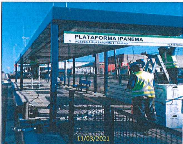
Foto 25 Instalação dos dispositivos de ITS do abrigo da estação Eco
