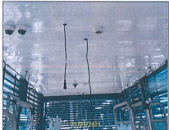
Foto 44 Cameras, detectores de fumaça e sonorização instalados
