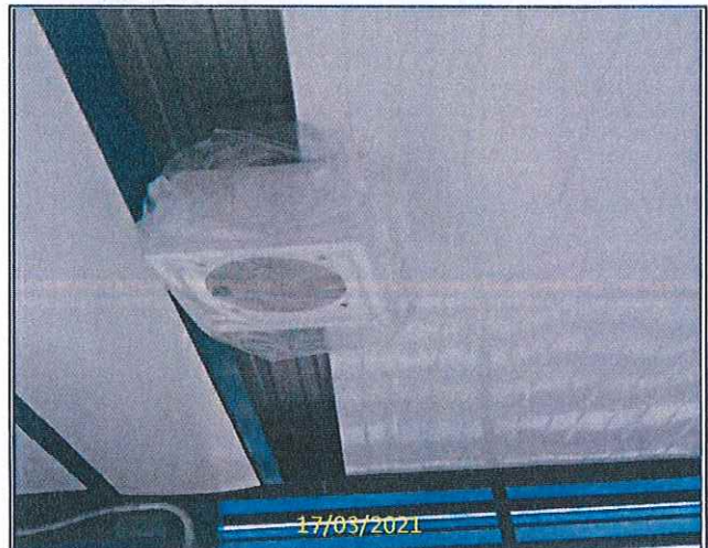
Foto 32 Instalação de dispositivo de sonorização
