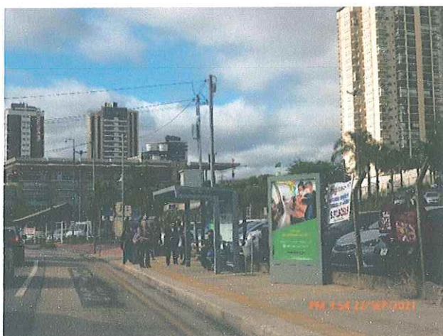
Foto 15: Sistema ITS instalado nos pontos de parada do Corredor Estrutural Sul (S8S).
