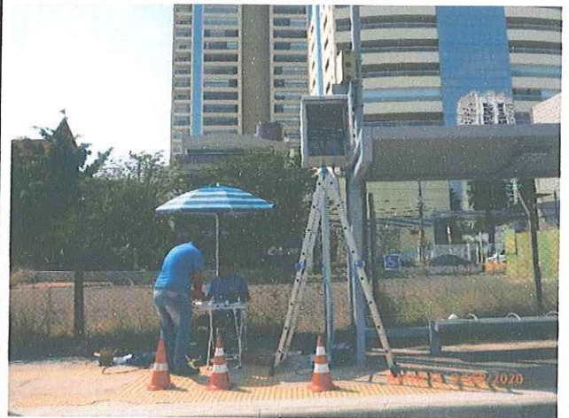
Foto 2: Instalação dos itens do sistema ITS no Corredor Estrutural Sul.
