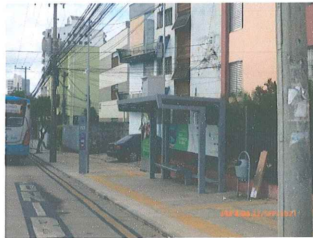
Foto 2: Sistema ITS instalado nos pontos de parada do Corredor Estrutural Sul (S2S).
