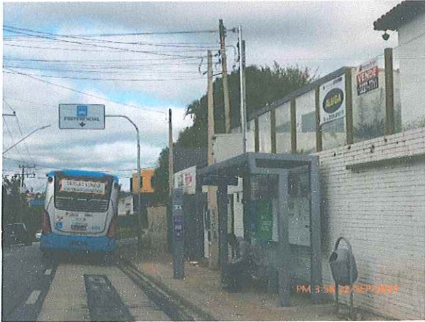
Foto 7: Sistema ITS instalado nos pontos de parada do Corredor Estrutural Sul (S4S).
