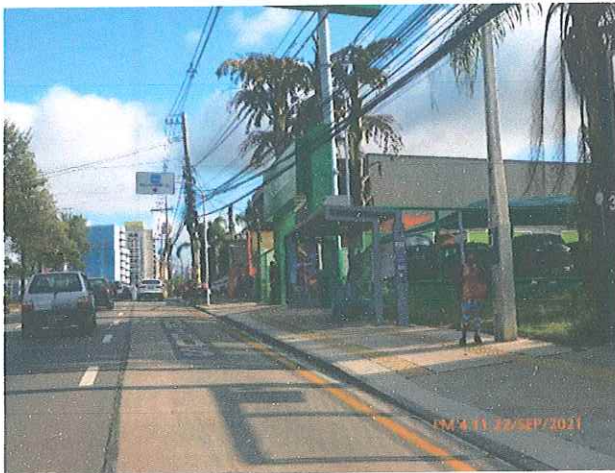
Foto 21: Sistema ITS instalado nos pontos de parada do Corredor Estrutural Sul (S8C).
