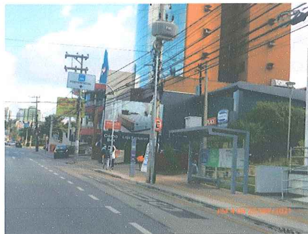
Foto 16: Sistema ITS instalado nos pontos de parada do Corredor Estrutural Sul (S6C).
