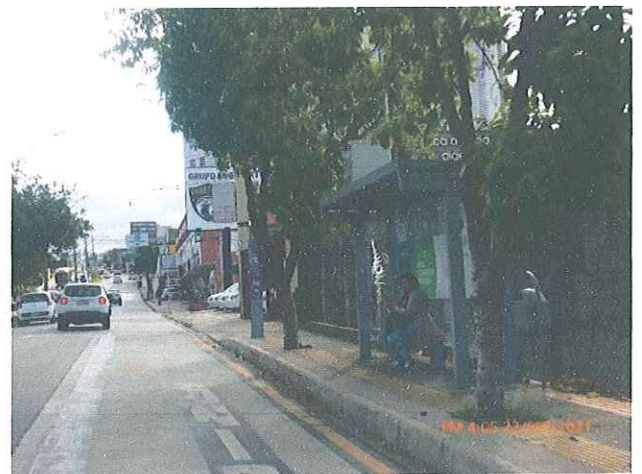
Foto 6: Sistema ITS instalado nos pontos de parada do Corredor Estrutural Sul (S3C).
