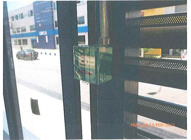
Fotos 35 e 36: Sistema de emergência para abertura manual das portas automáticas.
