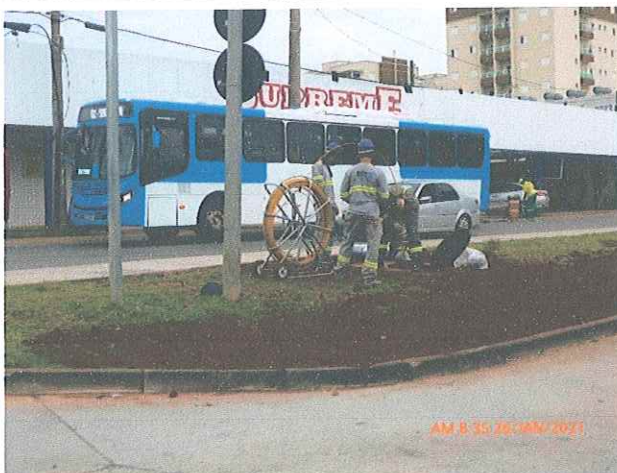
Fotos 15 e 16: Instalação da fibra ótica no Corredor Ipanema.
