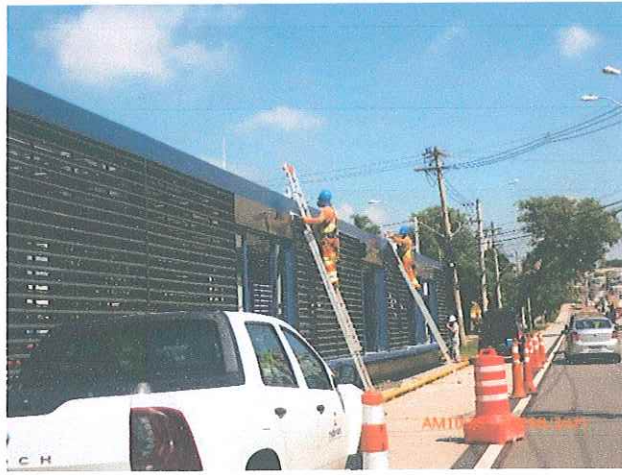
Fotos 33 e 34: Instalação das antenas de comunicação 5Ghz do sistema "ônibus/terra".
