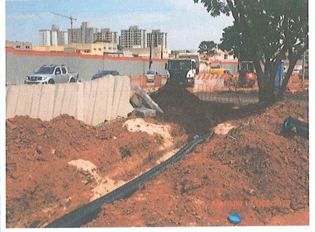
Fotos 9 e 10: Implantação da infraestrutura dos dutos de fibra ótica.
