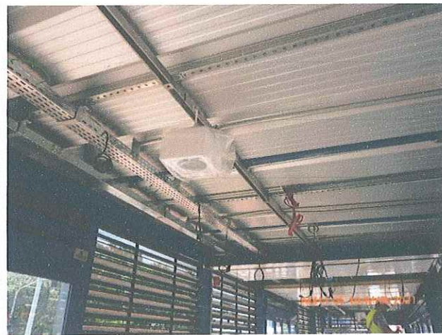
Fotos 39 e 40: Instalação do sistema de informação sonora nas estações do Corredor Ipanema.
