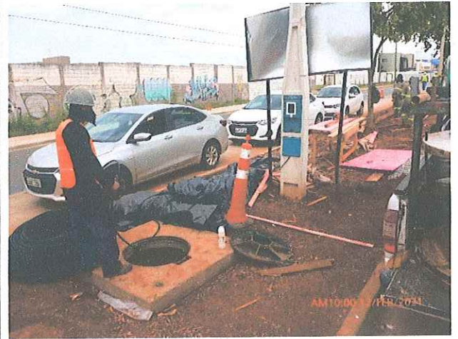
Fotos 19 e 20: Instalação da fibra óptica no Corredor Ipanema.
