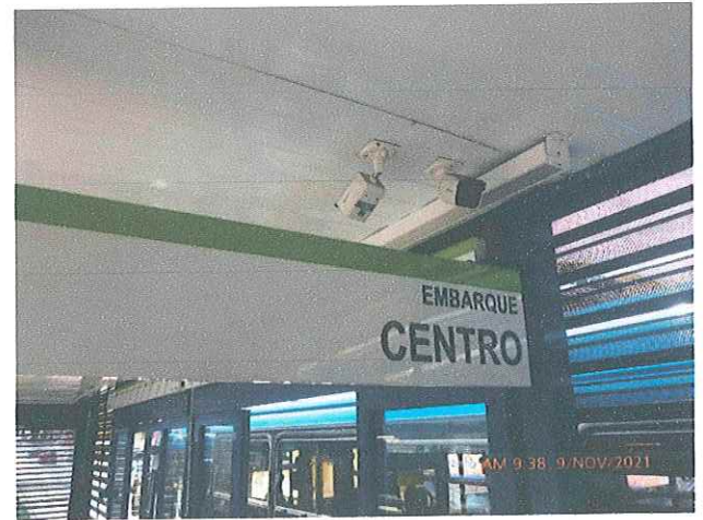
Fotos 5 e 6: Roteadores WiFi e câmeras do circuito fechado de monitoramento nas estações BRT do Corredor Ipanema.
