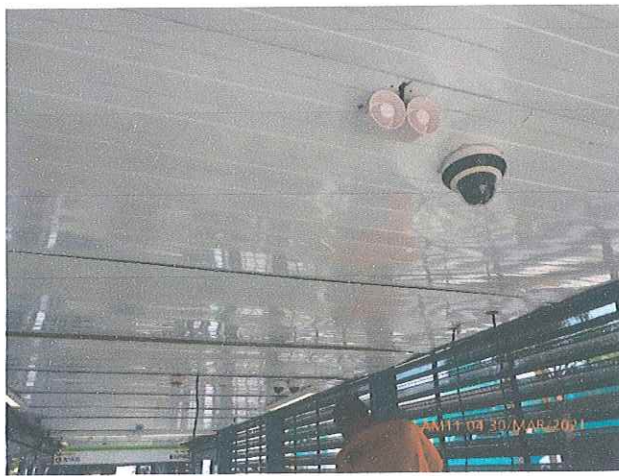
Fotos 45 e 46: Instalação do circuito fechado de monitoramento (CFTV) nas estações do Corredor Ipanema.
