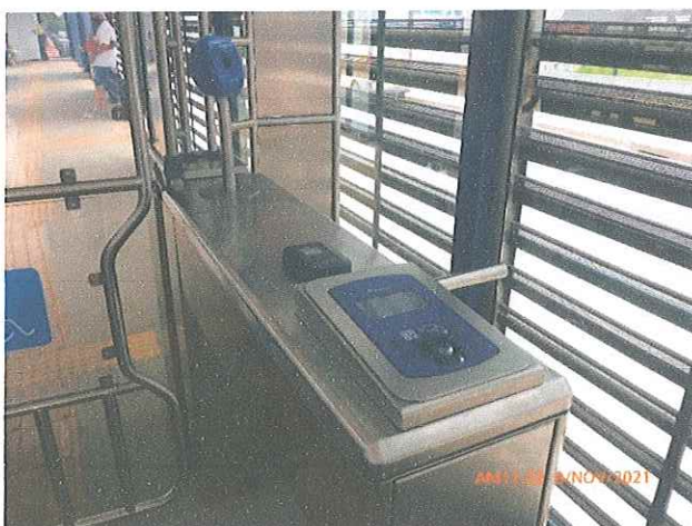
Fotos 13 e 14: Catracas com validadores de acesso nas estações BRT do Corredor Ipanema.
