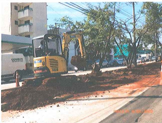
Fotos 3 e 4: Implantação da infraestrutura dos dutos de fibra ótica.
