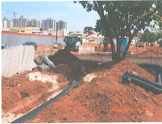
Fotos 9 e 10: Implantação da infraestrutura dos dutos de fibra ótica.
