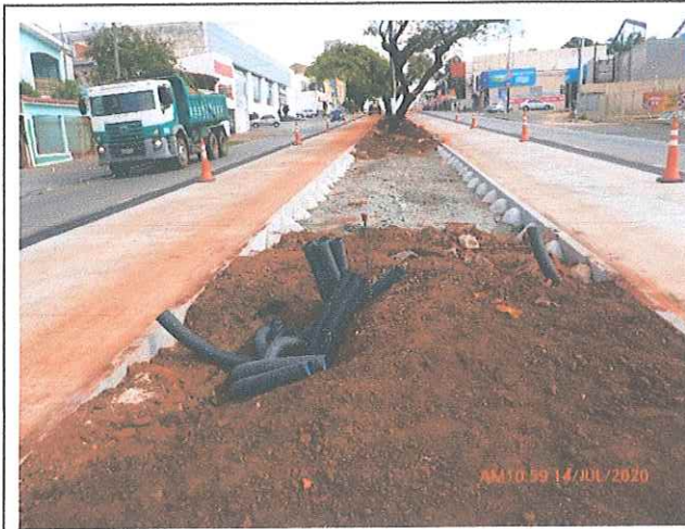
Fotos 5 e 6: Implantação da infraestrutura dos dutos de fibra ótica.
