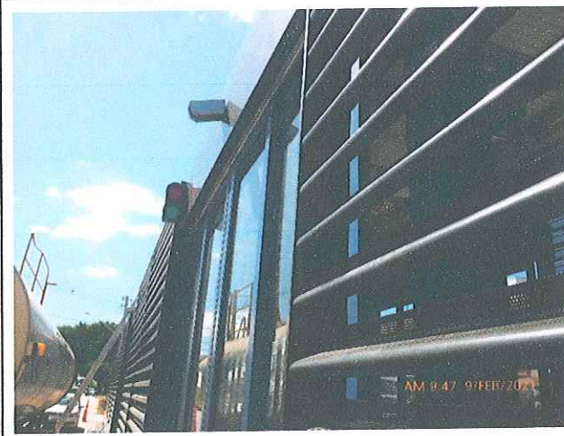
Fotos 31 e 32: Instalação dos sensores do acionamento das portas automáticas.
