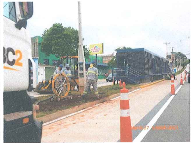
Fotos 15 e 16: Instalação da fibra ótica no Corredor Ipanema.
