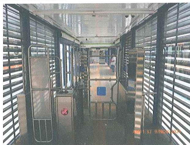
Fotos 13 e 14: Catracas com validadores de acesso nas estações BRT do Corredor Ipanema.
