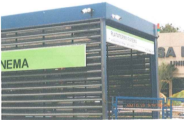
Fotos 7 e 8: Câmeras do circuito fechado de monitoramento (CFTV) nas estações BRT do Corredor Ipanema.
