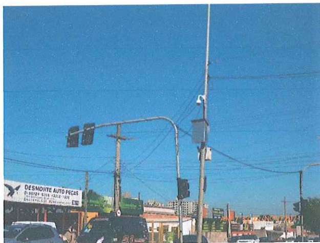
Fotos 19 e 20: Câmeras 'Dome' instaladas no Corredor Ipanema.
