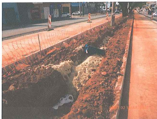
Fotos 7 e 8: Implantação da infraestrutura dos dutos de fibra ótica.
