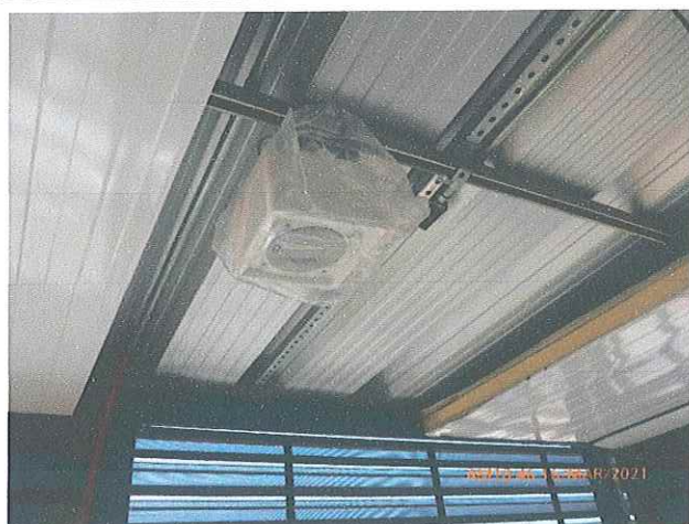
Fotos 39 e 40: Instalação do sistema de informação sonora nas estações do Corredor Ipanema.
