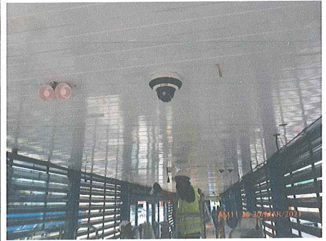
Fotos 47 e 48: Instalação do circuito fechado de monitoramento (CFTV) nas estações do Corredor Ipanema.
