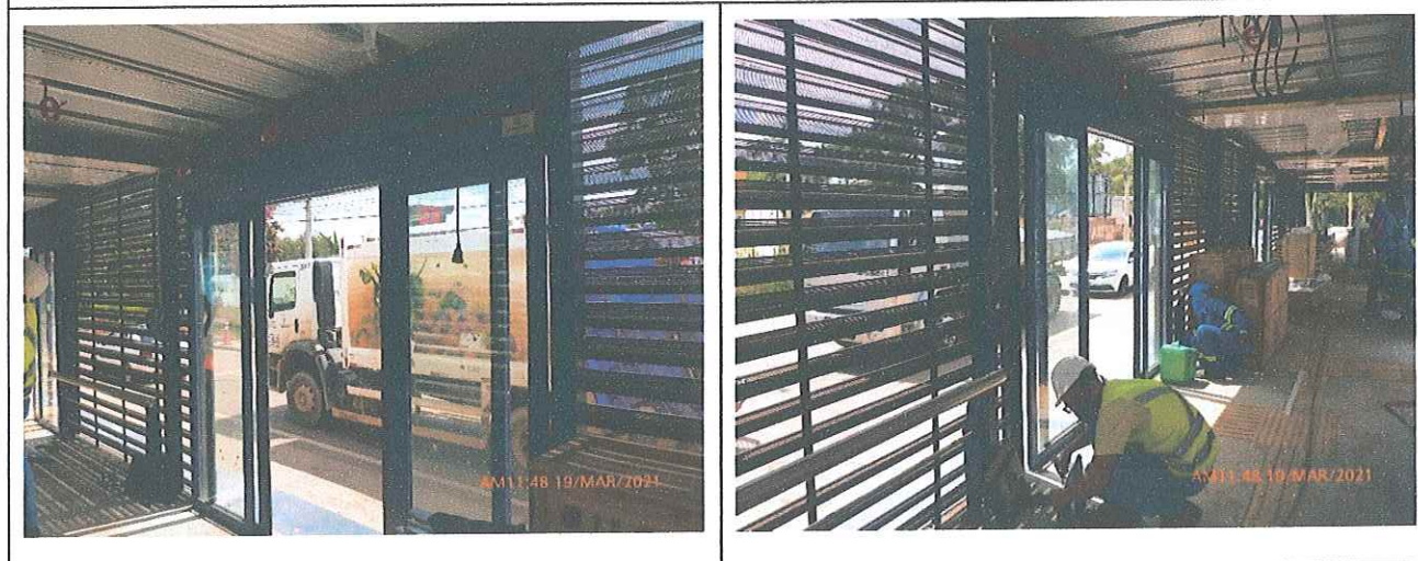
Fotos 43 e 44: Configuração das portas automáticas.
