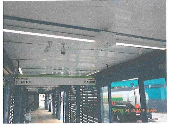
Fotos 45 e 46: Instalação do circuito fechado de monitoramento (CFTV) nas estações do Corredor Ipanema.
