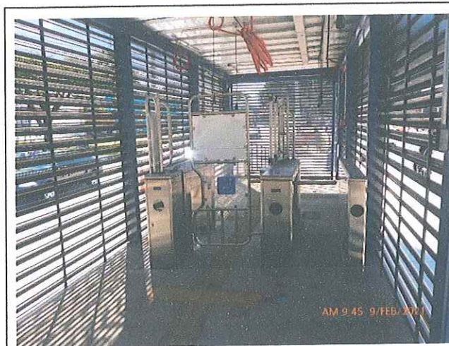
Fotos 29 e 30: Instalação das catracas e configuração dos validadores com o sistema ITS.
