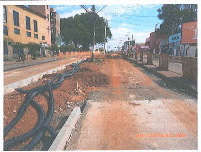
Fotos 5 e 6: Implantação da infraestrutura dos dutos de fibra ótica.
