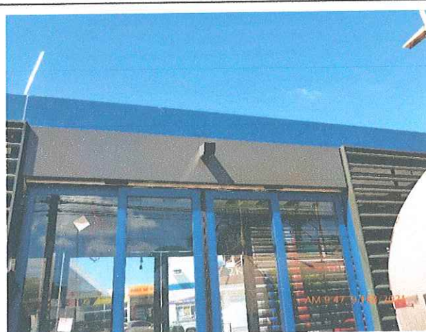
Fotos 31 e 32: Instalação dos sensores do acionamento das portas automáticas.
