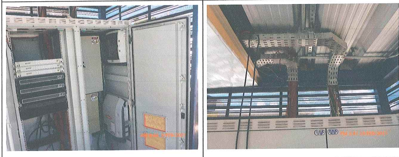
Fotos 23 e 24: Instalação dos 'Racks' do sistema ITS nas estações do Corredor Ipanema.
