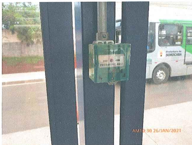
Fotos 35 e 36: Sistema de emergência para abertura manual das portas automáticas.
