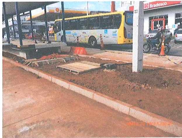
Fotos 3 e 4: Implantação da infraestrutura dos dutos de fibra ótica.
