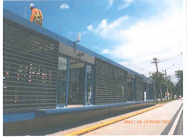
Fotos 33 e 34: Instalação das antenas de comunicação 5Ghz do sistema "ônibus/terra".
