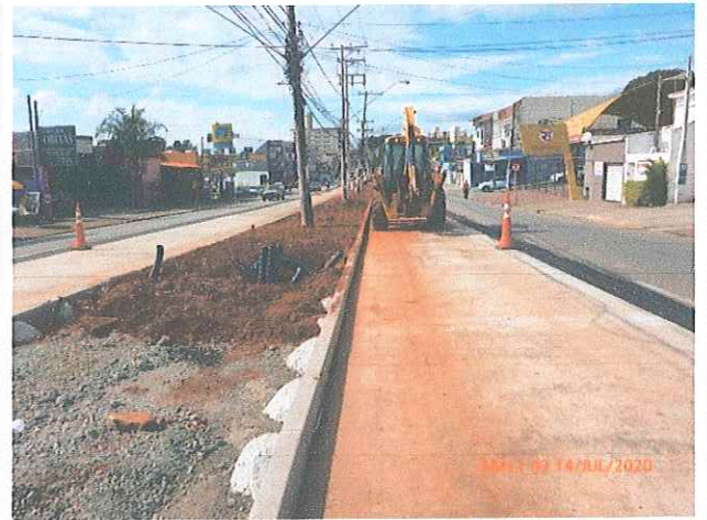
Fotos 7 e 8: Implantação da infraestrutura dos dutos de fibra ótica.
