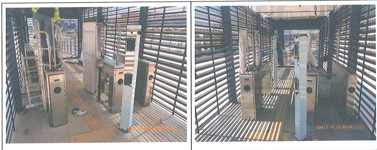
Fotos 41 e 42: Instalação dos interfones de comunicação com o Atendimento ao Usuário nas estações do Corredor Ipanema.
