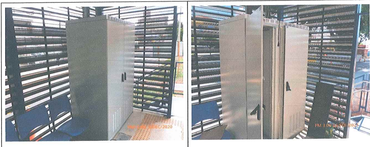
Fotos 21 e 22: Instalação dos 'Racks' do sistema ITS nas estações do Corredor Ipanema.
