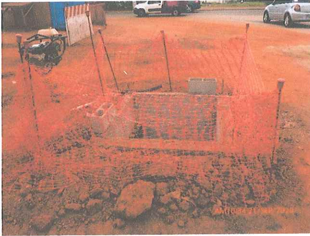
Fotos 13 e 14: Caixas de passagem da infraestrutura de comunicação do Corredor Ipanema.
