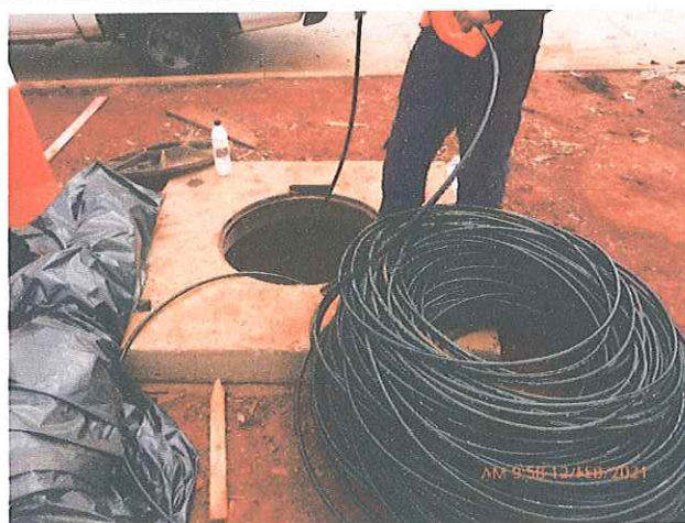
Fotos 19 e 20: Instalação da fibra óptica no Corredor Ipanema.
