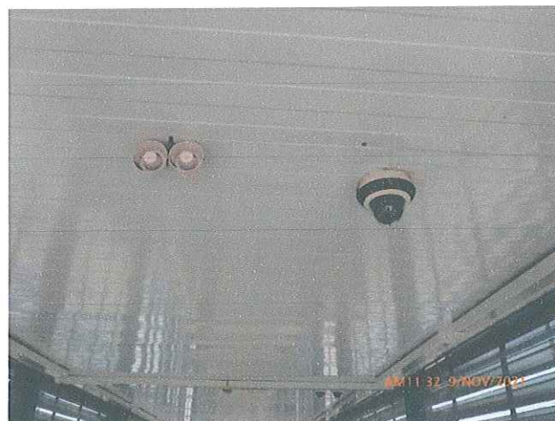
Fotos 15 e 16: Sistema de informação sonora nas estações BRT do Corredor Ipanema.
