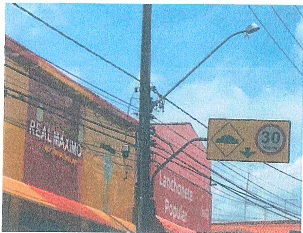
Foto 98: Câmeras dome instaladas no Corredor Estrutural Área Central.
