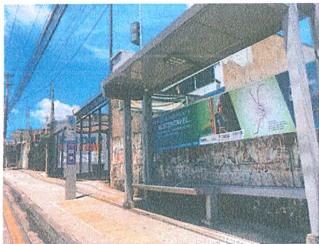
Foto 55: Sistema de ITS instalado no ponto de parada LG01C.
