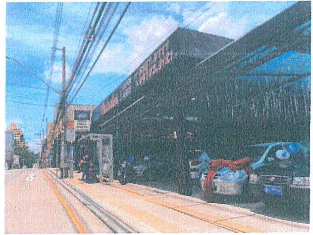
Foto 12: Sistema de ITS instalado no ponto de parada AC11.
