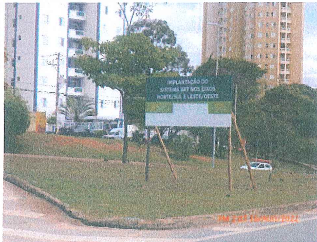
Foto 1: Placa de identificação das obras do BRT Sorocaba instalada no Corredor Área Central, dentro do padrão disponibilizado pela CEF.
