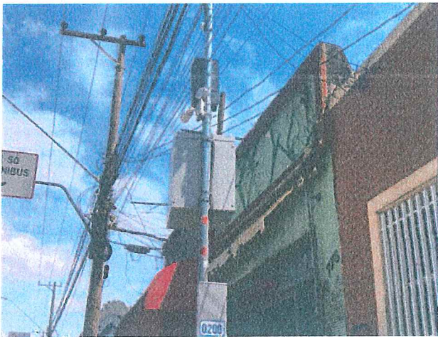
Fotos 70 e 71: Câmeras fixas de monitoramento de via instaladas no Corredor Estrutural Área Central.
