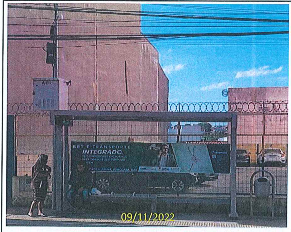
Foto 11 Poste do abrigo da parada AC06 com Rack.
