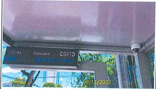
Foto 41 Vista do abrigo da parada LG03N com PMV display e câmera
