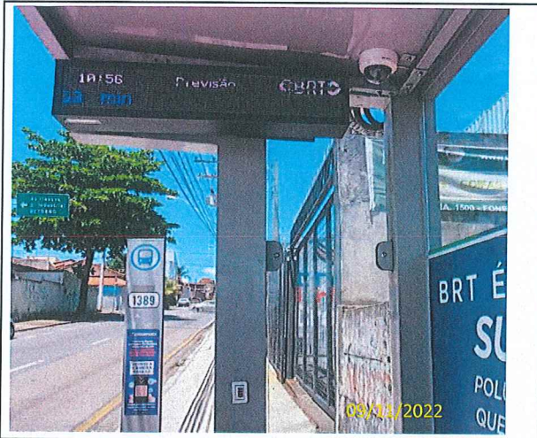
Foto 34 Vista do abrigo da parada LG01C com PMV display e câmera
