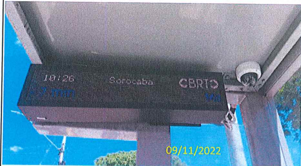
Foto 50 Vista do abrigo da parada ACN1 com PMV display e câmera
