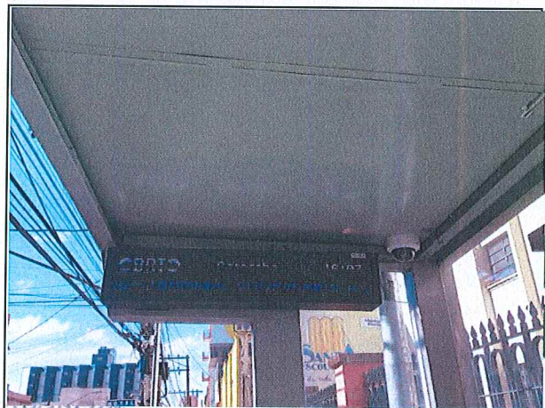
Foto 09 Vista do abrigo da parada AC05 com PMV display e câmera
