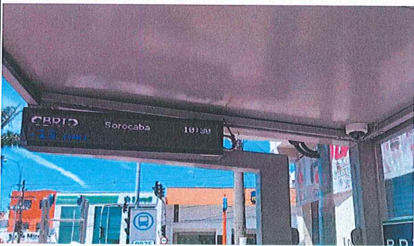
Foto 06 Vista do abrigo da parada AC4-01 com PMV display e câmera.
