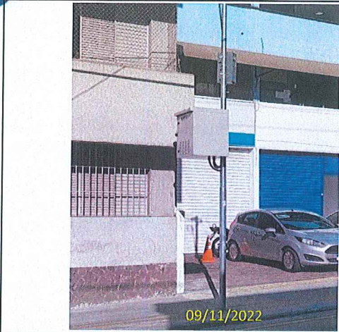
Foto 16 Poste do abrigo da parada AC10 com Rack.
