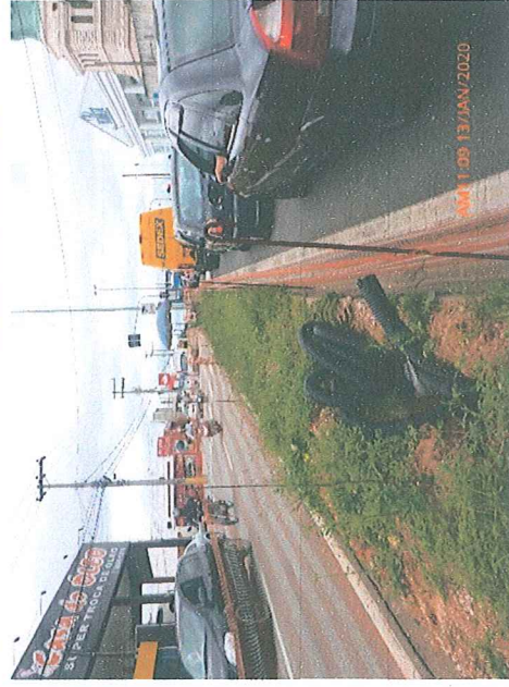
Fotos 9 e 10: Implantação da infraestrutura dos dutos de fibra ótica.
