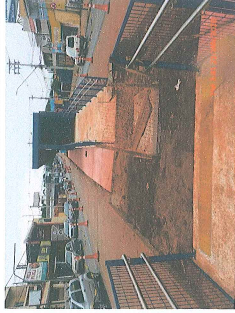
Fotos 17 e 18: Implantação da infraestrutura dos dutos de fibra ótica nas estações.
