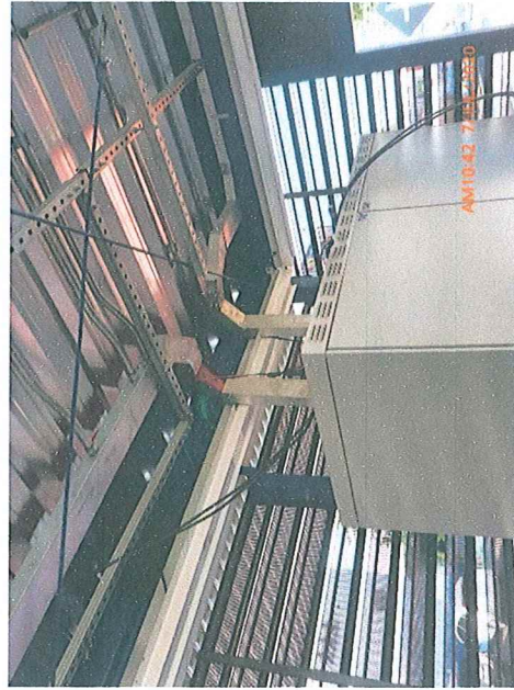
Fotos 25 e 26: Instalação dos 'Racks' do sistema ITS nas estações do Corredor Itavuvu.
