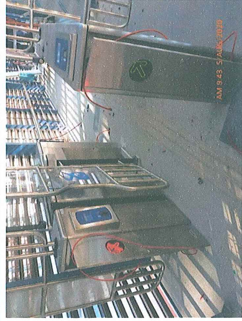
Fotos 29 e 30: Instalação das catracas e configuração dos validadores com o sistema ITS.
