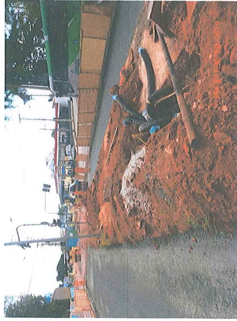
Fotos 9 e 10: Implantação da infraestrutura dos dutos de fibra ótica.
