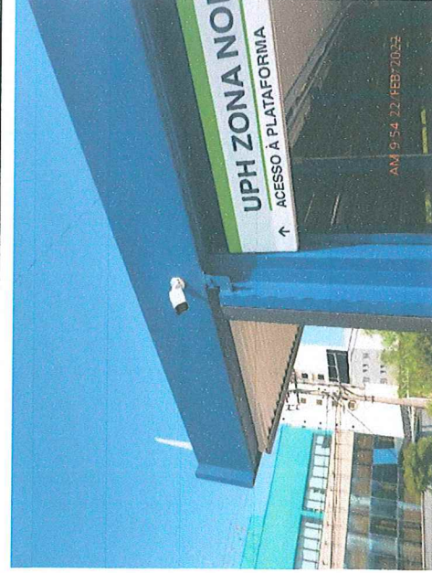
Fotos 41 e 42: Instalação do circuito fechado de monitoramento (CFTV) nas estações do Corredor Itavuvu.
