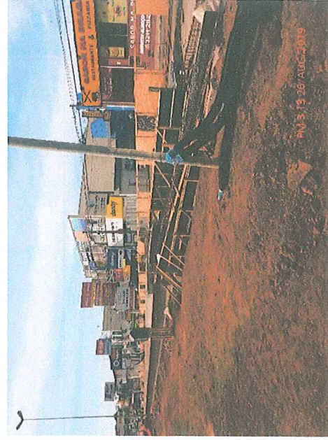
Fotos 13 e 14: Implantação da infraestrutura dos dutos de fibra ótica nas estações.
