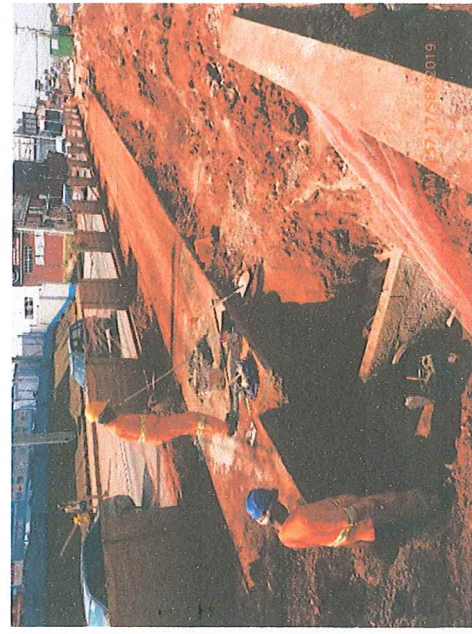
Fotos 5 e 6: Implantação da infraestrutura dos dutos de fibra ótica.
