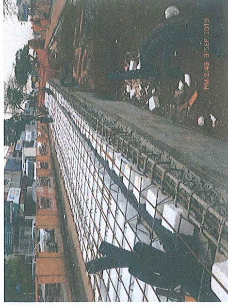
Fotos 13 e 14: Implantação da infraestrutura dos dutos de fibra ótica nas estações.
