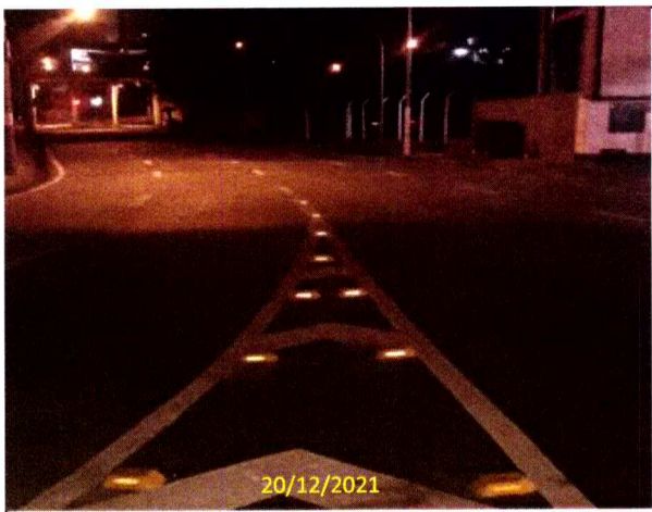
Foto 39 Instalação de Tachões
