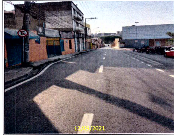
Foto 38 Sinalização na Rua Francisco Scarpa
