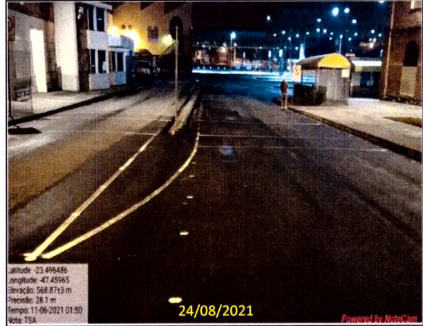
Foto 08 Marcação da sinalização da Av. Luiz Ferraz de Sampaio Jr.
