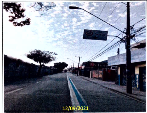
Foto 20 Sinalização na Avenida Hermelino Matarazzo
