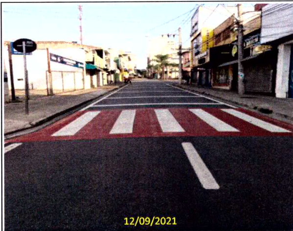
Foto 37 Sinalização na Rua Francisco Scarpa
