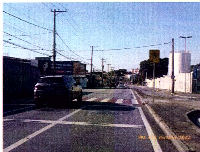
Fotos 47 e 48: Sinalização horizontal implantada no Corredor Estrutural General Osório.
