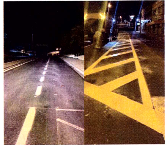
Fotos 9 e 10: Implantação da sinalização horizontal no Corredor Estrutural Área Central.
