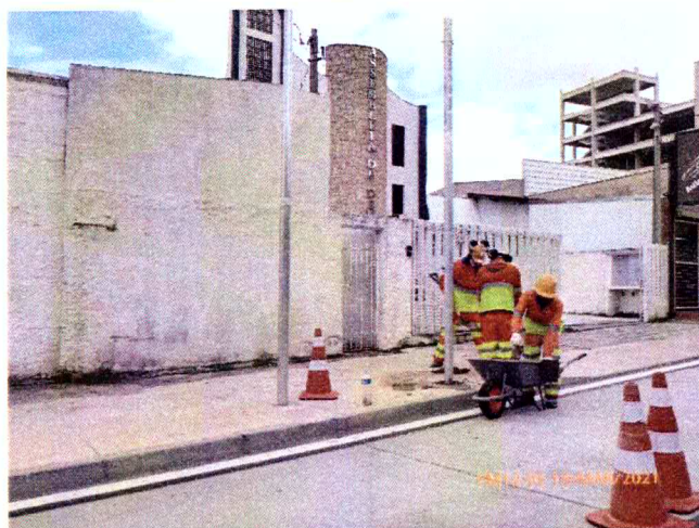
Fotos 29 e 30: Implantação da sinalização vertical no Corredor Estrutural Binário.
