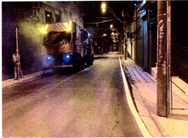
Fotos 5 e 6: Implantação da sinalização horizontal no Corredor Estrutural Área Central.
