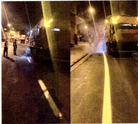
Fotos 9 e 10: Implantação da sinalização horizontal no Corredor Estrutural Área Central.
