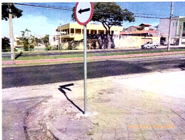
Fotos 41 e 42: Implantação das sinalizações verticais no Corredor Estrutural General Osório.
