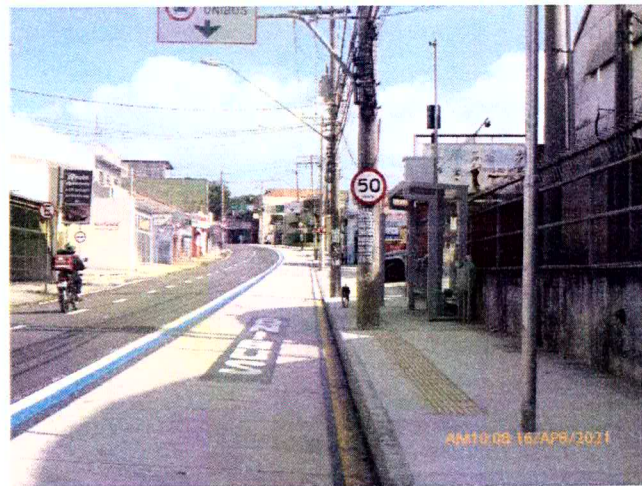
Fotos 27 e 28: Implantação das sinalizações horizontais no Corredor Estrutural Binário.
