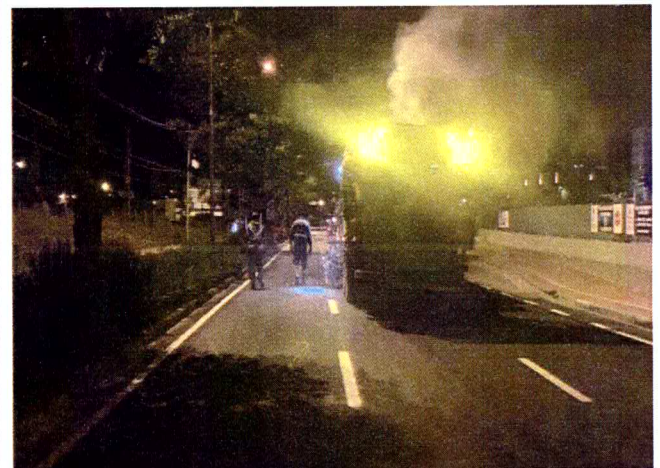
Fotos 7 e 8: Marcações para implantação da sinalização horizontal no Corredor Estrutural Área Central.
