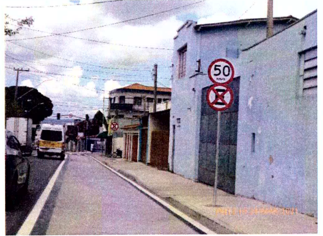
Fotos 33 e 34: Implantação da sinalização vertical no Corredor Estrutural Binário.
