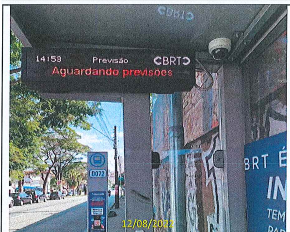
Foto 01 Vista do abrigo da parada L01C com PMV display e câmera.
