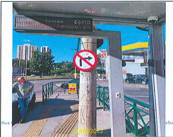
Foto 09 Vista do abrigo da parada L07L com PMV display e câmera.
