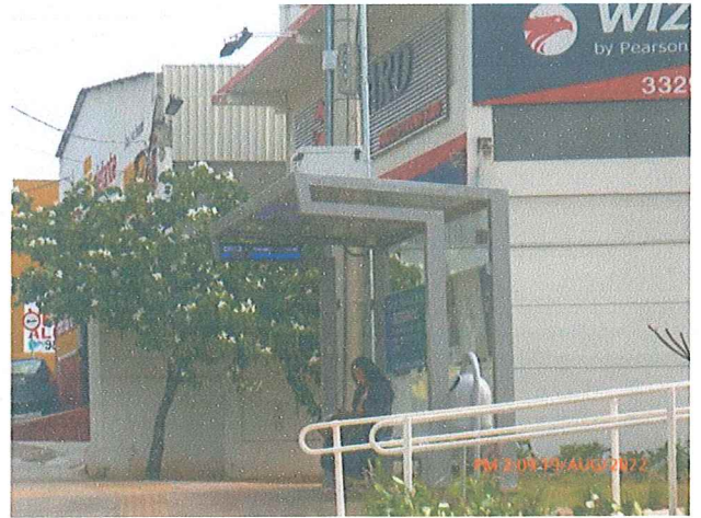
Foto 14: Sistema de ITS instalado no ponto de parada L6C.
