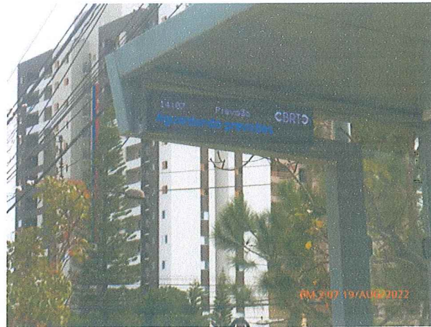
Fotos 19 e 20: Sistema de ITS instalado no ponto de parada L8C.
