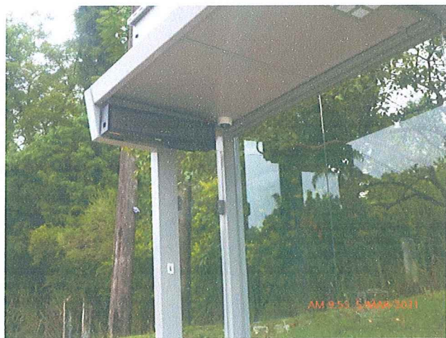
Fotos 23 e 24: Instalação dos PMVs nos pontos de parada do Corredor Estrutural Leste.
