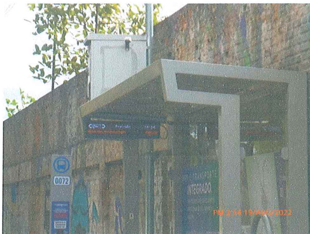
Foto 1: Sistema de ITS instalado no ponto de parada L1C.
