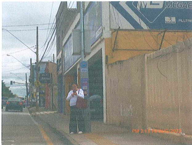
Foto 3: Sistema de ITS instalado no ponto de parada L2C.
