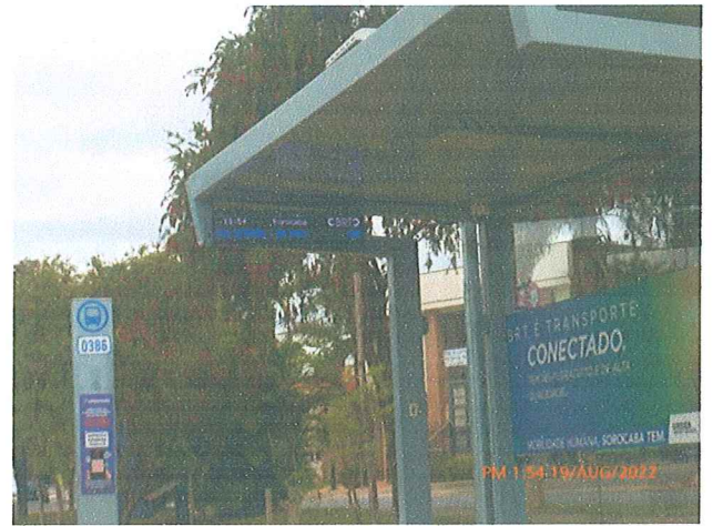
Fotos 41 e 42: Sistema de ITS instalado no ponto de parada L13L.
