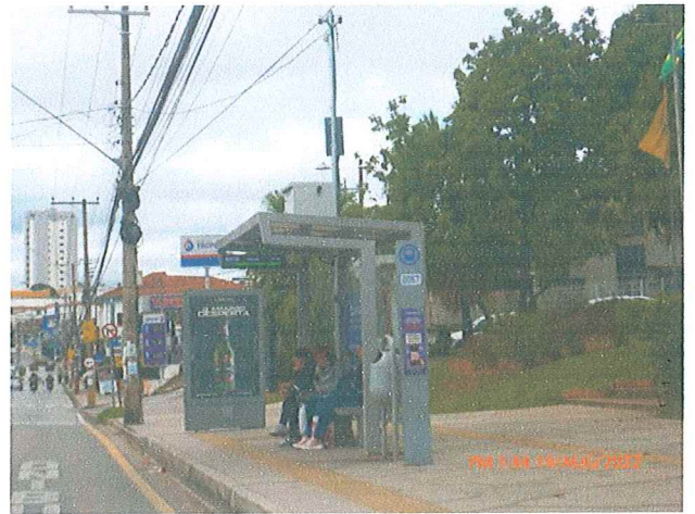
Foto 6: Sistema de ITS instalado no ponto de parada L3L.
