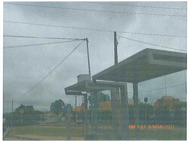
Fotos 25 e 26: Câmeras fixas de monitoramento de via e sensores de GPS instalados nos pontos de parada do Corredor Estrutural Leste.
