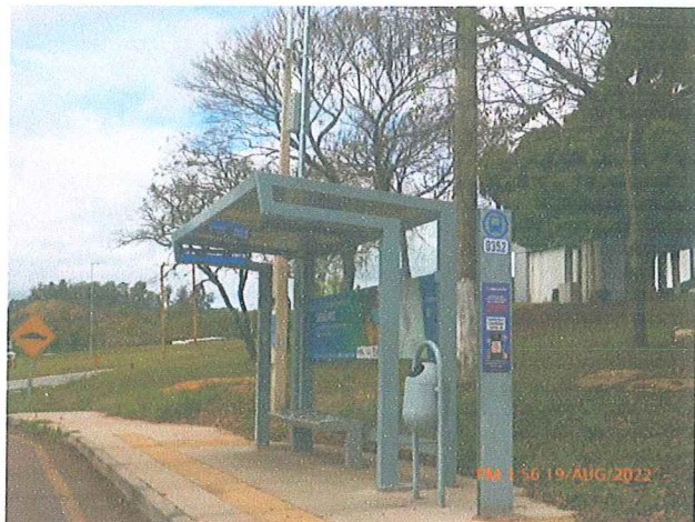
Foto 47: Sistema de ITS instalado no ponto de parada L15C.
