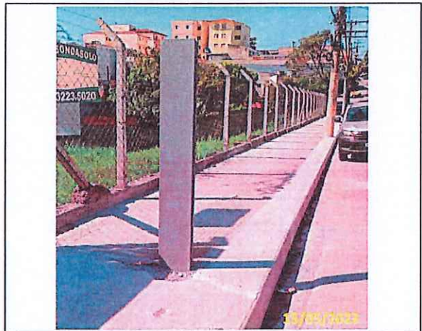
Foto 08 Vista lateral esquerda do totem instalado
