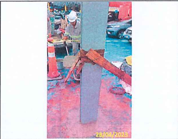
Foto 03 Ancoragem do totem instalado
