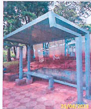
Foto 12 Vista do abrigo instalado
