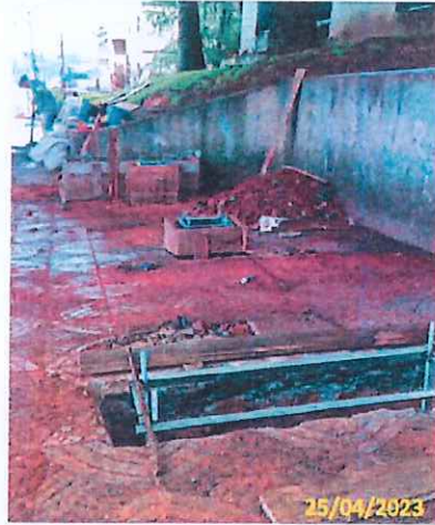
Foto 10 Instalação dos chumbadores para o abrigo
