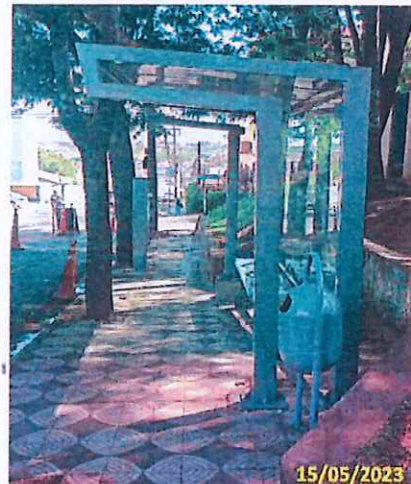
Foto 14 Vista lateral direita do abrigo instalado
