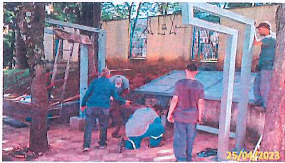
Foto 11 Instalação do abrigo em andamento
