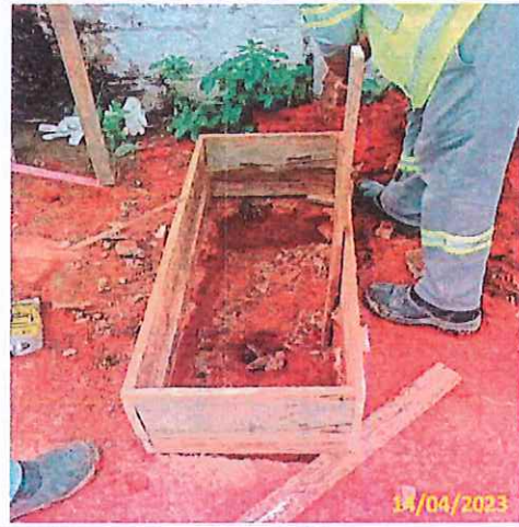
Foto 16 Preparação da base para instalação do chumbador
