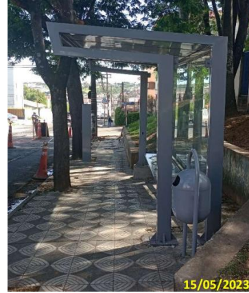
Foto 10 – Equipamentos (abrigo e lixeira) instalados na estaca 60, altura do número 1.223 da avenida Doutor Américo de Figueiredo, sentido bairro.
