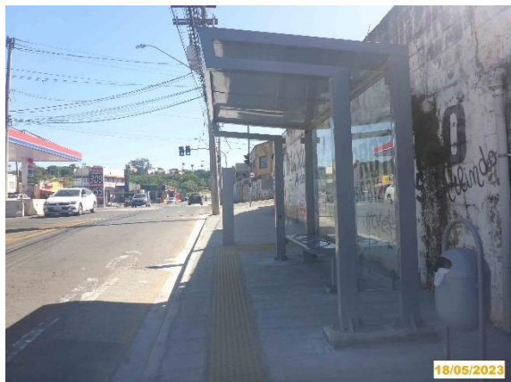
Foto 17 – Equipamentos (totem, abrigo, banco e lixeira) instalados na estaca 97.
