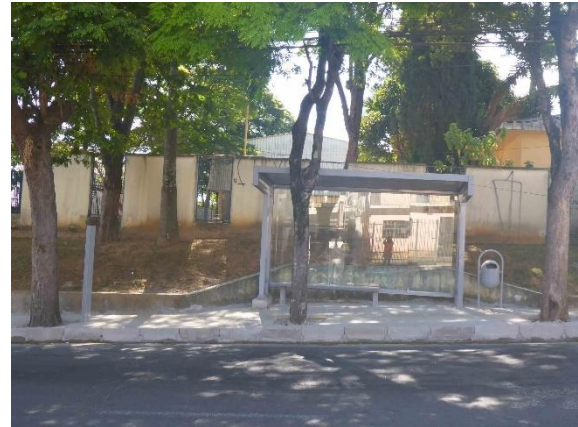
Foto 12 – Equipamentos (totem, abrigo, banco e lixeira) instalados na estaca 60.
