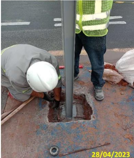
Foto 1 – Instalação do totem na estaca 17, altura do nº 340 da avenida Doutor Américo de Figueiredo, sentido bairro.
