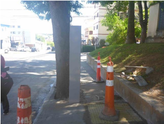
Foto 11 – Totem instalado na estaca 60.
