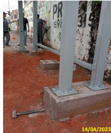
Foto 14 – Instalação do abrigo em andamento na estaca 97, altura do número 1.223 da avenida Doutor Américo de Figueiredo, sentido bairro.
