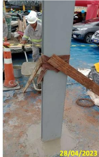
Foto 2 – Ancoragem do totem instalado na estaca 17.
