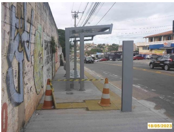
Foto 15 – Equipamentos (totem, abrigo, banco e lixeira) instalados na estaca 97.
