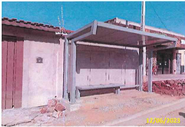
Foto 16 Vista do abrigo instalado
