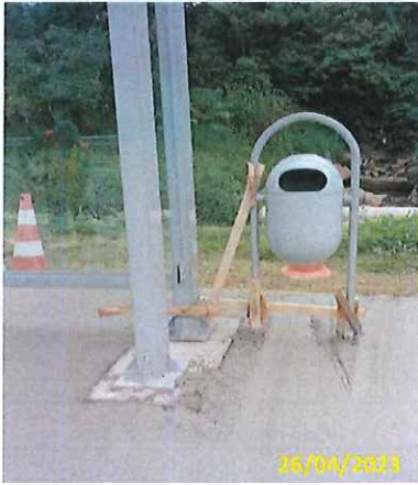
Foto 14 Ancoragem da lixeira instalada
