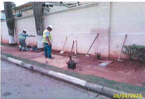
Foto 01 Marcação dos pontos com gabarito
