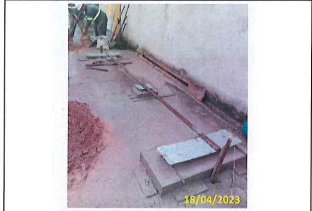
Foto 09 Instalação dos chumbadores do abrigo
