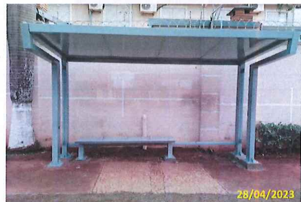
Foto 02 Vista frontal do abrigo instalado
