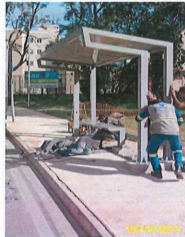
Foto 13 Instalação do abrigo
