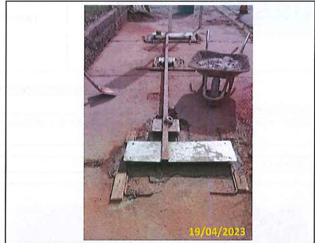
Foto 06 Instalação dos chumbadores do abrigo
