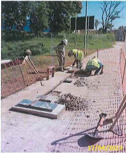
Foto 12 Preparação para instalação do chumbador
