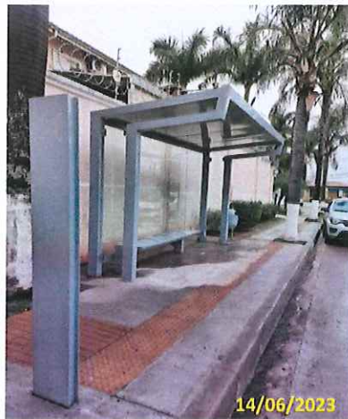
Foto 03 Vista lateral esquerda do conjunto instalado
