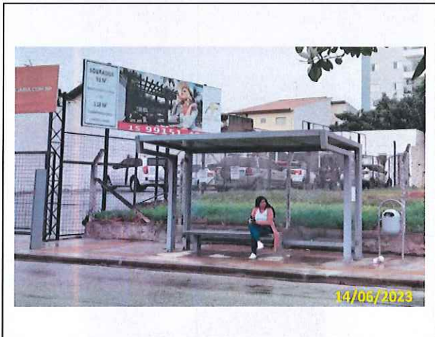
Foto 07 Vista do conjunto instalado
