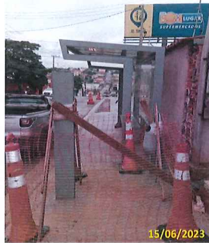
Foto 17 Ancoragem do totem e lixeira instalados
