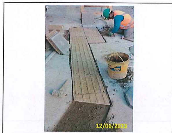
Foto 04 Instalação de piso podotátil
