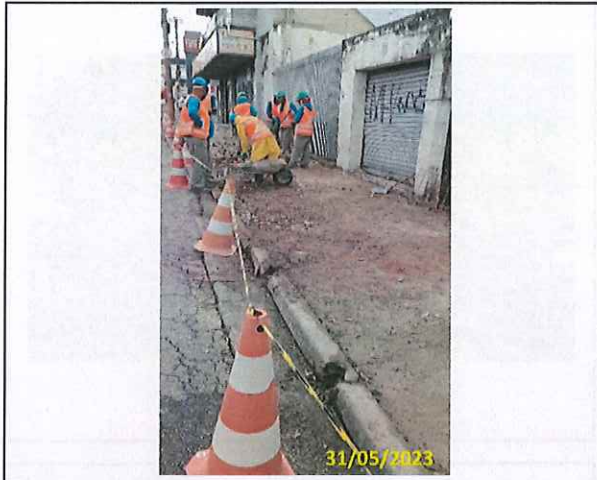
Foto 15 Demolição do passeio existente
