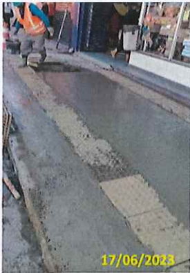
Foto 09 Concretagem do passeio
