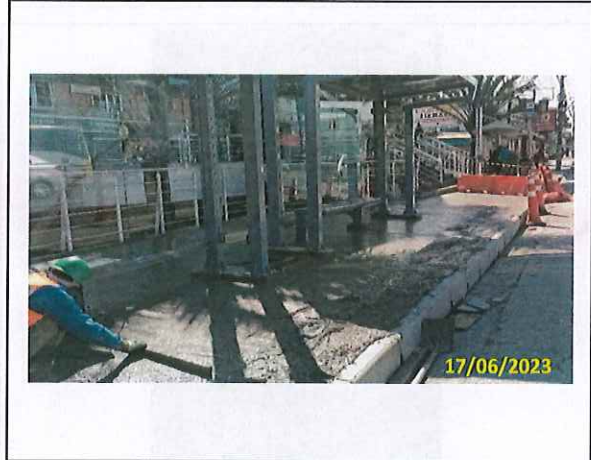
Foto 20 Concretagem do passeio
