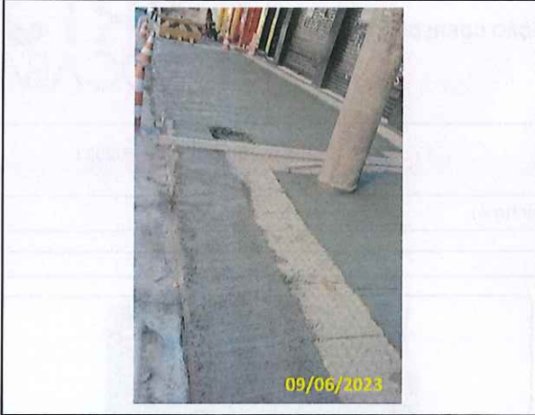
Foto 05 Concretagem do passeio
