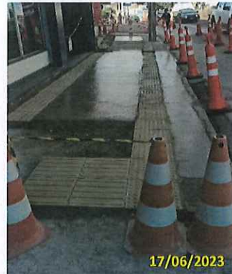
Foto 08 Sinalização e concretagem em andamento
