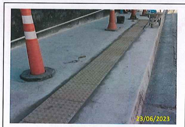
Foto 14 Instalação de piso podotátil
