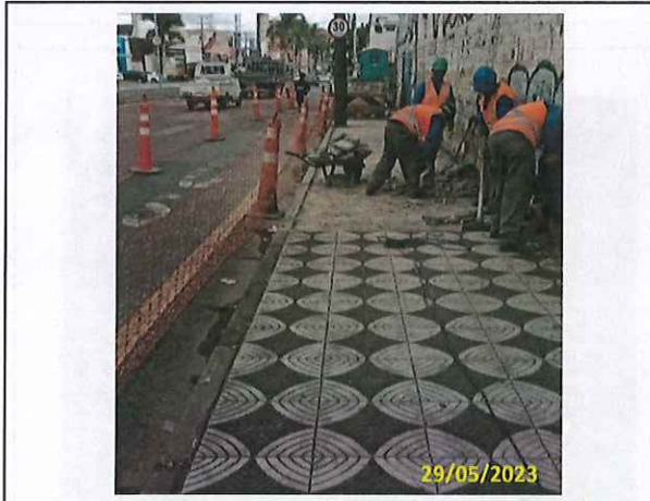
Foto 23 Demolição do passeio existente
