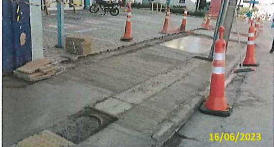
Foto 07 Instalação de piso podotátil
