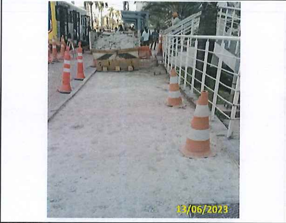
Foto 19 Demolição do passeio existente
