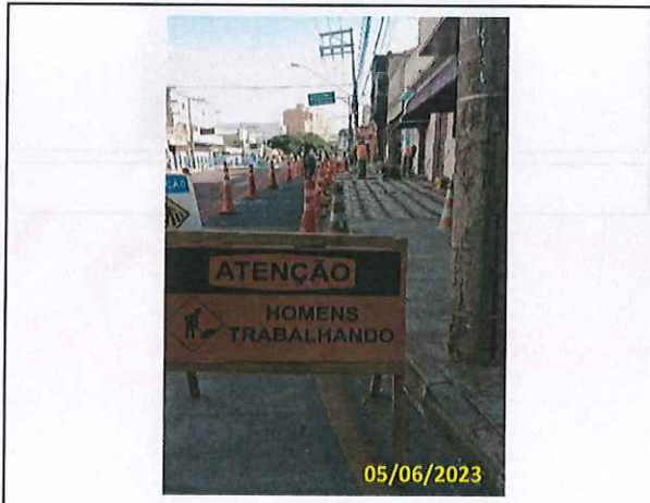
Foto 01 Sinalização de obra
