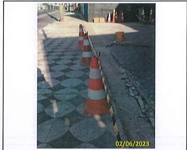
Foto 16 Instalação de piso podotátil
