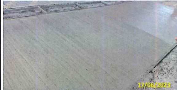
Foto 10 Execução de acabamento vassourado
