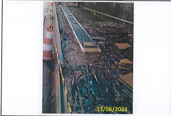
Foto 11 Preparo para a concretagem
