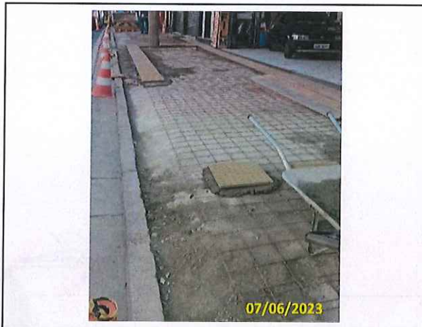
Foto 03 Instalação da tela metálica e início da instalação do podotátil
