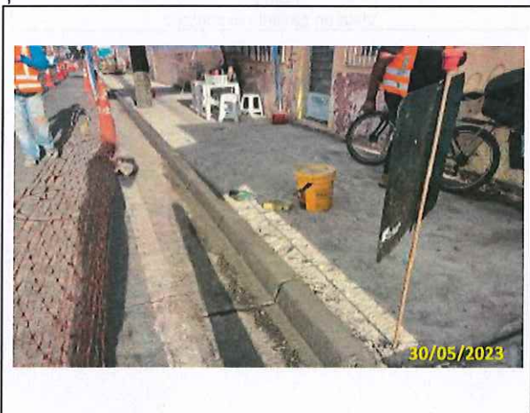
Foto 25 Reparo na guia e sarjeta
