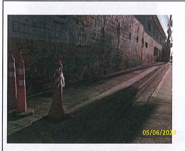
Foto 28 Vista do passeio executado
