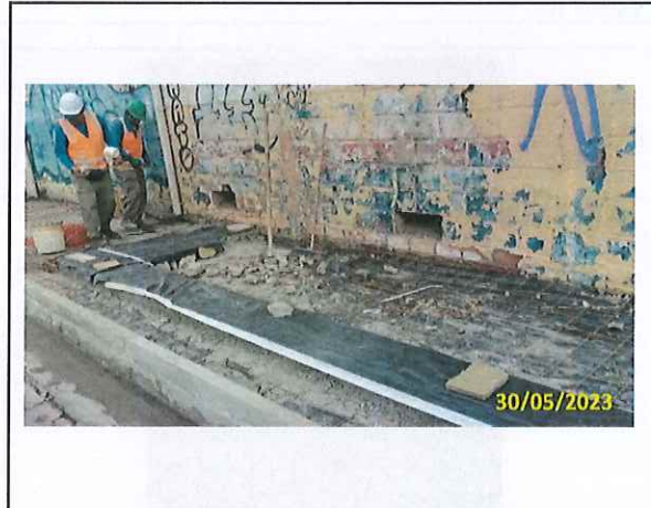
Foto 24 Preparo para concretagem
