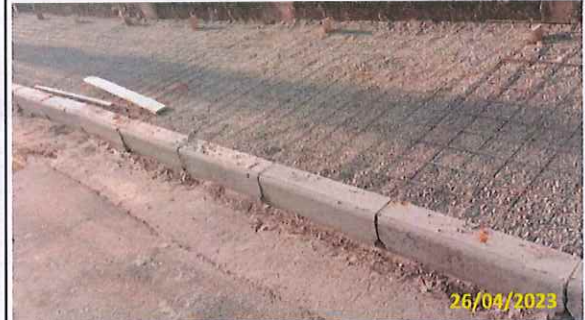
Foto 05 Instalação de tela metálica
