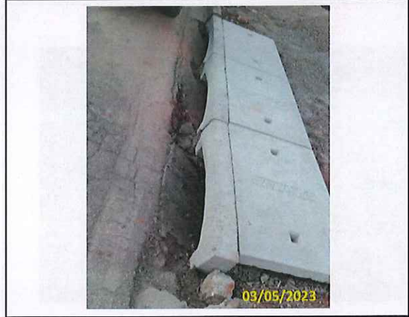
Foto 25 Instalação de boca de lobo
