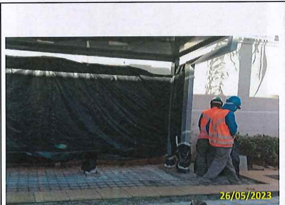
Foto 37 Instalação de piso podotátil
