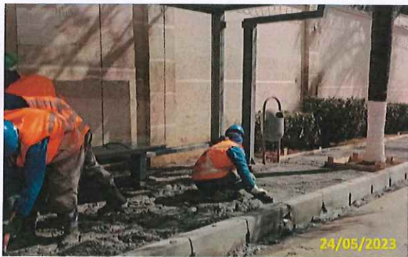
Foto 35 Concretagem do passeio
