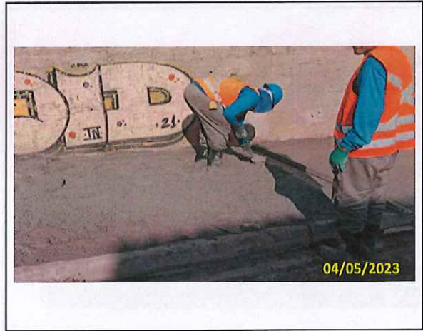
Foto 27 Concretagem do passeio
