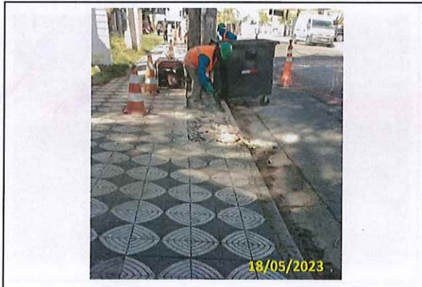
Foto 08 Demolição do passeio existente
