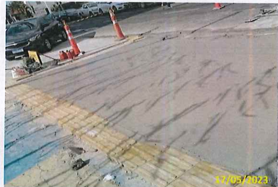
Foto 02 Instalação de piso podotátil (2ª parte)
