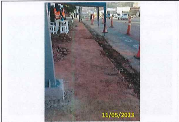
Foto 12 Demolição de passeio existente
