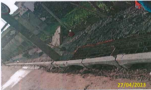
Foto 06 Início da concretagem
