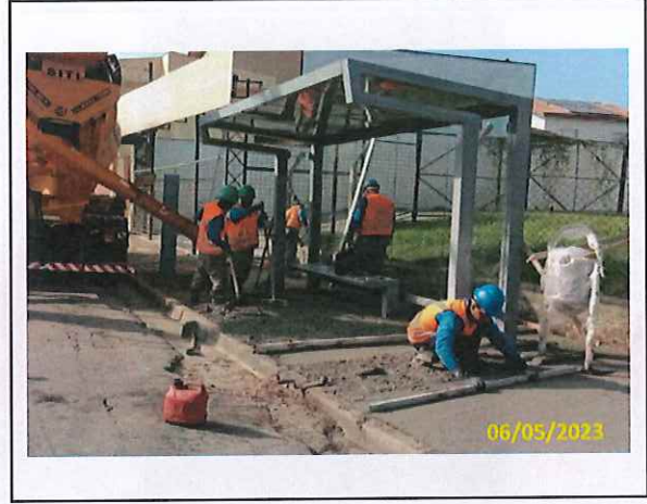
Foto 30 Concretagem do passeio
