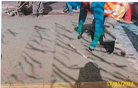
Foto 03 Concretagem do passeio (2ª parte)
