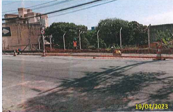
Foto 04 Instalação de guias
