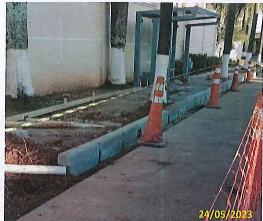
Foto 34 Instalação de guias
