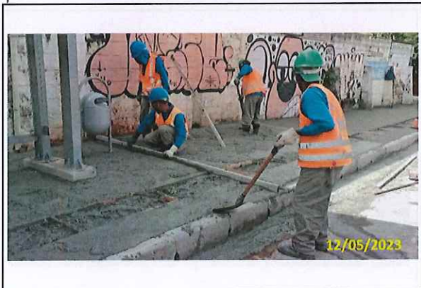
Foto 14 Concretagem do passeio
