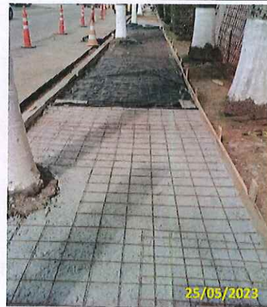
Foto 36 Instalação de tela metálica
