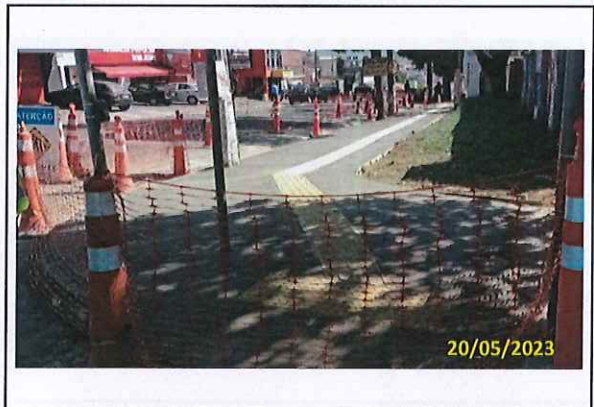
Foto 11 Vista do passeio executado
