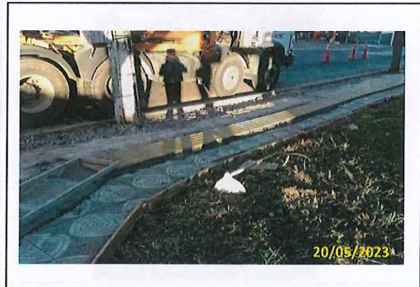
Foto 09 Instalação de piso podotátil
