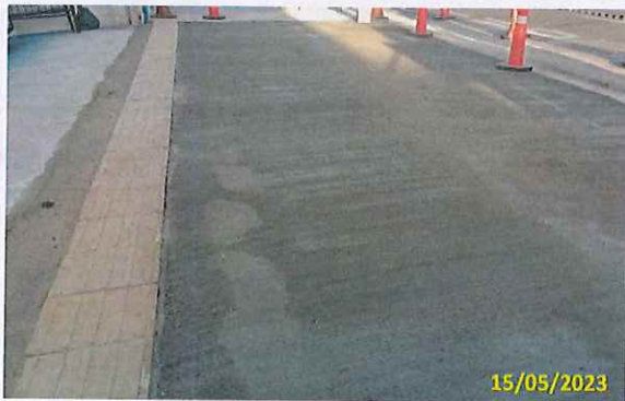
Foto 01 Acabamento vassourado (1ª parte)
