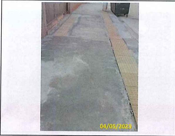
Foto 28 Instalação de piso podotátil
