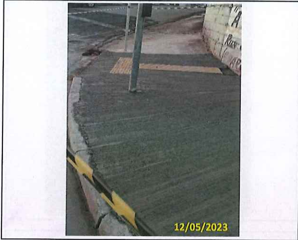
Foto 16 Instalação de piso podotátil
