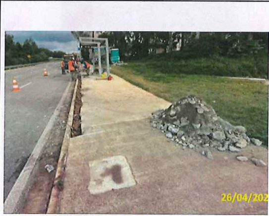
Foto 21 Demolição do passeio existente
