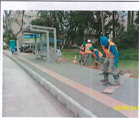
Foto 22 Concretagem do passeio
