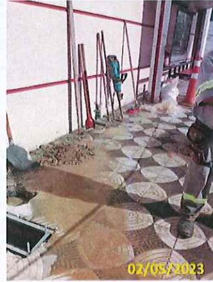
Foto 09 Instalação dos chumbadores do abrigo
