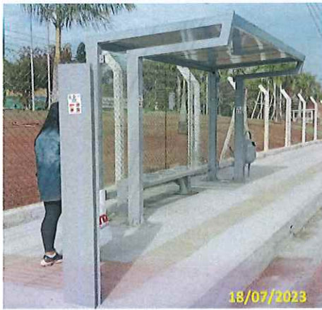
Foto 18 Vista lateral esquerda do conjunto instalado
