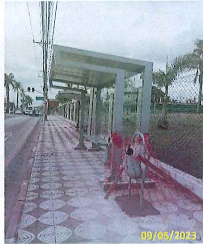
Foto 17 Abrigo e lixeira instalados
