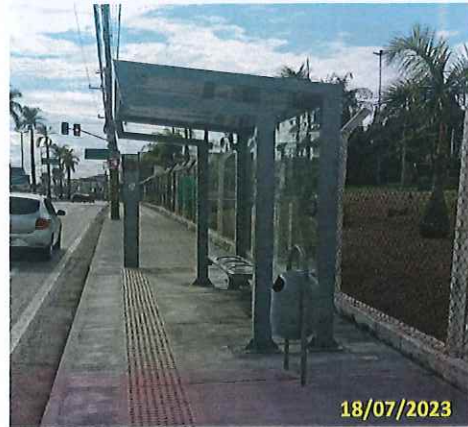
Foto 19 Vista lateral direita do conjunto instalado
