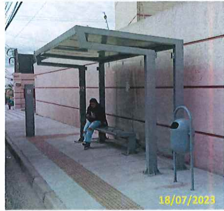
Foto 11 Vista do conjunto instalado
