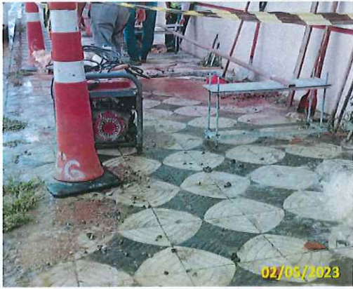
Foto 08 Preparação para instalação dos chumbadores
