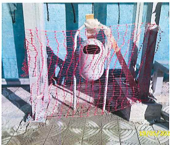
Foto 03 Instalação de lixeira
