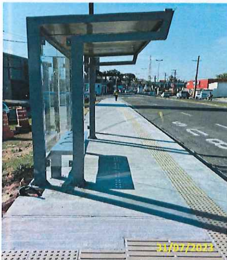
Foto 22 Instalação do abrigo
