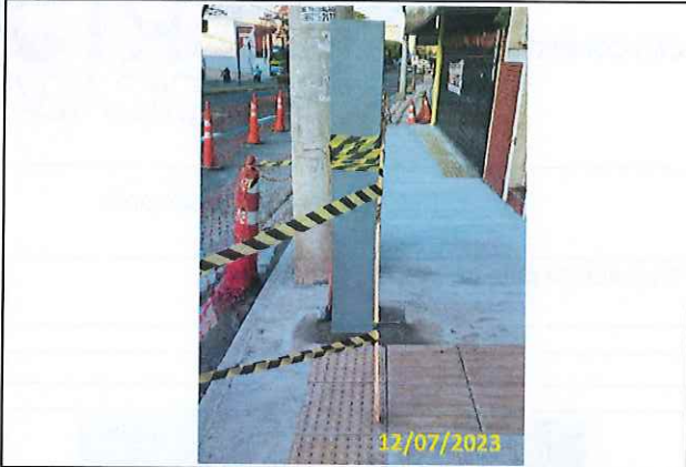
Foto 05 Ancoragem do totem instalado
