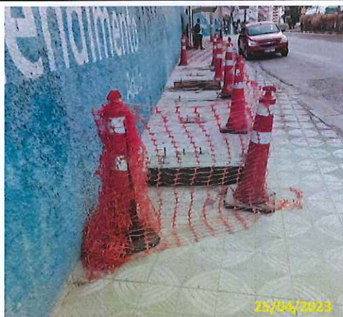
Foto 01 Instalação dos chumbadores do abrigo
