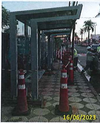
Foto 14 Instalação dos abrigos
