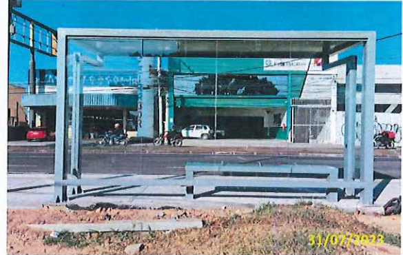
Foto 21 Instalação dos chumbadores
