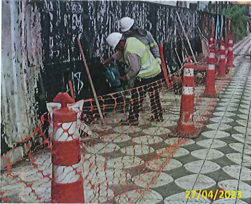
Foto 12 Preparação para instalação do chumbador
