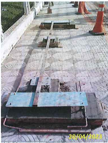
Foto 16 Instalação do chumbador
