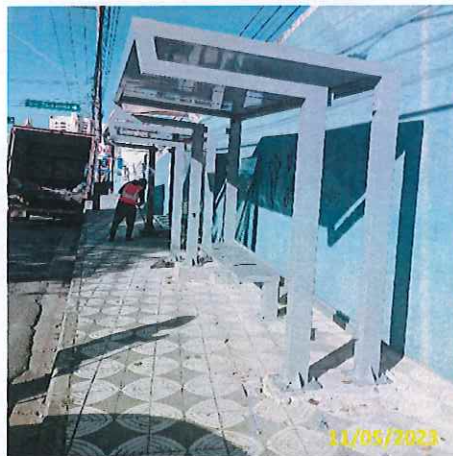
Foto 02 Instalação do abrigo
