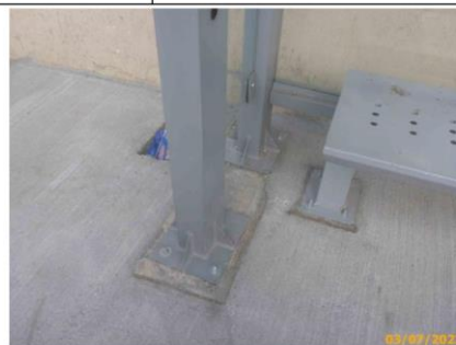
Foto 18 – Detalhe da fixação do abrigo.
