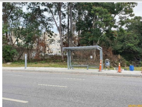
Foto 12 – Vista da parada de ônibus, estaca 82.
