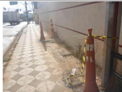
Foto 12 – Vista dos apoios do novo abrigo executados ao lado do antigo abrigo.
