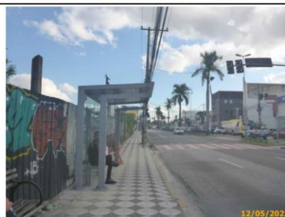
Foto 22 – Abrigo novo com equipamentos parciais instalados (cobertura, vedações, lixeira e banco).
