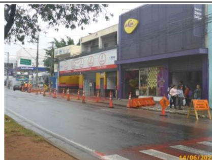
Foto 16 – Intervenção das obras no passeio em referência.
