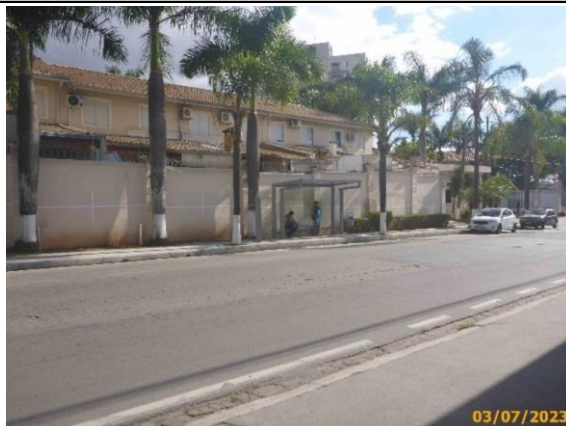
Foto 15 – Vista da parada de ônibus, estaca 13.
