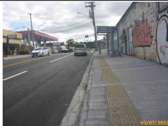
Foto 10 – Vista da parada de ônibus, estaca 97.
