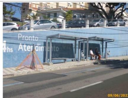
Foto 4 – Vista do Ponto de Parada contendo, o totem, e, os abrigos (cobertura, e vedações laterais e posterior com vidros), os bancos e as lixeiras.
