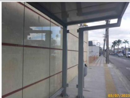
Foto 15 – Vista das vedações lateral e posterior do abrigo.
