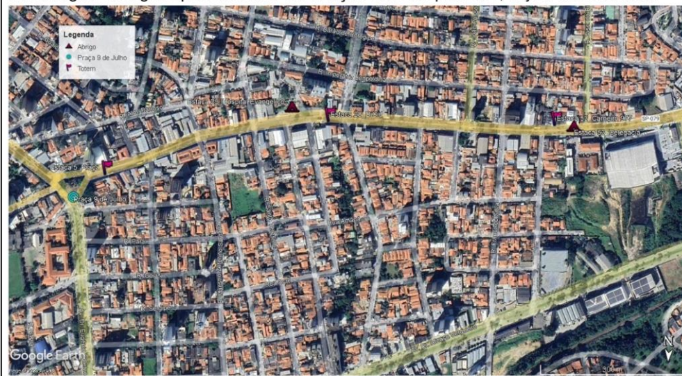
Corredor Oeste – Reforma dos Passeios – Trecho 4 Boletim de Medição - BM 31 – Evento /Marco - M66
