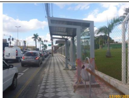
Foto 28 – Abrigo com a lixeira, a cobertura, o banco, e, as vedações instaladas, restando o totem.
