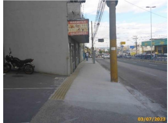
Foto 4 – Vista da parada de ônibus, estaca 70.
