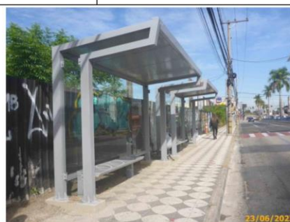
Foto 24 – Segue foto anterior. Abrigos contendo as coberturas, as vedações, os bancos e as lixeiras.
