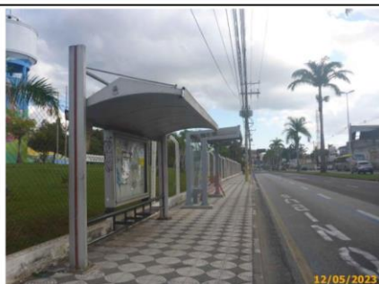
Foto 27 – Vista geral do Ponto de Parada com o abrigo a ser substituído, e ao fundo, o abrigo novo.
