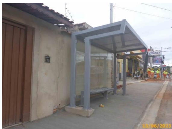
Foto 11 – Vista da parada de ônibus, estaca 102.
