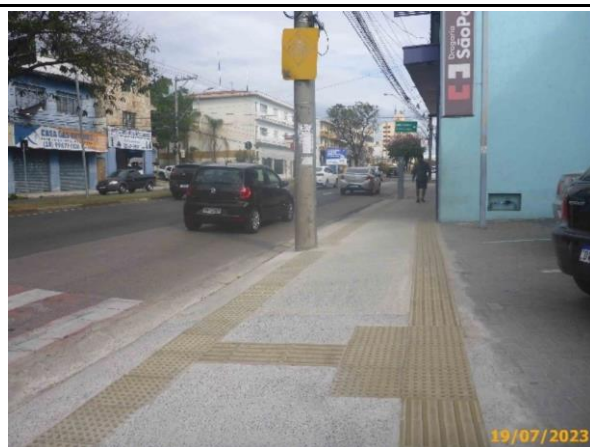
Foto 2 – Vista da parada de ônibus, estaca 28.
