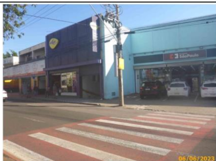
Foto 15 – Vista geral do ponto de parada, pretérita à reforma do passeio.
