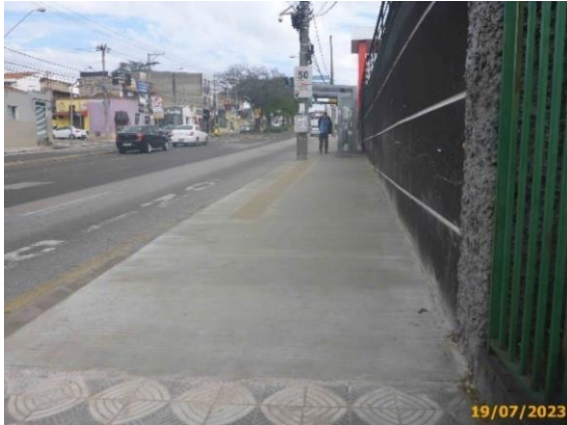
Foto 3 – Vista da parada de ônibus, estaca 53.
