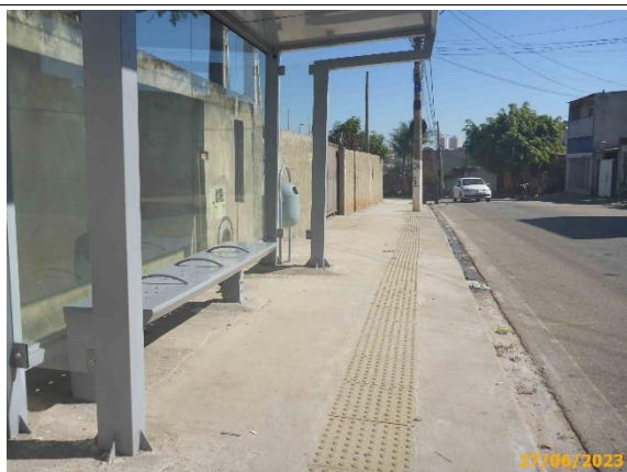
Foto 13 – Vista da parada de ônibus, estaca 59.
