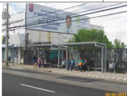
Foto 23 – Vista dos dois abrigos instalados no Ponto de Parada com equipamentos parciais.
