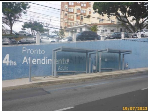
Foto 16 – Vista da parada de ônibus com os equipamentos em conformidade com o Anexo II de Edital. Estaca 25.
