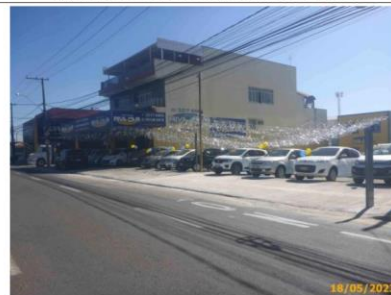
Foto 6 – Reforma do passeio concluída na calçada da agência de automóveis.
