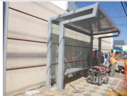
Foto 14 – Abrigo, vedações, e banco instalados no Ponto de Parada.
