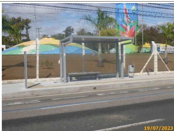
Foto 20 – Vista da parada de ônibus com os equipamentos em conformidade com o Anexo II de Edital. Estaca 100.
