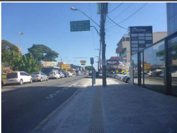
Foto 7 – Vista da parada de ônibus, estaca 17.
