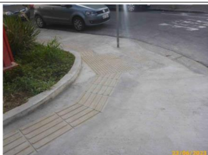
Foto 19 – Acessibilidade na área de intervenção das obras, sentido centro.
