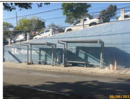
Foto 2 – Vista de parte dos equipamentos urbanos instalados.
