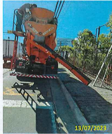
Foto 20 Início da concretagem do passeio
