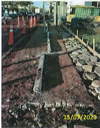
Foto 25 Demolição do passeio existente (1º Trecho)
