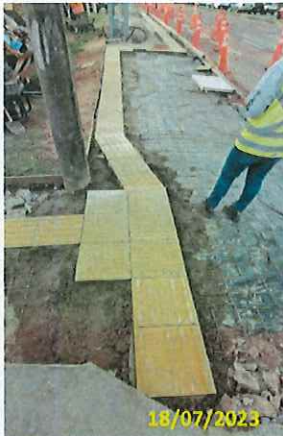
Foto 29 Instalação de piso podotátil (1º Trecho)
