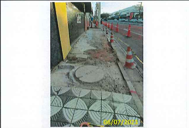
Foto 07 Demolição do passeio existente
