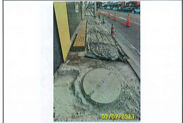
Foto 08 Instalação da lona e tela e instalação do piso podotátil
