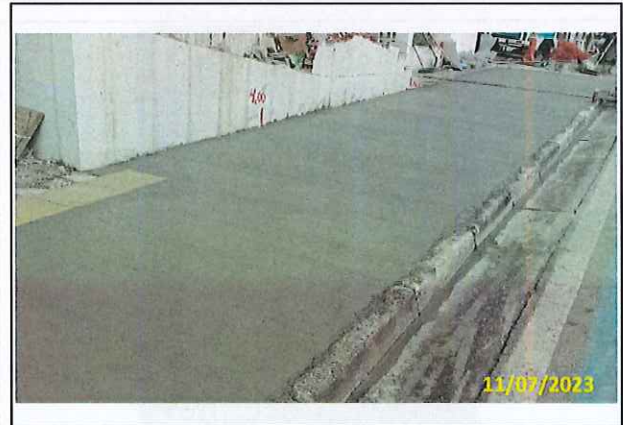
Foto 10 Execução de acabamento vassourado
