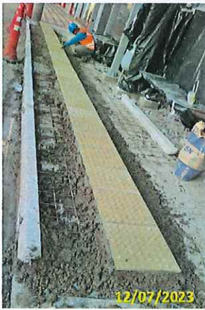
Foto 17 Instalação do piso podotátil
