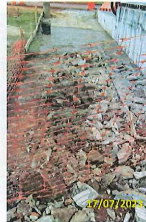
Foto 26 Demolição do passeio existente (2º Trecho)
