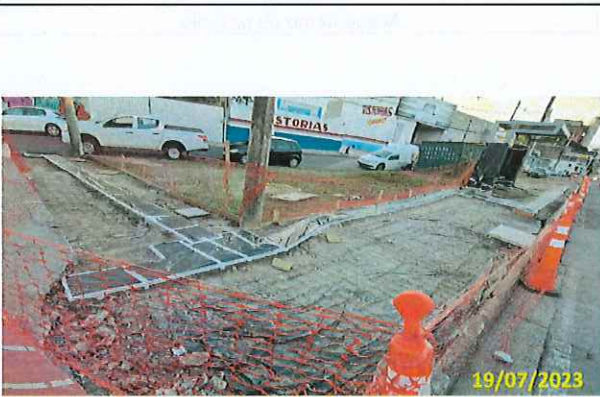
Foto 29 Instalação de piso podotátil (1º Trecho)
