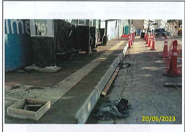
Foto 06 Concretagem do passeio
