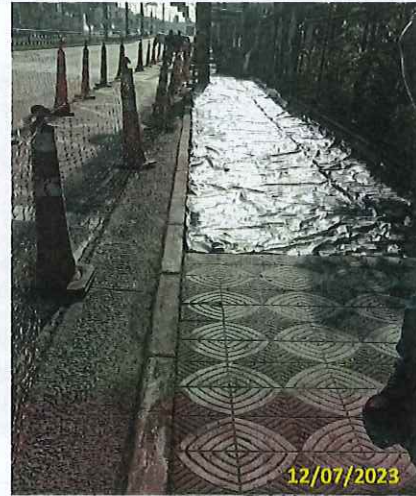
Foto 16 Instalação de lona
