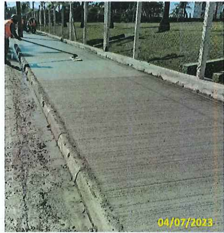
Foto 24 Execução de acabamento vassourado
