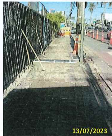
Foto 18 Tela metálica instalada
