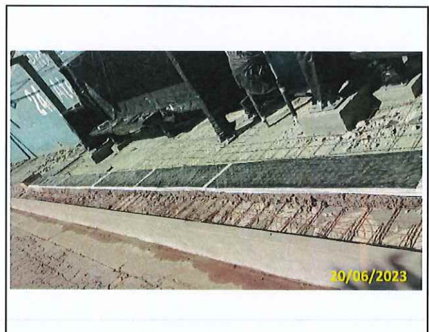
Foto 04 Preparação para concretagem
