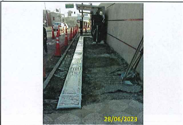
Foto 13 Preparo para concretagem
