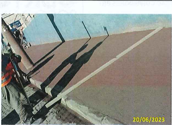
Foto 05 Concretagem do passeio em andamento
