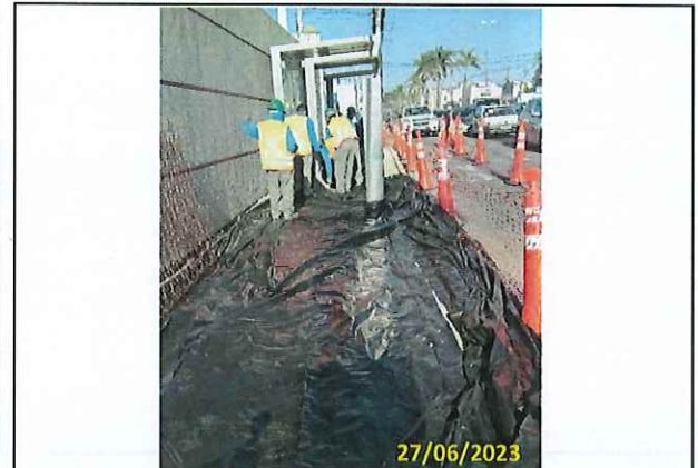
Foto 12 Instalação da lona e tela metálica
