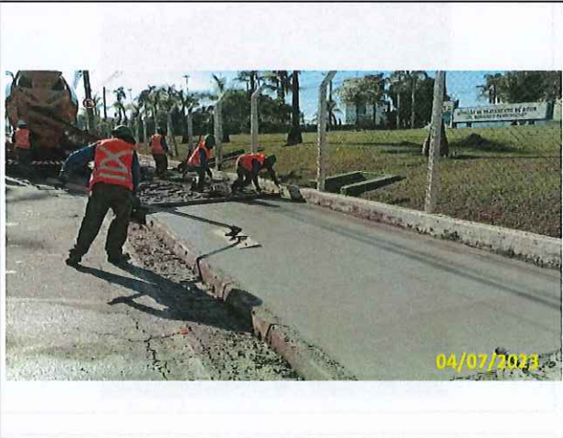
Foto 23 Concretagem do passeio
