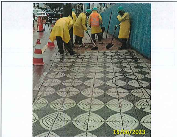
Foto 01 Demolição do passeio existente
