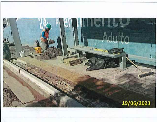
Foto 03 Instalação da tela metálica e instalação do piso podotátil
