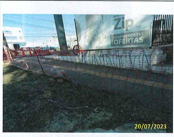
Foto 33 Concretagem do passeio (2º Trecho)
