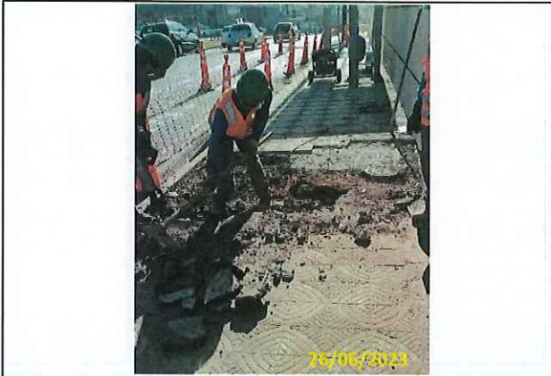
Foto 11 Demolição do passeio existente
