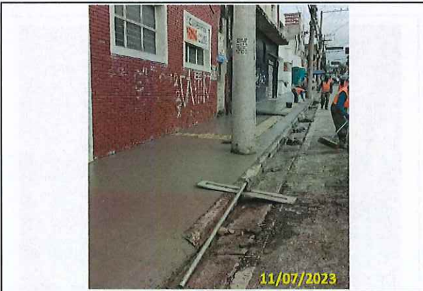
Foto 09 Concretagem do passeio
