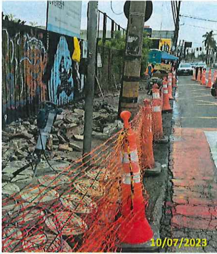
Foto 15 Demolição do passeio existente
