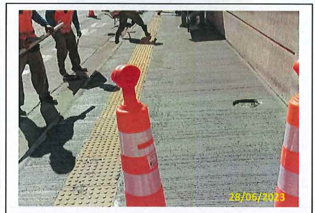
Foto 14 Execução de acabamento vassourado
