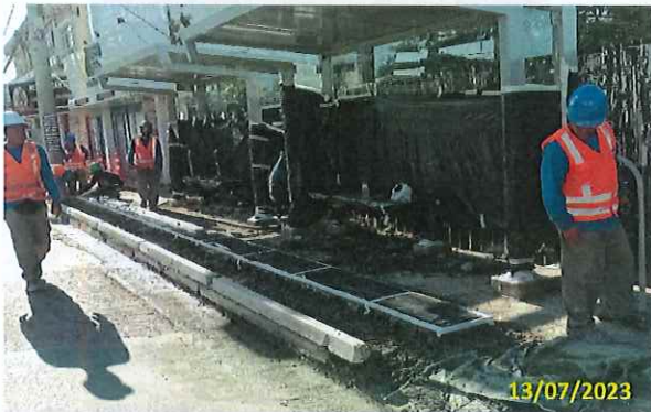
Foto 19 Preparo para concretagem
