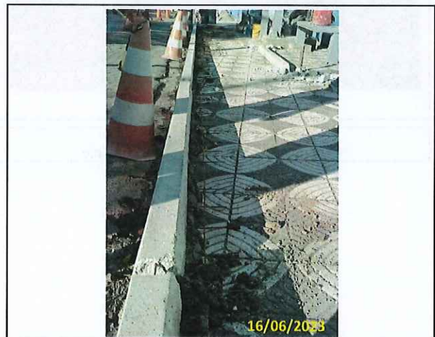
Foto 02 Assentamento de guia
