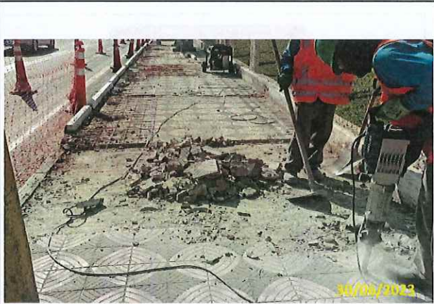
Foto 21 Demolição do passeio existente
