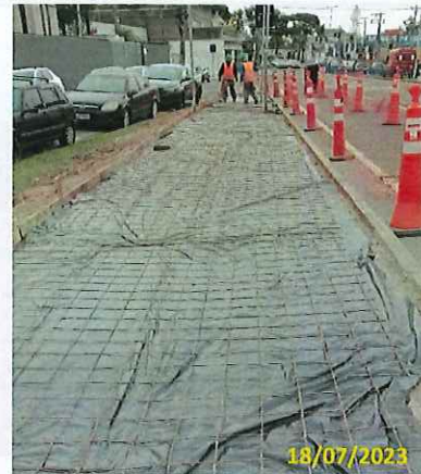
Foto 28 Instalação de lona e tela metálica
