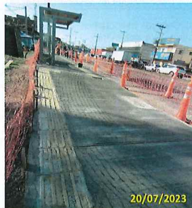
Foto 32 Concretagem do passeio (1º Trecho)
