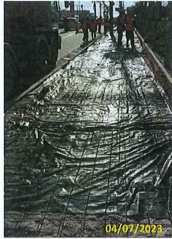
Foto 22 Instalação de lona e tela metálica
