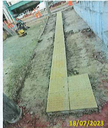
Foto 30 Instalação de piso podotátil (2º Trecho)
