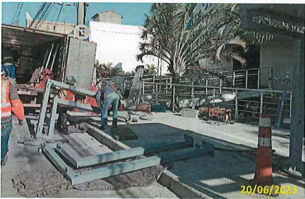
Foto 16 Instalação do 3º abrigo
