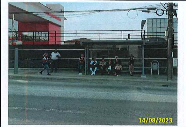
Foto 08 Vista do conjunto instalado
