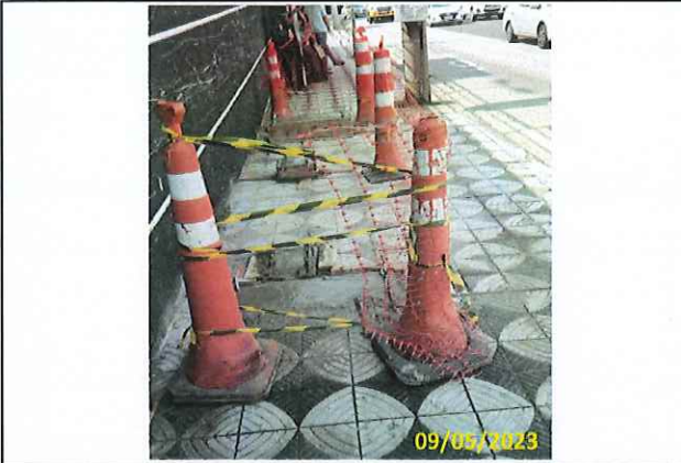
Foto 04 Instalação dos chumbadores do abrigo
