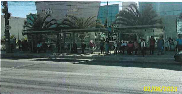
Foto 18 Vista do conjunto instalado
