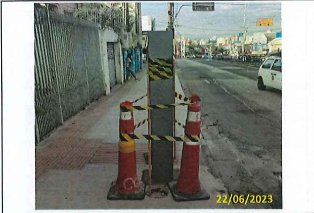
Foto 09 Ancoragem e sinalização do totem instalado
