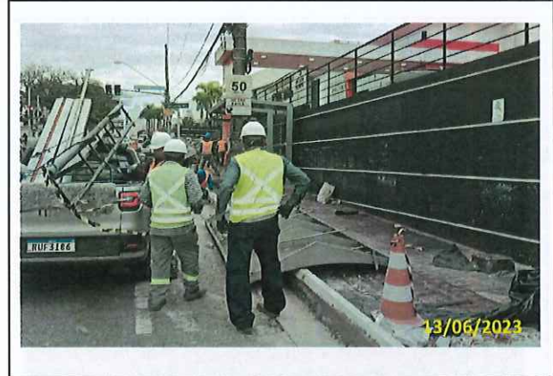
Foto 05 Remoção do abrigo antigo
