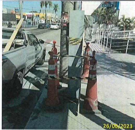
Foto 17 Ancoragem e sinalização do totem instalado
