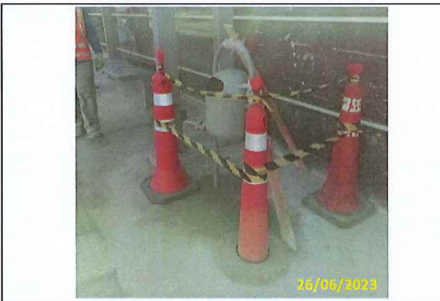
Foto 06 Instalação da lixeira
