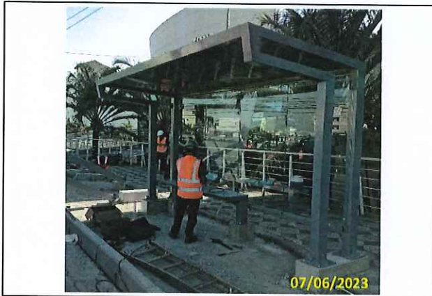
Foto 14 Instalação do vidro do 2º abrigo
