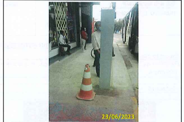
Foto 03 Acabamento da base do totem instalado
