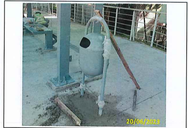
Foto 15 Instalação da lixeira
