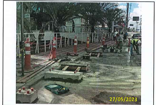
Foto 13 Instalação dos chumbadores do abrigo
