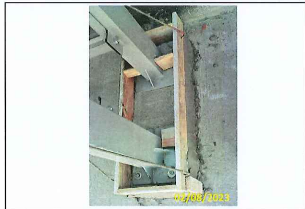
Foto 07 Acabamento da base do abrigo
