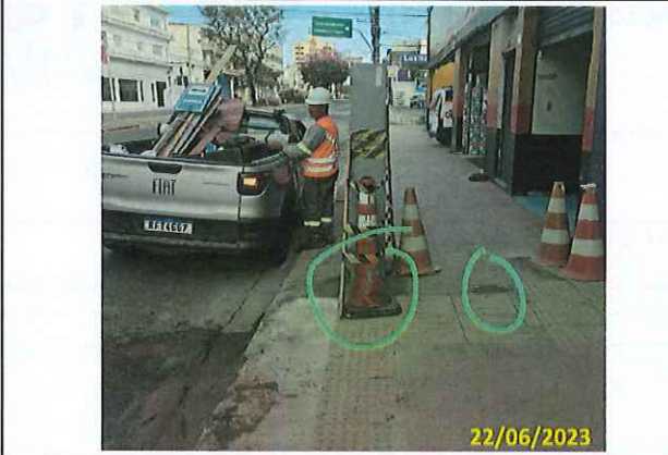
Foto 02 Ancoragem do totem instalado e sinalização
