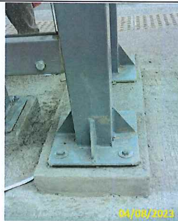
Foto 19 Acabamento da base do abrigo
