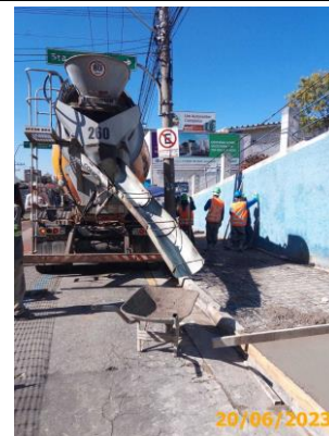
Foto 6 – Reforma do passeio em andamento, em destaque, a aplicação do concreto.
