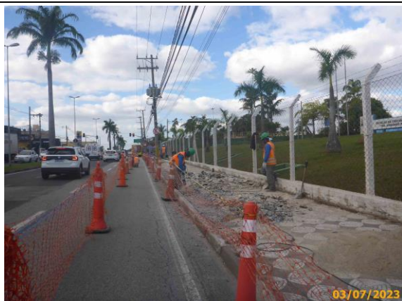
Foto 63 – Demolição do revestimento existente do passeio.
