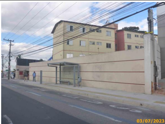
Foto 41 – Vista geral do passeio reformado e, liberado ao tráfego de pedestres.
