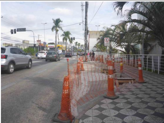
Foto 29 – Bases de apoio dos abrigos executadas no passeio em referência.
