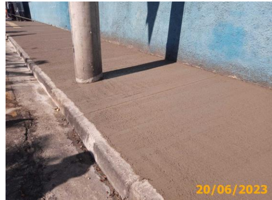
Foto 10 – Vista parcial do passeio após a aplicação do concreto.
