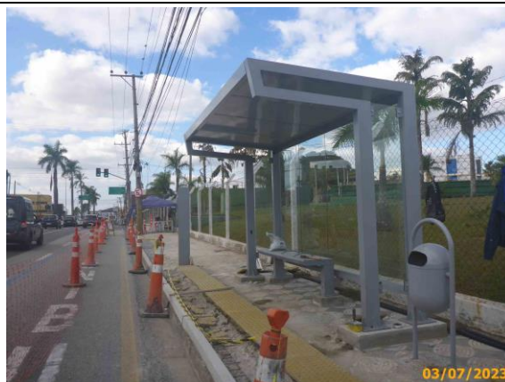
Foto 64 – Execução da sinalização tátil no passeio.
