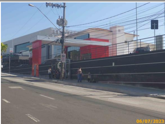
Foto 17 – Vista geral do Ponto de Parada na estaca 53.
