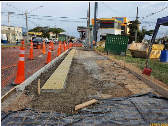
Foto 79 – Preparação da base do passeio, e, a instalação dos ladrilhos tátil.
