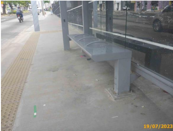
Foto 21 – Detalhe da fixação do vidro lateral.
