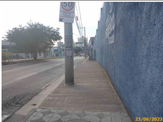
Foto 11 – Vista do passeio liberado após a reforma.
