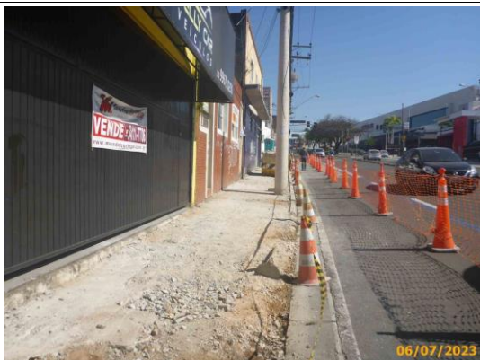
Foto 19 – Demolição do passeio existente na data de acompanhamento do evento.
