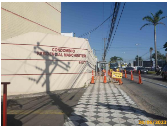
Foto 29 – Intervenção das obras no passeio.
