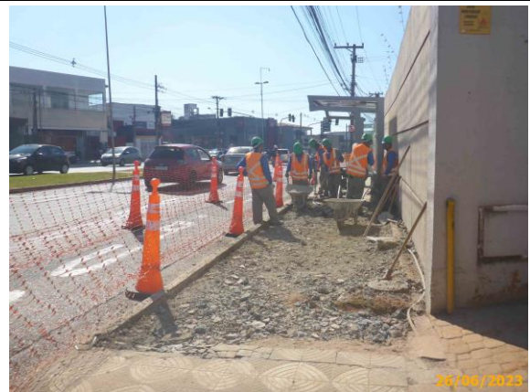
Foto 30 – Demolição do passeio existente.
