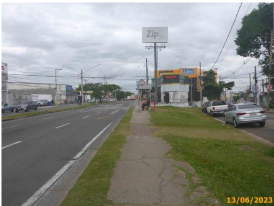
Foto 71 – Vista do ponto de parada pretérita as obras de implantação do BRT.
