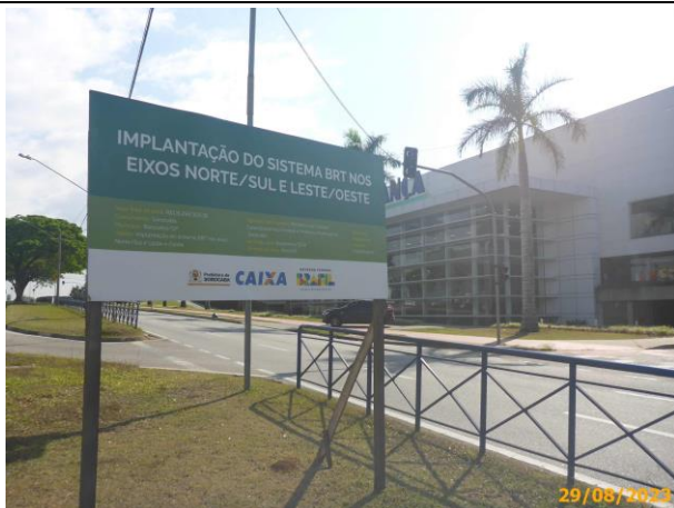
Foto 3 – Vista da placa da obra de Implantação do Sistema BRT instalada na altura do nº 1.601 da avenida Doutor Armando Pannunzio.
