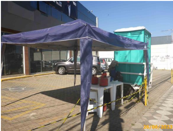
Foto 33 – Área de vivência durante as obras.
