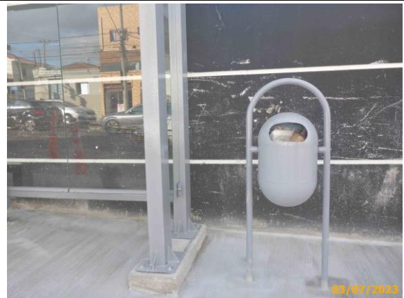
Foto 26 – Detalhe da lixeira.
