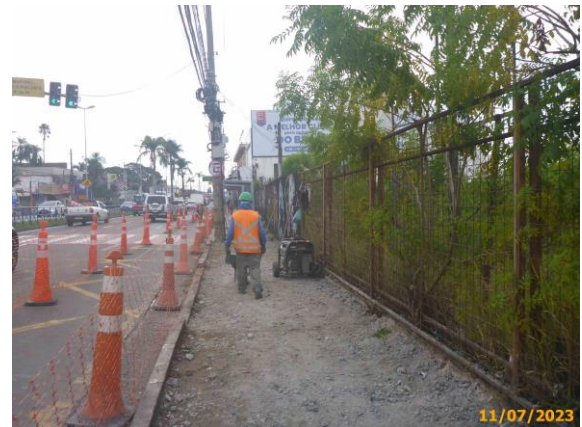
Foto 48 – Demolição do revestimento existente do passeio.
