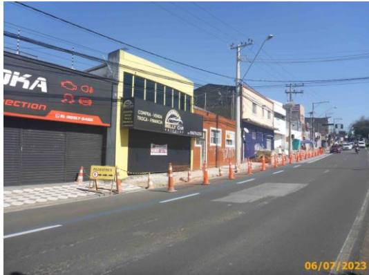
Foto 15 – Vista geral do passeio da estaca 53, com a sinalização provisória durante as obras.
