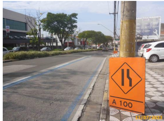
Foto 18 – Sinalização provisória das obras, sentido centro.
