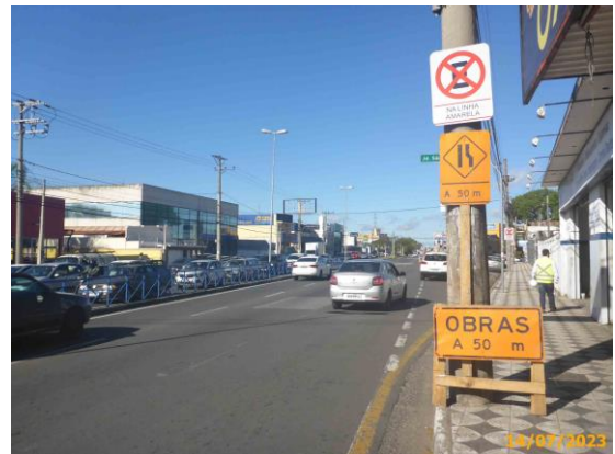
Foto 72 – Sinalização provisória durante a intervenção das obras.
