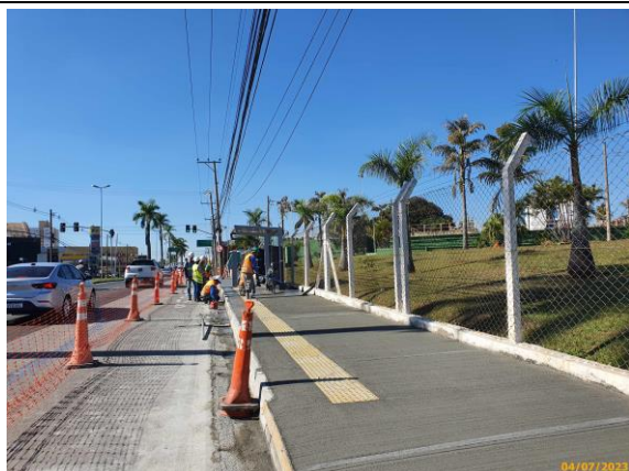
Foto 67 – Aplicação do concreto no passeio. Em destaque, o piso tátil.
