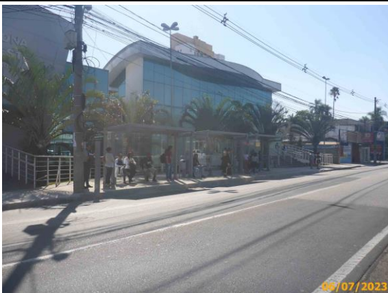
Foto 37 – Vista geral do Ponto de Parada com os equipamentos urbanos e passeio reformado.
