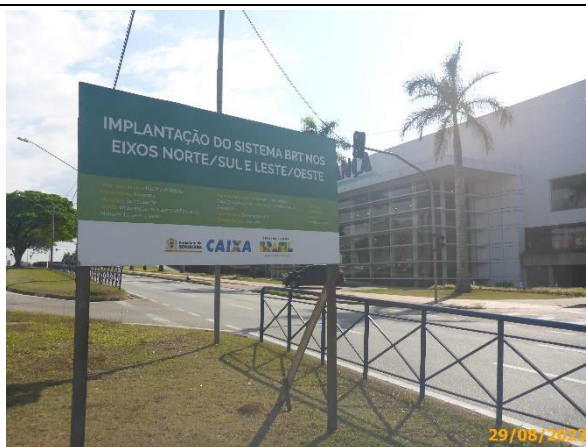
Foto 3 – Vista da placa da obra de Implantação do Sistema BRT instalada na altura do nº 1.601 da avenida Doutor Armando Pannunzio.
