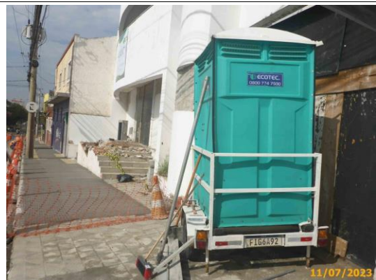
Foto 20 – Banheiro químico disponibilizado na frente de obras.
