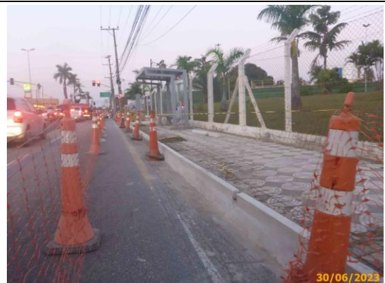
Foto 62 – Guias implantadas para alteamento da calçada.
