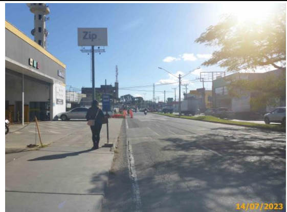
Foto 74 – Ponto de parada provisório durante as obras.
