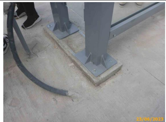
Foto 32 – Detalhe da fixação do abrigo.
