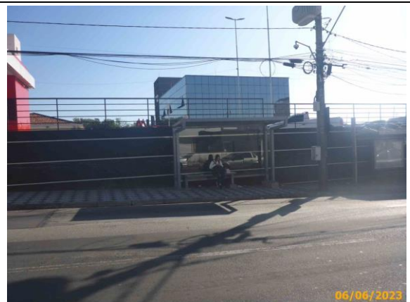
Foto 18 – Vista geral do Ponto de Parada, com parte dos equipamentos instalados (banco e abrigo).
