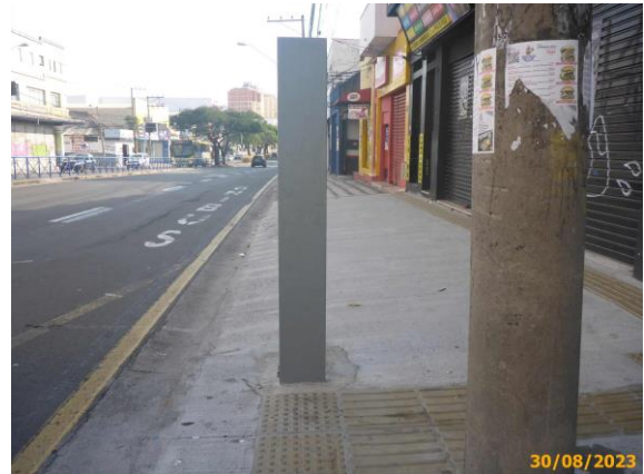
Foto 8 – Totem (marco) instalado.
