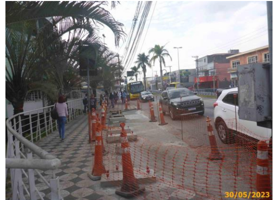
Foto 28 – Bases de apoio dos abrigos executadas no passeio em referência.
