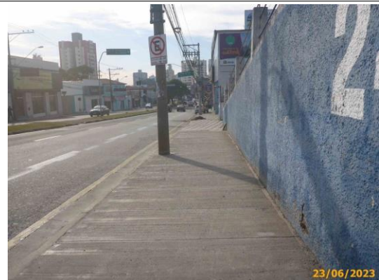
Foto 12 – Vista do passeio liberado após a reforma.
