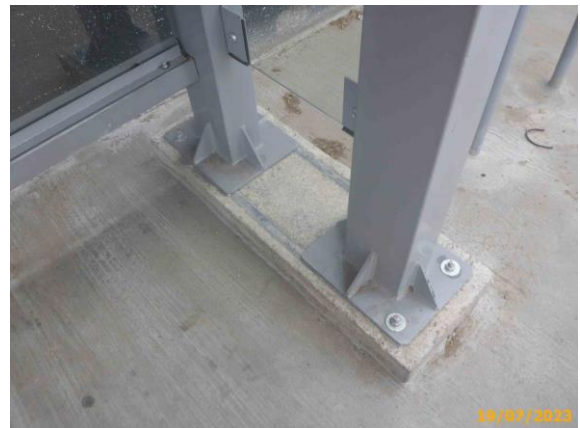
Foto 24 – Detalhe da fixação dos apoios do abrigo.
