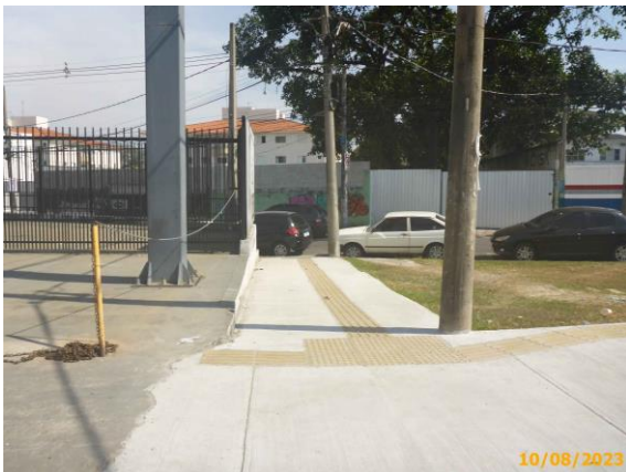
Foto 89 – Vista do passeio reformado, em destaque o piso tátil.
