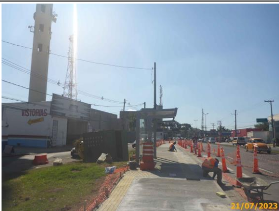
Foto 85 – Vista parcial do passeio após a aplicação do concreto.
