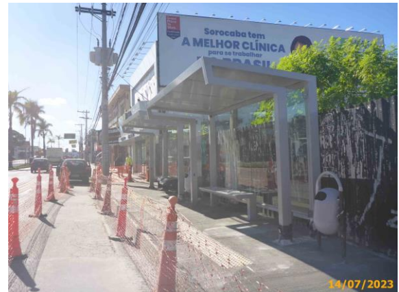
Foto 52 – Concreto aplicado no passeio em referência.
