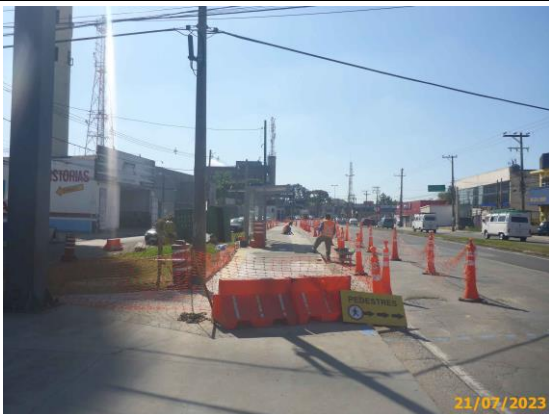
Foto 83 – Vista parcial do passeio após a aplicação do concreto.
