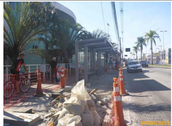
Foto 30 – Vista dos dois abrigos instalados no Ponto de Parada com equipamentos parciais.
