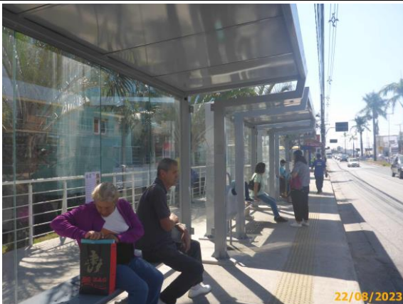
Foto 35 – Equipamentos urbanos instalados no PP (coberturas, lixeiras, bancos, e, vedações).
