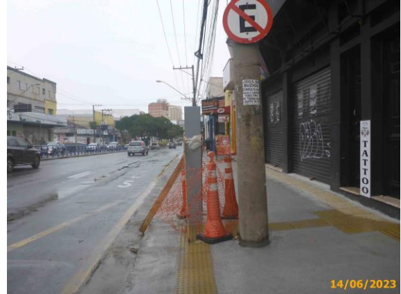
Foto 6 – Equipamento urbano (marco) instalado no ponto de parada.
