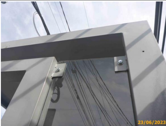
Foto 25 – Detalhe da fixação do vidro lateral.
