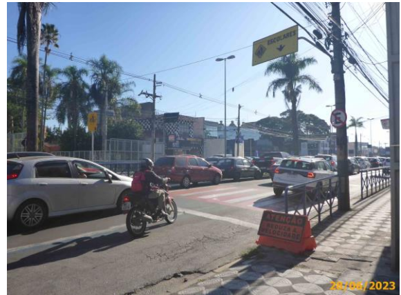
Foto 34 – Sinalização provisória na avenida General Carneiro.
