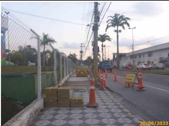
Foto 59 – Sinalização provisória de isolamento e condução de pedestres durante as obras.
