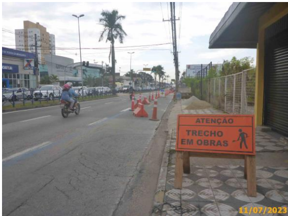
Foto 45 – Sinalização provisória durante a intervenção das obras.
