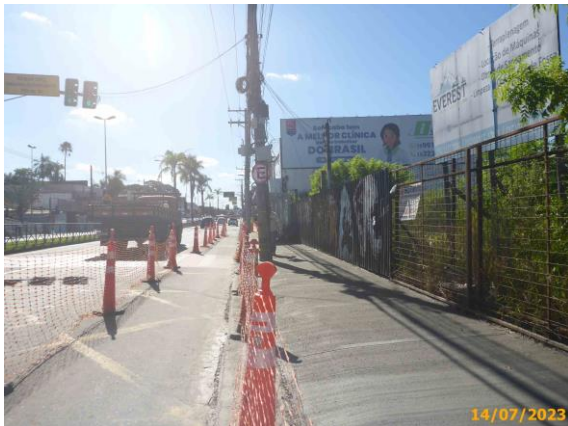
Foto 51 – Concreto aplicado no passeio em referência.
