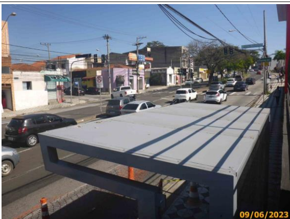
Foto 19 – Vista da cobertura do abrigo.
