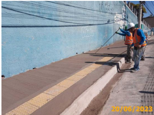
Foto 9 – Segue foto anterior. Em destaque, a execução dos frisos para aumento da rugosidade no passeio.
