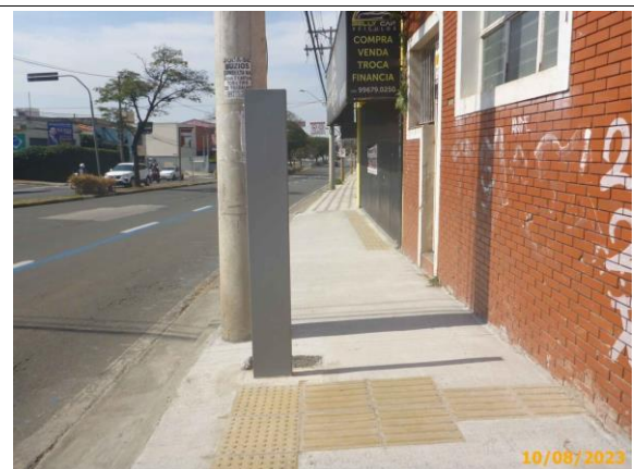
Foto 26 – Vista parcial do passeio com a sinalização tátil implantada.
