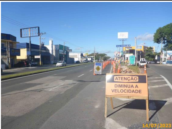
Foto 73 – Sinalização provisória durante a intervenção das obras.
