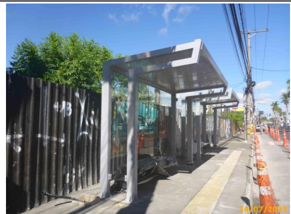
Foto 50 – Concreto aplicado no passeio em referência.
