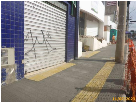
Foto 21 – Piso em concreto implantado no passeio.
