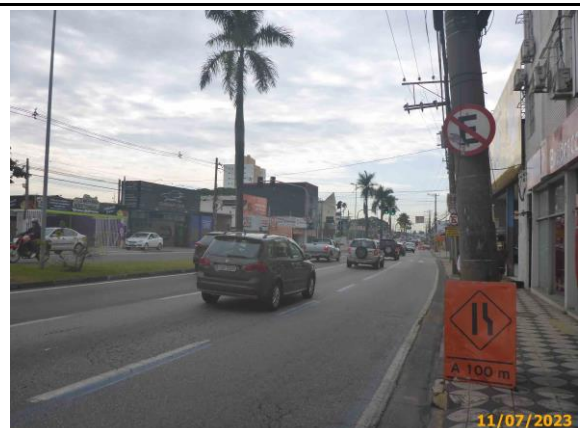
Foto 44 – Sinalização provisória durante as obras.
