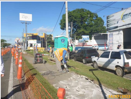
Foto 77 – Demolição do revestimento existente.
