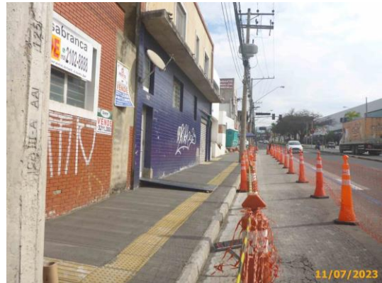
Foto 22 – Segue foto anterior, em destaque, a sinalização tátil implantada.
