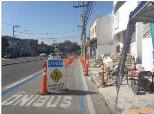
Foto 17 – Sinalização provisória das obras. Em destaque, a passagem de pedestres sentido centro.
