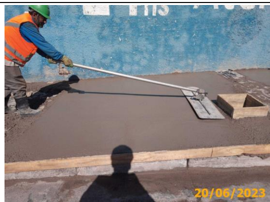
Foto 8 – Desempeno do concreto através do "float de aço".
