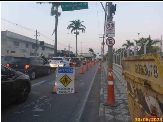
Foto 61 – Sinalização provisória de isolamento e condução de pedestres durante as obras.
