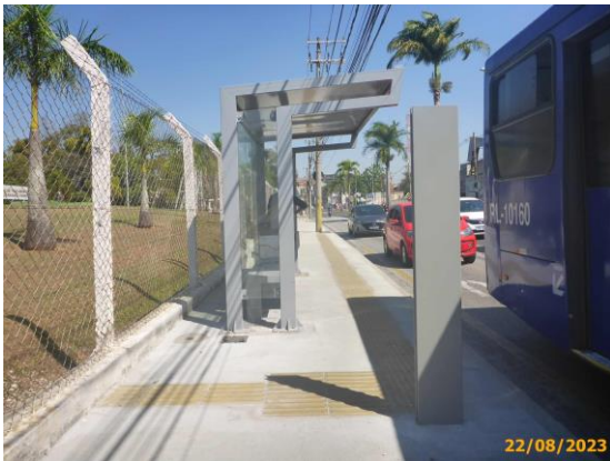
Foto 69 – Vista do passeio, em destaque o piso tátil.
