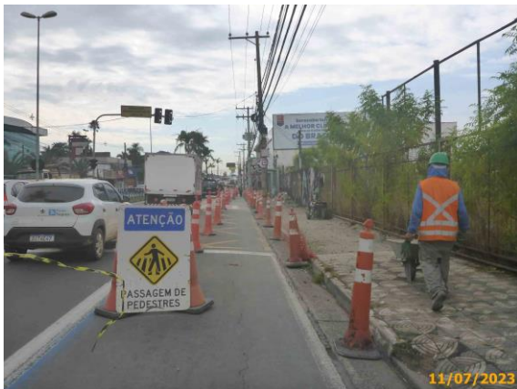
Foto 47 – Sinalização provisória durante a intervenção das obras. Em destaque, a sinalização de passagem de pedestres.
