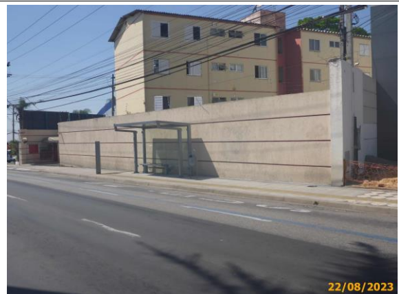
Foto 42 – Vista geral do passeio reformado e, liberado ao tráfego de pedestres.
