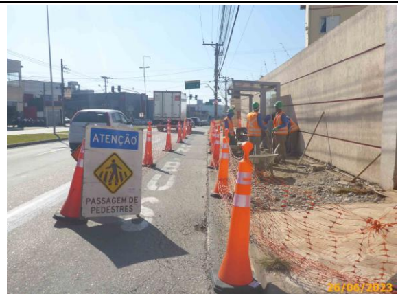
Foto 32 – Sinalização provisória de isolamento das obras, e condução dos pedestres.
