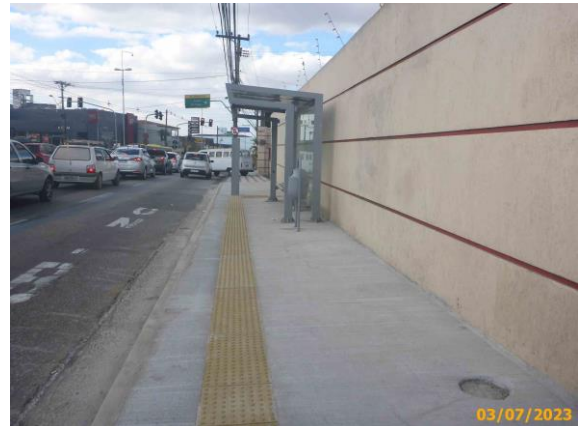
Foto 40 – Vista parcial do passeio após a conclusão da reforma. Em destaque, o ladrilho tátil de alerta
