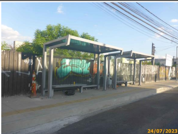
Foto 53 – Vista parcial do passeio reformado.
