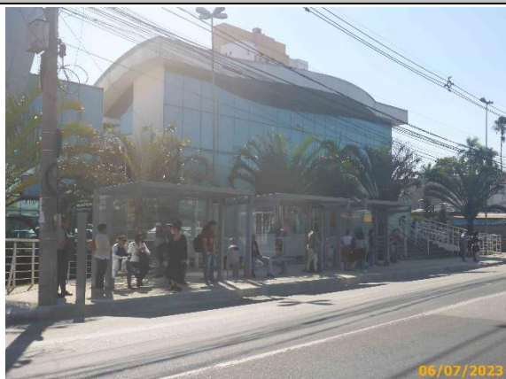
Foto 15 – Vista da parada de ônibus com os equipamentos em conformidade com o Anexo II de Edital. Estaca 85.
