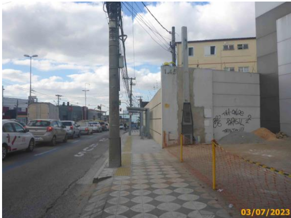
Foto 39 – Vista parcial do passeio após a conclusão da reforma.
