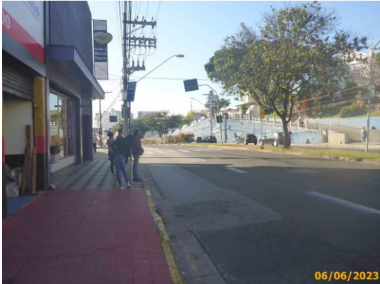
Foto 11 – Vista do ponto da parada antes da intervenção das obras.
