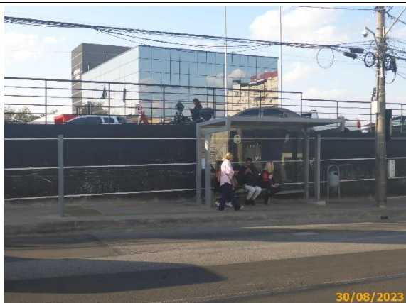
Foto 13 – Vista da parada de ônibus com os equipamentos em conformidade com o Anexo II de Edital. Estaca 53.
