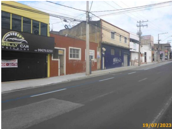
Foto 27 – Vista geral do passeio reformado.
