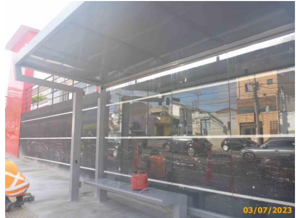
Foto 22 – Banco e vedações do abrigo instalados.
