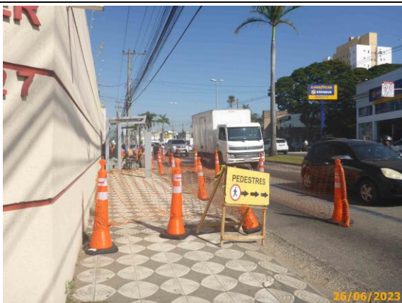
Foto 31 – Sinalização provisória de isolamento das obras, e condução dos pedestres.
