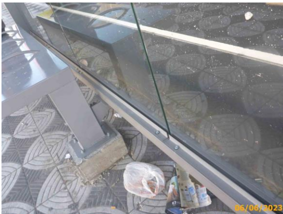
Foto 23 – Detalhe da fixação do vidro lateral.
