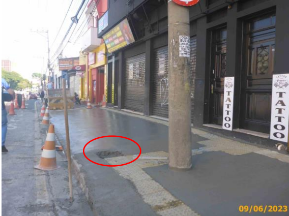
Foto 5 – Vista parcial do Ponto de Parada com o furo no passeio para a instalação do marco (totem).
