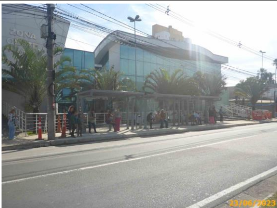
Foto 31 – Vista de implantação dos três abrigos completos (cobertura, lixeira, banco e vedações em vidro).
