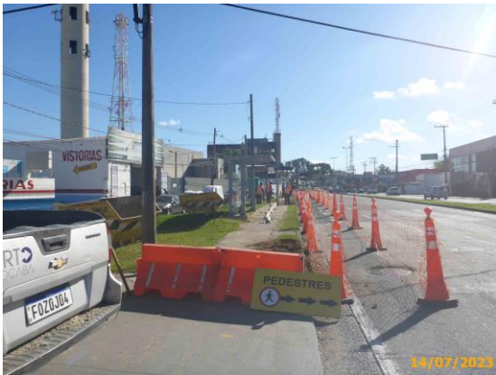
Foto 75 – Sinalização provisória durante as obras. Em destaque, a condução de pedestres.
