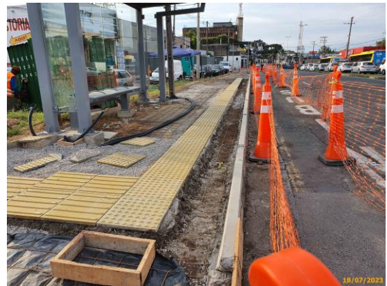
Foto 82 – Segue foto anterior. Em destaque, o alçamento do passeio.
