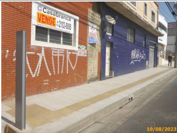
Foto 23 – Sinalização tátil implantada na parada de ônibus.
