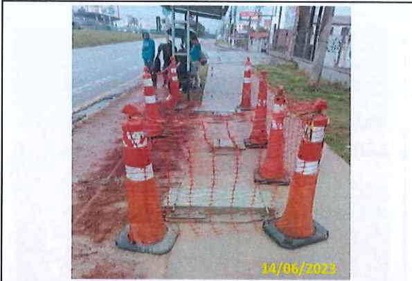
Foto 20 Instalação dos chumbadores do abrigo
