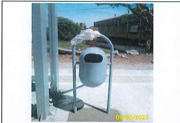
Foto 21 Ancoragem da lixeira instalada
