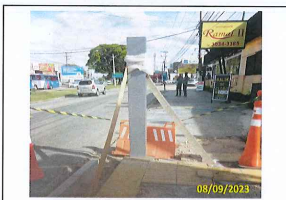
Foto 16 Ancoragem do totem instalado
