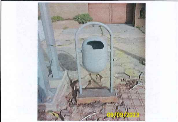
Foto 19 Vista da lixeira instalada
