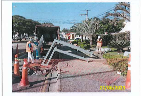
Foto 29 Instalação do abrigo
