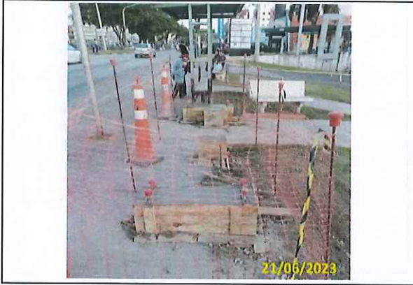
Foto 24 Instalação de chumbadores do abrigo
