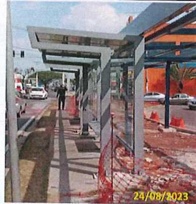
Foto 07 Instalação do 2º abrigo
