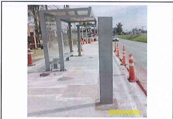
Foto 23 Vista do totem e abrigo instalados
