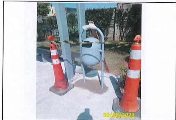
Foto 33 Instalação da lixeira
