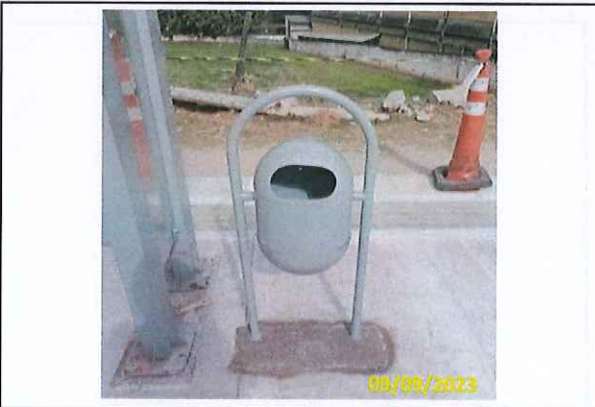
Foto 22 Vista da lixeira instalada
