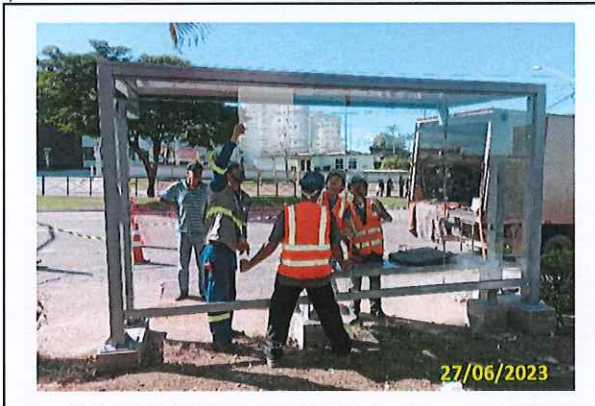
Foto 30 Instalação de vidro do abrigo
