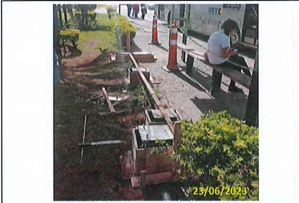
Foto 28 Instalação dos chumbadores do abrigo
