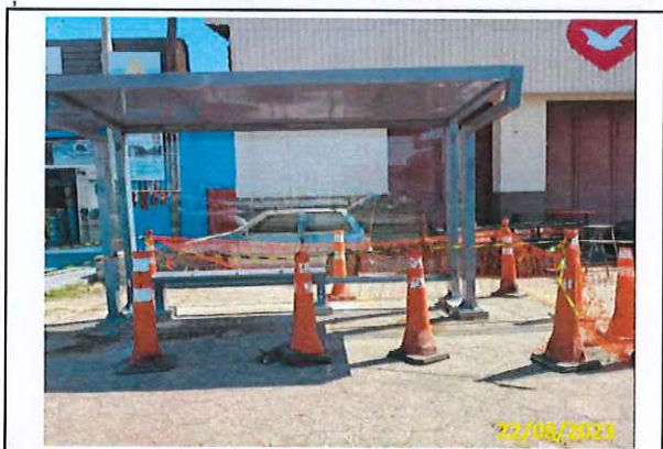
Foto 15 Vista do abrigo instalado
