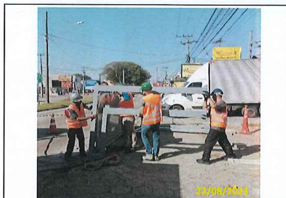
Foto 14 Instalação do abrigo
