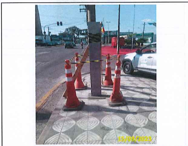
Foto 01 Ancoragem do totem instalado
