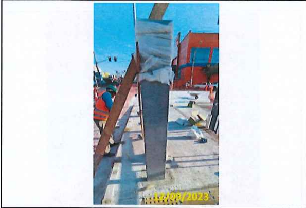
Foto 08 Instalação dos chumbadores do abrigo
