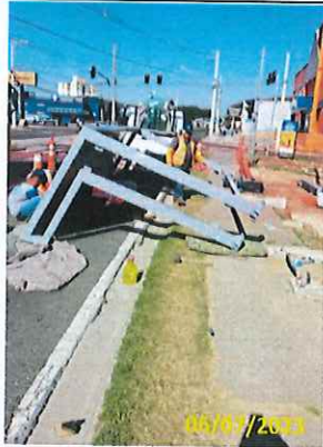
Foto 04 Instalação do 1º abrigo
