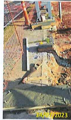
Foto 05 Instalação dos chumbadores referente ao 2º abrigo
