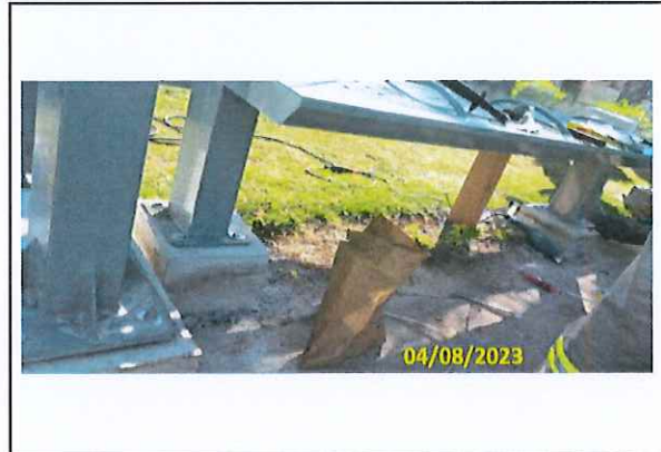
Foto 31 Chumbamento do banco do abrigo
