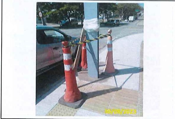
Foto 32 Instalação do totem
