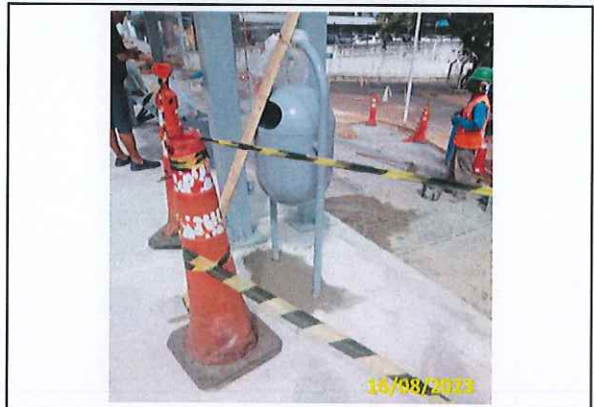
Foto 27 Instalação da lixeira
