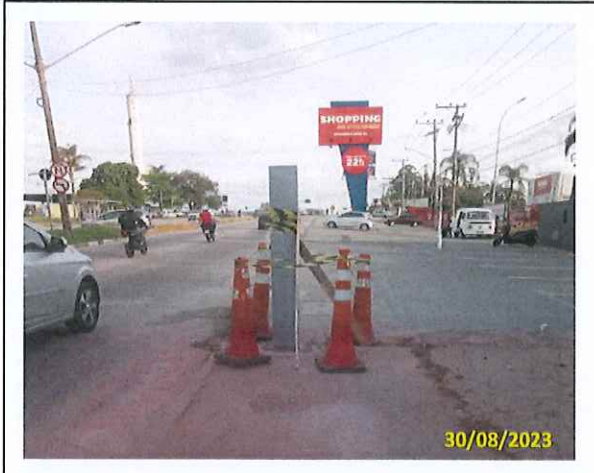
Foto 34 Ancoragem do totem instalado
