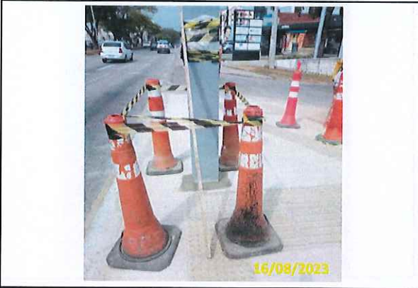
Foto 26 Instalação do totem
