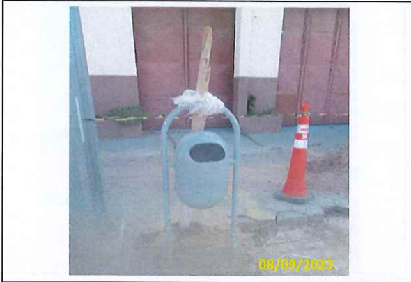
Foto 17 Ancoragem da lixeira instalada
