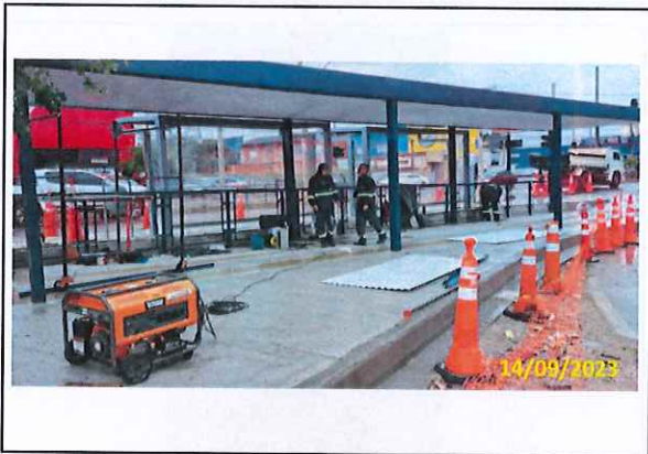
Foto 12 Instalação do forro do abrigo de conexão
