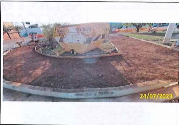
Foto 05 Local limpo para concretagem (Ilha)
