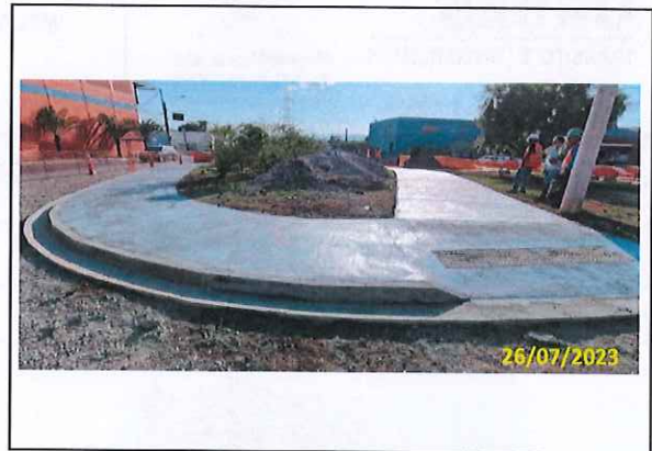
Foto 06 Passeio concretado em processo de cura (Ilha)
