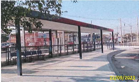
Foto 17 Vista do abrigo de conexão
