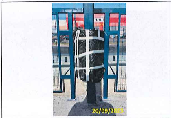
Foto 15 Instalação das lixeiras do abrigo de conexão
