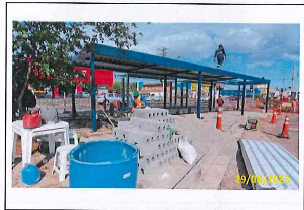
Foto 08 Instalação das telhas do abrigo de conexão
