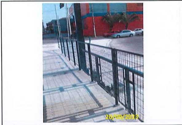
Foto 13 Instalação de guarda corpo
