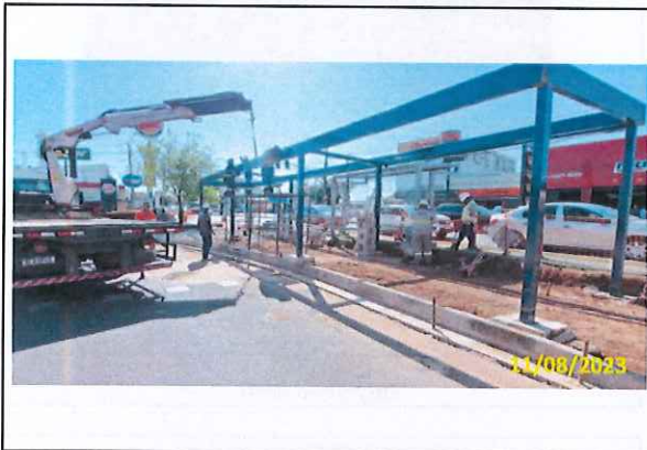
Foto 07 Instalação do abrigo de conexão
