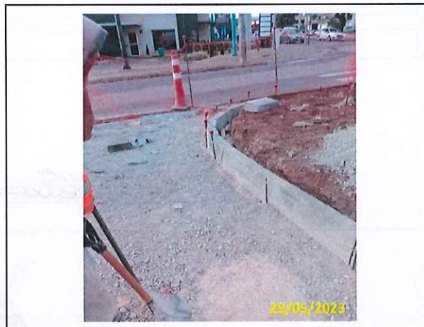
Foto 03 Assentamento de guias (Ilha)
