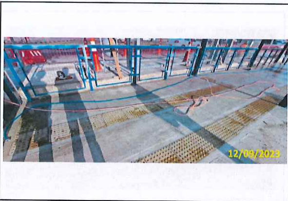
Foto 11 Instalação do gradil do abrigo de conexão
