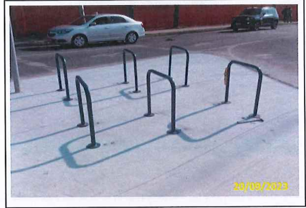
Foto 14 Instalação de paraciclos
