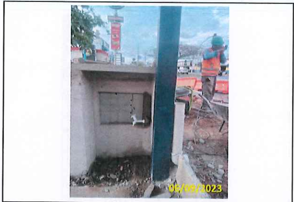
Foto 10 Instalação de registro e torneira da Caixa do SAAE
