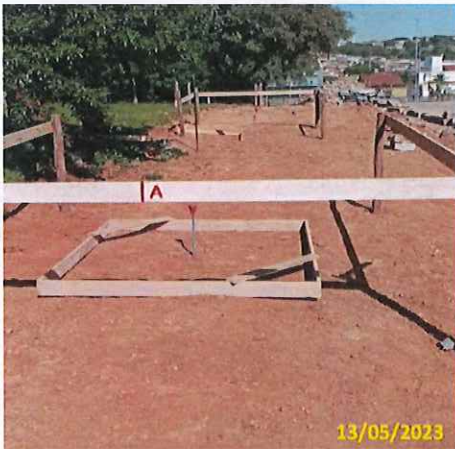
Foto 01 Gabarito da fundação
