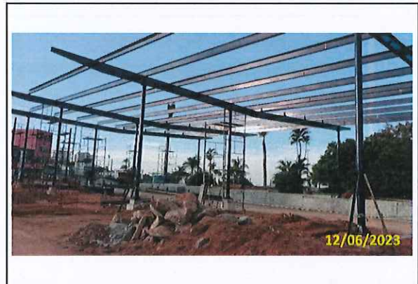
Foto 12 Montagem da estrutura metálica - cantoneira
