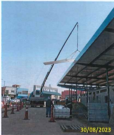
Foto 21 Finalização da instalação das telhas
