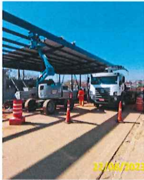
Foto 19 Início da instalação das telhas
