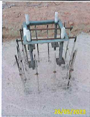
Foto 07 Instalação do chumbador da estrutura metálica
