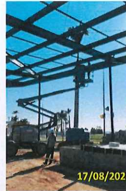
Foto 18 Montagem da estrutura metálica - Solda e pintura
