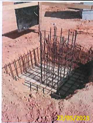
Foto 05 Armação da sapata
