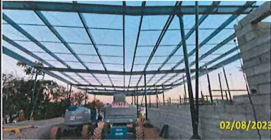
Foto 17 Montagem da estrutura metálica - Solda das nervuras
