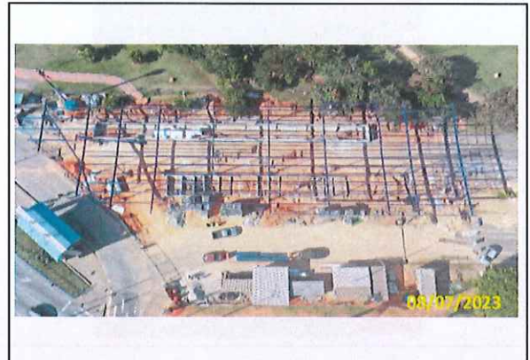
Foto 14 Registro do drone - Montagem da estrutura metálica
