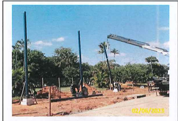
Foto 10 Início da instalação dos pilares da estrutura metálica
