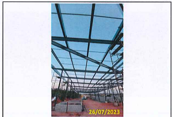
Foto 16 Montagem da cantoneira de apoio das telhas
