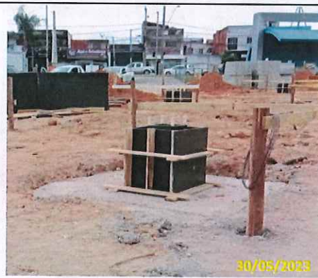
Foto 08 Montagem das fôrmas temporárias
