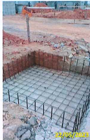
Foto 04 Armação da sapata
