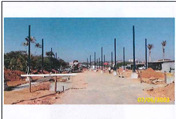
Foto 11 Continuação da instalação dos pilares da estrutura metálica
