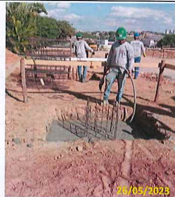
Foto 06 Concretagem da sapata
