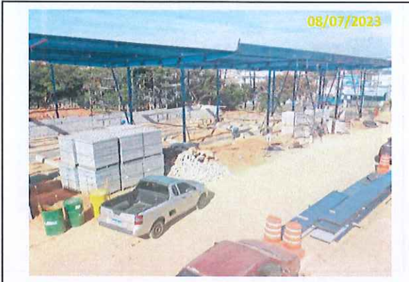
Foto 13 Registro do drone - Montagem da estrutura metálica
