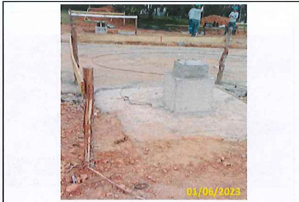
Foto 09 Concretagem da sapata do pilar
