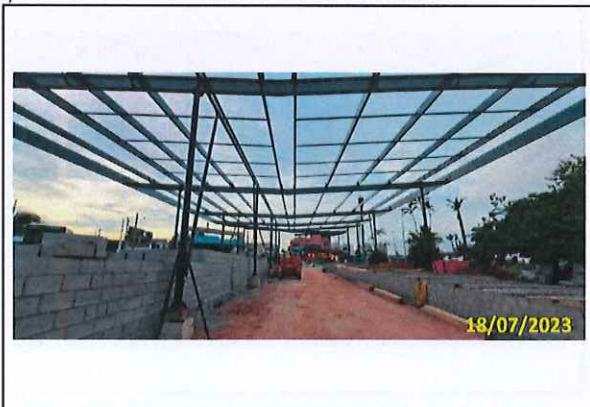
Foto 15 Montagem da estrutura metálica - Agulhas e travamentos
