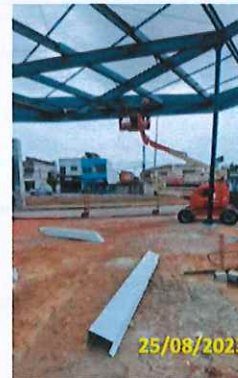
Foto 20 Instalação das calhas da cobertura
