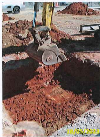
Foto 02 Abertura de vala da fundação
