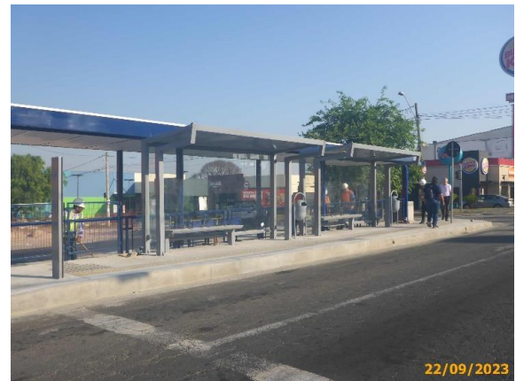
Foto 14 – Vista geral da parada, com os dois abrigos completos, conforme previsto no Anexo II de Edital.
