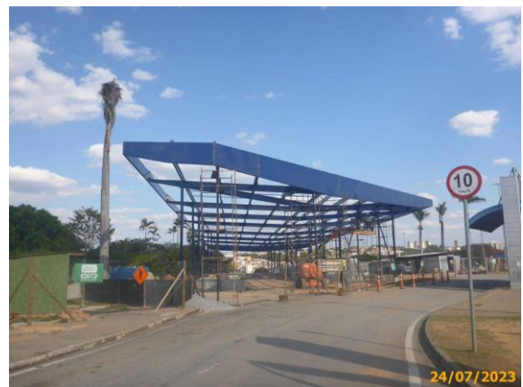
Foto 18 – Segue foto anterior. Em destaque, a testeira na cabeceira instalada.
