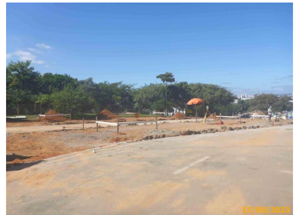
Foto 4 – Marcação locacional das fundações diretas.
