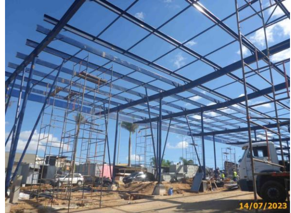
Foto 14 – Instalação das terças metálicas.
