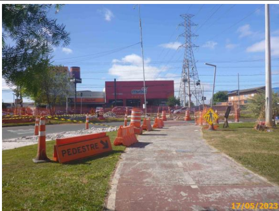
Foto 5 – Vista da sinalização provisória durante as obras da estação.
