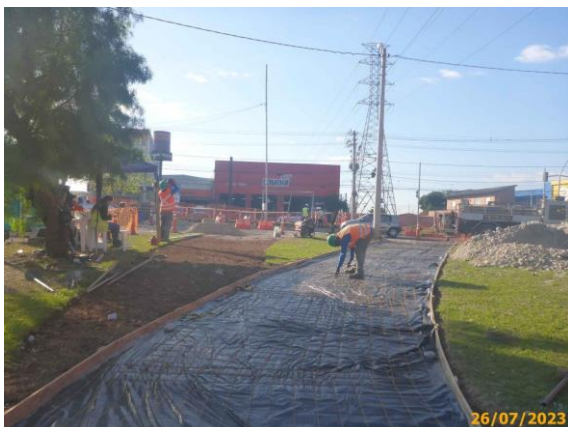
Foto 19 – Preparação do terreno para a concretagem do passeio.
