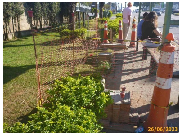
Foto 38 – Bases de apoio em concreto executados no PP.
