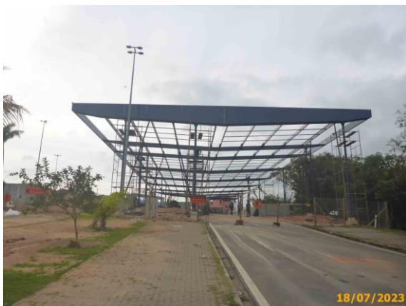
Foto 17 – Vista geral da estrutura metálica, em destaque, a testeira na cabeceira da cobertura.
