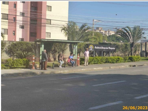
Foto 37 – Vista geral do PP antes da intervenção das obras.
