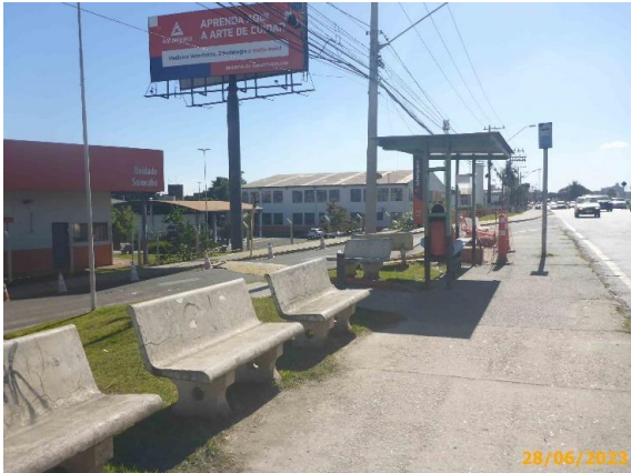
Foto 29 – Vista geral do PP antes da intervenção das obras.
