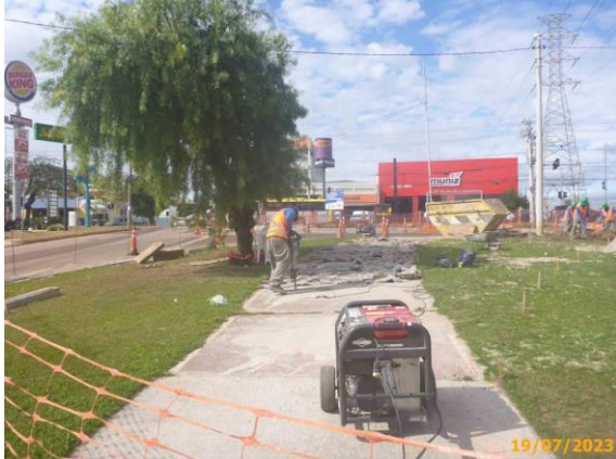
Foto 15 – Demolição do passeio defronte a estação.
