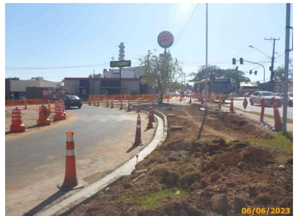
Foto 14 – Guias e sarjetas de concreto implantadas na estação.
