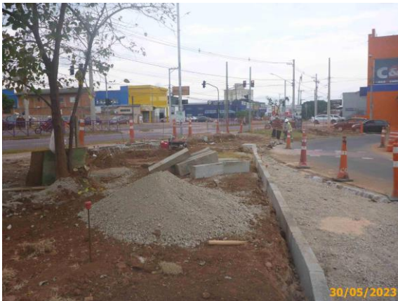
Foto 11 – Implantação das guias e sarjetas de concreto na estação.
