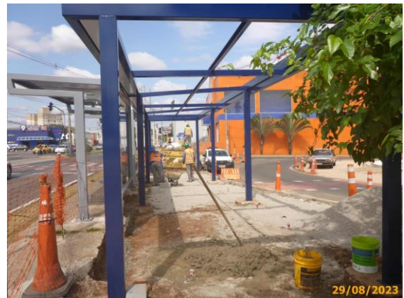
Foto 24 – Obras de execução do piso da estação.
