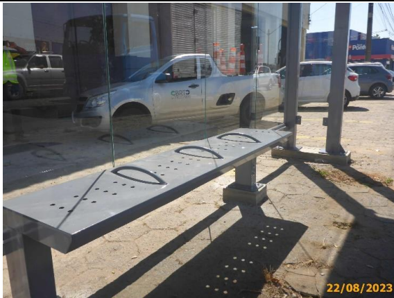
Foto 23 – Segue foto anterior. Banco instalado.
