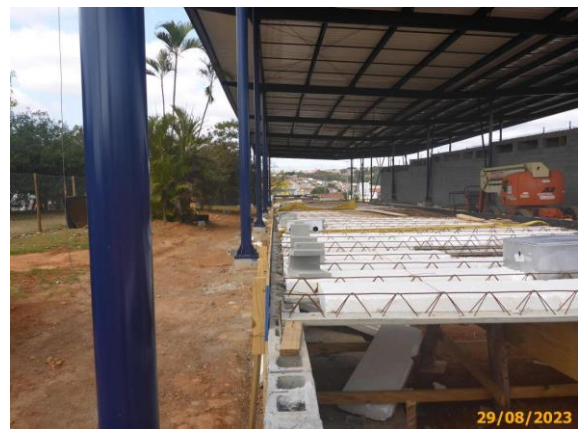
Foto 24 – Vista parcial dos apoios da cobertura metálica do Terminal.
