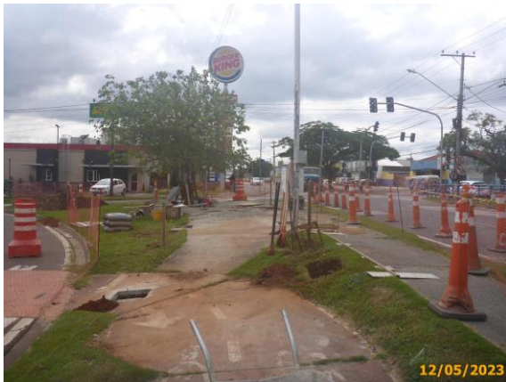
Foto 7 – Bases de apoio em concreto em execução no PP.
