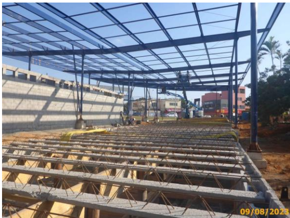
Foto 21 – Contraventamento em instalação.
