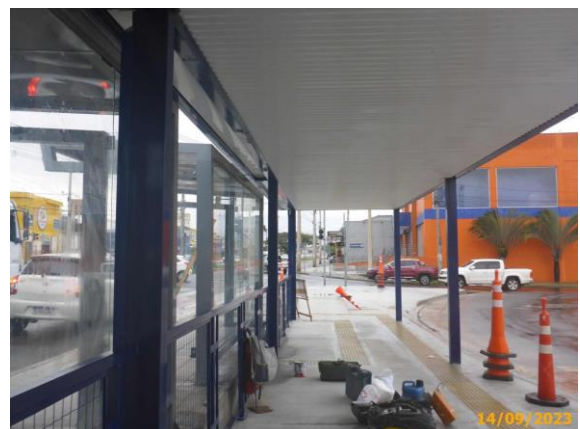
Foto 38 – Forro instalado no abrigo da Estação Santa Cruz.
