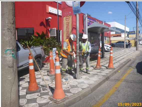
Foto 3 – Vista do Ponto de Parada durante a instalação do marco (totem).
