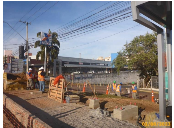
Foto 32 – Bases de apoio do segundo abrigo executadas no passeio do PP.
