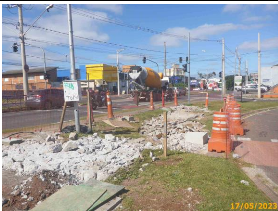
Foto 7 – Demolição da área de intervenção das obras na estação.
