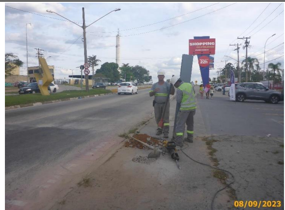
Foto 44 – Instalação do marco (totem).
