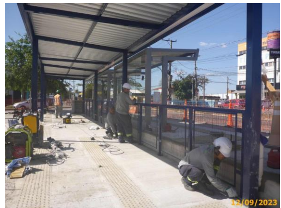
Foto 36 – Instalação do guarda corpo e gradil.
