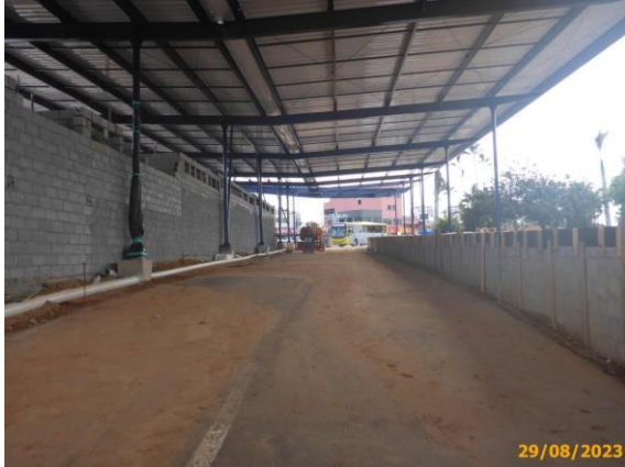
Foto 25 – Vista parcial da cobertura com as telhas instaladas.
