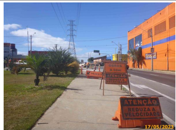
Foto 6 – Vista da sinalização provisória durante as obras junto a avenida Santa Cruz.
