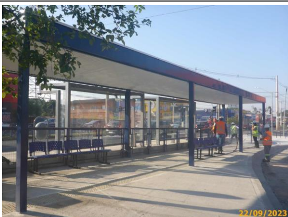
Foto 43 – Bancos em instalação na estação.
