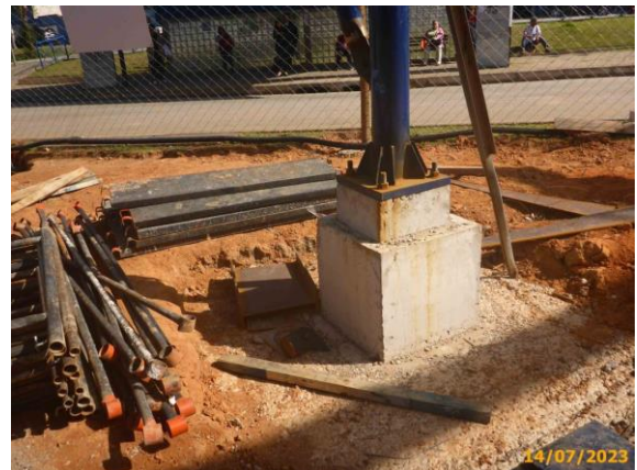
Foto 16 – Detalhe do apoio da estrutura metálica.
