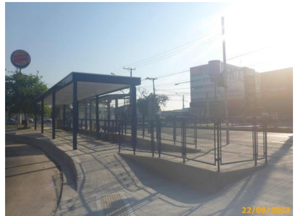
Foto 48 – Vista parcial da Estação Santa Cruz.
