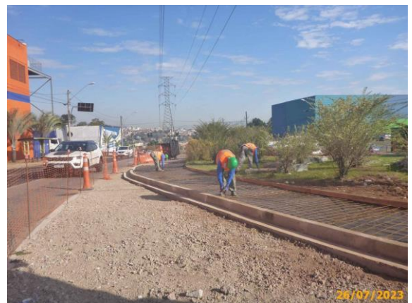
Foto 18 – Preparação do terreno para a concretagem do passeio.
