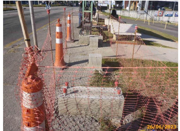
Foto 30 – Bases de apoio em concreto executadas no PP.
