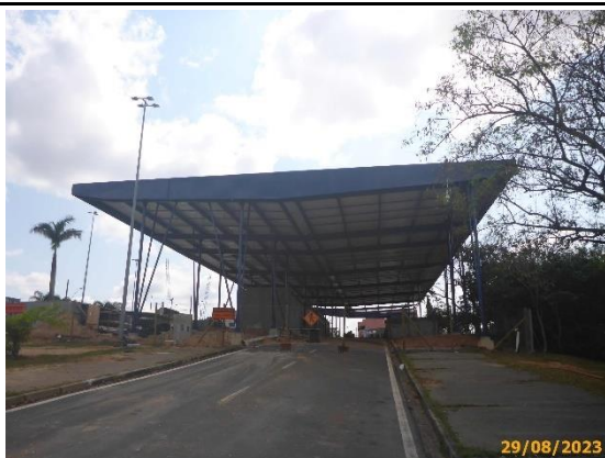
Foto 15 – Vista da Cobertura do Terminal Ipiranga.
