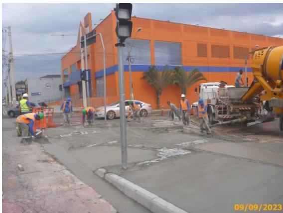
Foto 35 – Lançamento do concreto na estação.
