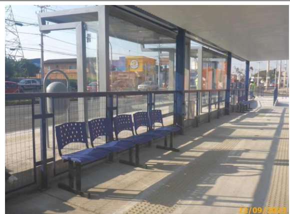
Foto 44 – Bancos instalados na estação.
