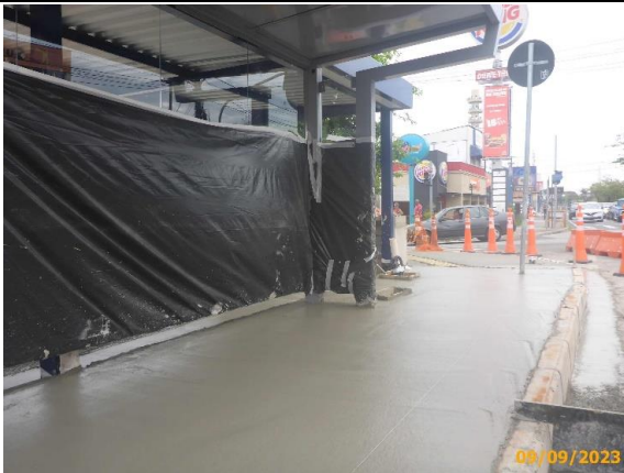
Foto 11 – Bancos removidos durante as obras do passeio.
