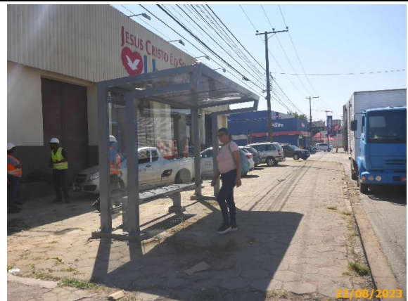
Foto 22 – Cobertura, banco e vidros de fechamento instalados no PP.
