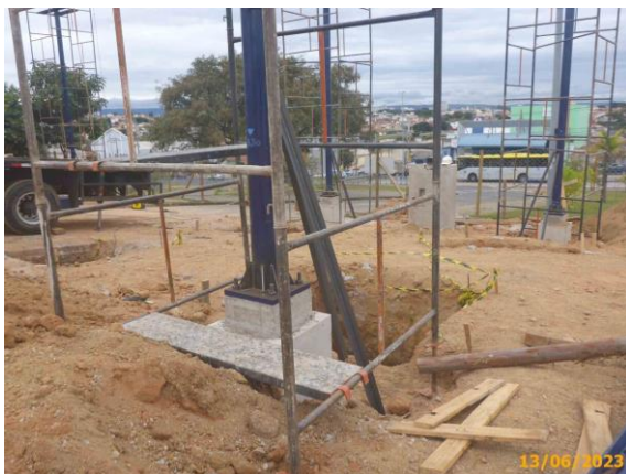
Foto 9 – Detalhe da sapata e da fixação da estrutura metálica.
