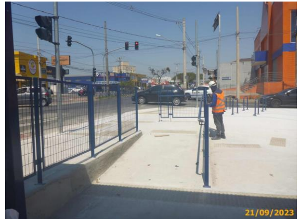
Foto 40 – Guarda corpo instalado na rampa de acesso na estação.
