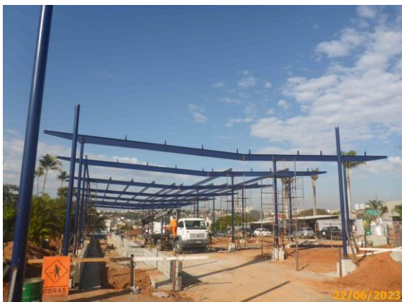
Foto 11 – Tesouras metálicas em instalação.
