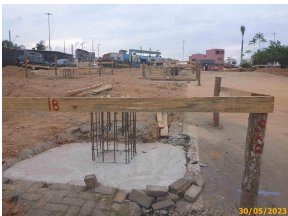
Foto 5 – Concretagem das fundações diretas foi realizada.
