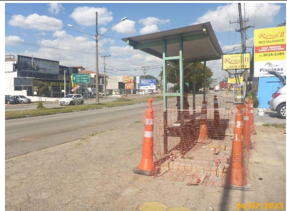
Foto 20 – Abrigo existente a ser removido, e, as bases de concreto implantadas.
