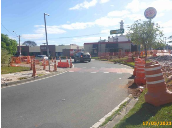
Foto 9 – Retorno existente mantido durante as obras.
