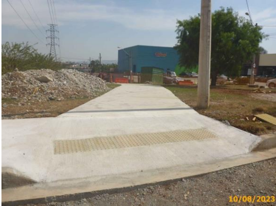
Foto 21 – Segue foto anterior. Detalhe da acessibilidade e sinalização tátil.
