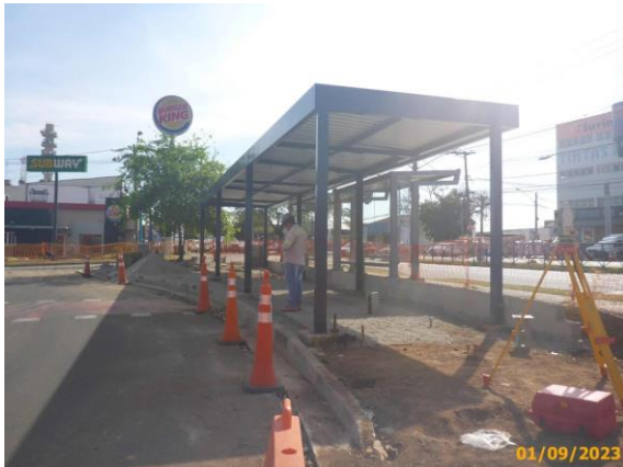
Foto 27 – Abrigo parcialmente implantado, e, a permanência das obras n.
