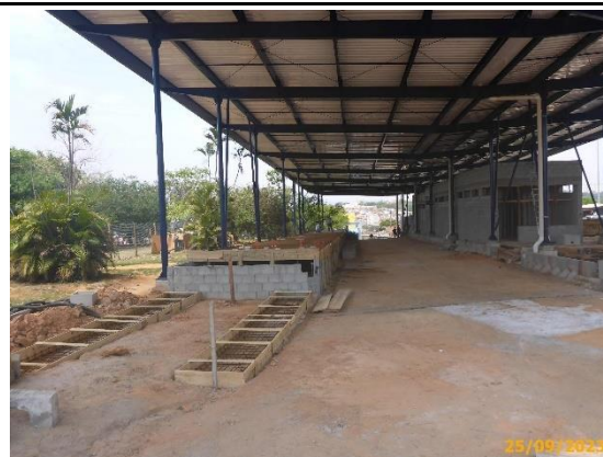
Foto 16 – Vista da Cobertura do Terminal Ipiranga.
