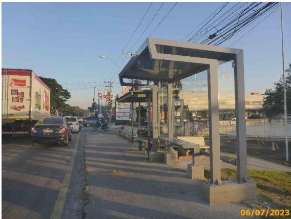
Foto 31 – Um abrigo parcialmente instalado.
