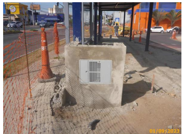
Foto 26 – Instalação da entrada de água fria na estação.
