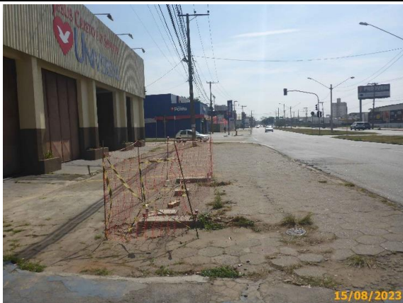
Foto 21 – Vista do PP com a remoção do abrigo, e em destaque, o isolamento das bases de apoio em concreto.
