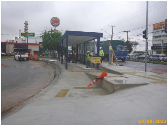
Foto 39 – Vista da Estação Santa Cruz em fase de instalação do mobiliário.
