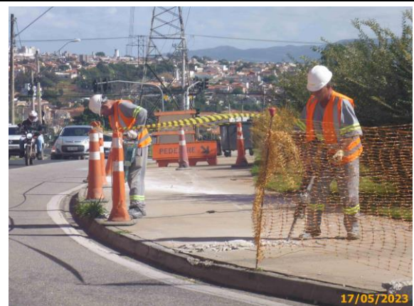
Foto 8 – Demolição da área de intervenção das obras no passeio junto da estação.
