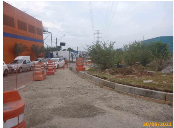
Foto 12 – Implantação das guias de concreto na estação.
