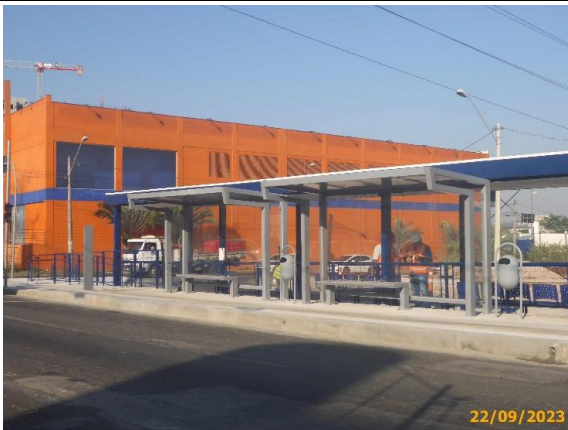
Foto 13 – Vista geral da parada, com os dois abrigos completos, conforme previsto no Anexo II de Edital.
