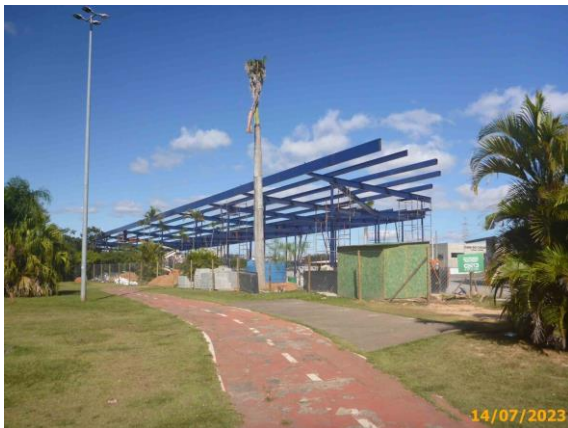
Foto 15 – Vista geral da estrutura metálica da cobertura.
