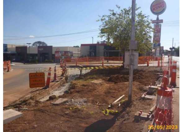
Foto 10 – Readequação do passeio para a implantação da estação.
