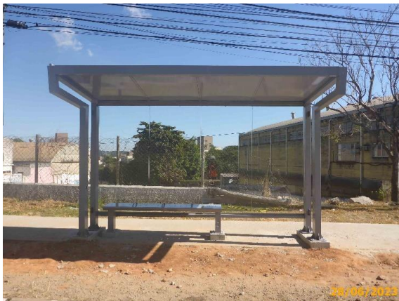
Foto 25 – Vista do mobiliário parcialmente instalado no PP.
