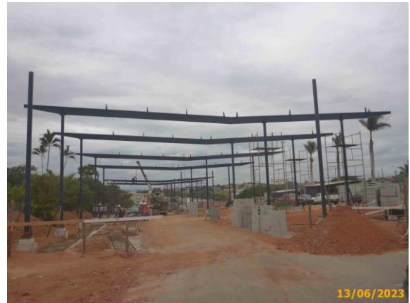
Foto 8 – Implantação da estrutura metálica da cobertura do Terminal Ipiranga em andamento.
