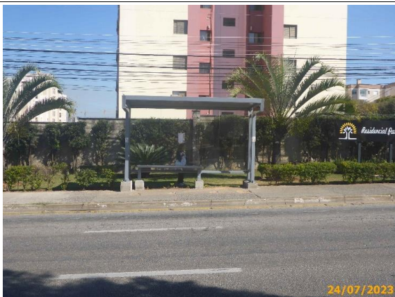
Foto 39 – Abrigo parcialmente instalado.
