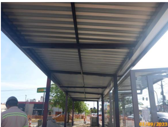
Foto 25 – Telhas instaladas no abrigo da estação..
