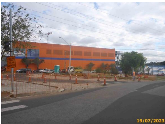
Foto 17 – Vista geral dos isolamentos das obras da estação.
