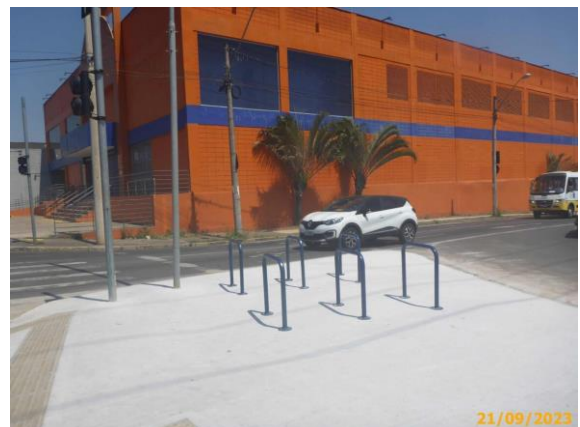
Foto 42 – Paraciclos instalados na estação.
