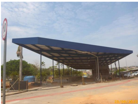
Foto 29 – Vista geral da cobertura concluída no Terminal Ipiranga.
