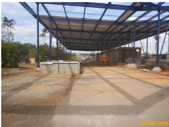
Foto 23 – Telhas sendo instaladas na cobertura.
