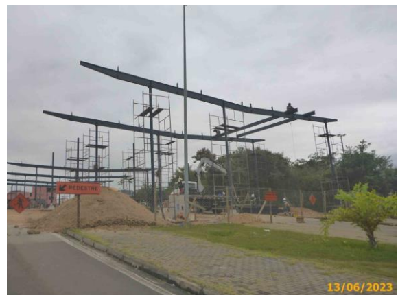
Foto 10 – Instalação das tesouras metálicas em perfil "I".
