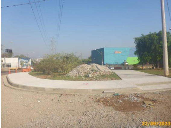
Foto 45 – Vista geral da parada, com os dois abrigos completos, conforme previsto no Anexo II de Edital.
