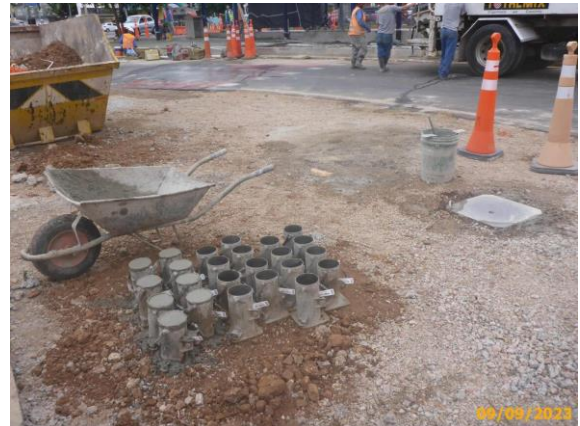
Foto 28 – Controle de qualidade do concreto aplicado no piso da estação.
