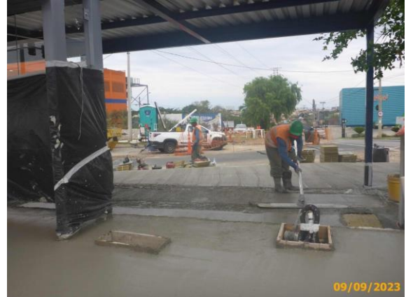
Foto 34 – Utilização do “float” para minimizar a formação de bolhas e homogeneização do piso em concreto.
