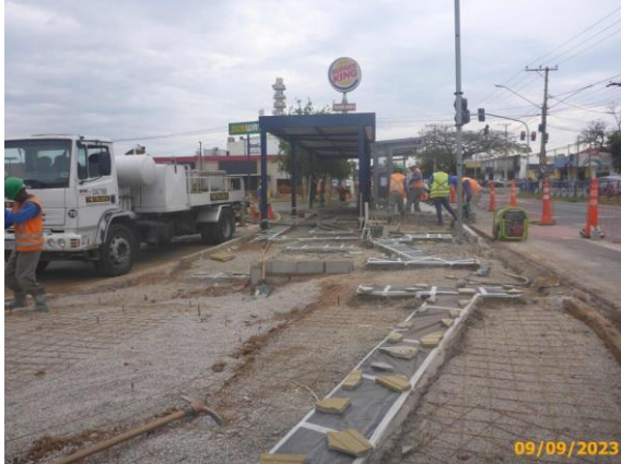
Foto 33 – Vista geral das obras no piso da estação.
