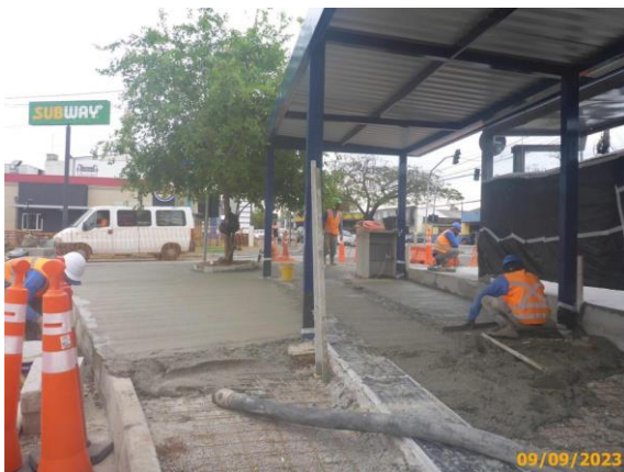
Foto 29 – Lançamento do concreto na estação.
