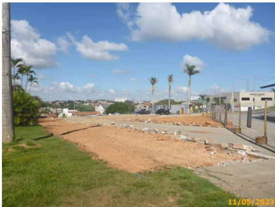
Foto 3 – Vista parcial da limpeza do terreno realizada no Terminal Ipiranga.
