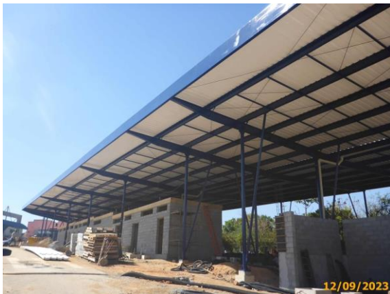
Foto 27 – Vista da cobertura concluída.
