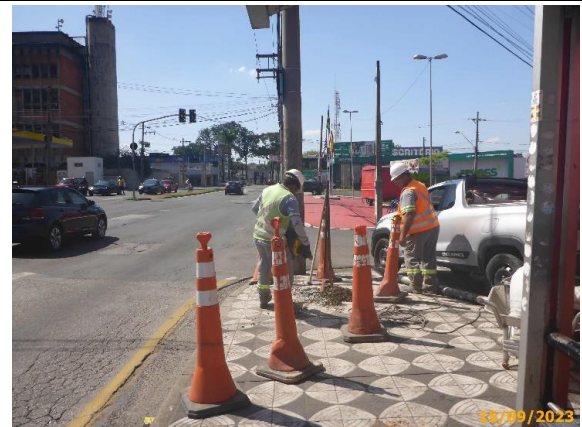
Foto 4 – Equipamento urbano (marco) instalado no ponto de parada.
