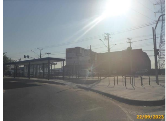
Foto 46 – Vista geral da Estação de Conexão, conforme previsto no Anexo II de Edital.
