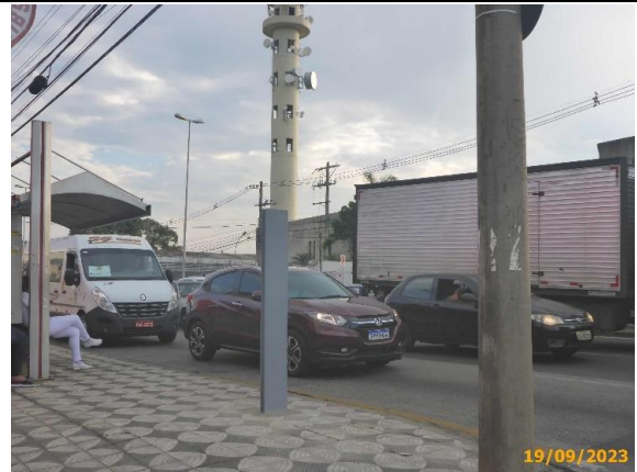
Foto 6 – Totem (marco) instalado.
