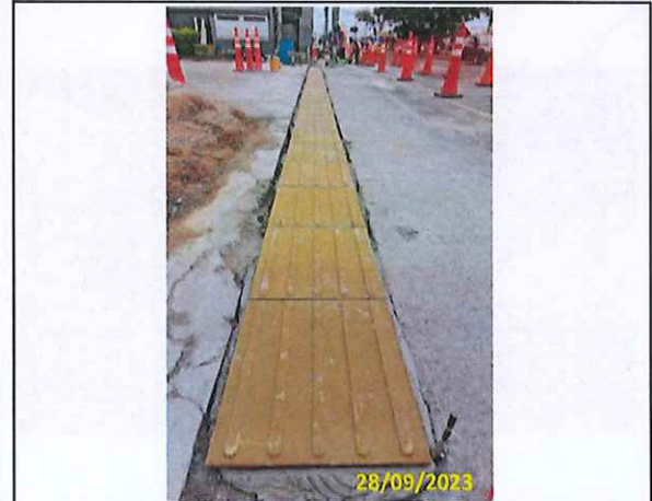
Foto 22 Assentamento de piso podotátil
