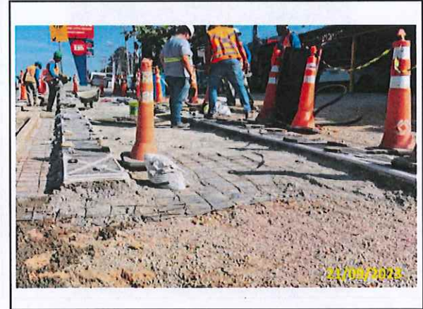
Foto 89 Preparo para concretagem
