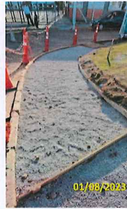
Foto 56 Aplicação de lastro no 1º trecho do passeio
