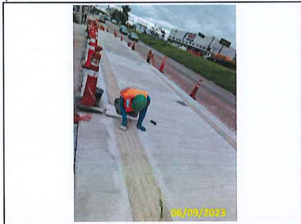
Foto 52 Limpeza do piso podotátil
