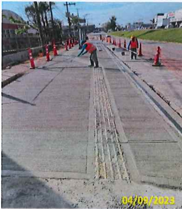
Foto 48 Acabamento do passeio executado
