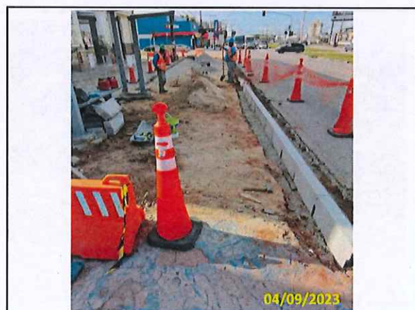
Foto 31 Assentamento de guias
