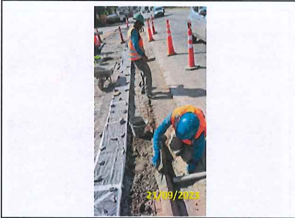
Foto 90 Rebaixamento de guia para entrada de veículos
