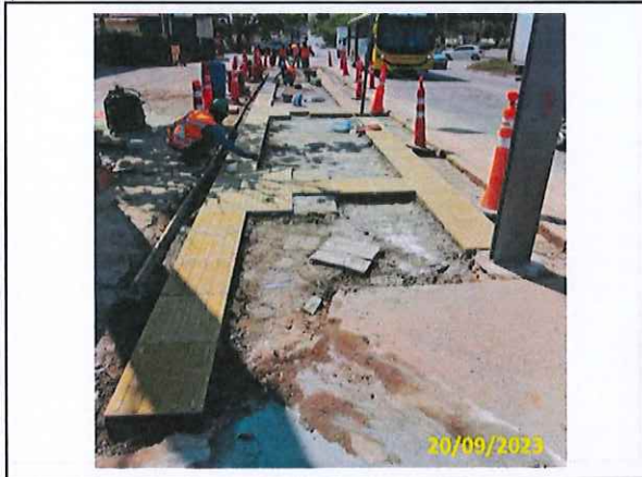
Foto 88 Assentamento de piso podotátil
