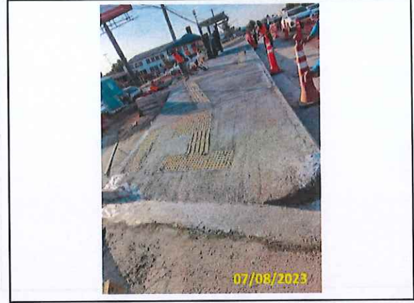
Foto 66 Acabamento do passeio em andamento
