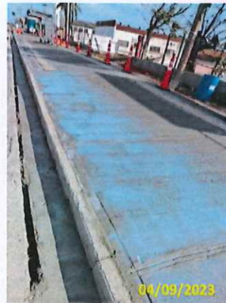
Foto 49 Aplicação de cura química
