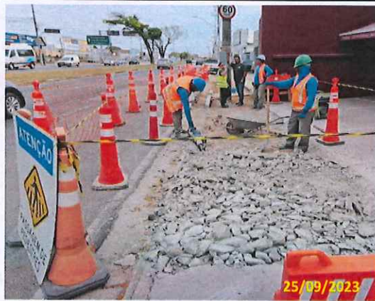
Foto 19 Continuação da demolição do passeio existente
