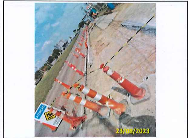
Foto 41 Assentamento de guias
