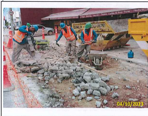
Foto 23 Demolição da 2ª parte do passeio existente
