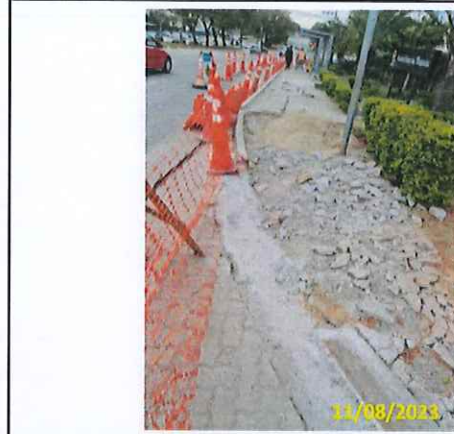
Foto 76 Demolição do 2º trecho do passeio existente
