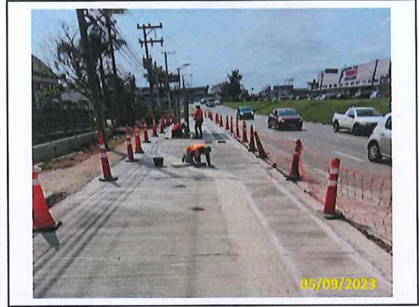
Foto 51 Rejunte do piso podotátil
