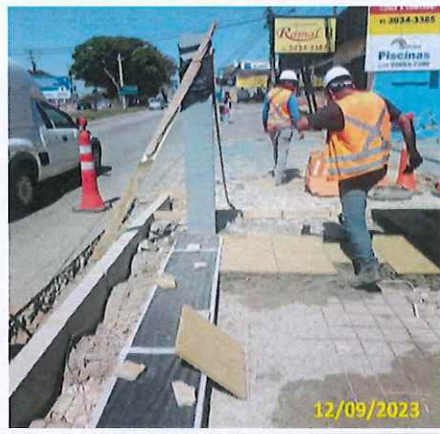
Foto 33 Assentamento de piso podotátil
