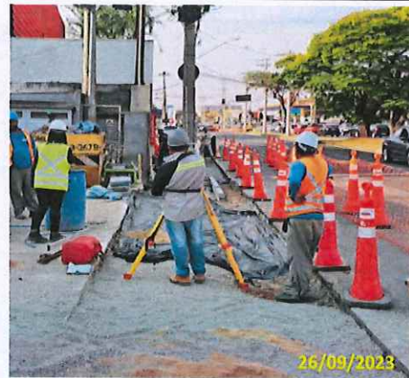
Foto 20 Aplicação de lastro e lona
