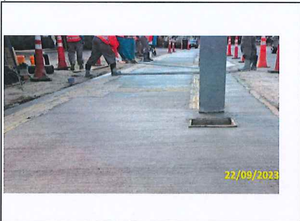
Foto 92 Acabamento do passeio em andamento
