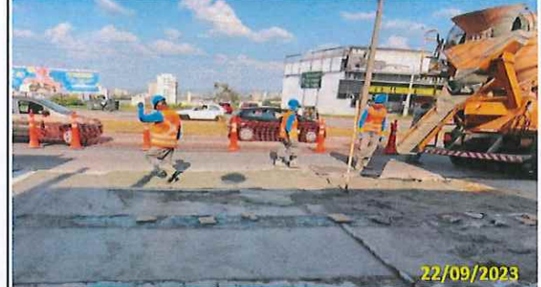
Foto 37 Concretagem em andamento da 2ª etapa do passeio
