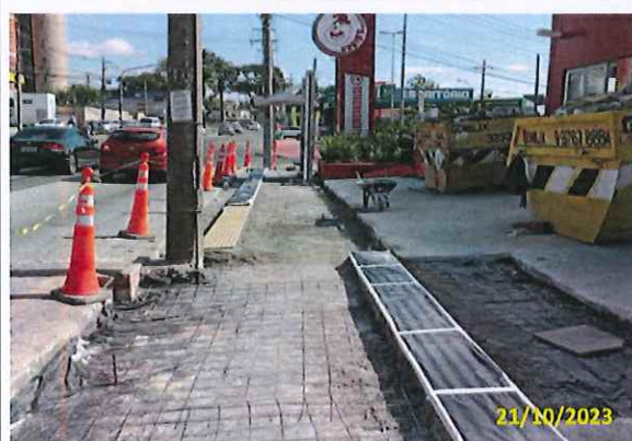
Foto 96 Preparo para concretagem
