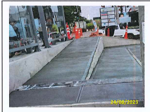
Foto 72 Rampa de acessibilidade concretada
