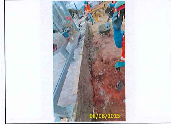
Foto 68 Escavação do trecho da rampa e reboco da mureta
