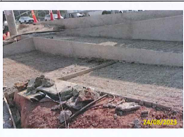
Foto 71 Preparo para concretagem da rampa de acessibilidade
