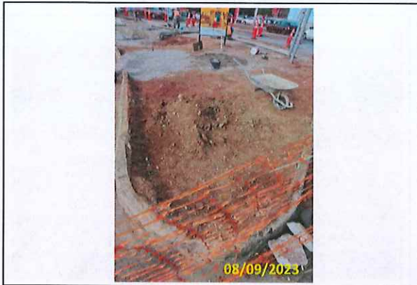
Foto 09 Limpeza do trecho faltante
