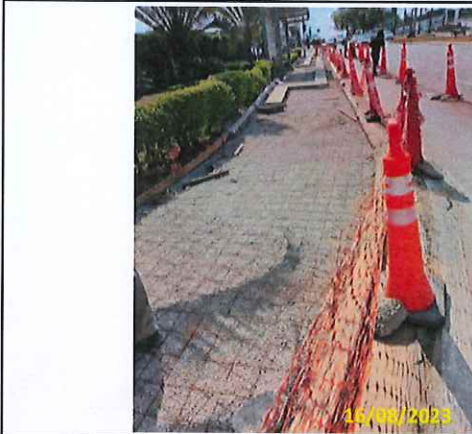
Foto 77 Aplicação de lastro e tela metálica
