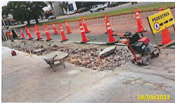
Foto 17 Início da demolição do passeio existente
