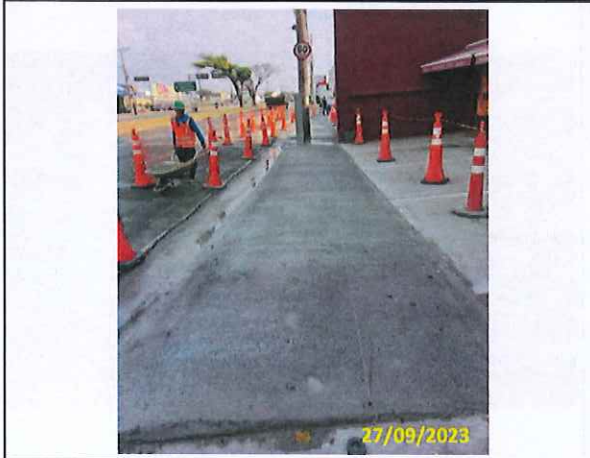
Foto 21 Concretagem do passeio
