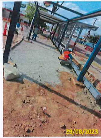
Foto 02 Aplicação de lastro (Área do abrigo de conexão)
