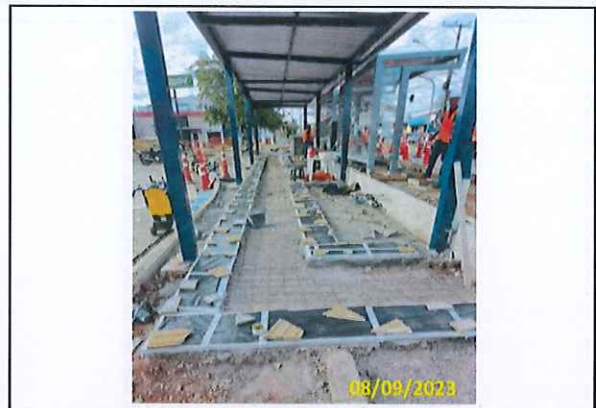
Foto 10 Preparo para concretagem
