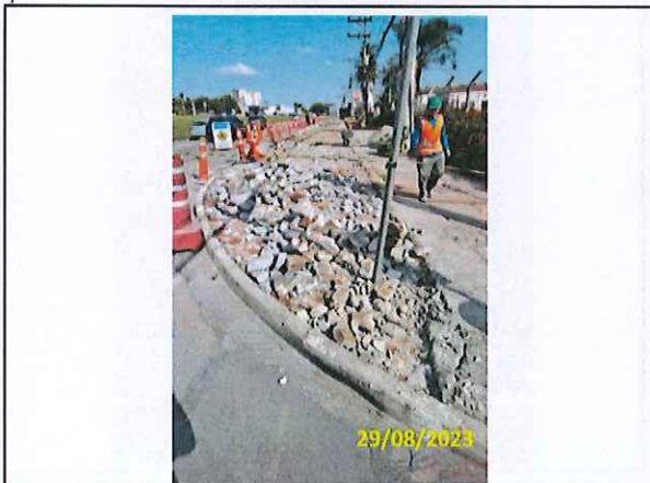
Foto 44 Demolição da 2ª etapa do passeio existente
