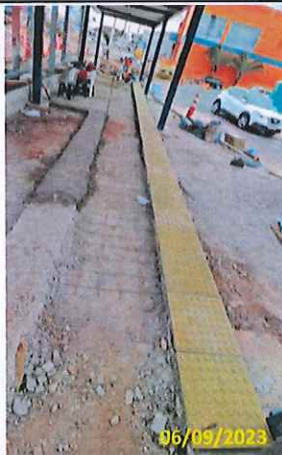
Foto 03 Assentamento de piso podotátil (Área do abrigo de conexão)
