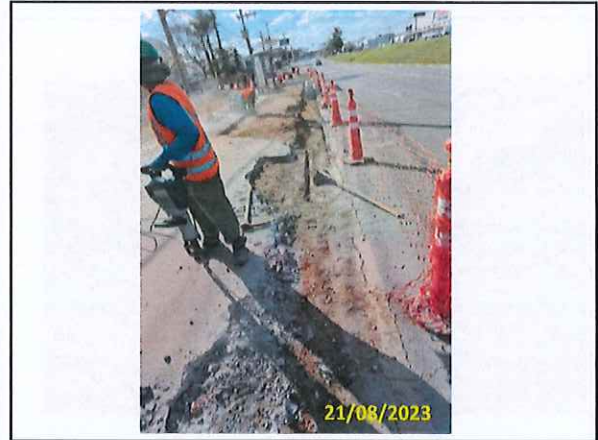
Foto 39 Continuação da demolição do passeio
