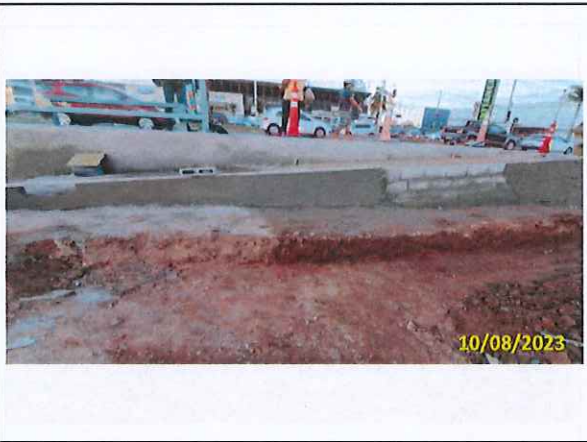
Foto 69 Reboco da rampa de acessibilidade em andamento
