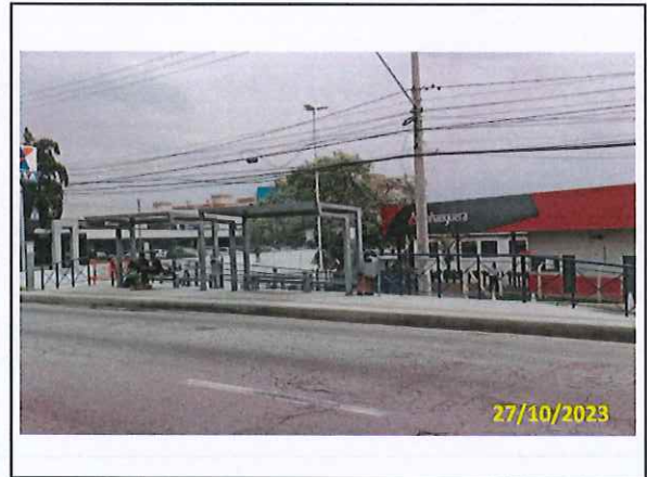
Foto 74 Vista do passeio executado
