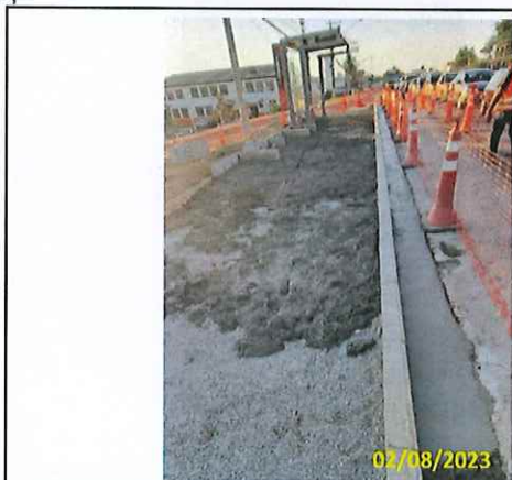
Foto 59 Concretagem da sarjeta
