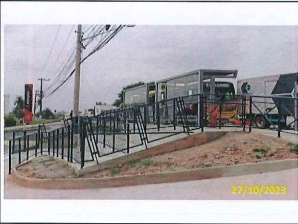
Foto 73 Instalação de gradil
