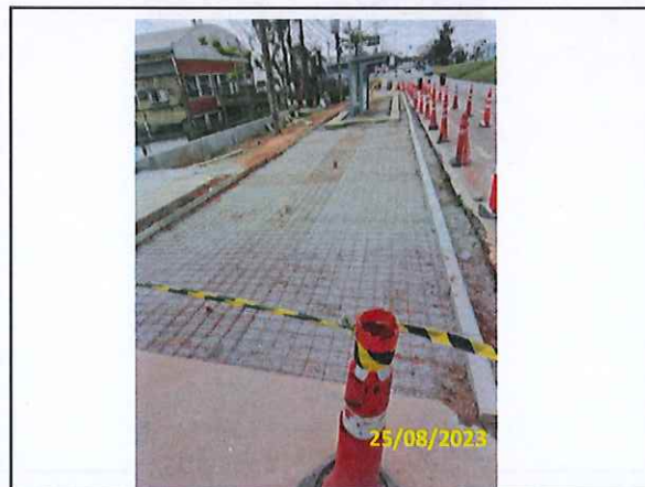
Foto 43 Aplicação de lastro e tela metálica
