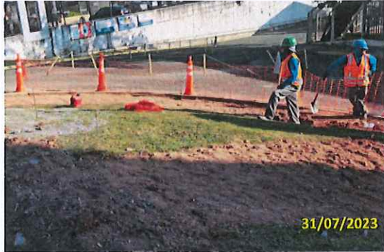
Foto 53 Demolição e limpeza em andamento
