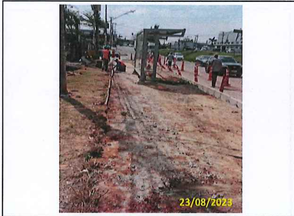
Foto 40 Montagem das formas temporárias
