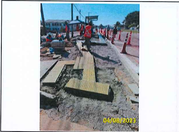
Foto 63 Assentamento de piso podotátil
