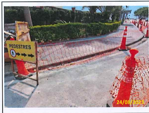
Foto 80 Concretagem do passeio finalizada
