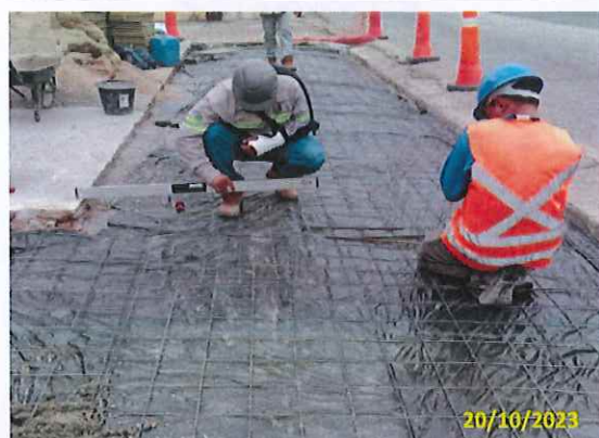
Foto 95 Conferência e marcação para nivelamento do passeio
