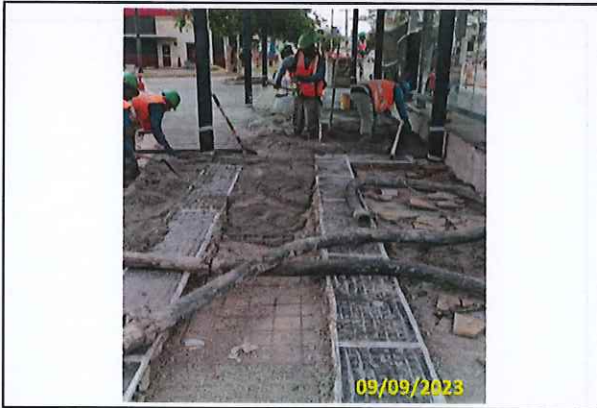
Foto 11 Concretagem do passeio em andamento
