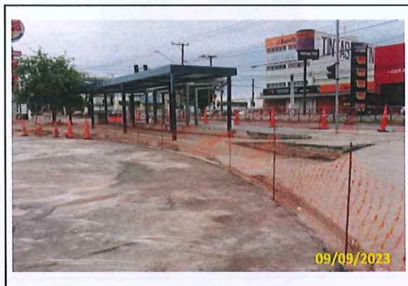
Foto 14 Passeio concretado
