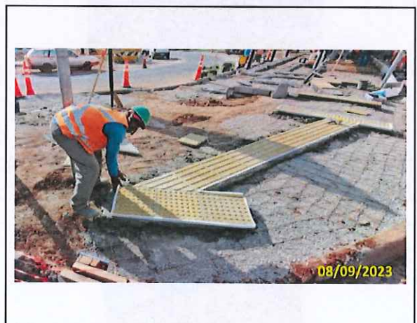
Foto 08 Continuação do assentamento de piso podotátil
