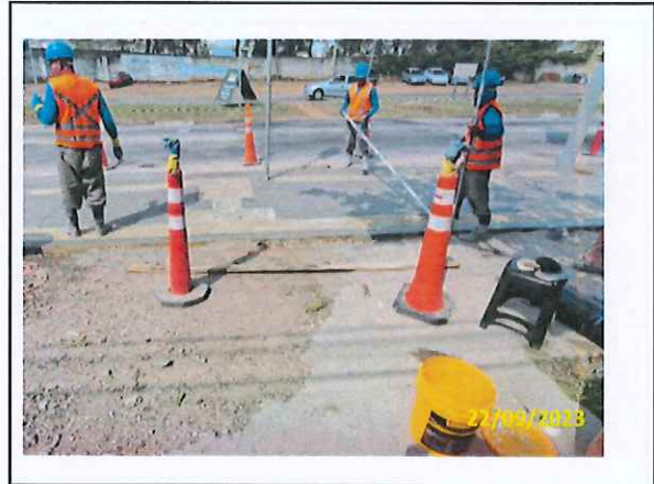
Foto 91 Concretagem do passeio
