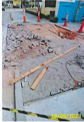
Foto 35 Demolição e limpeza da 2ª etapa do passeio existente
