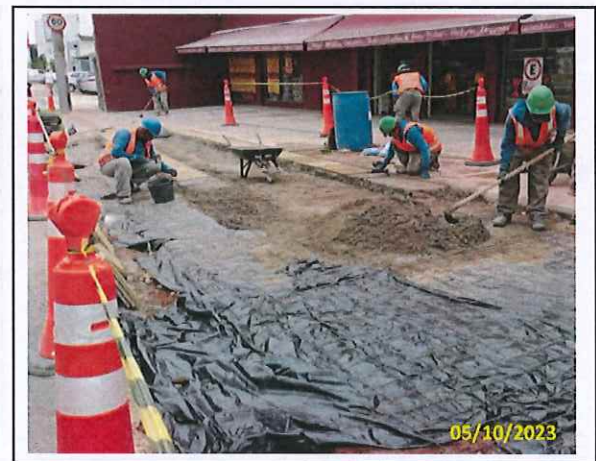
Foto 24 Assentamento de piso podotátil e aplicação de tela e lona
