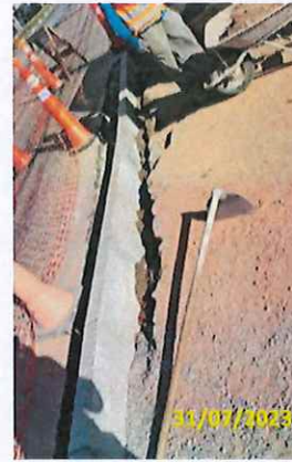
Foto 54 Assentamento de guias
