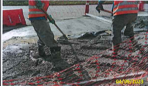
Foto 47 Concretagem do passeio em andamento
