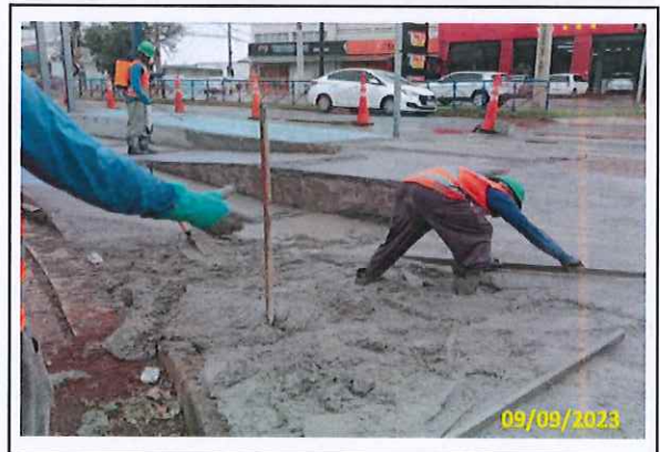
Foto 12 Concretagem do passeio em andamento
