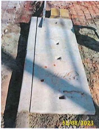
Foto 46 Troca de guia e tampa da boca de lobo
