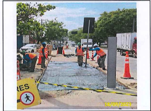
Foto 87 Aplicação de lona e tela metálica - 2º trecho do passeio
