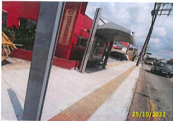
Foto 97 Passeio concretado
