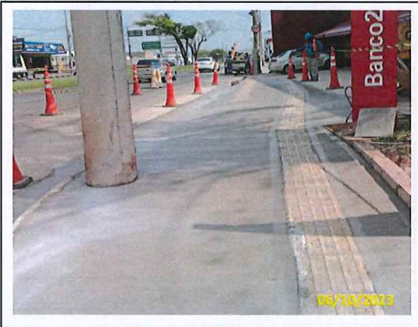
Foto 27 Concretagem do passeio concluída
