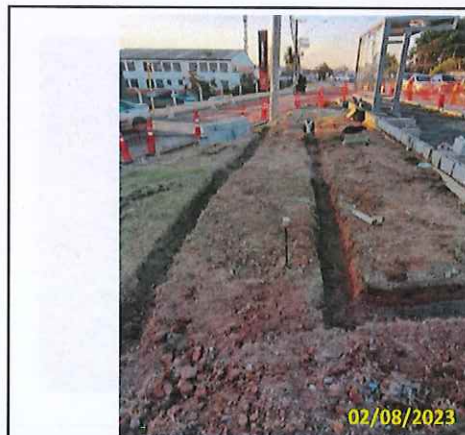
Foto 58 Escavação - Parte de trás do abrigo
