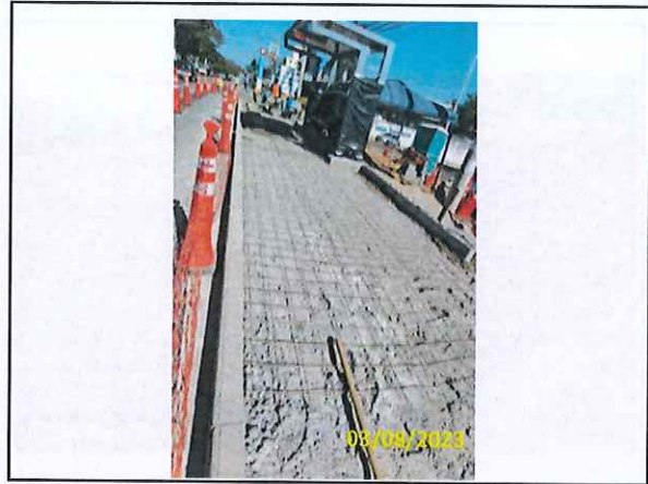
Foto 62 Aplicação de tela metálica
