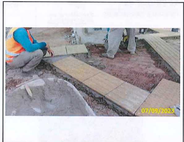
Foto 06 Assentamento de piso podotátil (Lado direito)
