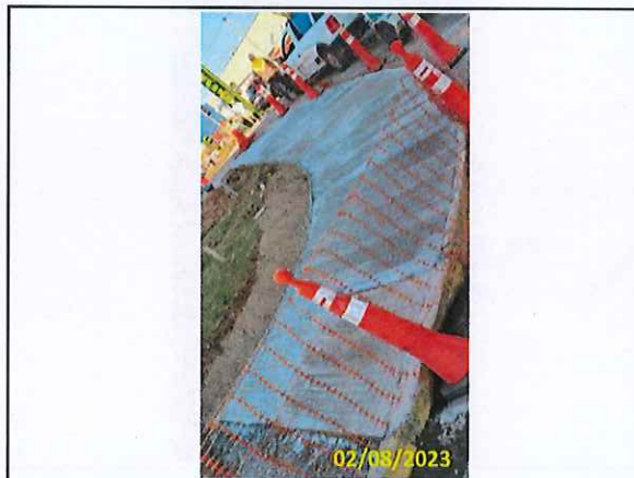
Foto 60 1º Trecho do passeio concretado
