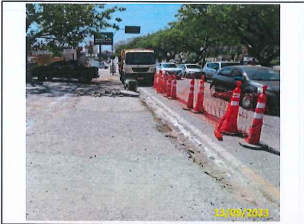
Foto 82 Início da demolição do 1º trecho do passeio existente
