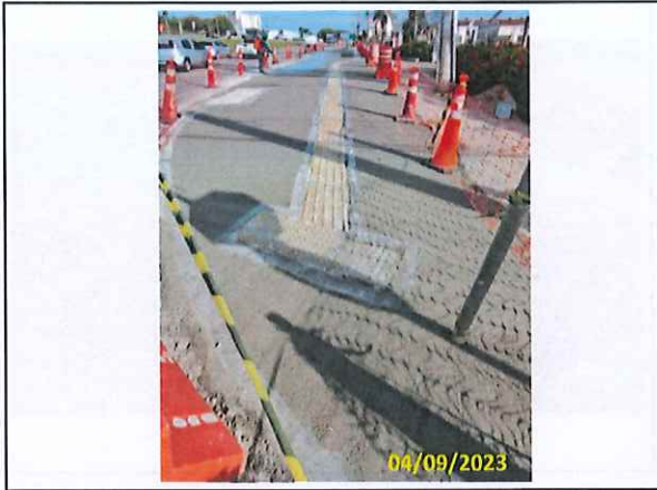
Foto 50 Passeio concretado
