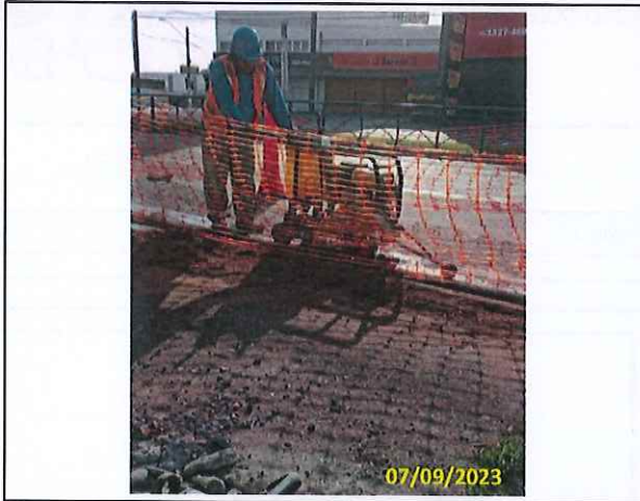
Foto 05 Corte e demolição da sarjeta existente
