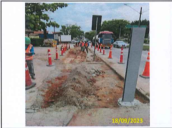
Foto 86 Demolição do 2º trecho do passeio
