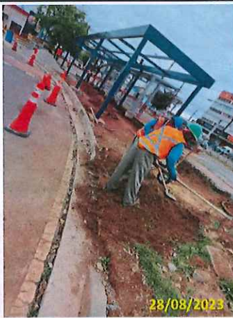
Foto 01 Demolição e limpeza
