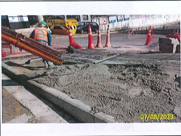
Foto 65 Concretagem do 3º trecho do passeio em andamento
