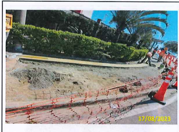
Foto 78 Assentamento de piso podotátil
