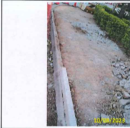
Foto 75 Demolição do passeio existente
