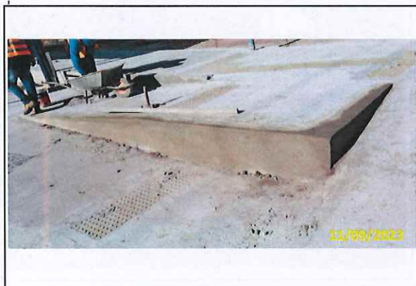
Foto 15 Acabamento da rampa de acessibilidade
