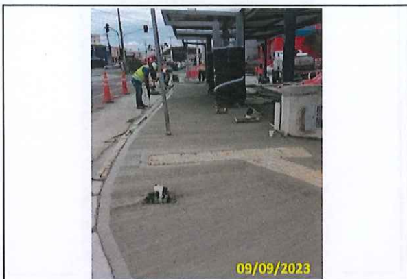
Foto 13 Acabamento do passeio executado
