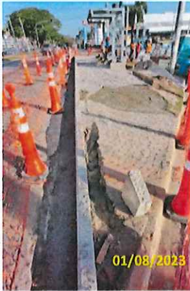
Foto 55 Aplicação de lastro
