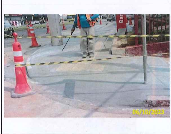
Foto 26 Aplicação de cura química
