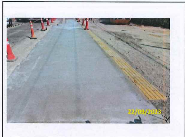
Foto 93 Passeio concretado
