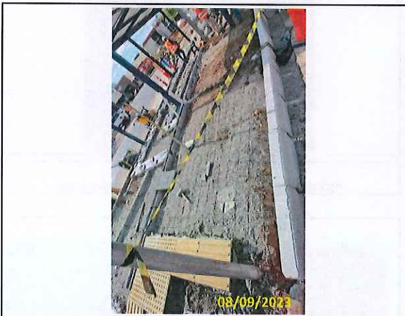
Foto 07 Assentamento de guias e aplicação de lastro e tela
