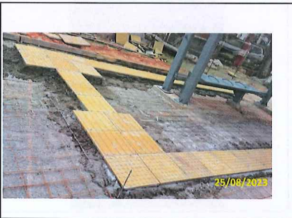
Foto 42 Assentamento de piso podotátil
