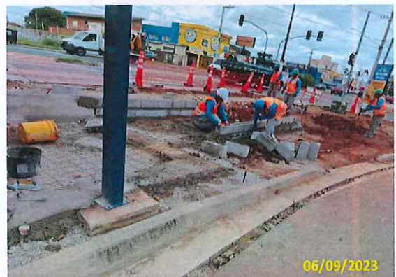
Foto 04 Execução da mureta ref. a rampa de acessibilidade
