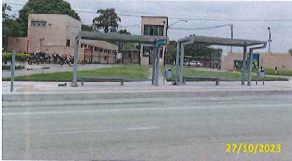
Foto 05 Vista do conjunto instalado
