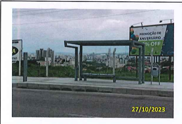
Foto 19 Vista do conjunto instalado
