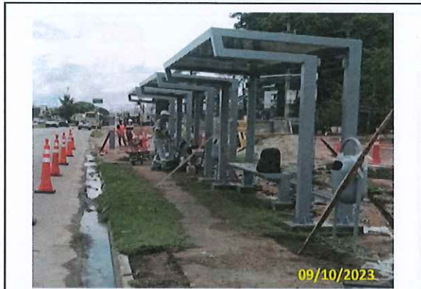
Foto 15 Ancoragem das lixeiras instaladas
