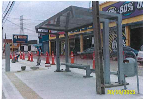
Foto 27 Vista do conjunto instalado
