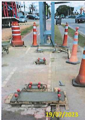
Foto 12 Instalação dos chumbadores do 2º abrigo
