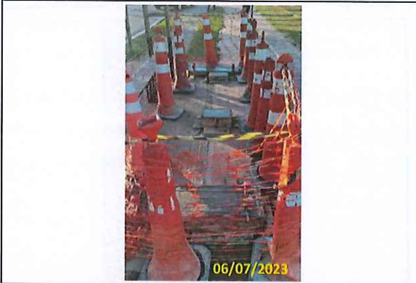
Foto 06 Instalação dos chumbadores do abrigo
