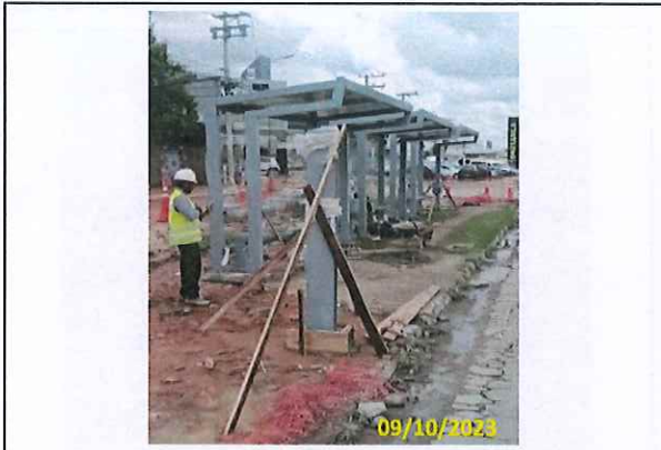
Foto 14 Ancoragem do totem instalado
