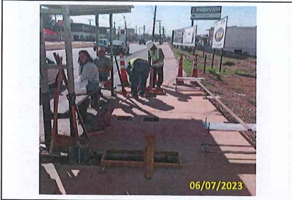
Foto 17 Instalação dos chumbadores do abrigo
