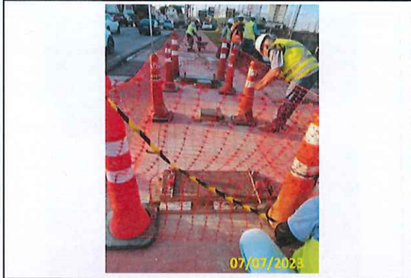
Foto 20 Instalação de chumbadores do abrigo
