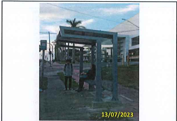
Foto 07 Vista do abrigo instalado
