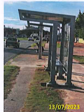
Foto 11 Instalação do 1º abrigo
