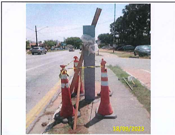
Foto 03 Ancoragem do totem instalado
