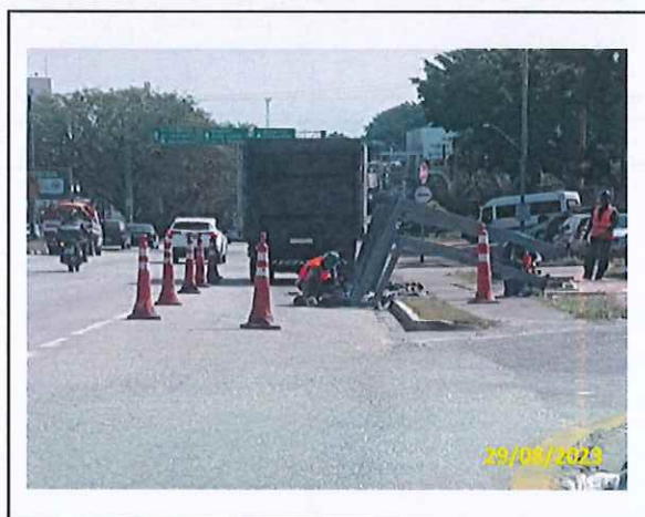
Foto 02 Instalação do abrigo em andamento
