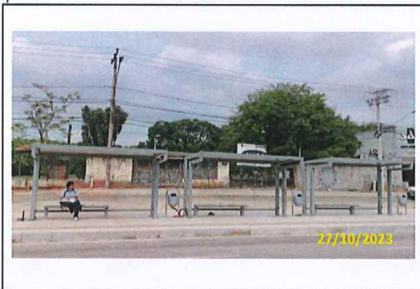
Foto 16 Vista do conjunto instalado
