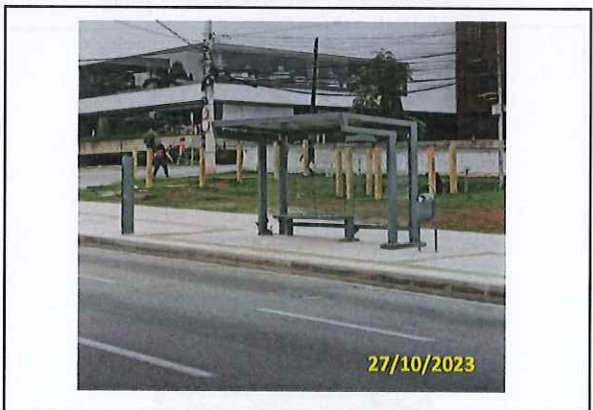
Foto 09 Vista do conjunto instalado
