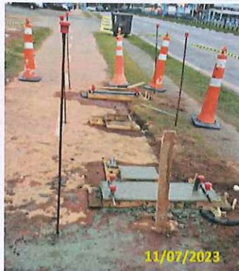
Foto 10 Instalação dos chumbadores do 1º abrigo
