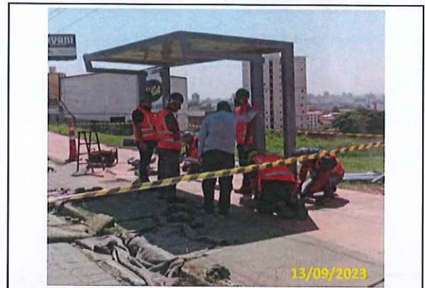
Foto 18 Instalação do abrigo
