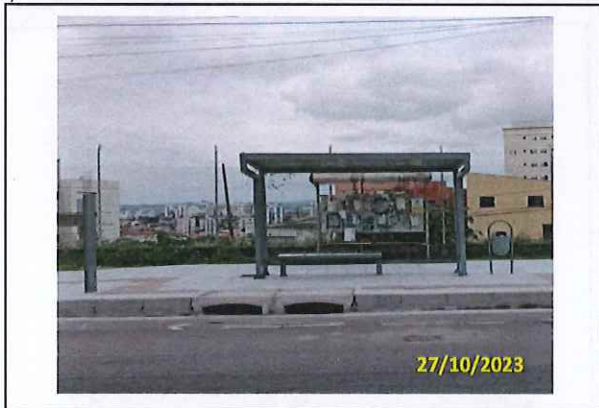
Foto 22 Vista do conjunto instalado
