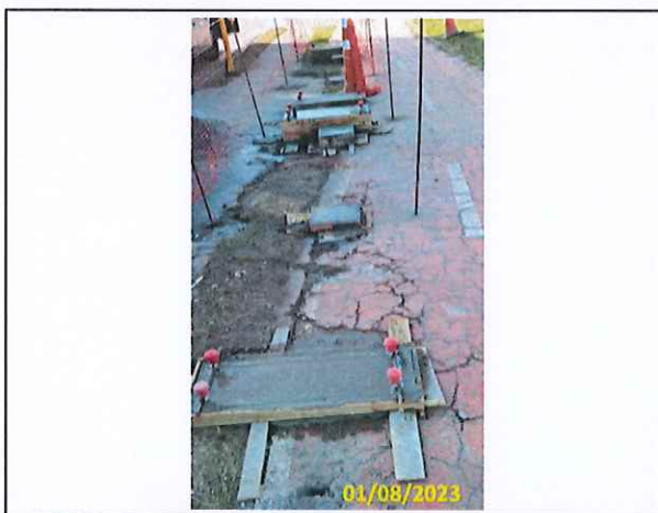
Foto 01 Instalação dos chumbadores do abrigo
