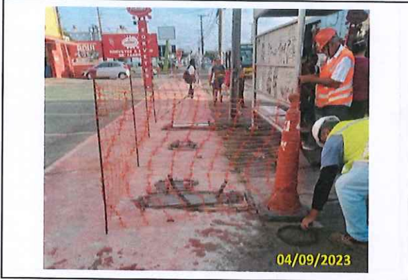
Foto 23 Instalação dos chumbadores do abrigo
