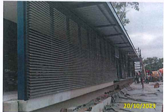
Foto 46 Instalação de suporte do forro externo
