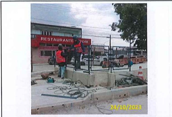
Foto 49 Instalação de gradil na rampa de acesso à estação
