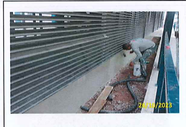
Foto 52 Pintura da estrutura de concreto da estação
