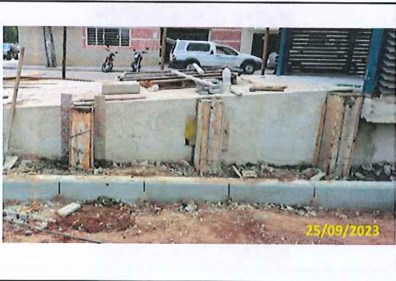
Foto 31 Execução dos pilares de suporte do guarda corpo
