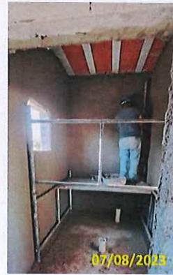
Foto 63 Início do reboco interno da casa dos motoristas
