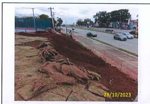
Foto 101 Limpeza do talude e plantio de grama
