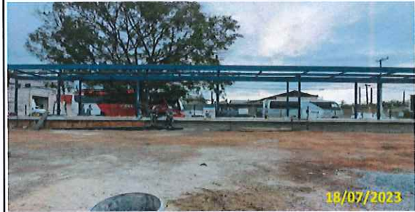
Foto 12 Alinhamento das testeiras
