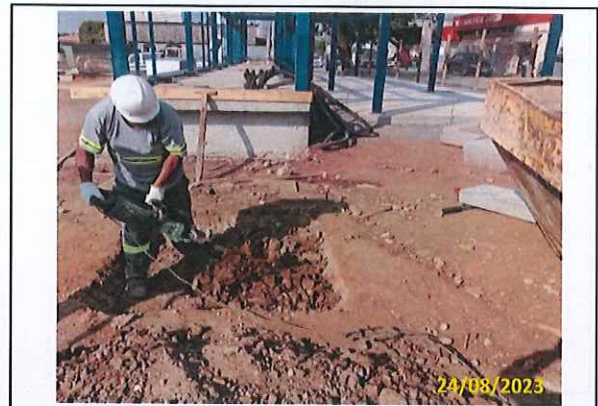
Foto 115 Escavação para instalação do poste Lottawan próx. ao abrigo
