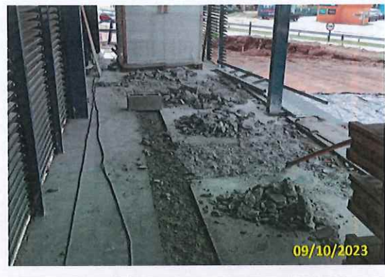
Foto 34 Demolição para assentamento de piso podotátil
