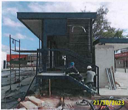
Foto 47 Finalização da instalação dos brises
