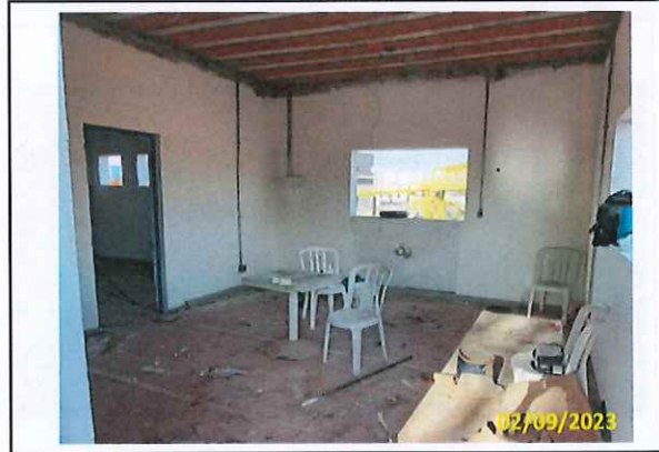
Foto 73 Início das instalações elétricas
