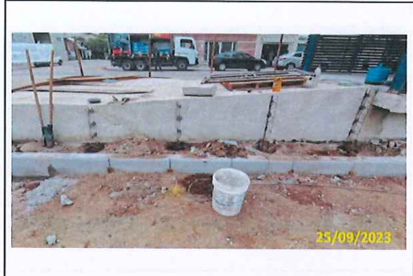
Foto 30 Escavação para os pilares de suporte do guarda corpo
