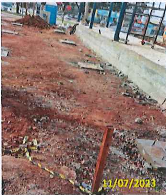
Foto 102 Instalação dos chumbadores do abrigo de conexão
