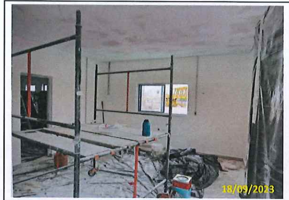
Foto 85 Aplicação de gesso na parte interna da casa dos motoristas
