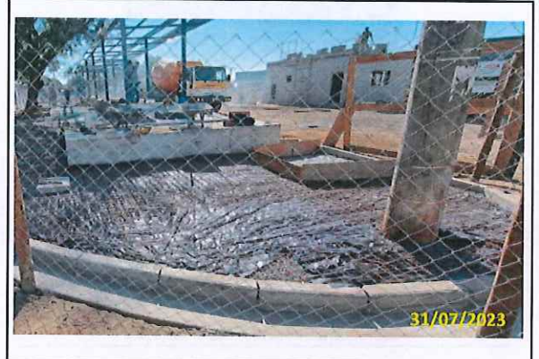
Foto 109 Preparo para concretagem
