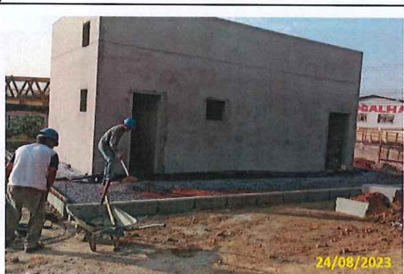
Foto 70 Preparo para concretagem do passeio
