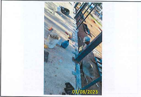
Foto 13 Continuação da instalação metálica da estação
