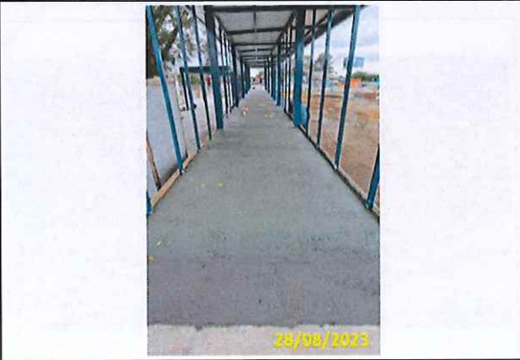
Foto 19 2ª etapa da concretagem da laje finalizada
