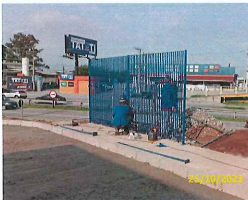
Foto 96 Instalação de gradil para cercamento da área de transferência
