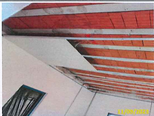
Foto 80 Início da instalação do forro de gesso na sala dos motoristas
