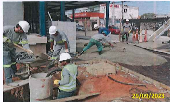
Foto 121 Concretagem do passeio ao lado do abrigo e concretagem p/ poste Lottawan
