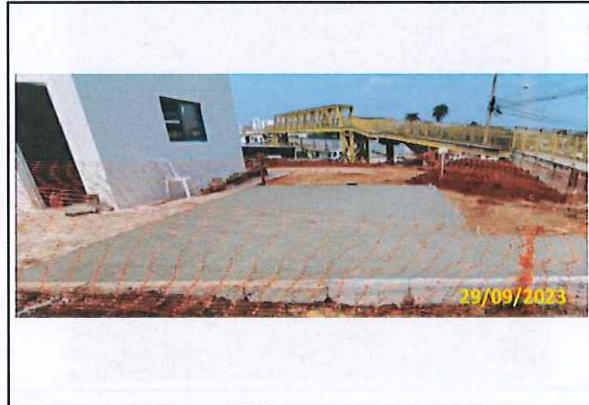
Foto 91 Concretagem do bicicletário
