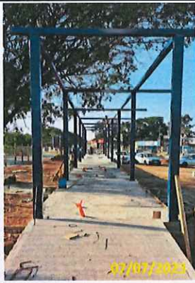
Foto 11 Instalação de pilares e terças em andamento
