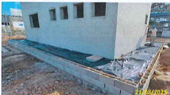
Foto 68 Aplicação de lastro e lona no passeio
