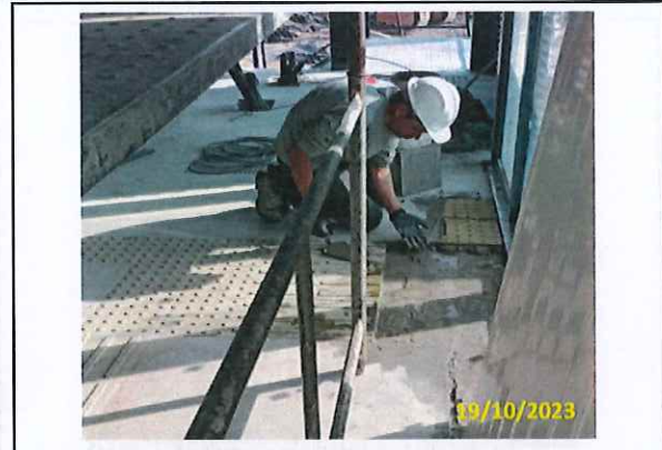
Foto 44 Assentamento de piso podotátil na estação
