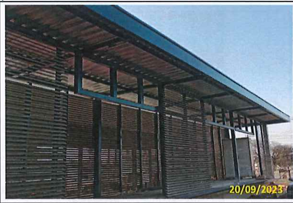
Foto 27 Instalação de pingadeiras e rufos na cobertura da estação
