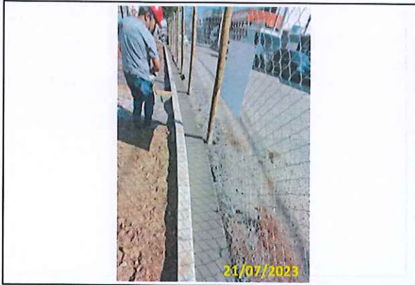
Foto 106 Sarjeta realizada em frente ao abrigo de conexão
