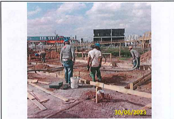
Foto 56 Montagem de fôrmas temporárias
