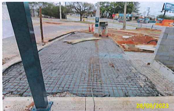
Foto 120 Aplicação de lastro, lona e tela no passeio ao lado do abrigo
