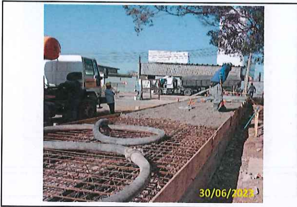
Foto 07 Concretagem da laje da estação em andamento
