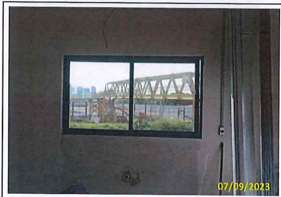
Foto 77 Instalação de vidro na janela
