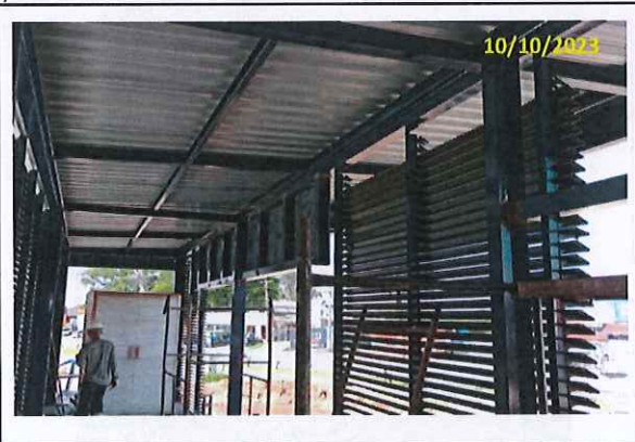
Foto 35 Instalação das chapas de fechamento do batente das portas
