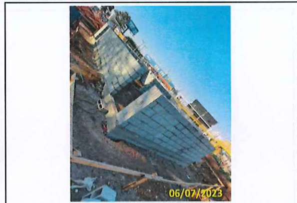
Foto 59 Alvenaria da casa dos motoristas em andamento
