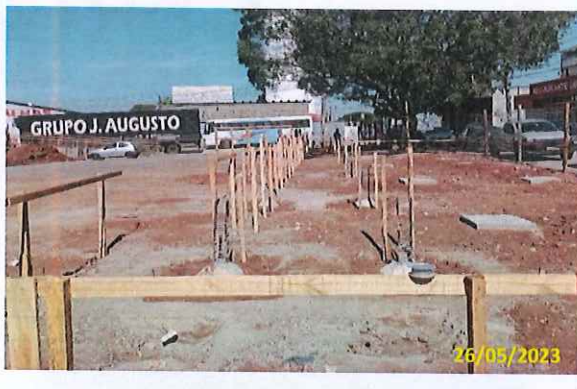
Foto 05 Sapata concretada e armada
