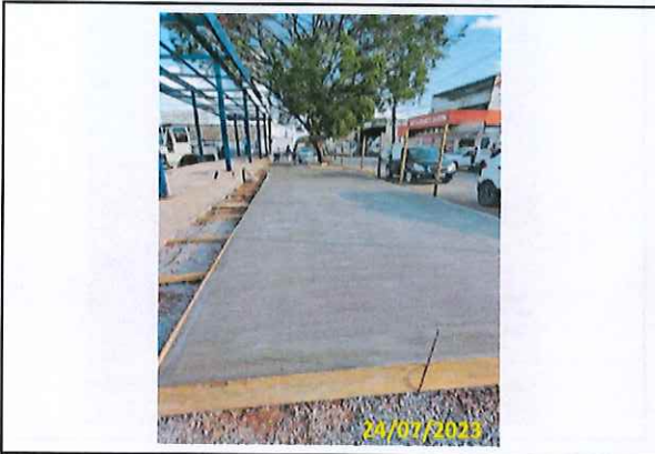
Foto 108 Passeio na área do abrigo de conexão concretado
