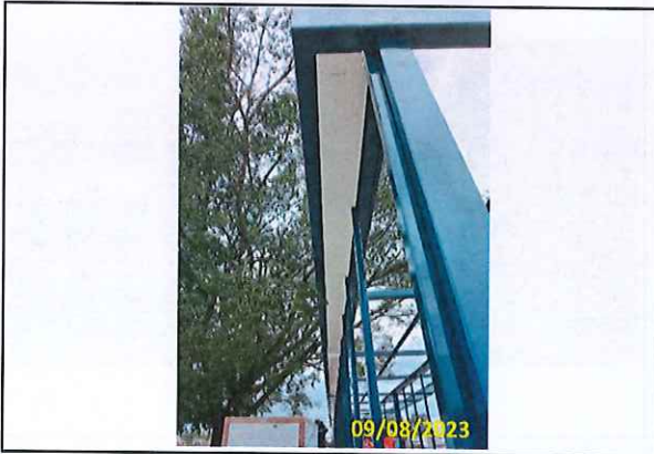
Foto 15 Instalação das calhas da estação
