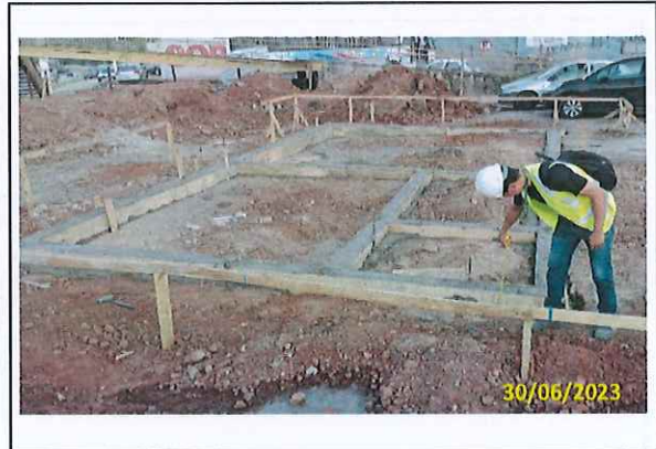
Foto 57 Execução da fundação da casa dos motoristas
