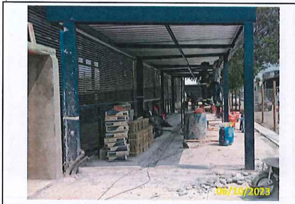
Foto 124 Instalação dos suportes do forro do abrigo
