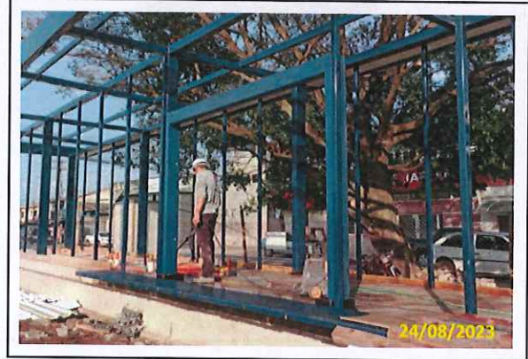
Foto 16 Limpeza da laje para concretagem
