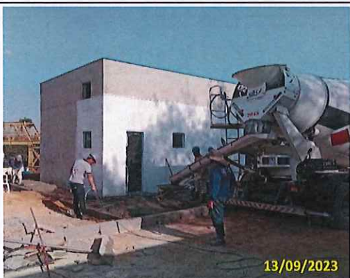
Foto 82 Concretagem do passeio em torno da casa dos motoristas
