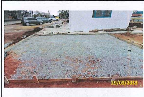
Foto 89 Montagem de fôrmas temporárias e aplicação de lastro - bicicletário
