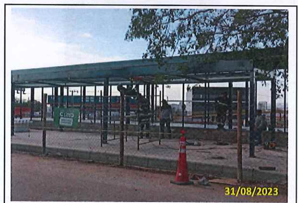
Foto 117 Ajuste de testeiras para cobrir o abrigo
