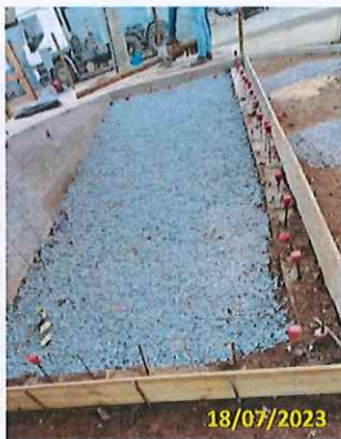
Foto 104 Aplicação de lastro na rampa de acessibilidade
