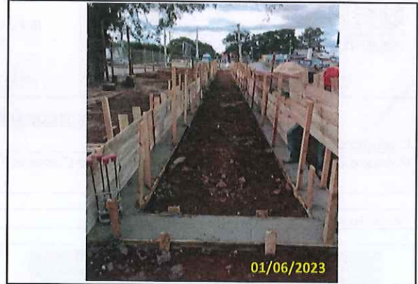
Foto 06 Montagem das fôrmas temporárias
