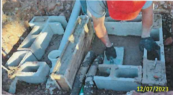
Foto 60 Execução da caixa de inspeção
