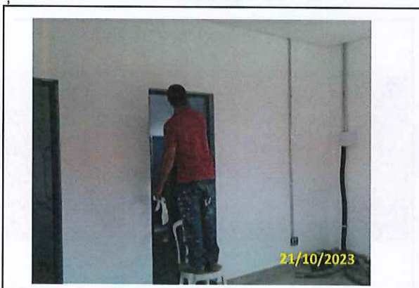
Foto 94 Acabamento em andamento
