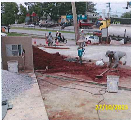
Foto 98 Instalação da ligação de água da casa dos motoristas (Realocação)
