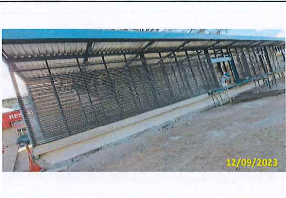
Foto 25 Instalação dos brises (Parte frontal)
