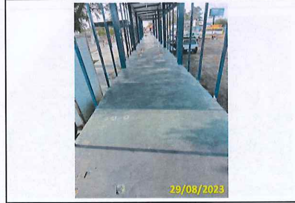
Foto 20 Polimento realizado no piso da estação
