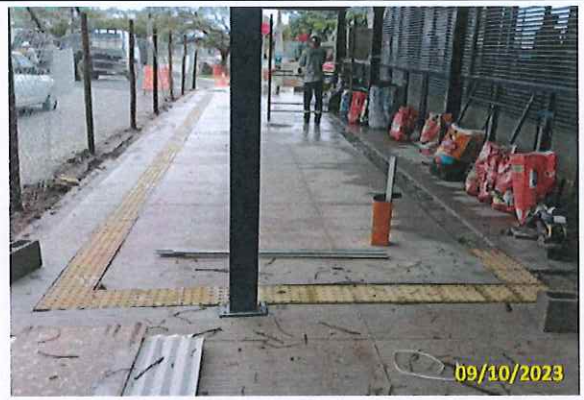
Foto 126 Assentamento de piso podotátil do abrigo
