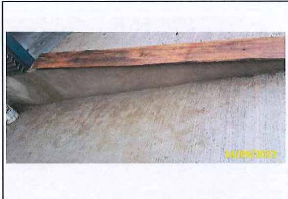
Foto 26 Reboco da base da rampa de acessibilidade
