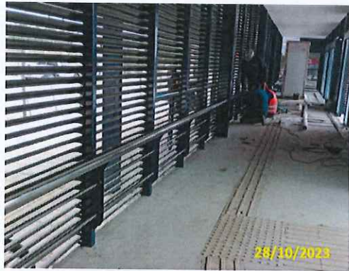
Foto 55 Instalação do bundoril
