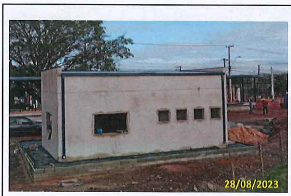
Foto 71 Instalação das calhas da casa dos motoristas
