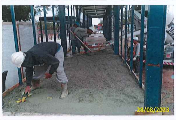
Foto 17 Concretagem da 2ª etapa da laje da estação
