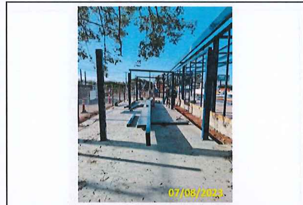
Foto 113 Instalação de telhas
