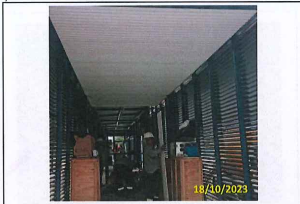
Foto 43 Instalação do forro
