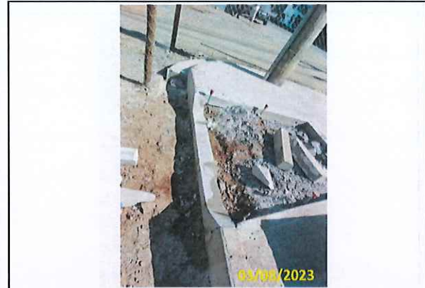
Foto 111 Recorte referente à rampa de acessibilidade
