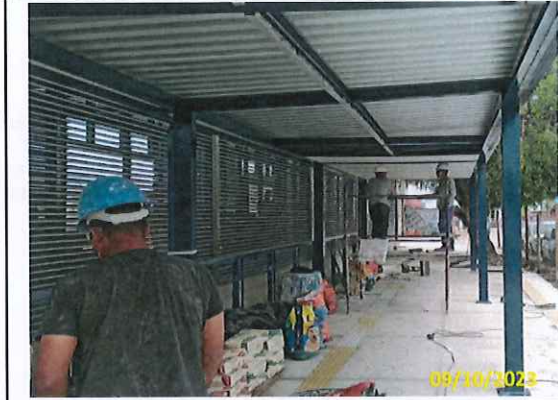
Foto 127 Instalação de forro no abrigo de conexão
