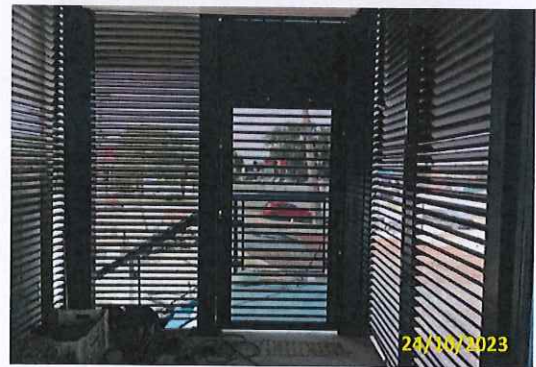
Foto 48 Instalação da porta de saída de emergência
