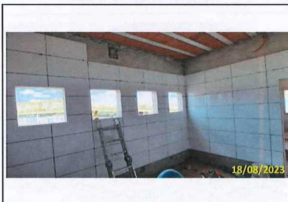
Foto 67 Revestimento em andamento
