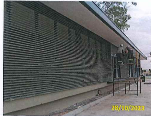
Foto 54 Pintura da estação
