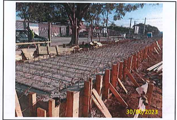
Foto 08 Laje da estação concretada e armada
