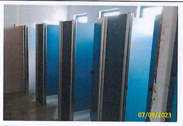
Foto 78 Instalação de gabinetes do banheiro
