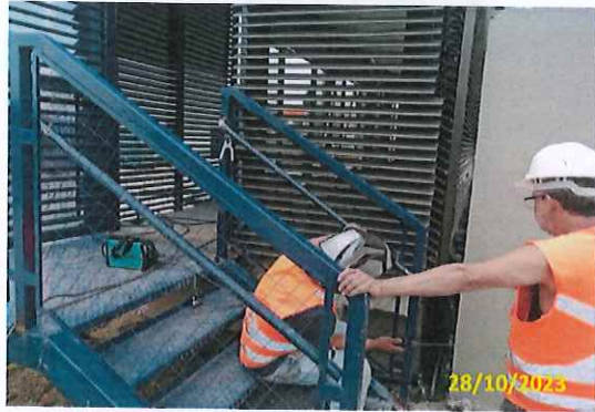
Foto 53 Instalação do corrimão
