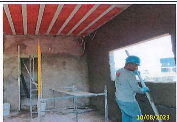
Foto 64 Continuação do reboco interno da casa dos motoristas
