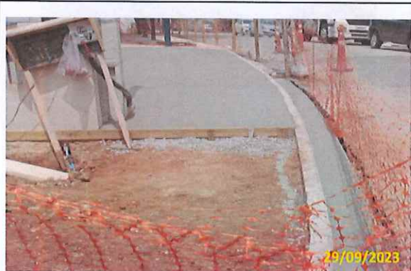
Foto 122 Passeio e sarjetas próximo ao abrigo concretados
