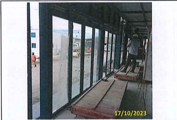
Foto 41 Instalação das portas automáticas da estação
