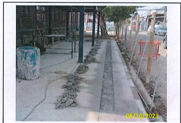
Foto 125 Demolição para assentamento de piso podotátil do abrigo
