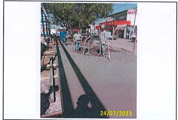
Foto 107 Concretagem do passeio na área do abrigo de conexão
