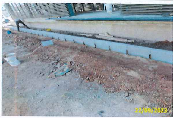
Foto 29 Assentamento de guias próximo à estação
