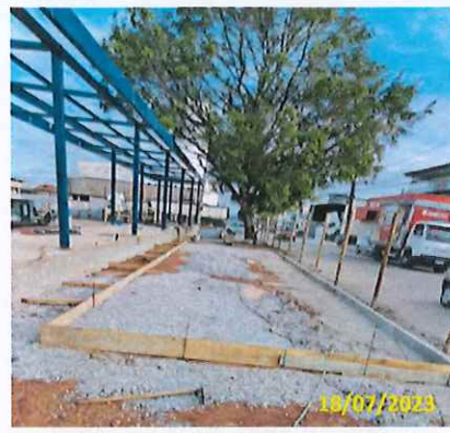
Foto 105 Aplicação de lastro na área do abrigo de conexão
