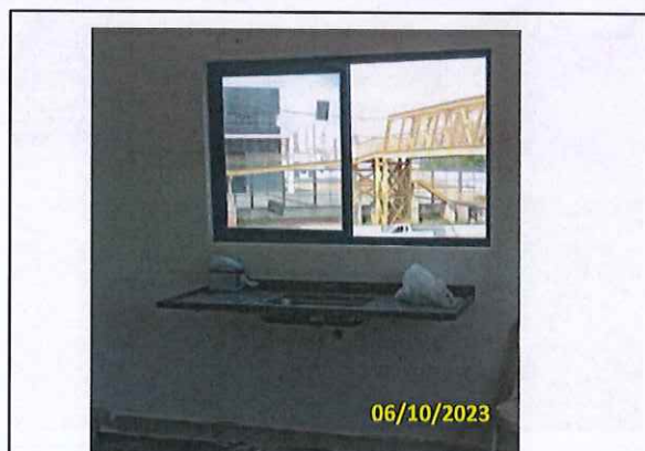
Foto 93 Instalação da pia da cozinha
