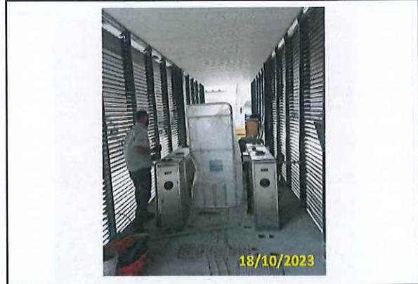
Foto 42 Instalação de catracas
