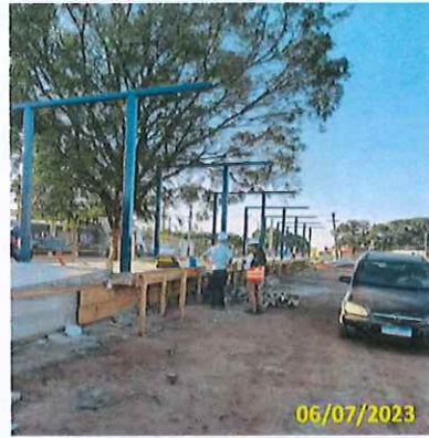
Foto 10 Instalação de pilares e terças
