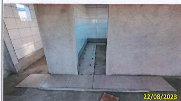
Foto 69 Assentamento de piso na casa dos motoristas
