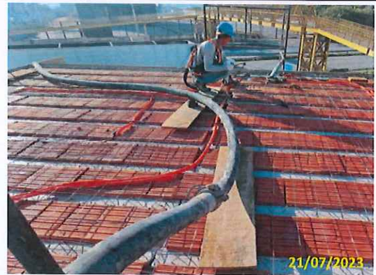
Foto 61 Concretagem da laje da casa dos motoristas
