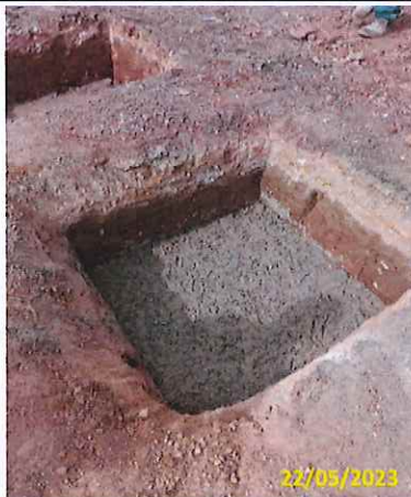
Foto 03 Aplicação de lastro
