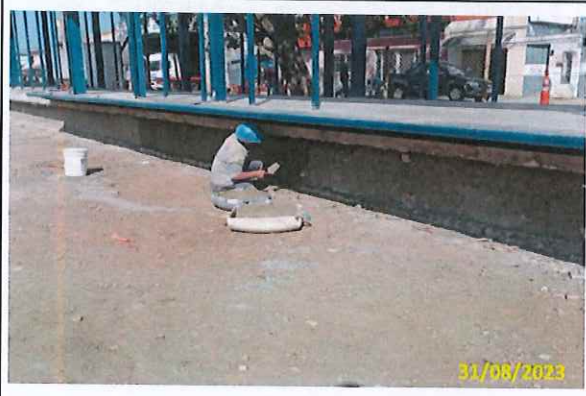
Foto 21 Reboco da base da estação de conexão
