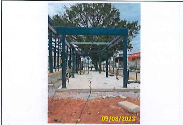
Foto 114 Continuação da montagem do abrigo de conexão
