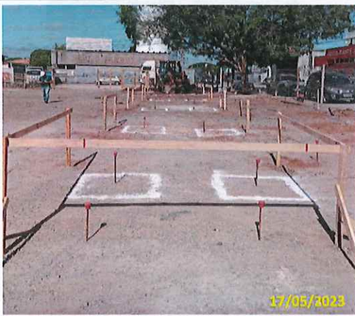
Foto 01 Gabarito da fundação da estação
