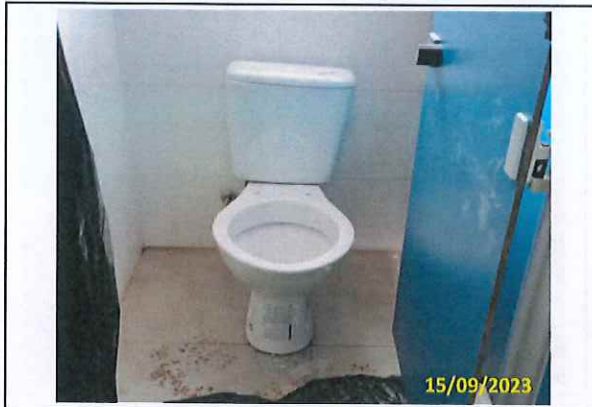
Foto 84 Instalação de louças no banheiro da casa dos motoristas
