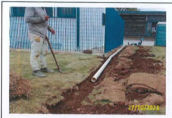
Foto 100 Instalação do tubo de drenagem
