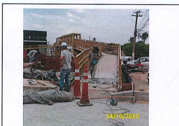
Foto 95 Forma para rampa de acessibilidade da passarela
