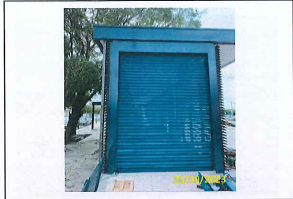
Foto 50 Instalação da porta da estação
