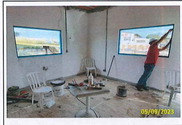
Foto 75 Instalação das janelas da sala dos motoristas
