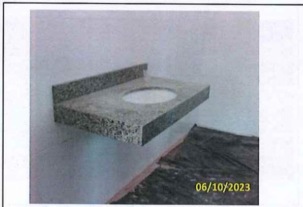
Foto 92 Instalação de cuba do lavatório do banheiro
