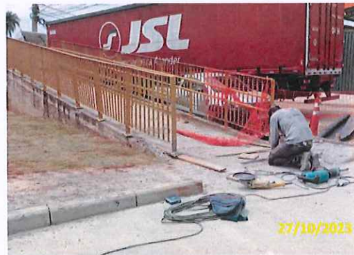
Foto 99 Assentamento de piso podotátil na rampa de acesso à passarela
