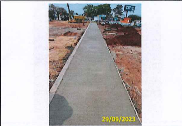
Foto 90 Concretagem do passeio ao lado da casa dos motoristas
