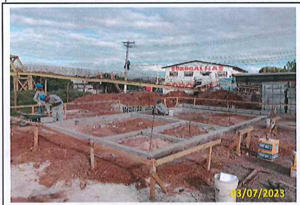
Foto 58 Início da alvenaria da casa dos motoristas
