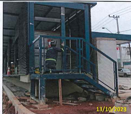
Foto 40 Instalação das calhas da cobertura
