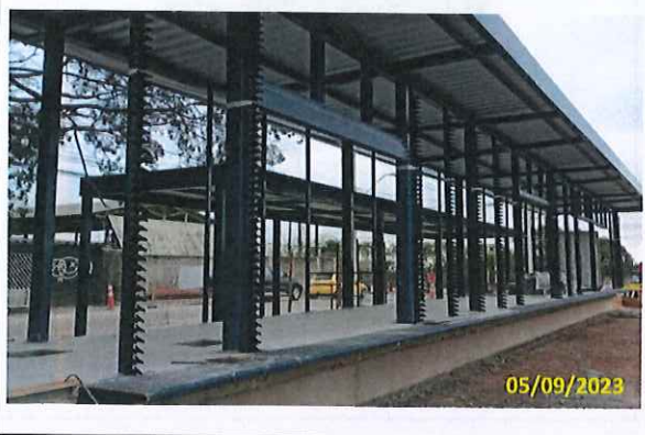
Foto 23 Instalação de suporte dos brises
