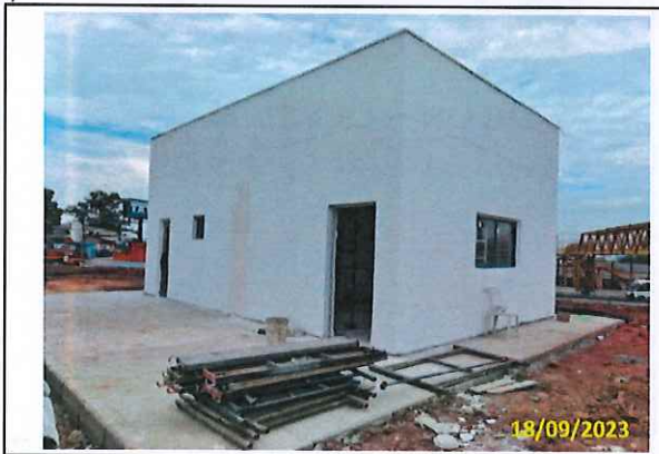
Foto 86 Pintura externa da casa dos motoristas
