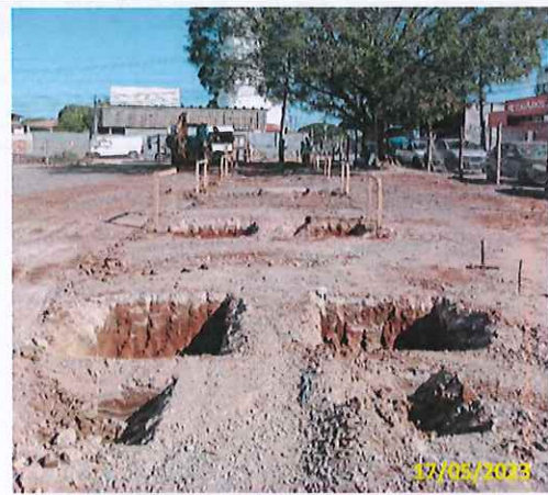
Foto 02 Abertura de vala da fundação
