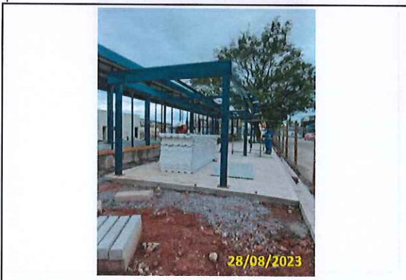
Foto 116 Solda da estrutura metálica do abrigo
