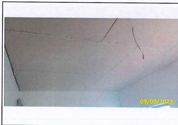
Foto 79 Instalação do forro de gesso no banheiro
