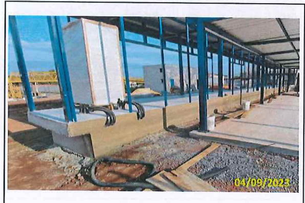
Foto 22 Reboco da base da estação de conexão (Atrás da estação)
