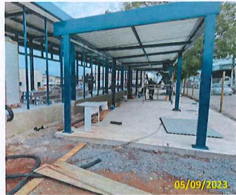
Foto 119 Manutenção das testeiças do abrigo
