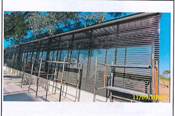
Foto 24 Instalação dos brises (Fundo da estação)
