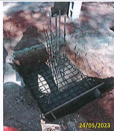
Foto 04 Armação da sapata
