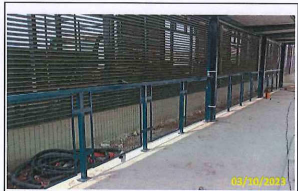
Foto 123 Instalação de gradil no abrigo de conexão
