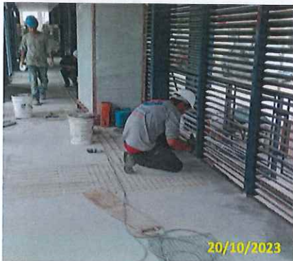
Foto 45 Acabamento entre o piso e reboco da estação
