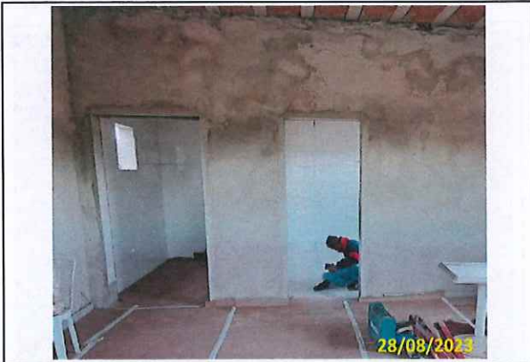
Foto 72 Rejunte do piso e revestimento - Banheiro
