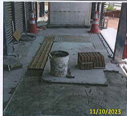
Foto 38 Assentamento de piso podotátil
