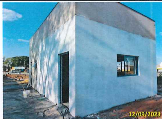
Foto 81 Pintura externa da casa dos motoristas
