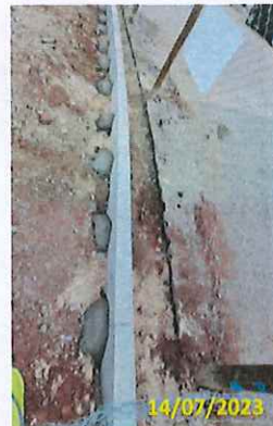
Foto 103 Assentamento de guias em frente ao abrigo de conexão
