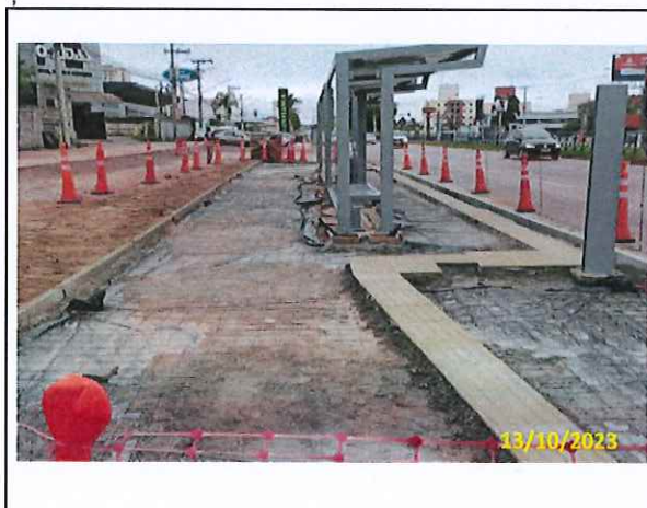
Foto 24 Assentamento de piso podotátil e instalação de lona e tela
