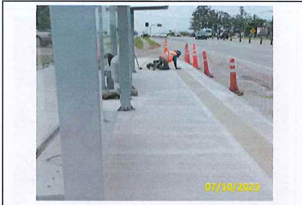
Foto 11 Acabamento e limpeza
