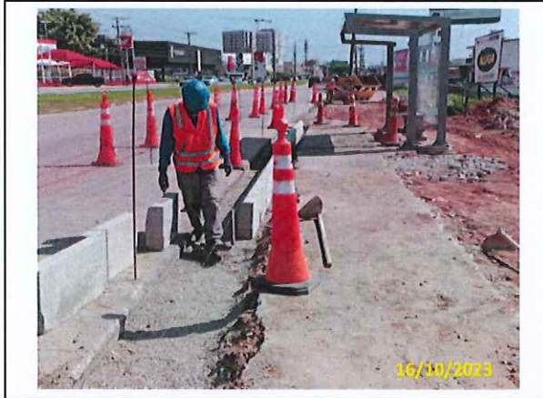
Foto 29 Assentamento de guias
