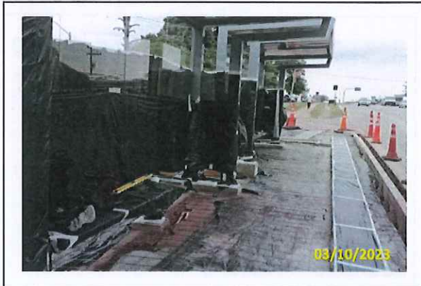
Foto 09 Preparo para concretagem
