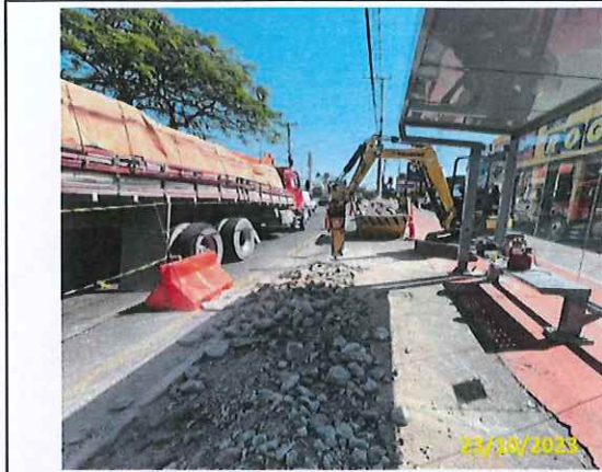
Foto 38 Demolição do passeio existente
