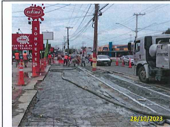
Foto 40 Início da concretagem
