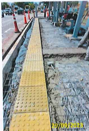
Foto 07 Assentamento de piso podotátil
