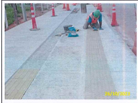
Foto 30 Assentamento de guias
