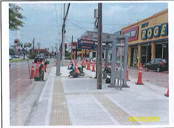
Foto 42 Acabamento e limpeza do passeio
