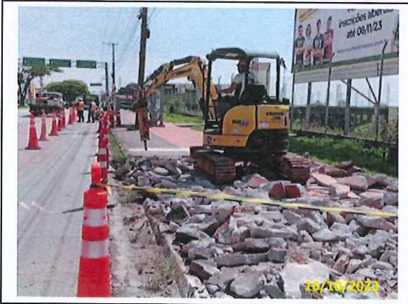
Foto 33 Demolição do passeio existente
