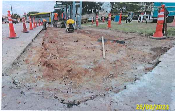
Foto 01 Demolição do passeio existente
