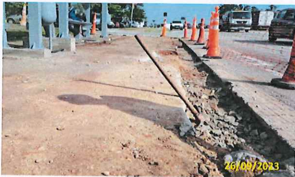
Foto 03 Demolição de guia e sarjeta
