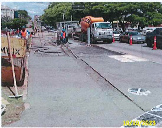
Foto 18 Concretagem do passeio
