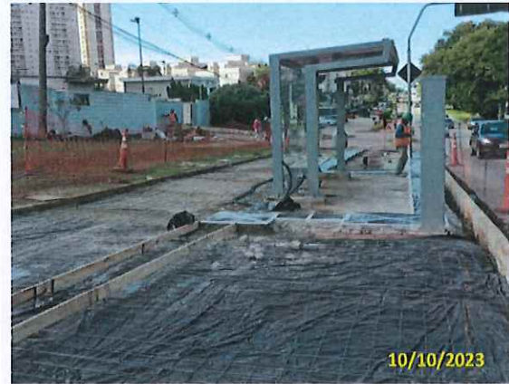
Foto 17 Preparo para concretagem
