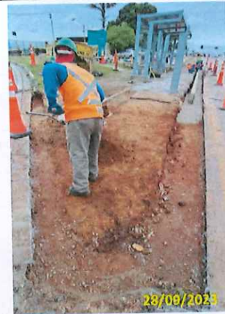
Foto 06 Escavação para nivelamento do passeio
