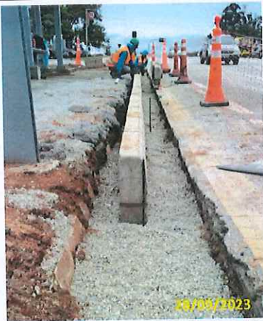
Foto 05 Assentamento de guias
