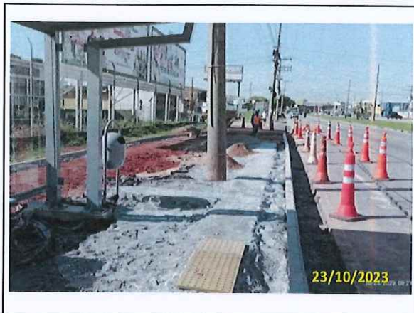
Foto 34 Preparo para assentamento de piso podotátil
