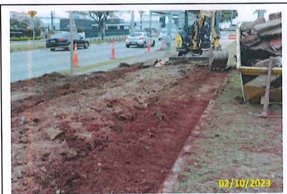
Foto 12 Demolição do passeio existente
