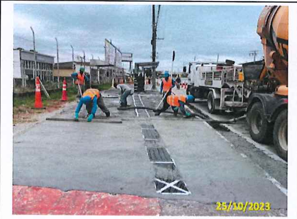
Foto 35 Concretagem do passeio em andamento
