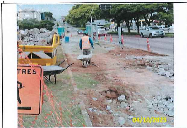
Foto 14 Continuação da demolição
