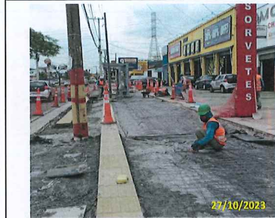
Foto 39 Assentamento de piso podotátil e instalação de lona e tela
