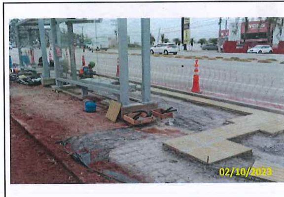
Foto 13 Assentamento de piso podotátil
