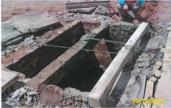
Foto 16 Troca de tampa e guia chapéu
