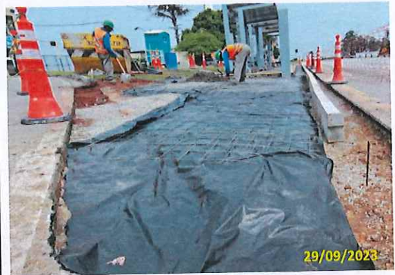
Foto 08 Aplicação de lona e tela metálica
