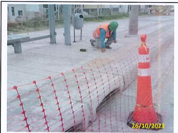
Foto 36 Acabamento e limpeza
