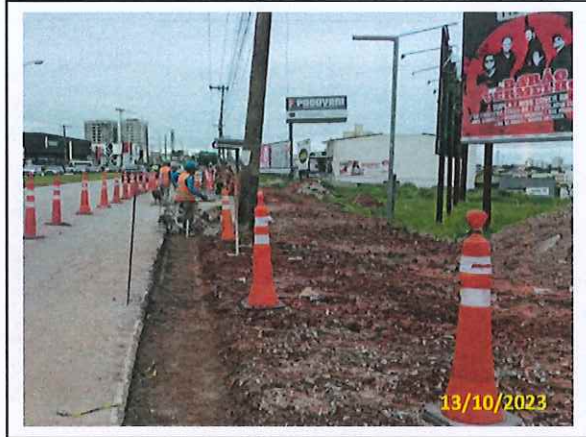
Foto 28 Continuação da demolição
