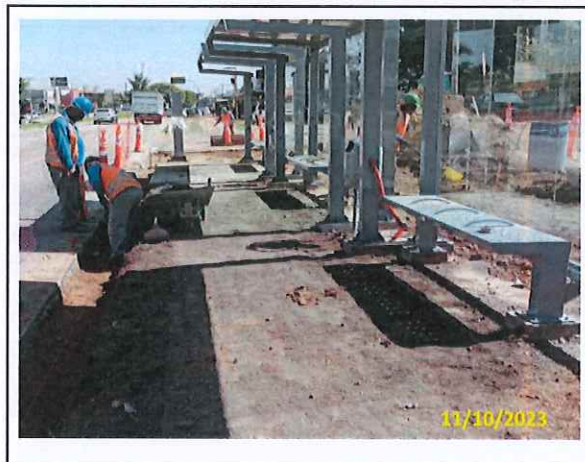
Foto 23 Continuação da limpeza e preparo para assentamento de piso podotátil
