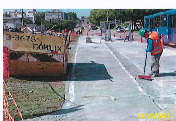
Foto 17 Preparo para concretagem
