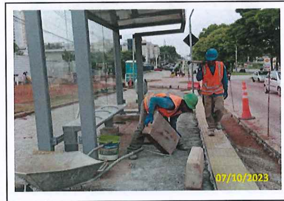
Foto 15 Assentamento de guias
