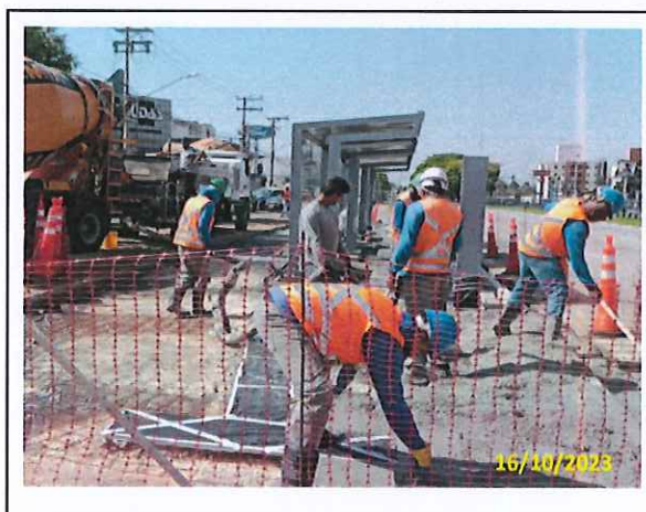
Foto 25 Início da concretagem
