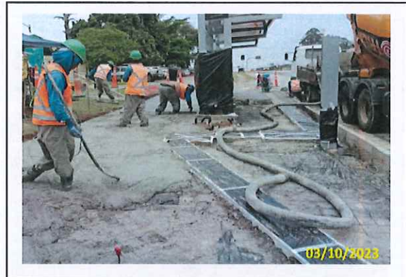
Foto 10 Concretagem do passeio em andamento
