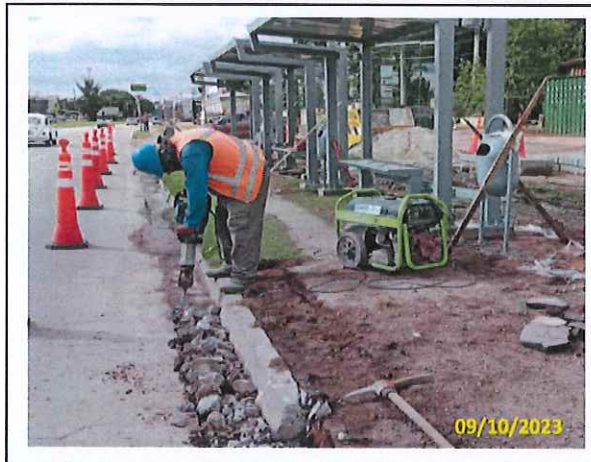
Foto 22 Demolição em andamento
