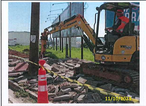
Foto 27 Demolição do passeio existente
