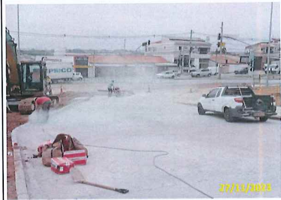
Foto 82 Corte e tratamento das juntas de dilatação
