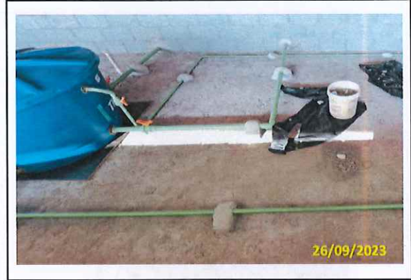
Foto 12 Pintura da tubulação de água
