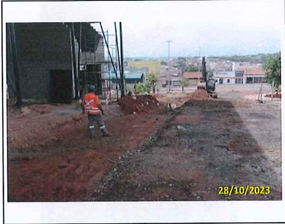
Foto 22 Escavação em andamento
