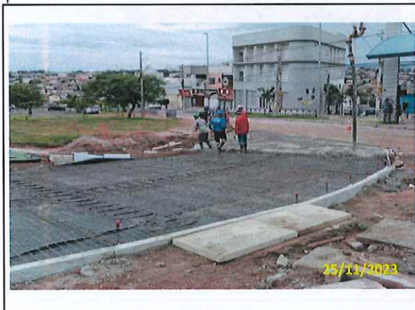
Foto 79 Aplicação do CCP
