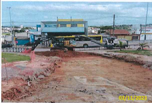
Foto 27 Escavação para execução do pavimento rígido
