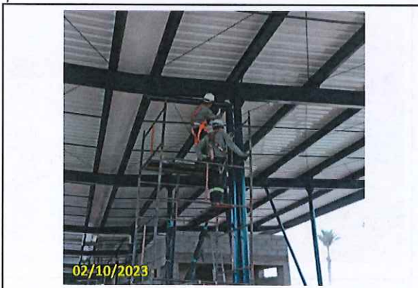
Foto 15 Pintura dos dutos de drenagem
