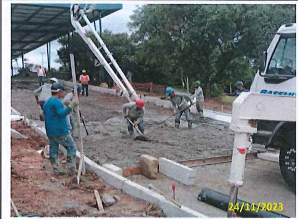
Foto 75 Aplicação do CCP
