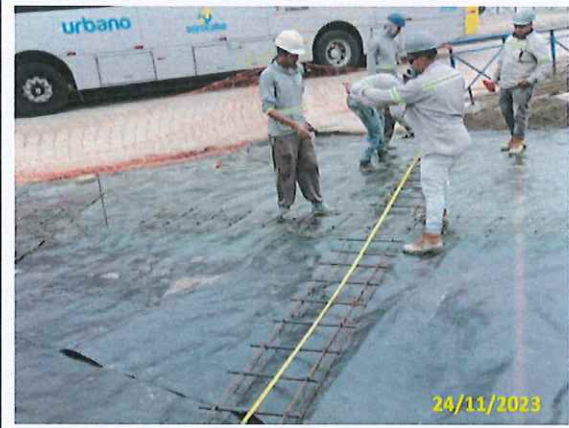
Foto 74 Marcação das juntas
