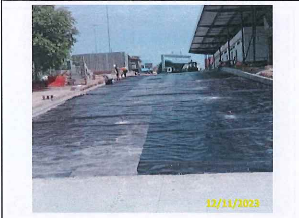
Foto 51 Preparo para aplicação de CCP
