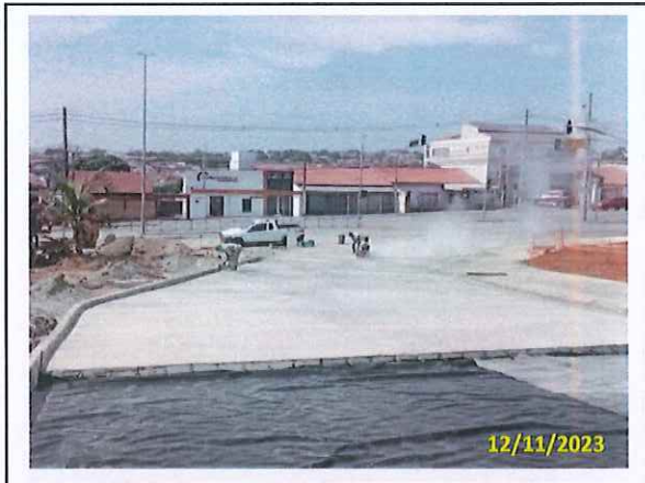
Foto 50 Corte das juntas de dilatação
