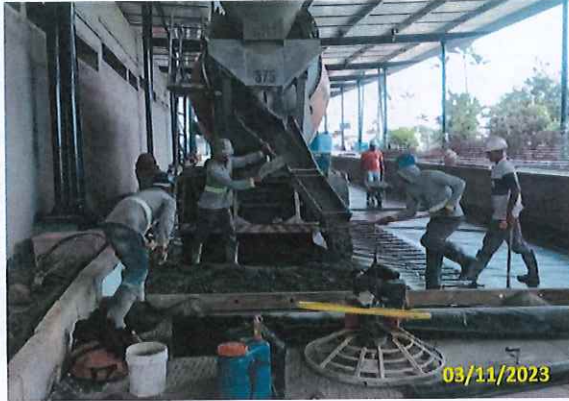
Foto 29 Início da aplicação do CCP (lado esquerdo do edifício de apoio)
