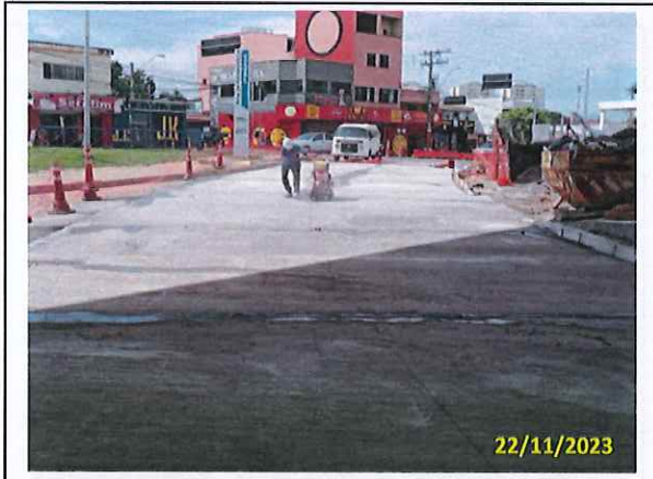
Foto 67 Corte das juntas de dilatação
