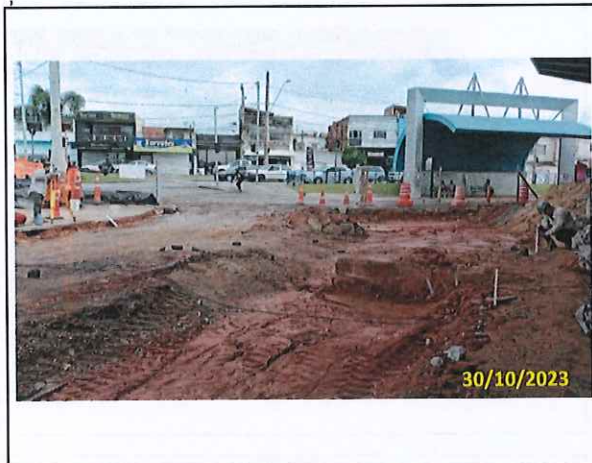
Foto 23 Marcação topográfica para execução do pavimento rígido
