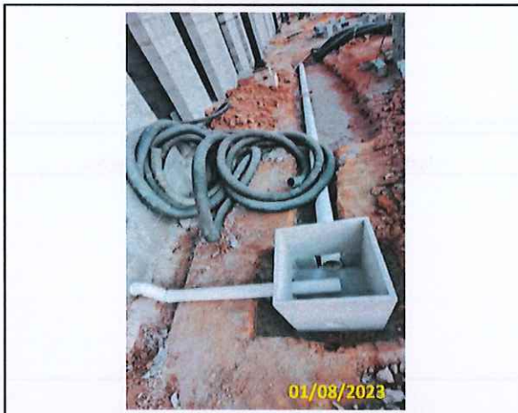
Foto 04 Instalação hidráulica - Tubulação e caixa de inspeção
