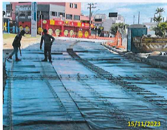
Foto 63 Montagem da armadura
