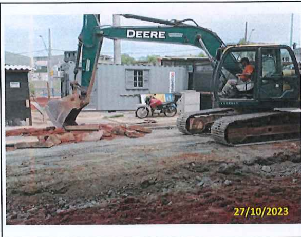
Foto 21 Remoção de guias existentes
