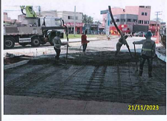
Foto 64 Aplicação do CCP
