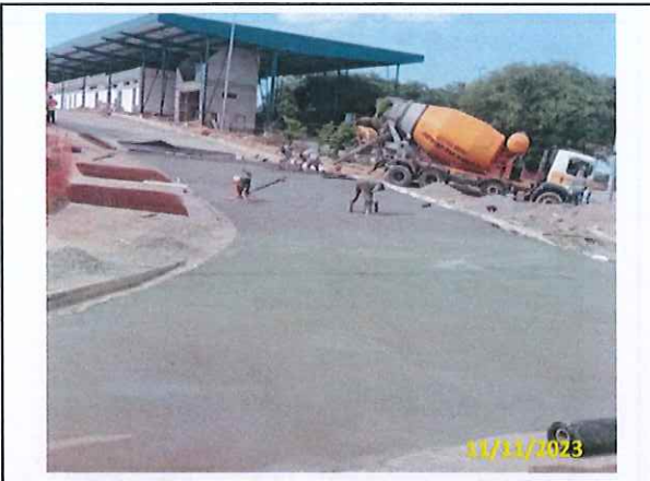
Foto 49 Acabamento do CCP aplicado
