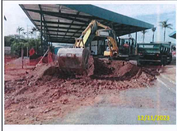
Foto 52 Escavação e limpeza
