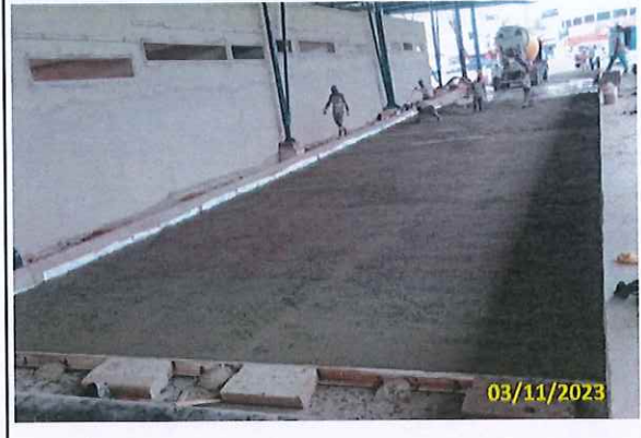
Foto 30 Aplicação do CCP em andamento (lado esquerdo do edifício de apoio)
