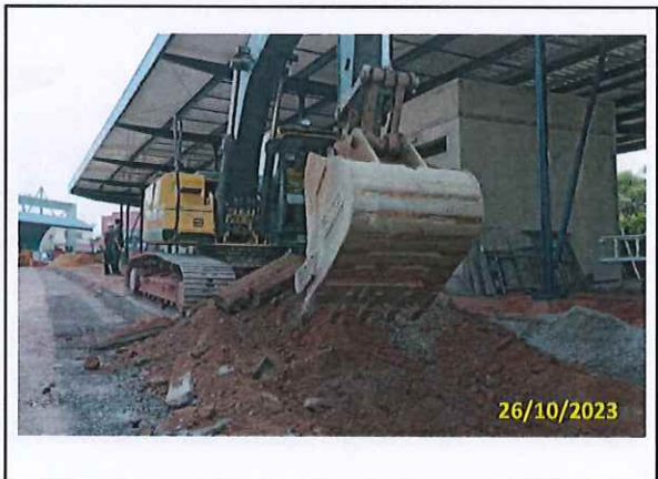
Foto 20 Início da escavação
