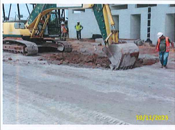
Foto 45 Tratamento de solo (Ponto borrachudo)
