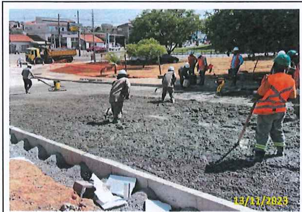
Foto 57 Aplicação do CCP em andamento
