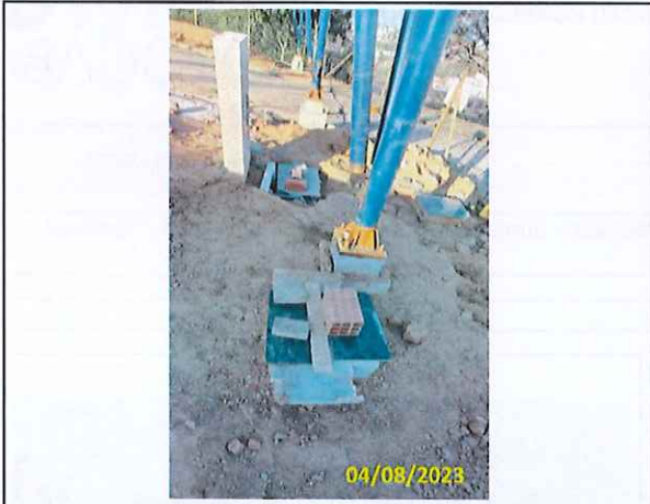
Foto 05 Assentamento da caixa de inspeção e aterro da tubulação
