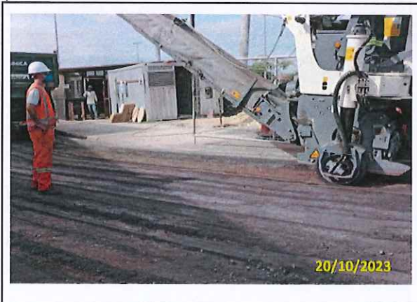
Foto 19 Fresagem em andamento
