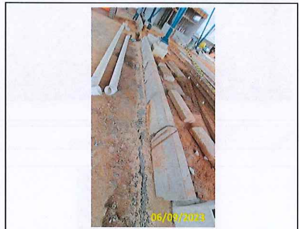
Foto 08 Assentamento de guias (lado esquerdo do edifício de apoio)
