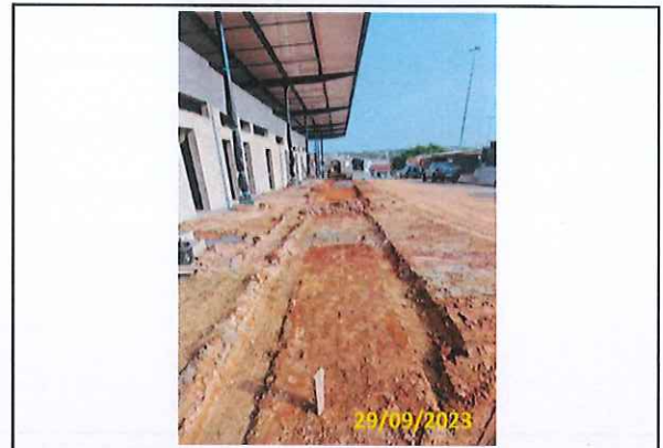
Foto 14 Acerto do solo para assentamento de guias
