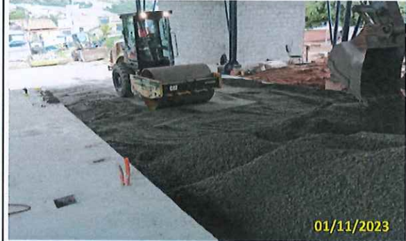
Foto 26 Aplicação de CCR (lado esquerdo do edifício de apoio)
