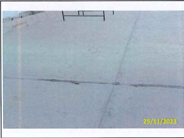
Foto 77 Tratamento das juntas
