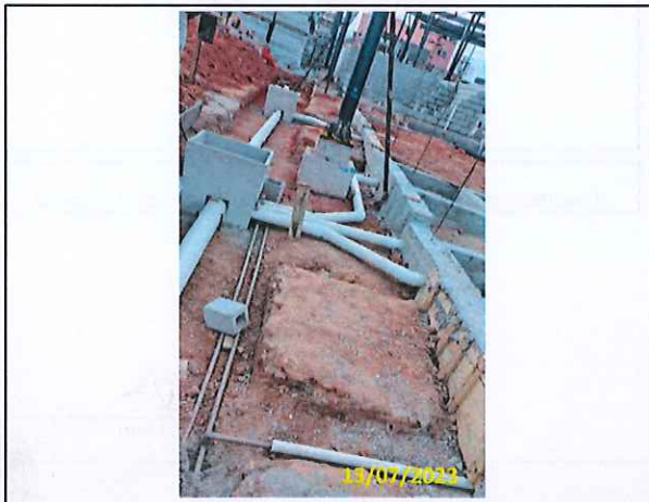
Foto 03 Instalação hidráulica - Tubulação e caixa de inspeção
