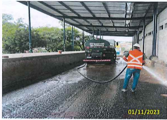
Foto 25 Limpeza para aplicação do CCR (lado esquerdo do edifício de apoio)
