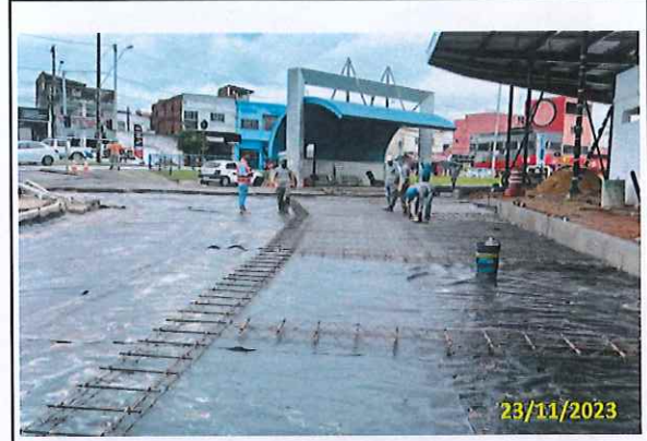
Foto 70 Montagem da armadura
