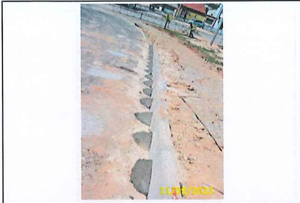
Foto 09 Escoramento de guias com bola de concreto
