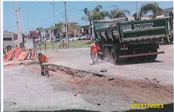
Foto 38 Demolição em andamento (entrada)
