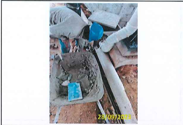
Foto 13 Acabamento na caixa de inspeção
