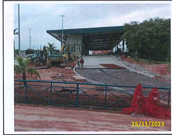
Foto 78 Preparo para concretagem
