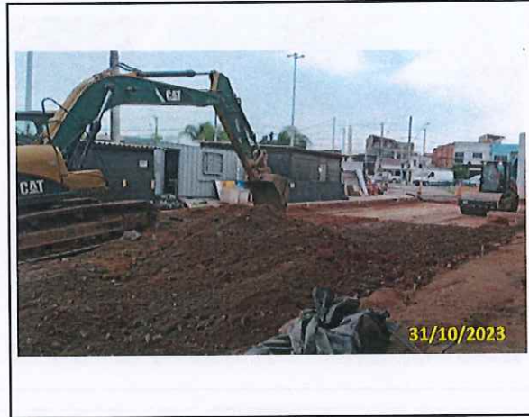
Foto 24 Escavação e compactação
