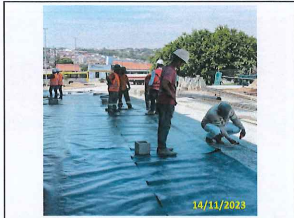
Foto 58 Preparo para aplicação do CCP
