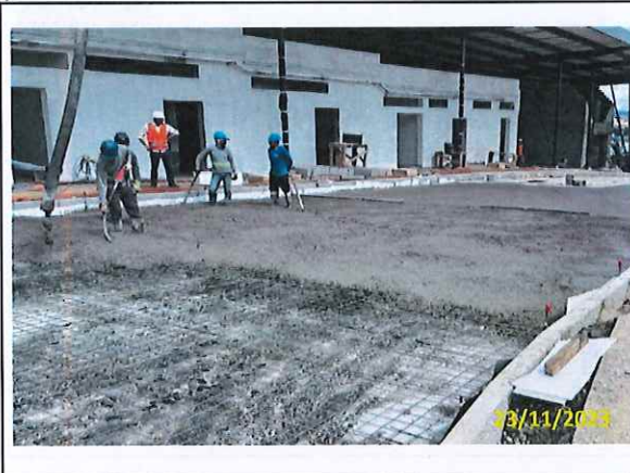
Foto 71 Aplicação do CCP
