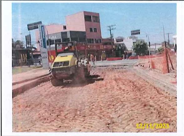
Foto 53 Compactação em andamento
