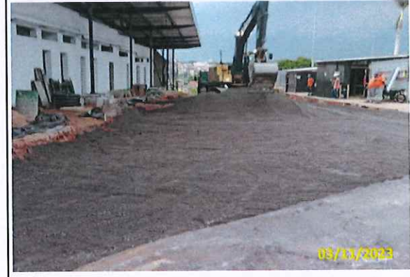
Foto 32 Aplicação de CCR (lado direito do edifício de apoio)
