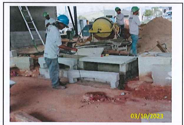
Foto 16 Alteamento da boca de lobo
