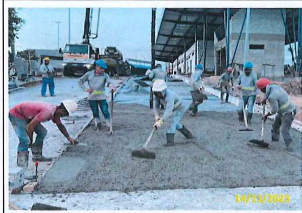
Foto 59 Aplicação do CCP em andamento
