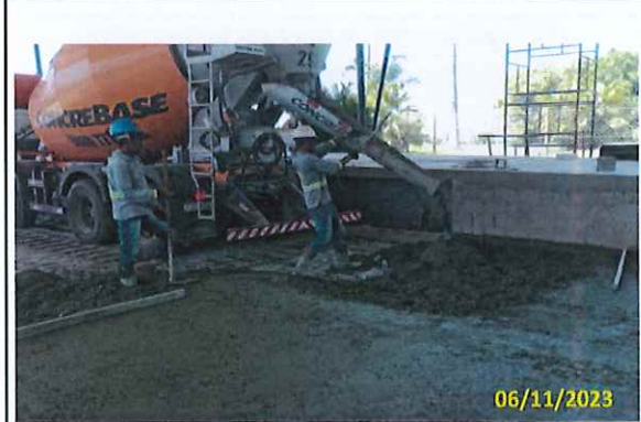
Foto 34 Aplicação de CCP em andamento
