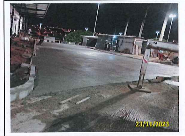
Foto 72 Concretagem finalizada
