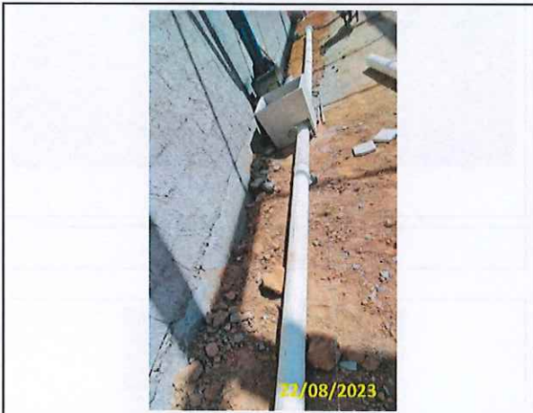
Foto 07 Instalação da tubulação e caixa de inspeção
