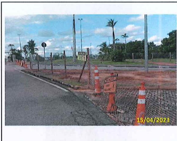
Foto 02 Limpeza do terreno
