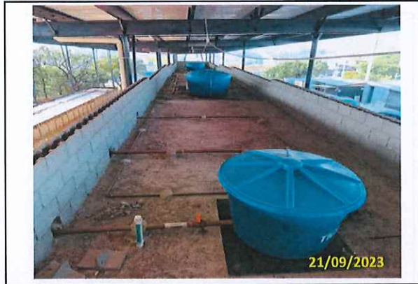
Foto 11 Ligação e travamento das tubulações de ligação com as caixas d'água
