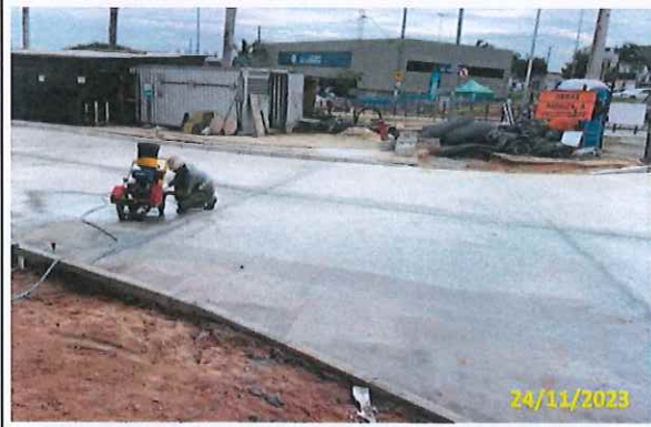
Foto 73 Corte das juntas de dilatação
