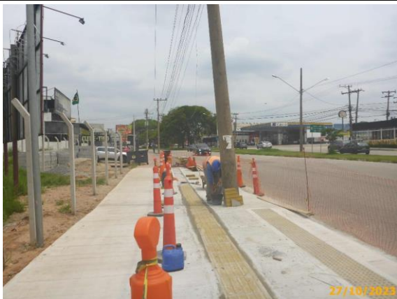
Foto 47 – Instalação dos ladrilhos táteis em andamento.
