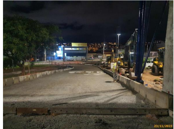
Foto 28 – Novas guias de concreto assentadas na via da Linha Eixo BRT.
