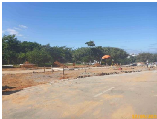
Foto 6 – Marcação locacional pela equipe de topografia.
