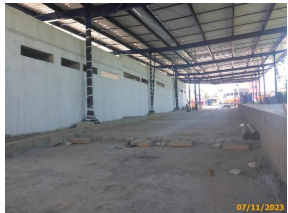
Foto 74 – CCP concluído na via da Linha Eixo BRT.
