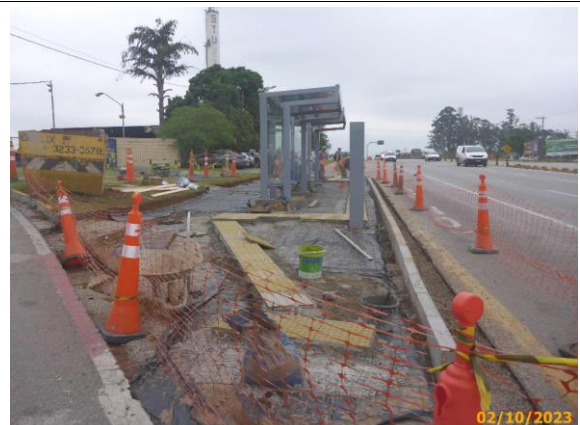
Foto 86 – Preparação do terreno concluída, em destaque, os ladrilhos táteis em implantação.
