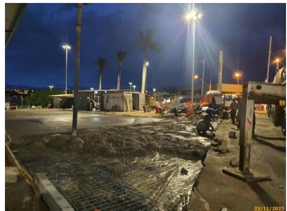
Foto 50 – Concreto sendo aplicado na via das Linhas Alimentadoras.
