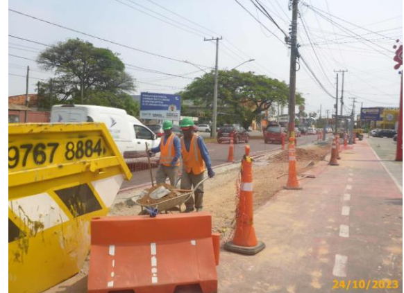
Foto 10 – Demolição e limpeza em andamento.
