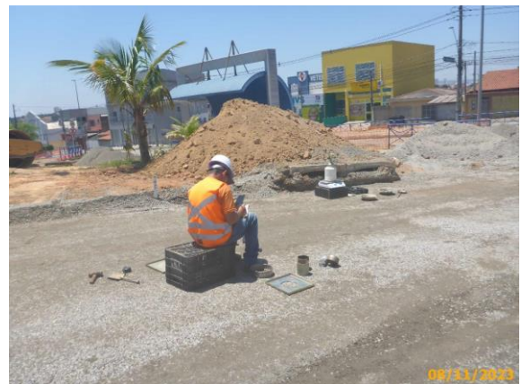
Foto 90 – Controle Tecnológico do BGS lançado na via das Linhas Alimentadoras.
