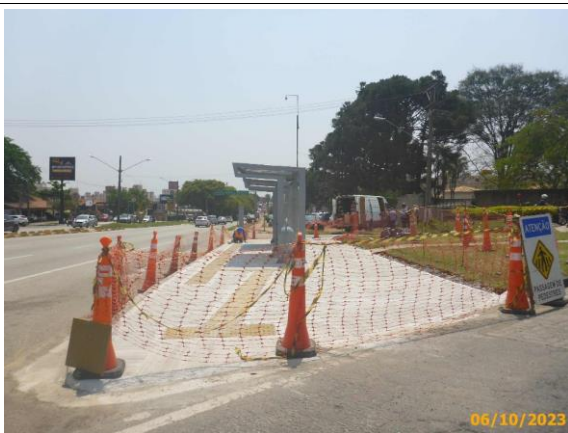
Foto 91 – Limpeza e aplicação do rejunte nos ladrilhos táteis.
