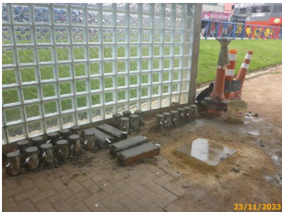
Foto 85 – Controle Tecnológico do concreto lançado na via das Linhas Alimentadoras.
