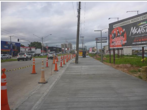
Foto 43 – Concretagem do passeio concluído, em destaque, as ranhuras no passeio
