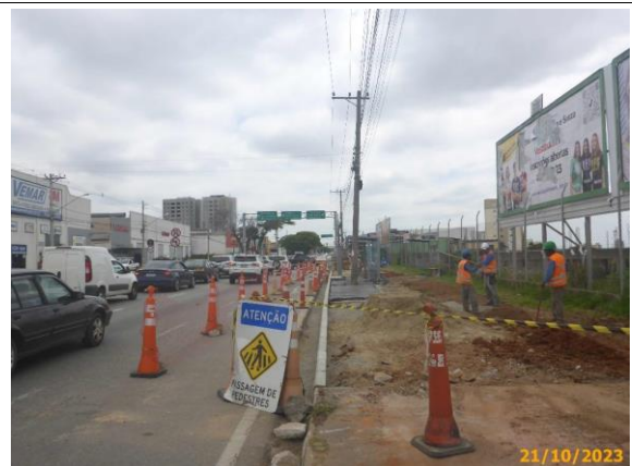
Foto 26 – Preparação do terreno para a concretagem.
