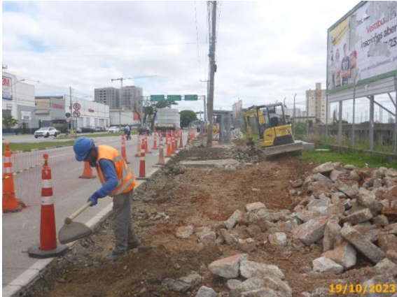
Foto 21 – Demolição da área de intervenção das obras no passeio.
