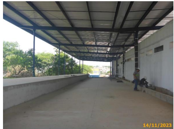
Foto 96 – Vista parcial do pavimento rígido da via da Linha Eixo BRT concluído.
