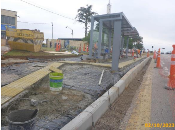
Foto 87 – Guias pré-moldadas instaladas, em destaque, a elevação da guia em 28 cm.
