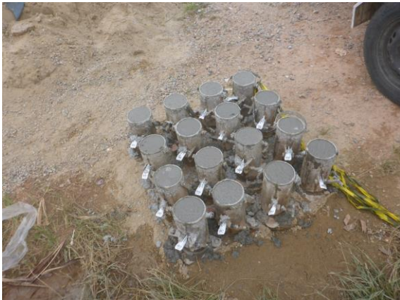
Foto 41 – Controle tecnológico do concreto.
