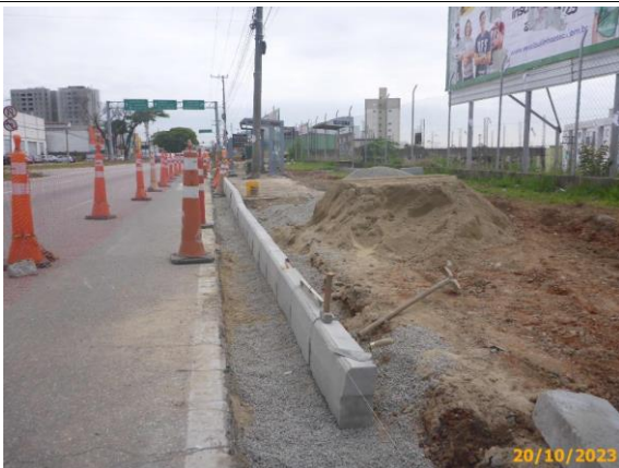
Foto 23 – Guias pré-moldadas em implantação.
