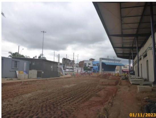
Foto 37 – Compactação da sub-base da via das Linhas Alimentadoras.
