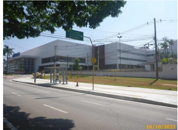
Foto 82 – Vista geral do Ponto de Parada concluído.
