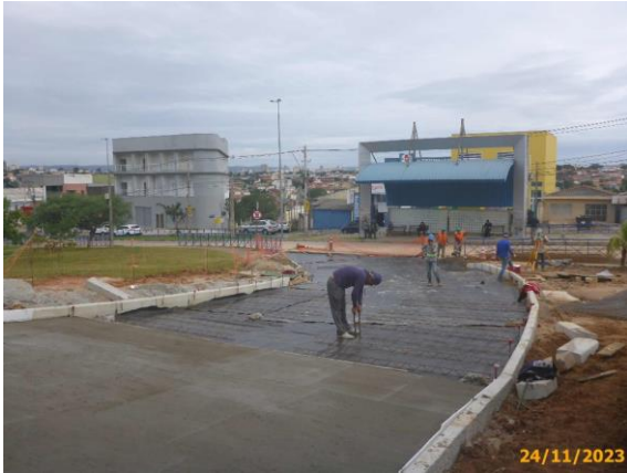
Foto 75 – Instalação das tela Q-283 e das barras de transição.
