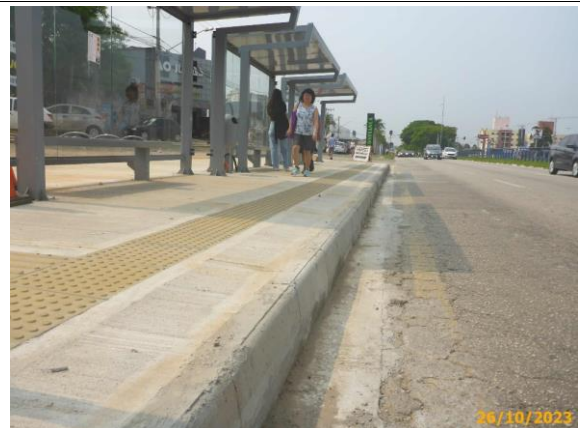
Foto 66 – Detalhe da guia pré-moldada elevada.
