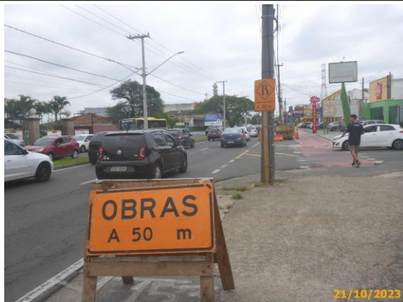
Foto 5 – Sinalização provisória das obras no passeio.
