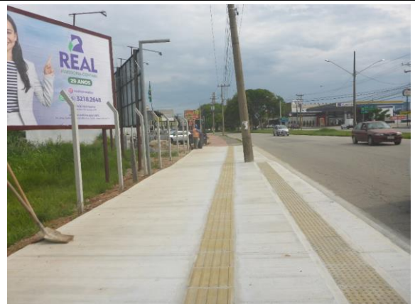
Foto 48 – Sinalização tátil concluída.
