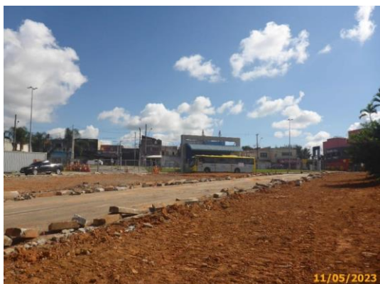
Foto 5 – Vista parcial da limpeza do terreno realizada no Terminal Ipiranga. Em destaque, a via da Linha Eixo do BRT.
