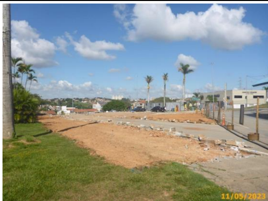
Foto 3 – Vista parcial da limpeza do terreno realizada no Terminal Ipiranga, inclusive a remoção das guias existentes.
