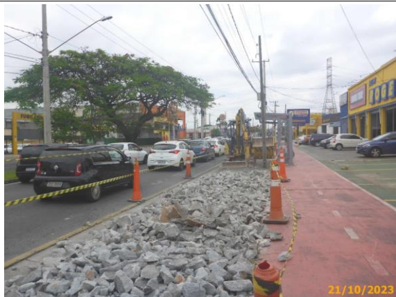
Foto 7 – Demolição do passeio existente.
