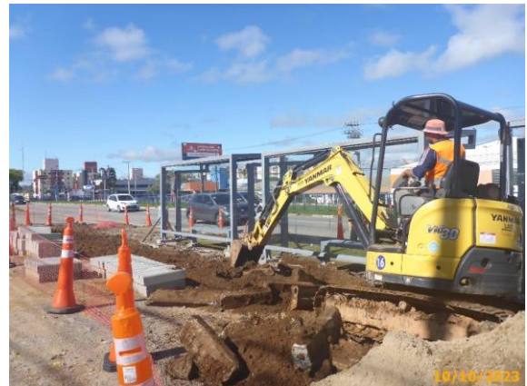
Foto 54 – Demolição e limpeza do terreno do passeio a ser reformado.
