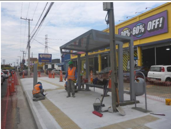
Foto 17 – Limpeza e rejunte dos ladrilhos táteis.
