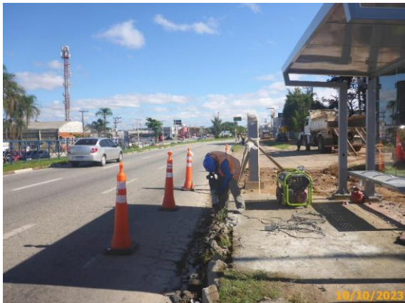
Foto 53 – Demolição da guia e da sarjeta.
