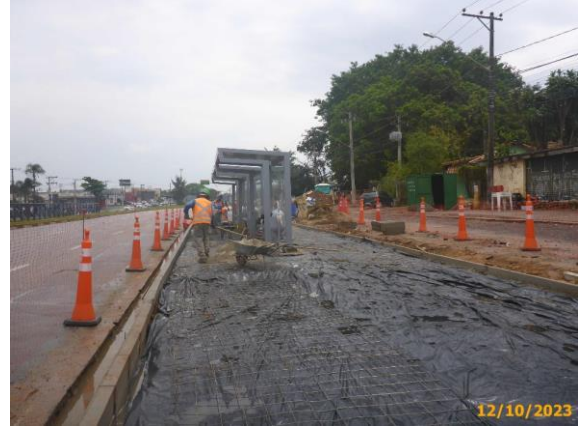
Foto 58 – Preparo do berço do passeio em andamento.
