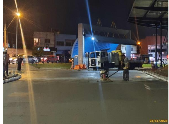
Foto 52 – Equipamento de acabamento (bambolê) do pavimento rígido na via das Linhas Alimentadoras.
