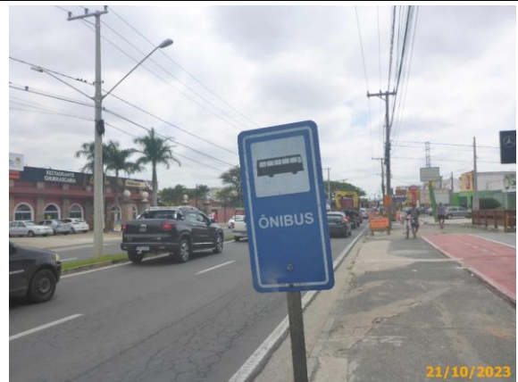
Foto 6 – Ponto de Parada provisório durante as obras no passeio.
