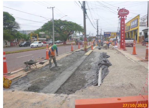
Foto 12 – Instalação dos ladrilhos táteis e preparação do terreno em andamento.
