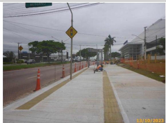
Foto 80 – Limpeza e rejunte da sinalização tátil.
