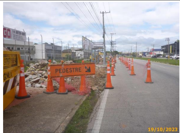
Foto 20 – Sinalização de isolamento das obras, e da passagem de pedestres.
