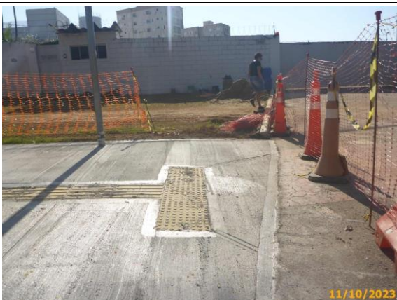
Foto 79 – Detalhe da acessibilidade ao passeio, em conformidade com a NBR 16537.
