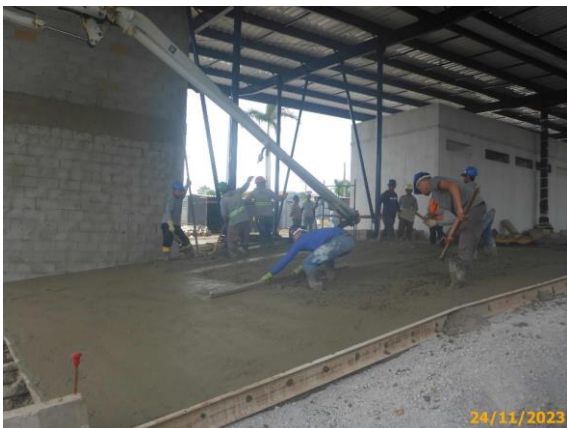
Foto 79 – CCP em execução na via da Linha Eixo BRT.
