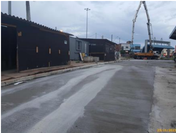
Foto 45 – Cura química aplicado no concreto da via das Linhas Alimentadoras.
