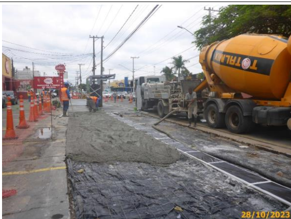
Foto 13 – Concretagem em andamento.
