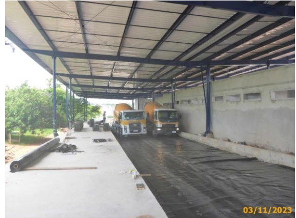
Foto 70 – CCP em andamento (sistema whitetopping) na via da Linha Eixo BRT.
