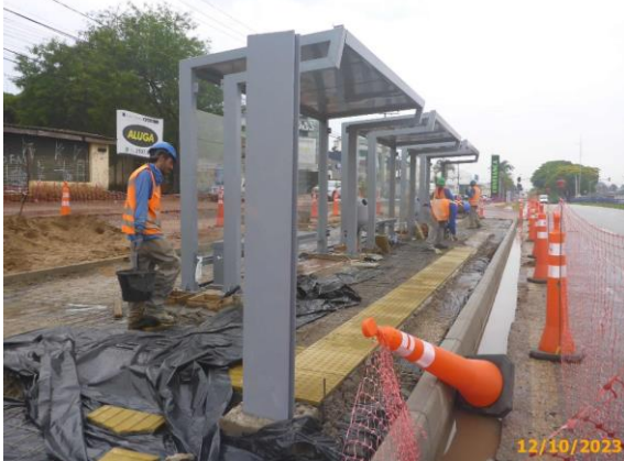
Foto 59 – Ladrilho tátil em instalação.
