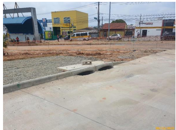
Foto 20 – Reconstrução da boca-de-lobo concluída na via das Linhas Alimentadoras.
