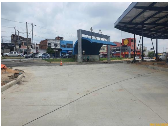
Foto 91 – Vista parcial do pavimento rígido concluído da via das Linhas Alimentadoras.
