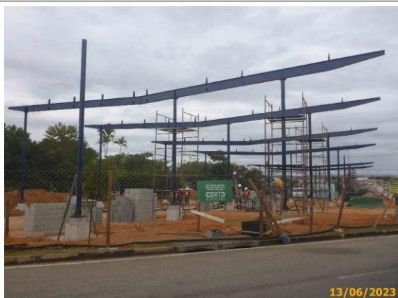
Foto 7 – Isolamento da área de intervenção das obras do BRT na face voltada a rua Estado de Israel.
