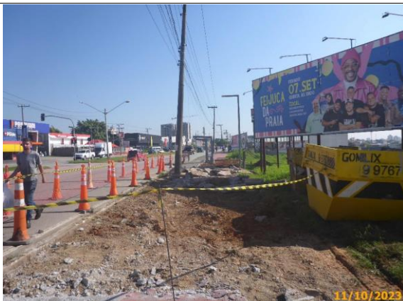
Foto 37 – Demolição em andamento na área de intervenção das obras.
