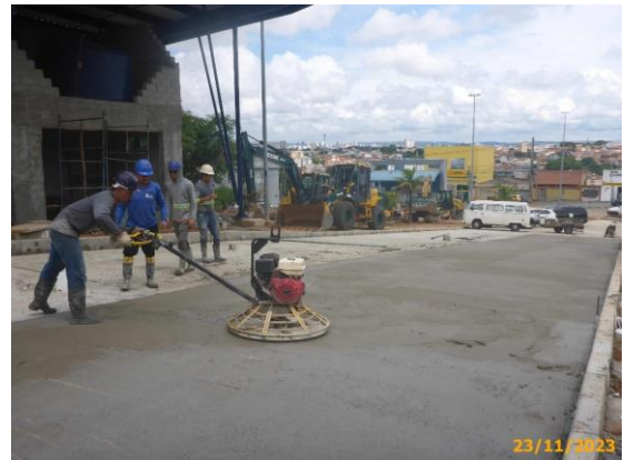
Foto 42 – Equipamento de acabamento (bambolê) do pavimento rígido na via das Linhas Alimentadoras.
