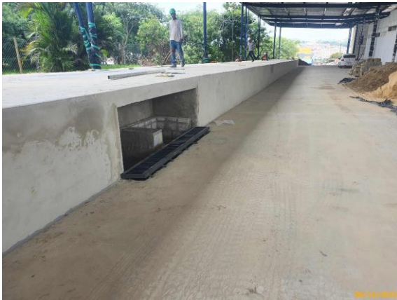
Foto 15 – Reconstrução da boca-de-lobo na via Linha Eixo BRT, inclusive a instalação da grelha em ferro.
