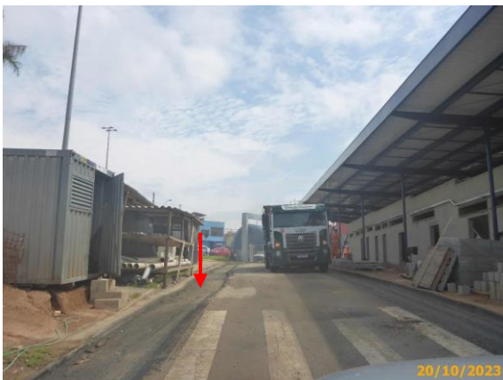
Foto 31 – Fresagem do pavimento flexível existente, destacando a deflexão da via das Linhas Alimentadoras.
