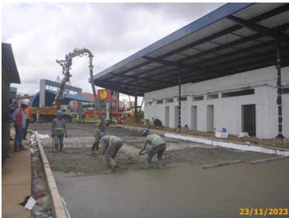
Foto 47 – Concreto sendo aplicado na via das Linhas Alimentadoras.
