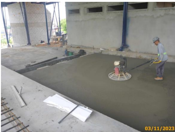
Foto 73 – Equipamento de acabamento (bambolê) do pavimento rígido na via da Linha Eixo BRT.
