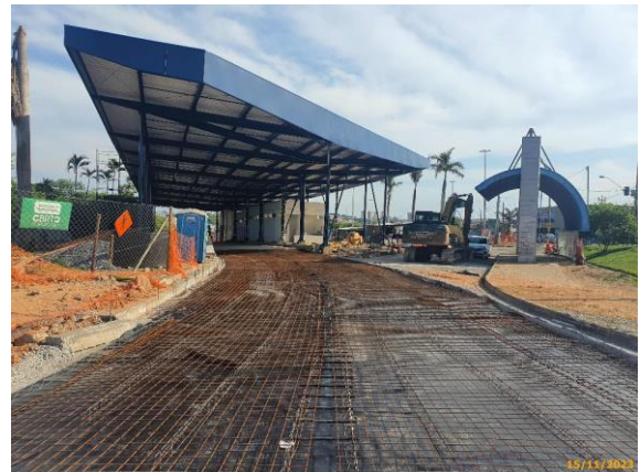
Foto 66 – Segue foto anterior. Em destaque, as telas Q-283, as barras de transição no eixo, e as treliças de apoio.
