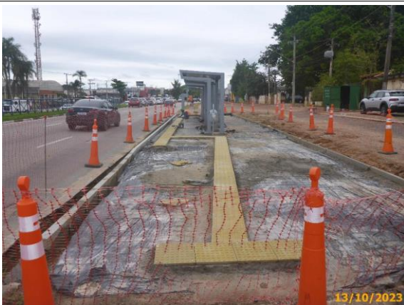
Foto 61 – Passeio preparado para a concretagem.
