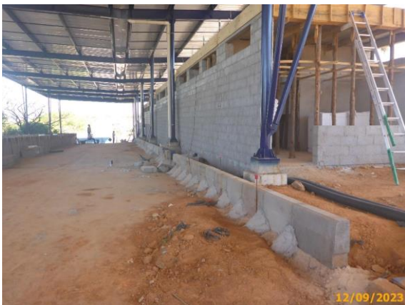
Foto 25 – Novas guias de concreto assentadas na via da Linha Eixo BRT.
