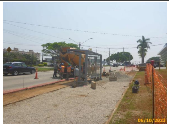
Foto 72 – Berço do passeio em preparação para a concretagem.
