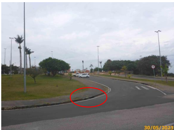
Foto 13 – Sistema de drenagem existente na via das Linhas Alimentadoras, foi mantido.
