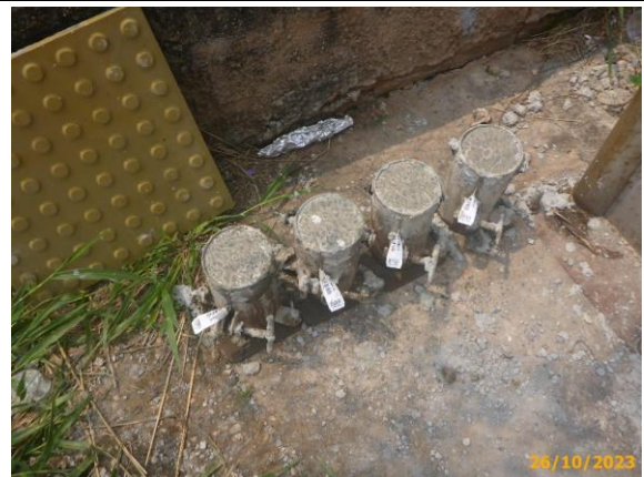
Foto 30 – Controle tecnológico do concreto.
