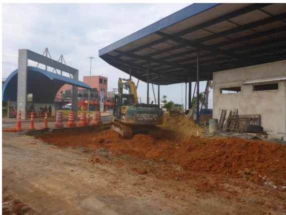
Foto 35 – Segue foto anterior. Escavação do solo natural da via.
