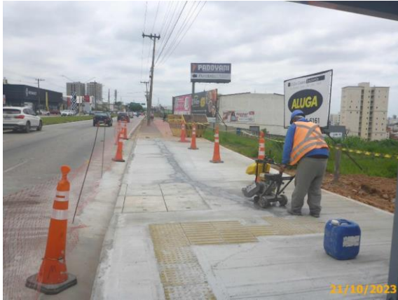
Foto 45 – Corte para a instalação dos ladrilhos táteis
