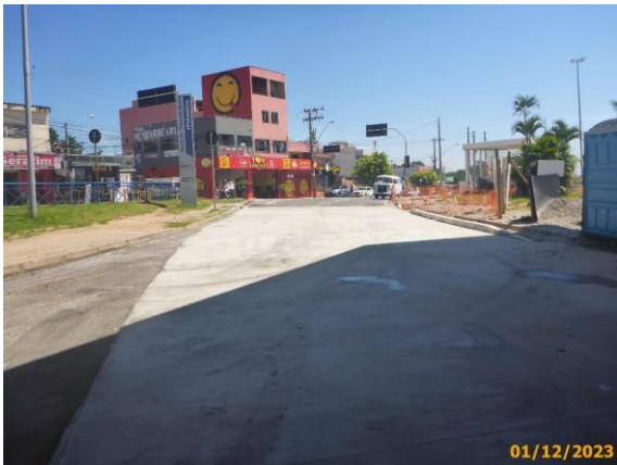
Foto 95 – Vista parcial do pavimento rígido da via da Linha Eixo BRT concluído.
