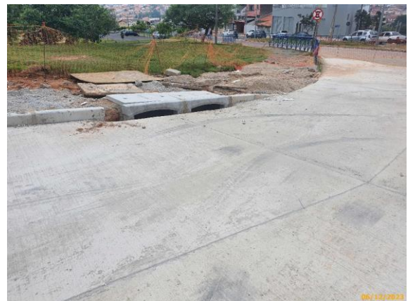
Foto 18 – Reconstrução da boca-de-lobo concluída na via Linha Eixo BRT.
