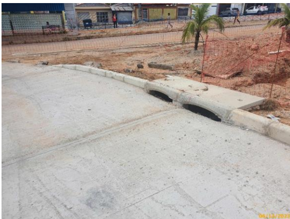
Foto 19 – Reconstrução da boca-de-lobo concluída na via Linha Eixo BRT.
