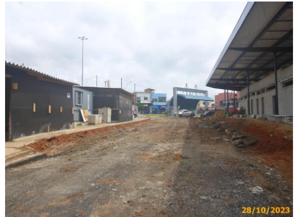
Foto 34 – Reconstrução da base do pavimento rígido da via das Linhas Alimentadoras.
