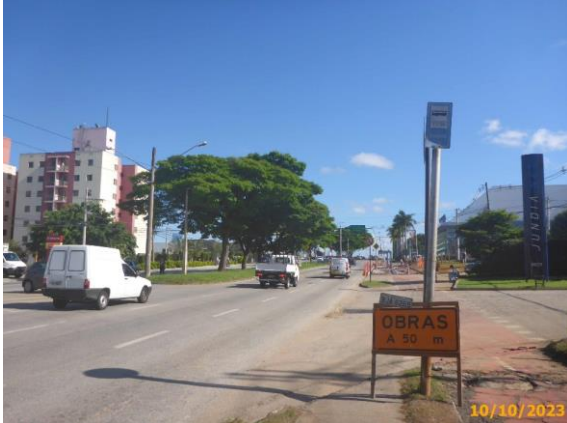
Foto 75 – Ponto de Parada provisório durante as obras do passeio.
