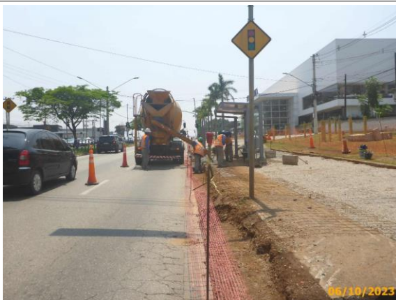
Foto 71 – Preparação da sarjeta.
