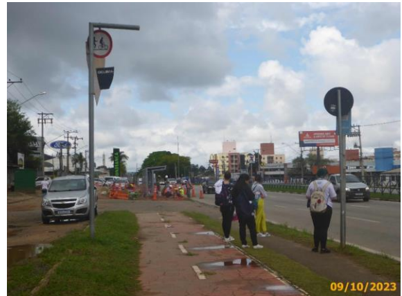
Foto 52 – Vista geral do PP (Ponto de Parada) provisório durante as obras.
