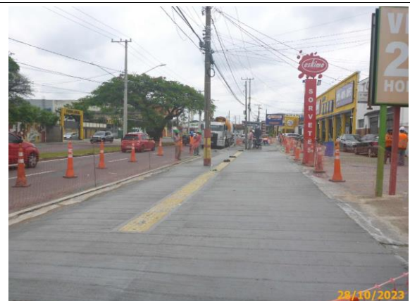
Foto 14 – Vista parcial do passeio concretado, em destaque, as ranhuras feitos com os fios de nylon no passeio.
