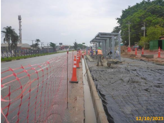
Foto 57 – Guias e sarjetas implantadas.
