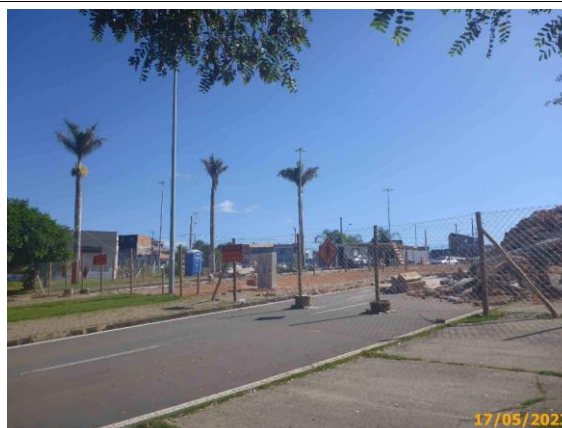
Foto 8 – Isolamento da área de intervenção das obras do BRT na face voltada à avenida Américo de Figueiredo.
