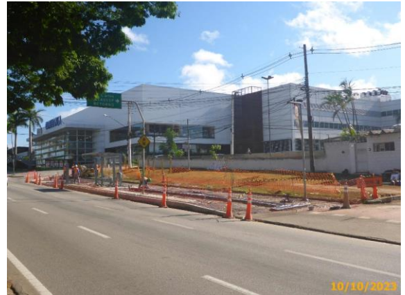
Foto 70 – Vista geral da intervenção das obras da reforma.
