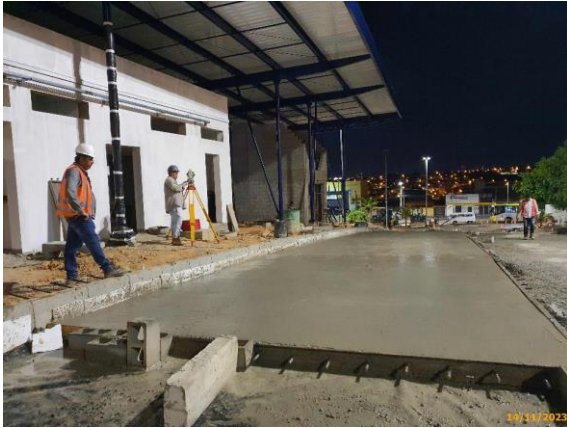
Foto 51 – Equipe de topografia conferindo as cotas de nível do pavimento rígido.
