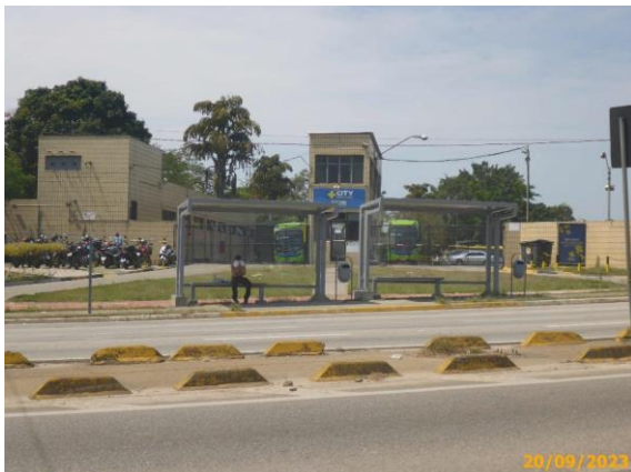
Foto 83 – Vista geral do Ponto de Parada com os equipamentos urbanos novos.
