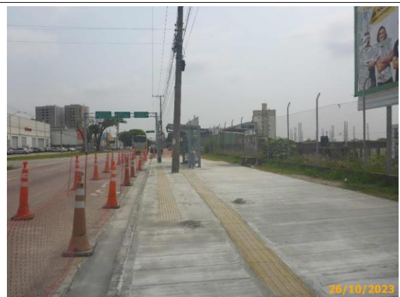
Foto 32 – Vista parcial do passeio após a concretagem.
