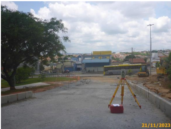
Foto 23 – Marcação topográfica da geometria da via da Linha Eixo BRT.
