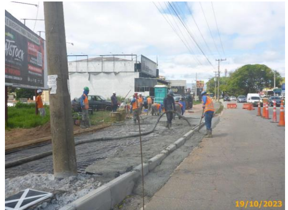
Foto 42 – Concretagem do passeio e da sarjeta em andamento.
