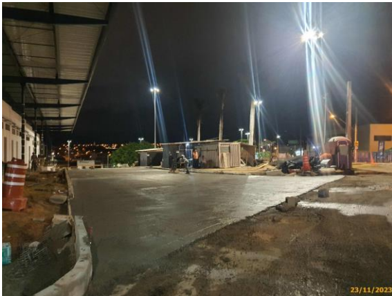
Foto 53 – Pavimento rígido concluída da via das Linhas Alimentadoras
