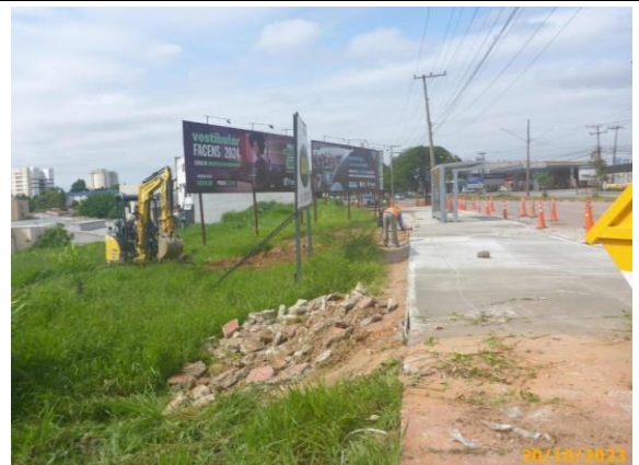
Foto 44 – Limpeza das áreas intervindas pelas obras.
