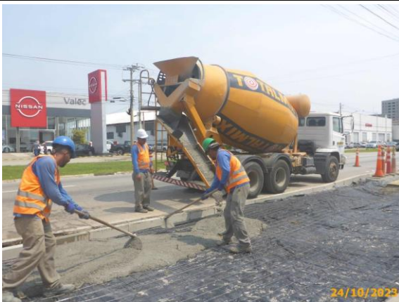
Foto 29 – Início da concretagem do passeio.
