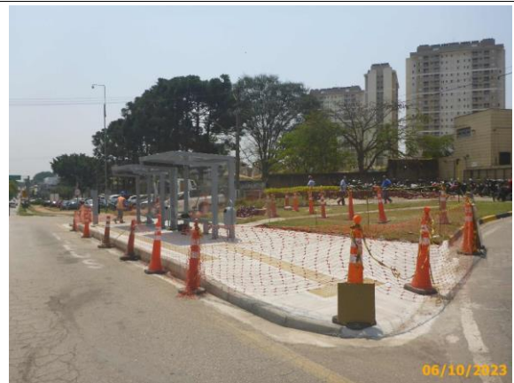
Foto 90 – Vista do passeio após a concretagem.
