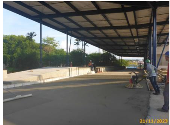
Foto 68 – Acabamento (bambolê) na via da Linha Eixo BRT.
