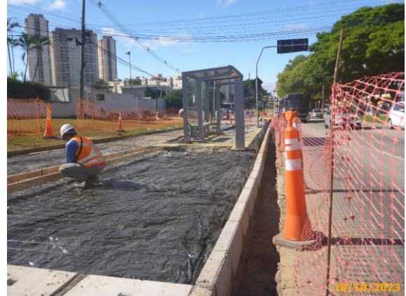
Foto 76 – Guias e sarjetas concluídas. Em destaque, a guia elevada com 28 cm de altura.
