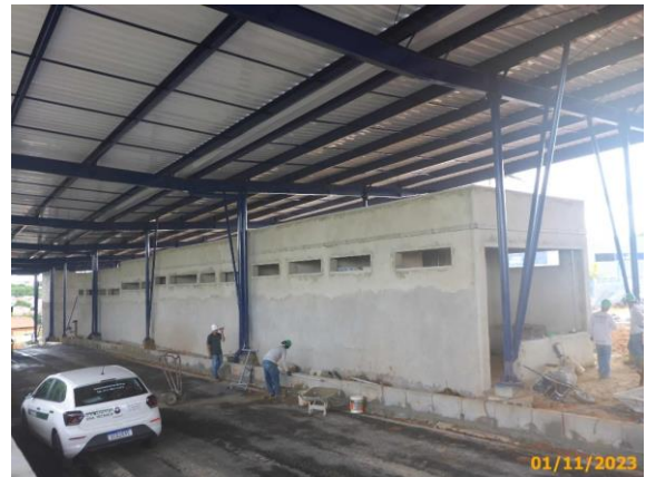
Foto 24 – Novas guias de concreto sendo assentadas na via da Linha Eixo BRT.
