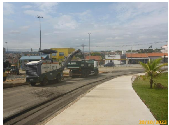
Foto 60 – Segue foto anterior. Base favorável à aplicação do CCP
