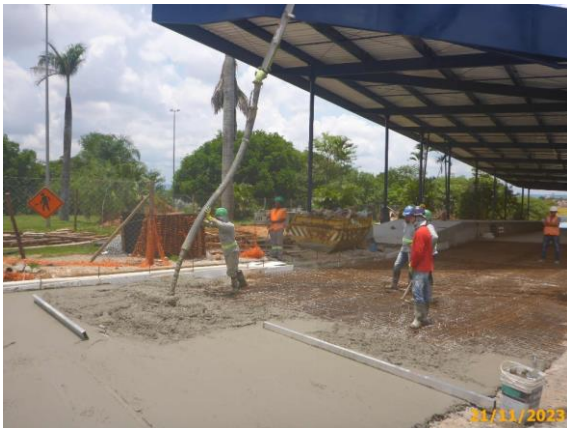
Foto 67 – CCP em execução na via da Linha Eixo BRT.
