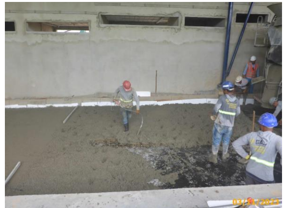
Foto 72 – Adensamento manual do concreto lançado.
