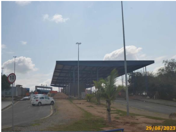
Foto 9 – Vista parcial do Terminal sendo, à direita, a Linha Eixo do BRT, e, à esquerda, a Linhas das Alimentadoras.
