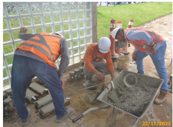
Foto 86 – Controle Tecnológico do concreto lançado na via das Linhas Alimentadoras.
