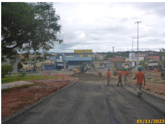
Foto 61 – Aplicação do CCP na via da Linha Eixo BRT.
