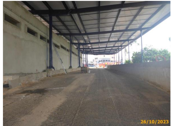
Foto 58 – Fresagem da via da Linha Eixo BRT concluída.
