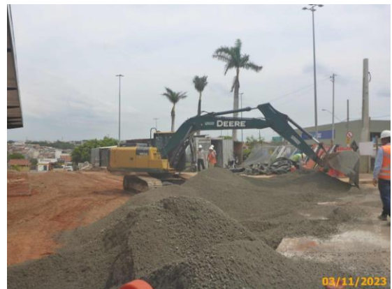
Foto 38 – Aplicação do BGS na via das Linhas Alimentadoras.
