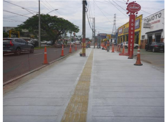
Foto 16 – Vista do ponto de parada com os equipamentos urbanos e o passeio reformado.
