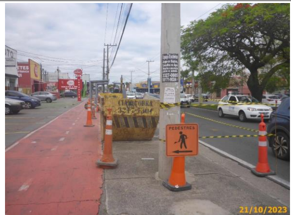
Foto 8 – Sinalização provisória de orientação aos pedestres.
