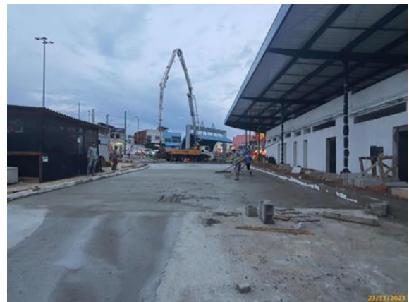
Foto 48 – Concreto sendo aplicado na via das Linhas Alimentadoras.
