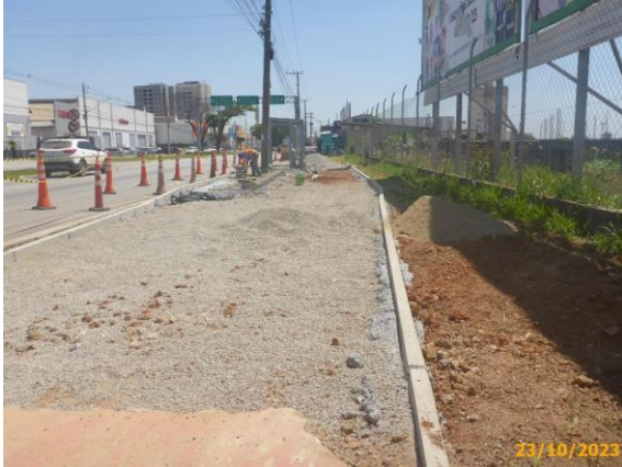
Foto 27 – Preparação do terreno em andamento.
