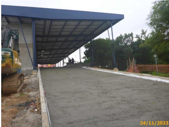
Foto 81 – Concretagem concluída na via da Linha Eixo BRT.
