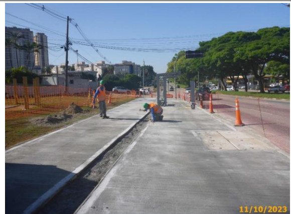
Foto 78 – Instalação dos ladrilhos táteis faltantes.
