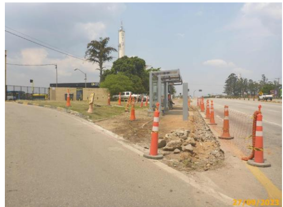
Foto 84 – Demolição e limpeza do Ponto de Parada.
