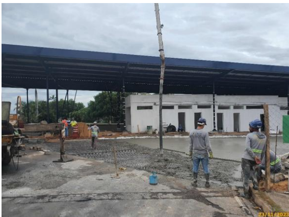
Foto 49 – Concreto sendo aplicado na via das Linhas Alimentadoras.
