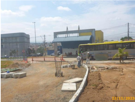
Foto 27 – Novas guias de concreto sendo assentadas na via da Linha Eixo BRT.
