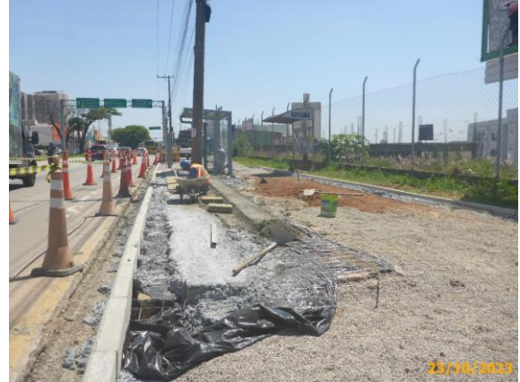
Foto 28 – Guias pré-moldadas implantadas, e em destaque, os ladrilhos táteis em instalação.
