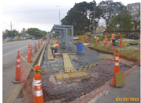
Foto 88 – Preparação para a concretagem concluída.
