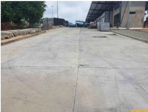
Foto 55 – Tratamento das juntas com tarucel e resina concluído na via das Linhas Alimentadoras.
