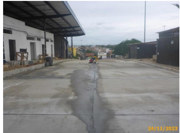
Foto 54 – Execução das juntas do pavimento rígido da via das linhas Alimentadoras.
