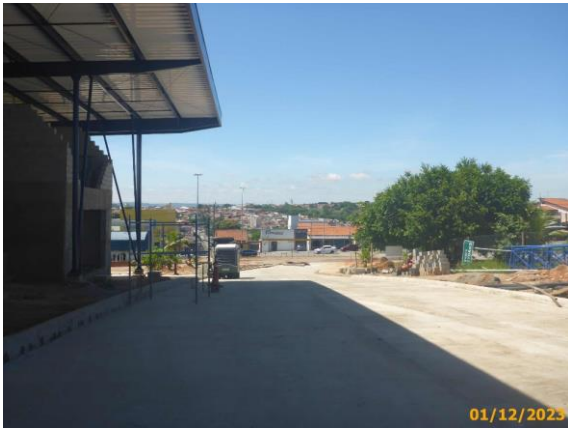
Foto 93 – Vista parcial do pavimento rígido concluído da via das Linhas Alimentadoras.
