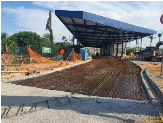
Foto 65 – Telas Q-283 e barras de transição instaladas para a concretagem da via da Linha Eixo BRT.
