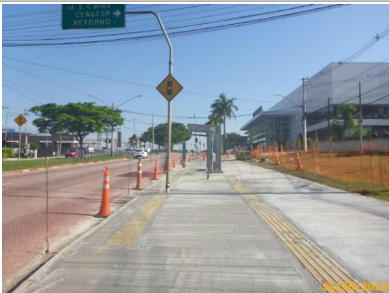
Foto 77 – Vista do passeio após a concretagem
