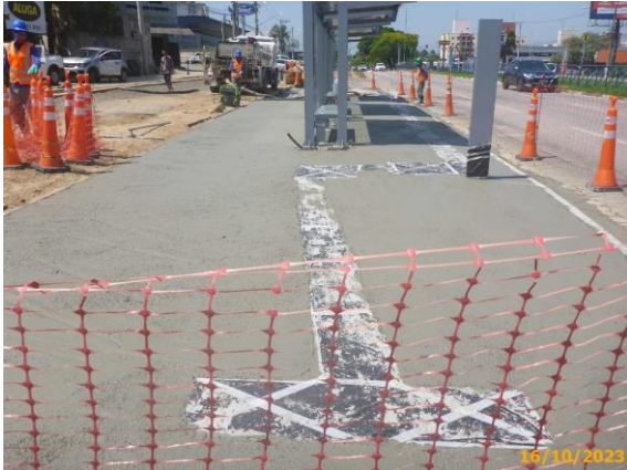
Foto 63 – Concretagem do passeio em andamento.
