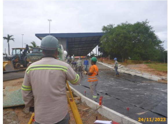
Foto 76 – Equipe de topografia conferindo e no apoio locacional das armaduras.
