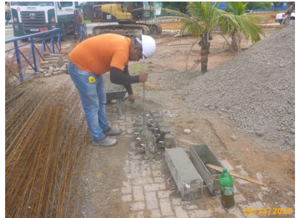
Foto 88 – Controle Tecnológico do concreto lançado na via da Linha Eixo BRT.
