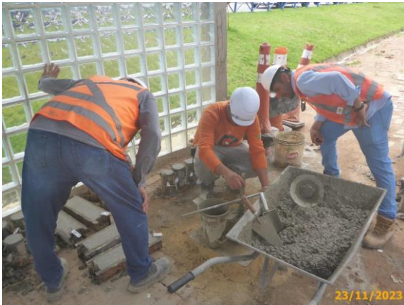
Foto 87 – Controle Tecnológico do concreto lançado na via das Linhas Alimentadoras.
