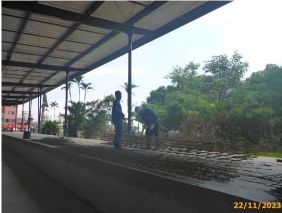
Foto 63 – Preparação das barras de transição e treliças de apoio.
