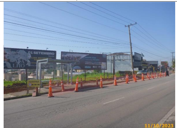
Foto 38 – Sinalização provisória, em destaque, a passagem de pedestres.
