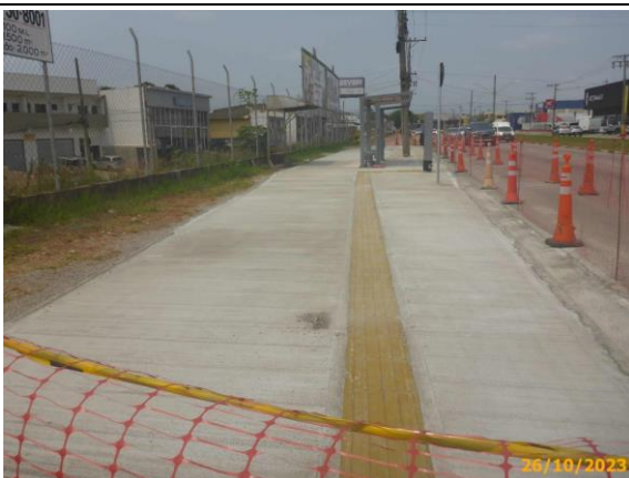
Foto 31 – Vista parcial do passeio após a concretagem.
