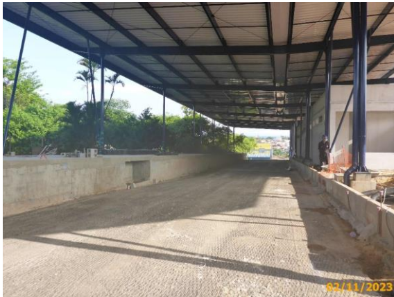
Foto 57 – Fresagem da via da Linha Eixo BRT concluída.
