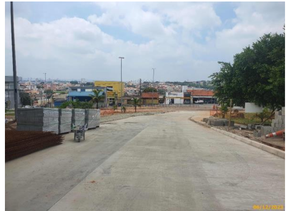
Foto 94 – Vista parcial do pavimento rígido concluído da via das Linhas Alimentadoras.
