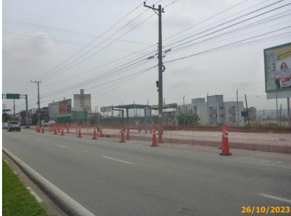
Foto 33 – Vista geral do passeio após a concretagem.
