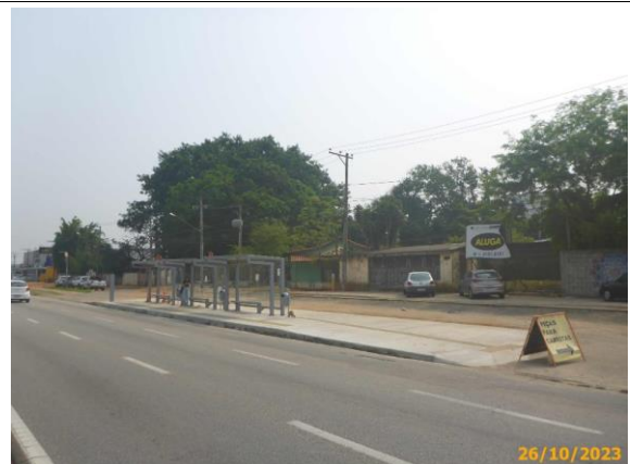
Foto 68 – Vista geral do Ponto de Parada concluído, em conformidade com o Anexo II do Contrato de Concessão.
