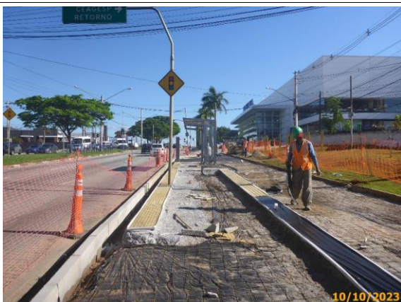
Foto 73 – Ladrilhos tátil implantados no passeio, em conformidade com a NBR 16537.
