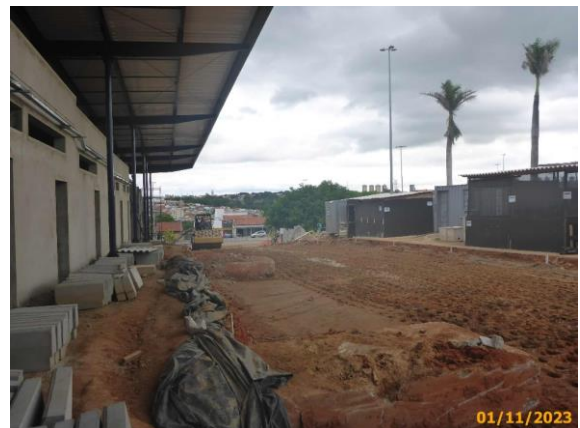
Foto 36 – Compactação da sub-base da via das Linhas Alimentadoras.
