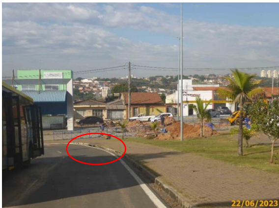
Foto 11 – Sistema de drenagem existente na Linha Eixo do BRT foi mantido.
