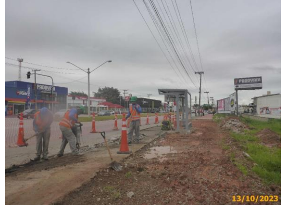
Foto 40 – Demolição da drenagem e do concreto existente.
