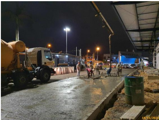
Foto 41 – Lançamento do concreto com fibras de polipropileno, e, o desempeno manual na via das Linhas Alimentadoras.
