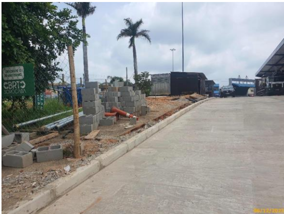
Foto 29 – Novas guias de concreto assentadas na via das Linhas Alimentadoras.
