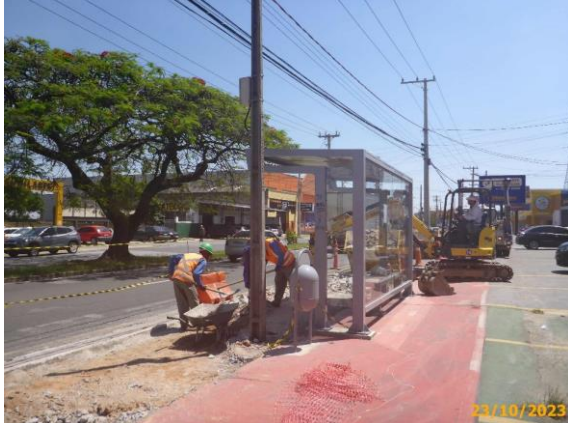
Foto 9 – Demolição e limpeza em andamento.
