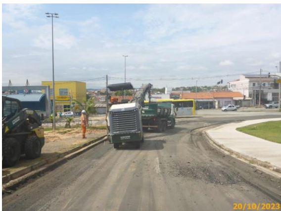
Foto 59 – Fresagem do pavimento flexível existente da via da Linha Eixo BRT.
