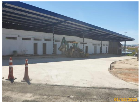
Foto 92 – Vista parcial do pavimento rígido concluído da via das Linhas Alimentadoras.
