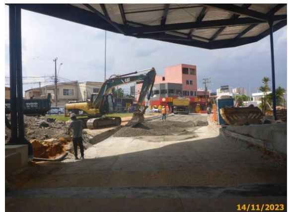
Foto 62 – Aplicação do CCP na via da Linha Eixo BRT.
