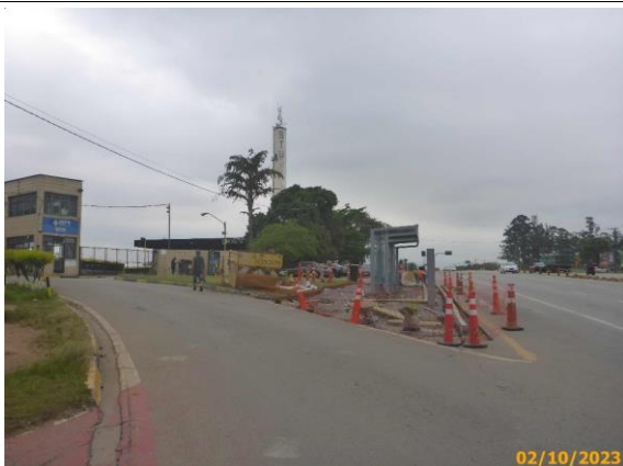
Foto 85 – Vista geral da intervenção das obras no passeio.
