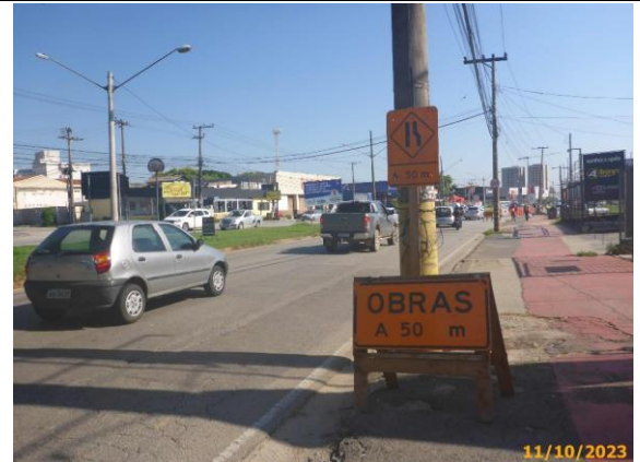
Foto 36 – Sinalização provisória das obras de reforma do passeio.
