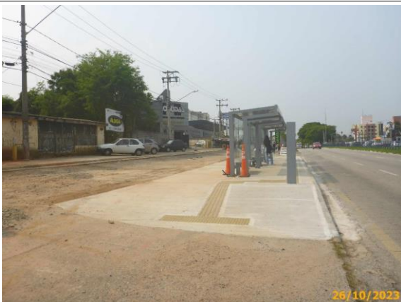
Foto 67 – Acessibilidade em conformidade com a NBR 9050 e 16537.
