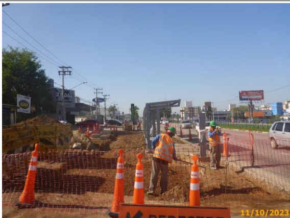
Foto 55 – Remoção do entulho e limpeza do terreno.
