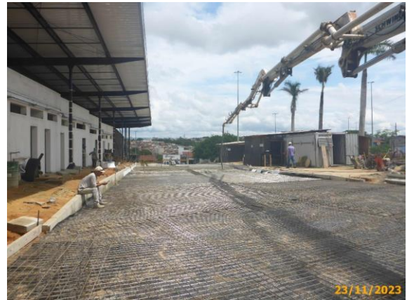
Foto 46 – Armação estrutural (tela Q-283) no trecho da via das Linhas Alimentadoras.
