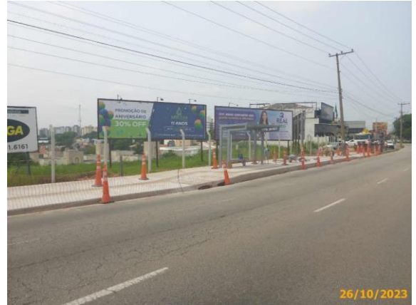
Foto 46 – Instalação dos ladrilhos táteis em andamento.
