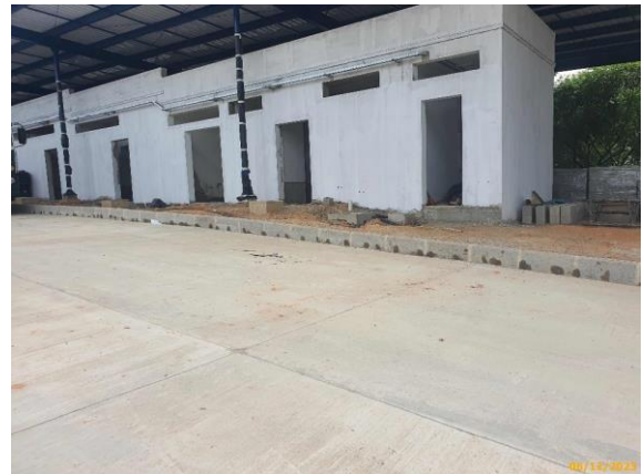
Foto 56 – Tratamento das juntas com tarucel e resina concluído na via das Linhas Alimentadoras.
