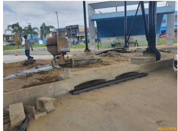
Foto 16 – Segue foto anterior. Em destaque, a grelha em ferro fundido em processo de instalação.
