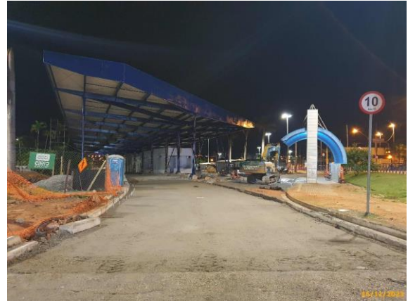
Foto 64 – CCR aplicado na via da Linha Eixo BRT.
