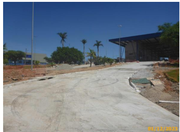
Foto 98 – Vista parcial do pavimento rígido da via da Linha Eixo BRT concluído.
