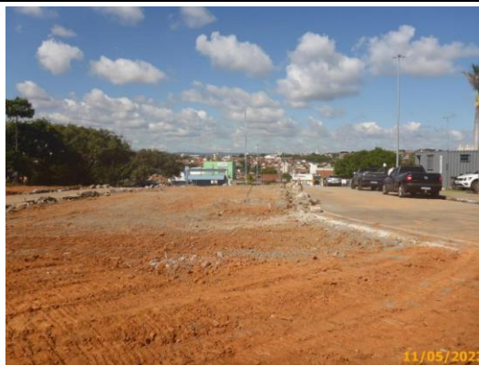
Foto 4 – Vista parcial da limpeza do terreno. Em destaque, a via das Linhas Alimentadoras.
