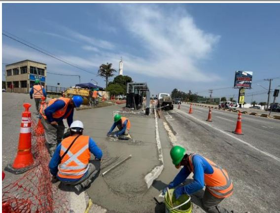
Foto 89 – Concretagem do passeio.
