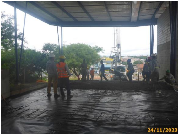
Foto 77 – CCP em execução na via da Linha Eixo BRT.
