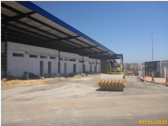
Foto 39 – Compactação do CCR aplicado na via das Linhas Alimentadoras.
