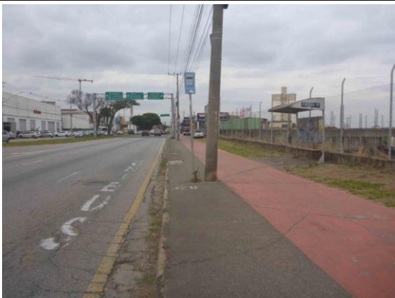
Foto 19 – Vista da parada de ônibus antes da intervenção das obras.
