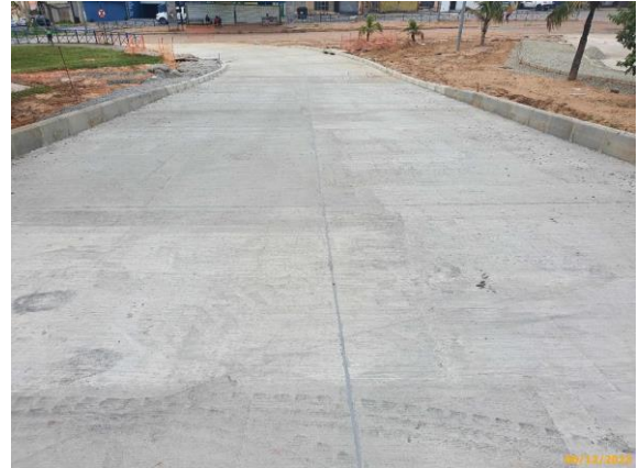
Foto 82 – Tratamento de juntas concluído na via da Linha Eixo BRT.
