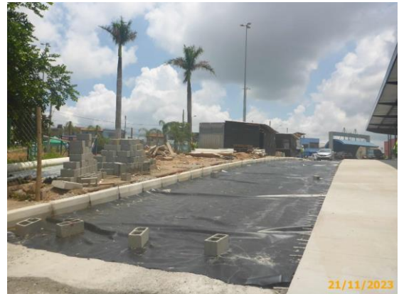
Foto 40 – Lona plástica aplicada na via das Linhas Alimentadoras.
