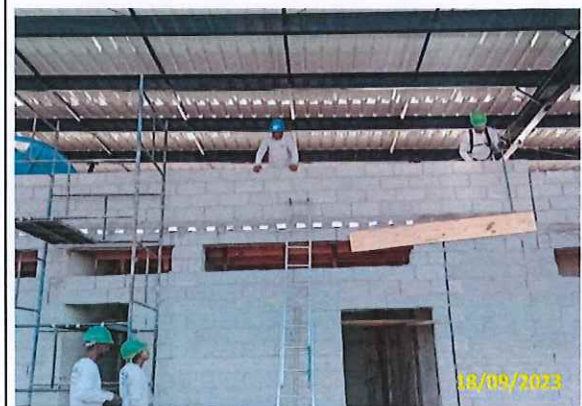
Foto 32 Retirada das fôrmas temporárias da laje
