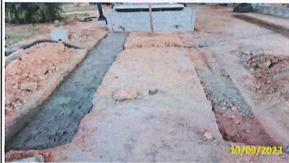
Foto 66 Escavação da base da rampa de acesso da plataforma BRT
