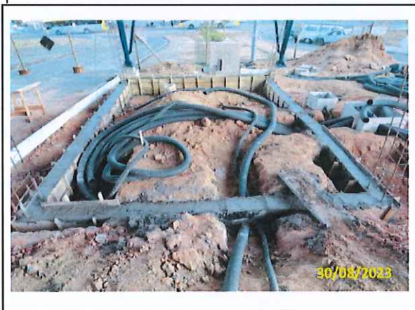
Foto 46 Concretagem da viga baldrame
