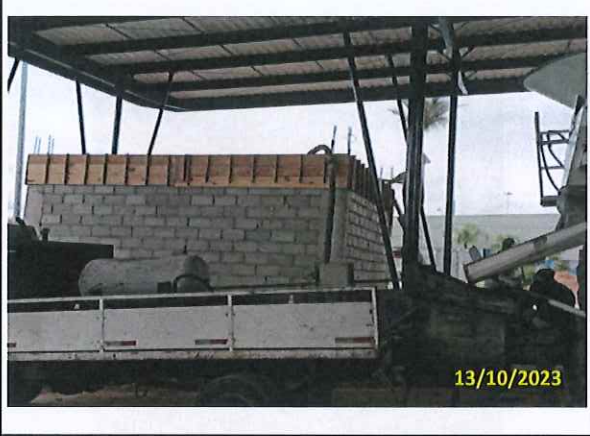
Foto 56 Início da concretagem da laje
