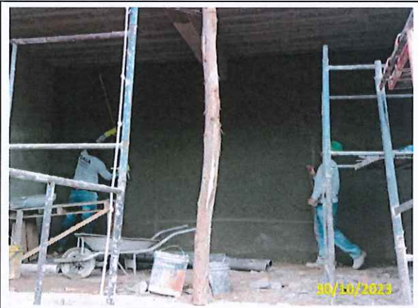
Foto 58 Reboco interno da casa do gerador
