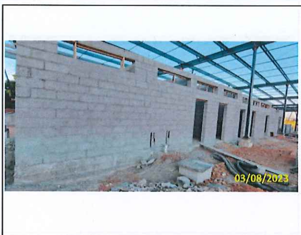
Foto 15 Alvenaria do edifício de apoio em andamento
