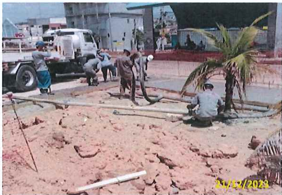
Foto 108 Concretagem do passeio
