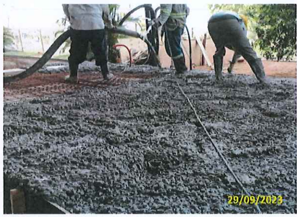
Foto 71 Concretagem da laje
