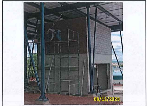
Foto 61 Reboco da segunda etapa
