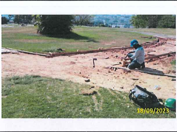
Foto 92 Readequação do passeio e ciclovia - Gabarito
