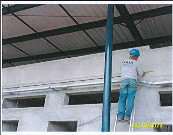
Foto 35 Instalação da moldura de EPS
