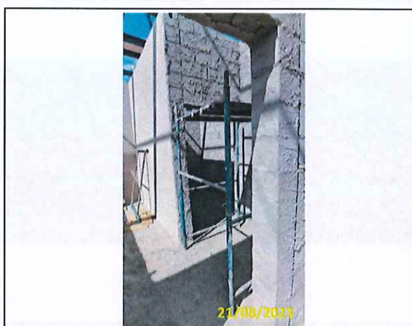
Foto 16 Chapisco do edifício de apoio em andamento
