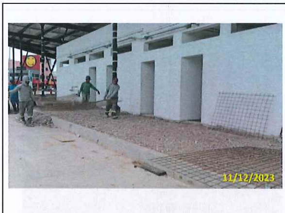
Foto 103 Aplicação de tela metálica do piso polido
