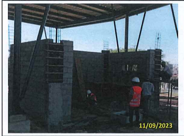
Foto 49 Montagem das fôrmas temporárias das vigas
