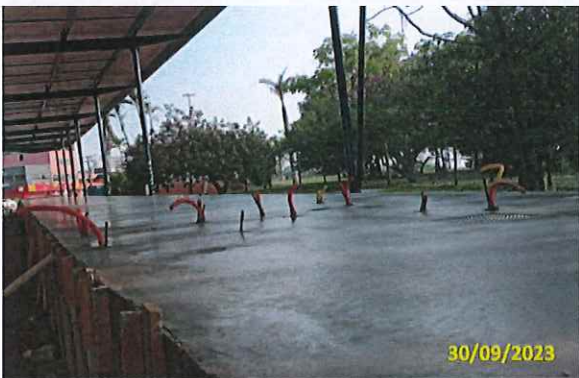
Foto 73 Concretagem da plataforma BRT finalizada
