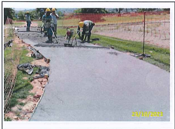
Foto 97 Concretagem do passeio em andamento
