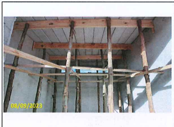
Foto 28 Escoramento da laje
