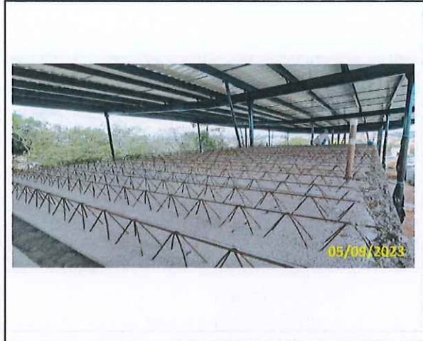
Foto 26 Instalação dos painéis da laje
