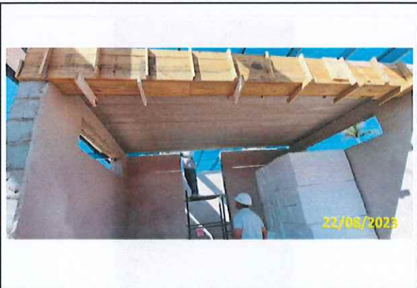
Foto 17 Instalação dos painéis referente à laje
