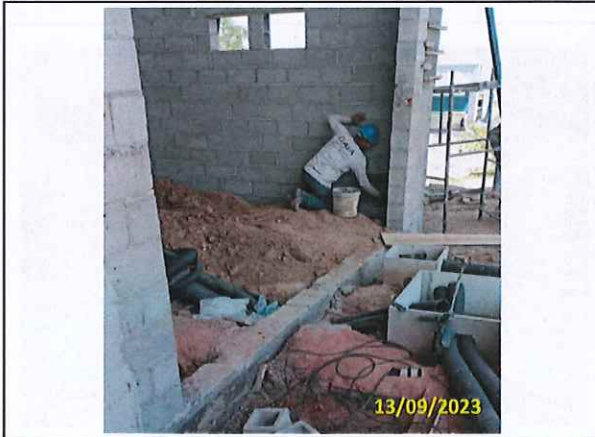
Foto 50 Impermeabilização e aterro
