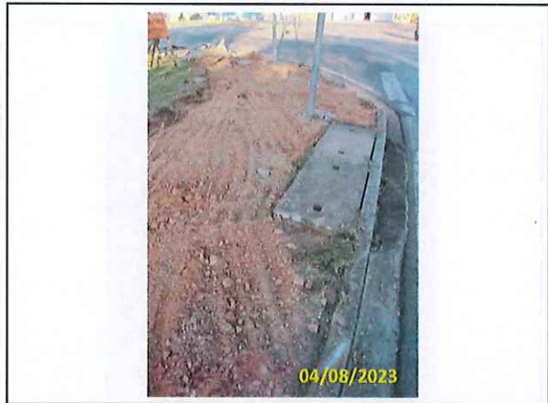
Foto 85 Limpeza do material demolido
