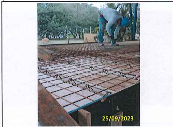
Foto 69 Manutenção e reforço da laje
