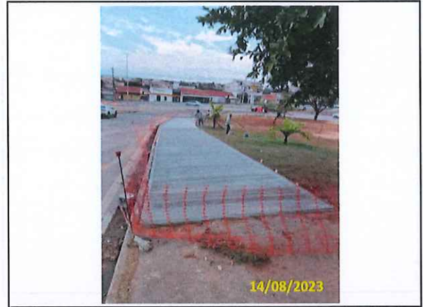
Foto 89 Acabamento do passeio em andamento
