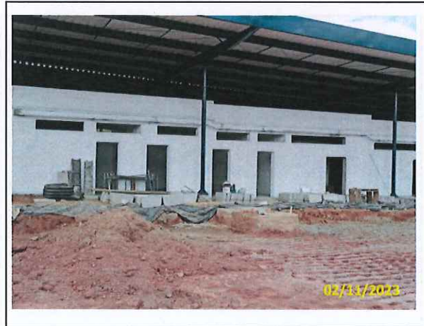
Foto 36 Pintura do edifício de apoio
