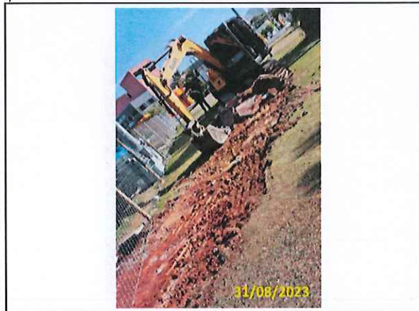
Foto 90 Demolição da ciclovia
