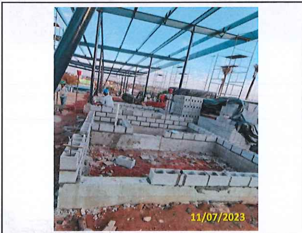
Foto 03 Alvenaria do edifício de apoio em andamento
