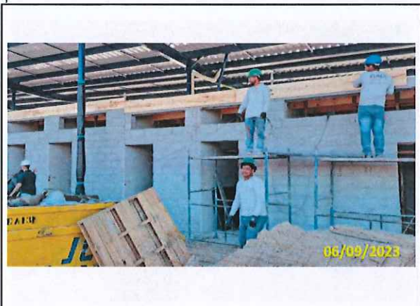
Foto 27 Montagem das fôrmas temporárias da laje
