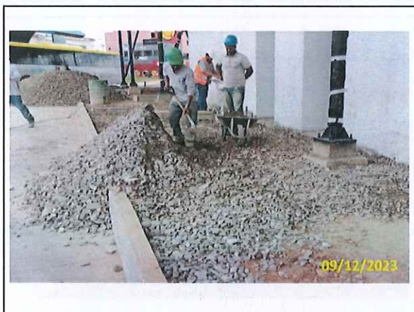
Foto 101 Espalhamento de lastro no piso da plataforma Padron
