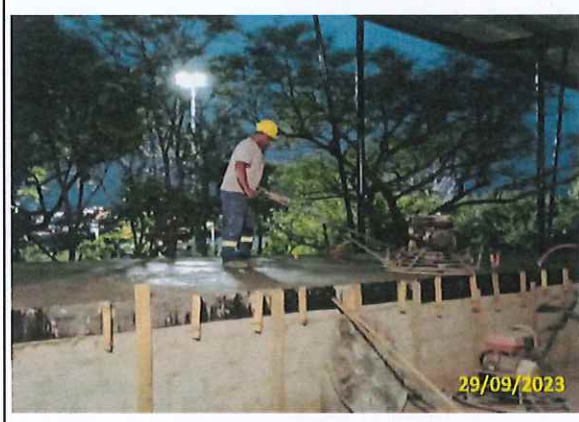
Foto 72 Polimento do concreto na plataforma BRT
