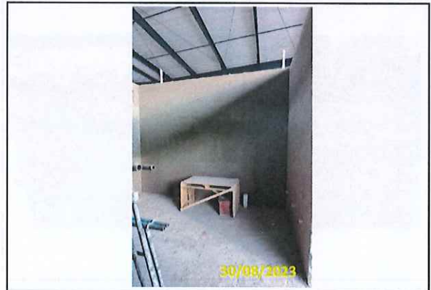
Foto 22 Reboco da parede interna
