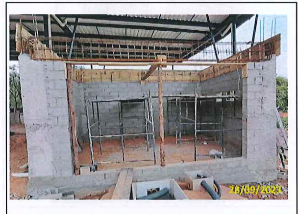
Foto 55 Montagem das fôrmas temporárias das vigas
