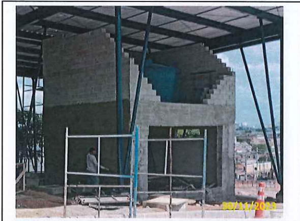
Foto 59 Reboco externo da casa do gerador
