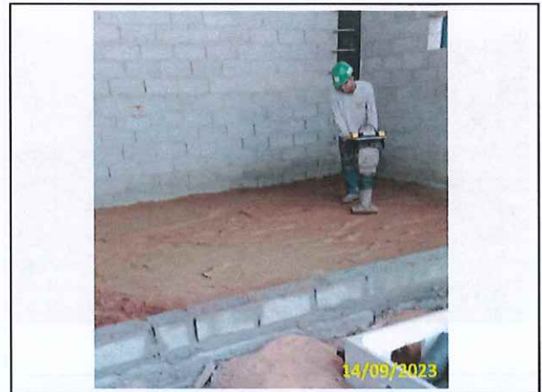
Foto 53 Compactação do solo na casa do gerador
