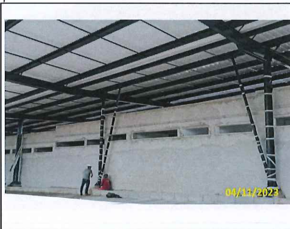
Foto 39 Preparo para pintura do edifício (lado traseiro)
