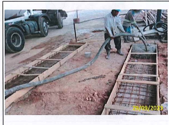
Foto 70 Concretagem da base da rampa de acesso
