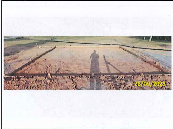
Foto 95 Escavação e marcação do gabarito (Futuro bicicletário)
