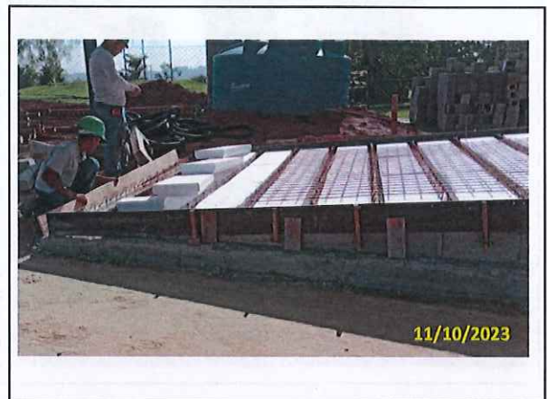
Foto 76 Montagem das fôrmas temporárias da rampa
