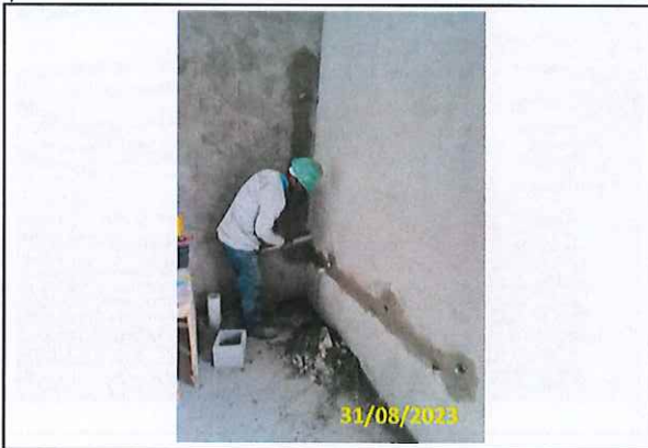
Foto 23 Acabamento da instalação do registro de água
