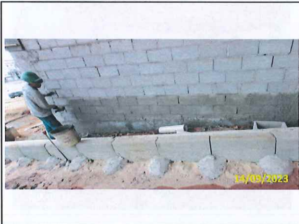
Foto 52 Aplicação de impermeabilizante na base externa
