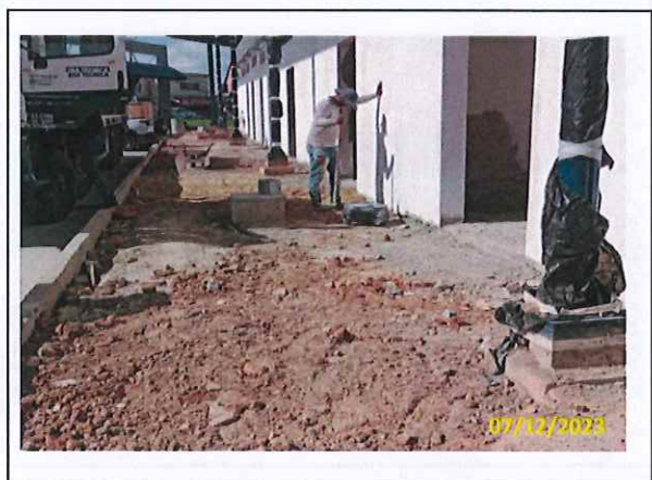
Foto 99 Regularização da base do piso polido
