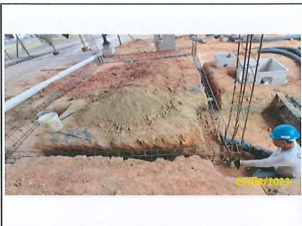
Foto 44 Montagem da armadura da viga baldrame
