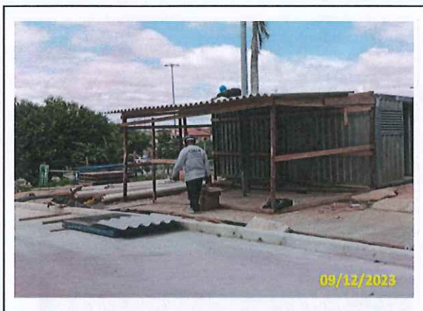
Foto 100 Desmobilização do canteiro para preparo da calçada
