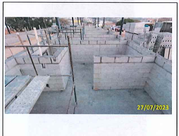
Foto 08 Enchimento das canaletas (continuação)
