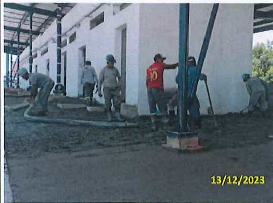
Foto 106 Concretagem do piso polido da plataforma Padron
