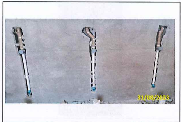
Foto 24 Instalação das válvulas de descarga
