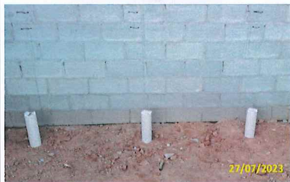
Foto 10 Instalação de tubulação de esgoto (Banheiro público masculino)
