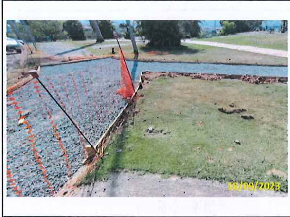
Foto 93 Readequação do passeio e ciclovia - Aplicação de lastro
