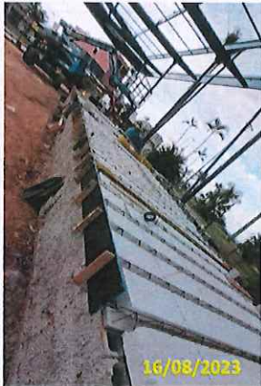
Foto 65 Montagem das fôrmas temporárias
