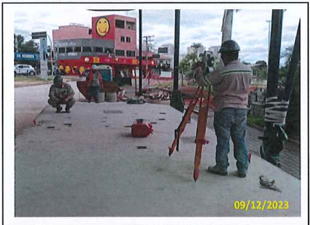
Foto 79 Marcação para instalação das catracas
