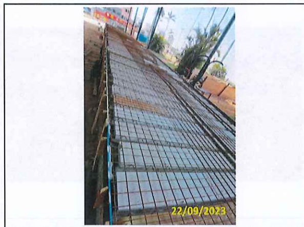
Foto 68 Instalação de tela metálica
