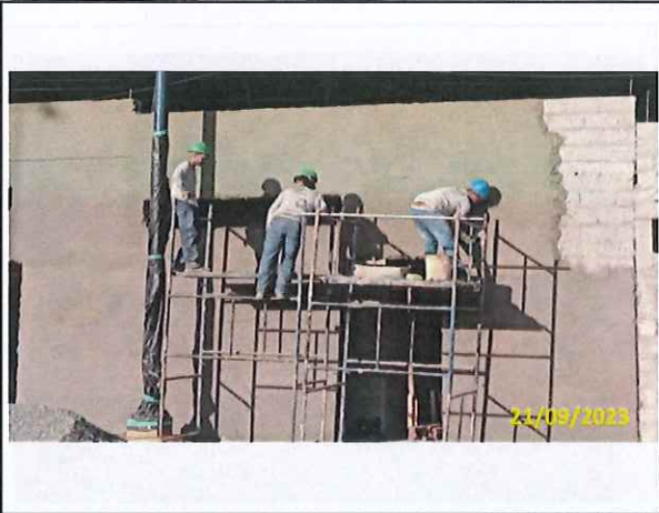
Foto 33 Reboco externo em andamento
