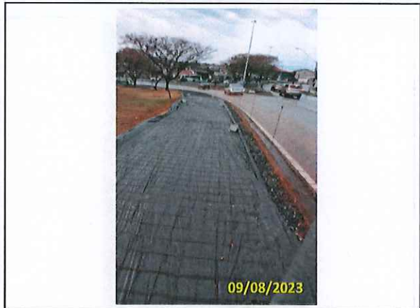
Foto 87 Aplicação de lona e tela metálica
