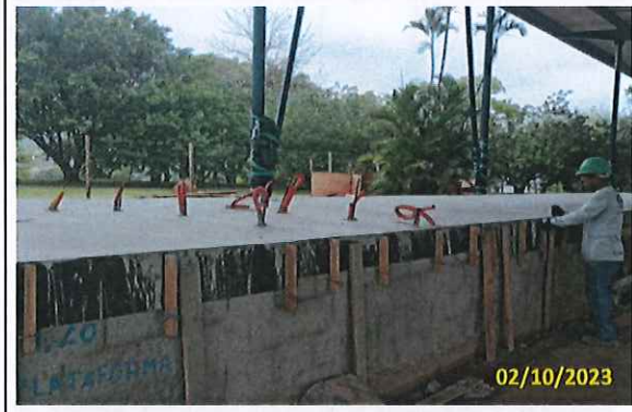
Foto 74 Remoção das fôrmas temporárias
