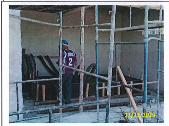
Foto 62 Montagem da fôrma da base do gerador
