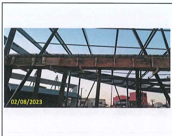
Foto 14 Concretagem da viga da bilheteria
