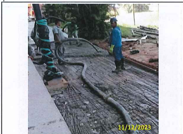
Foto 102 Concretagem do passeio ao lado da plataforma BRT
