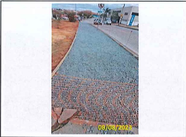
Foto 86 Aplicação de lastro
