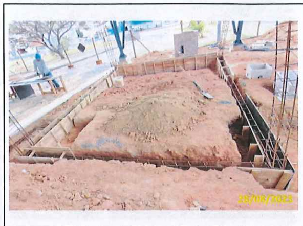
Foto 45 Montagem das fôrmas temporárias da viga baldrame
