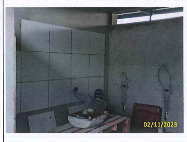
Foto 38 Revestimento nas paredes dos sanitários
