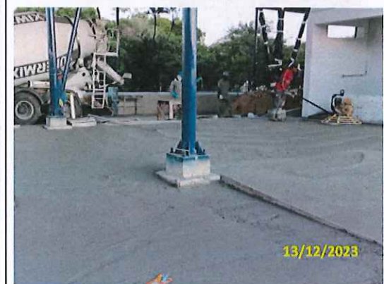
Foto 107 Acabamento do piso polido em andamento
