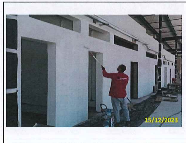
Foto 40 Pintura do edifício de apoio
