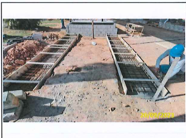
Foto 67 Montagem das fôrmas temporárias na base da rampa de acesso
