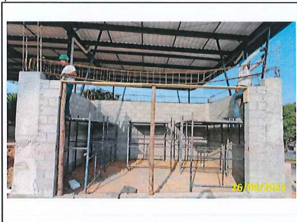
Foto 54 Instalação das ferragens da viga
