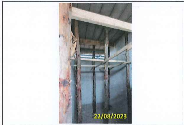
Foto 18 Escoramento da laje na sala da Urbes
