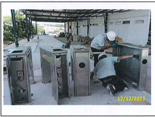
Foto 82 Instalação das catracas
