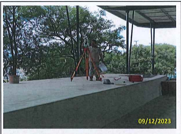
Foto 80 Marcação para instalação do piso podotátil
