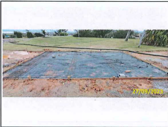
Foto 96 Aplicação de lona e tela metálica (Futuro bicicletário)
