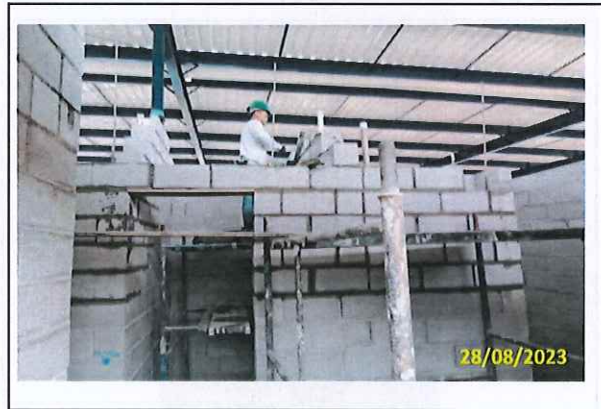
Foto 20 Alvenaria em andamento (Refeitório, sala ITS e vestiário)
