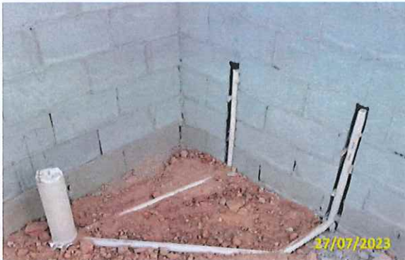
Foto 09 Instalação de tubulação da pia (Banheiro público masculino)
