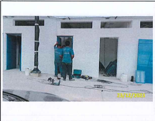
Foto 43 Instalação das esquadrias
