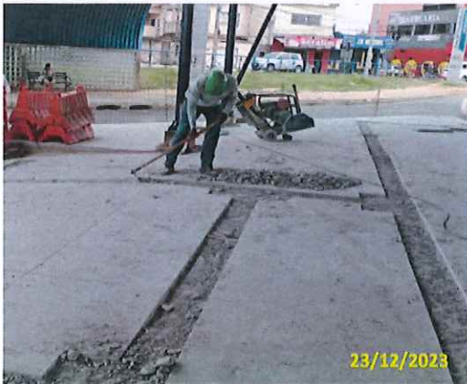
Foto 110 Limpeza da demolição realizada
