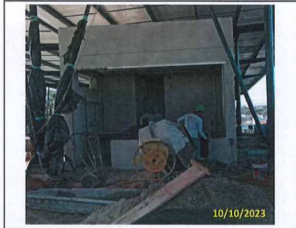
Foto 34 Execução do requadro
