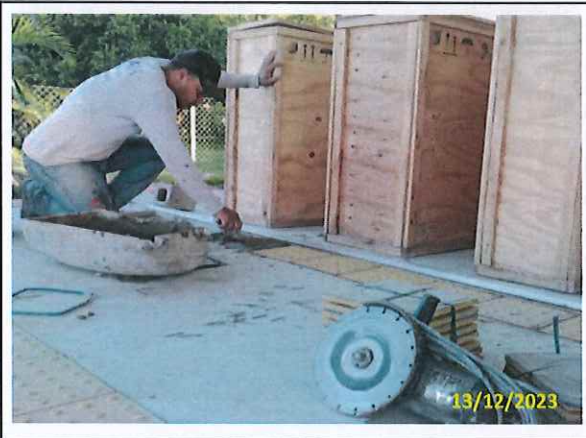
Foto 83 Instalação de piso podotátil
