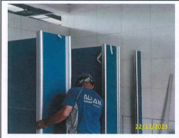
Foto 41 Instalação das divisórias dos sanitários
