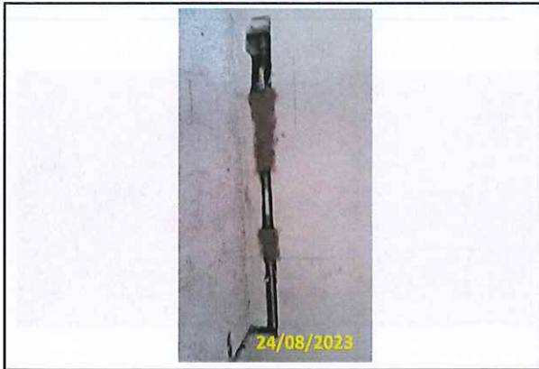
Foto 19 Instalação do registro de água no banheiro público feminino
