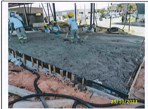
Foto 77 Concretagem da rampa
