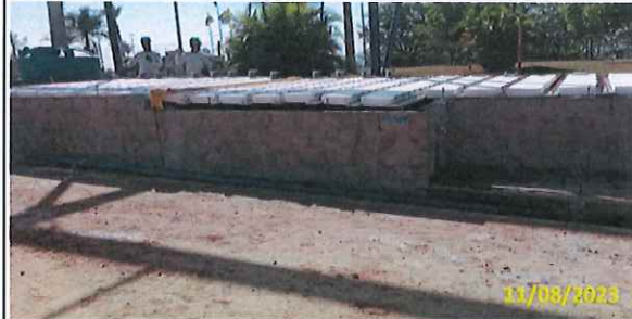
Foto 64 Instalação das placas de isopor
