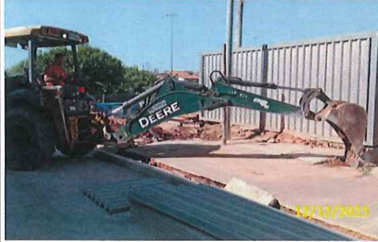
Foto 104 Demolição do passeio existente
