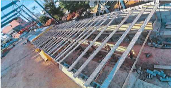
Foto 63 Montagem de escoras e treliças para laje
