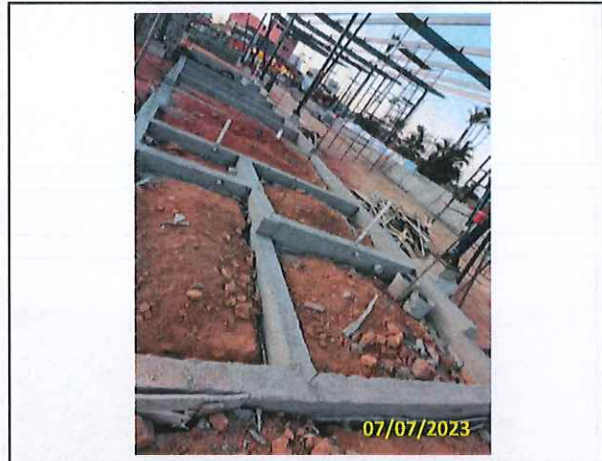
Foto 02 Retirada das fôrmas temporárias
