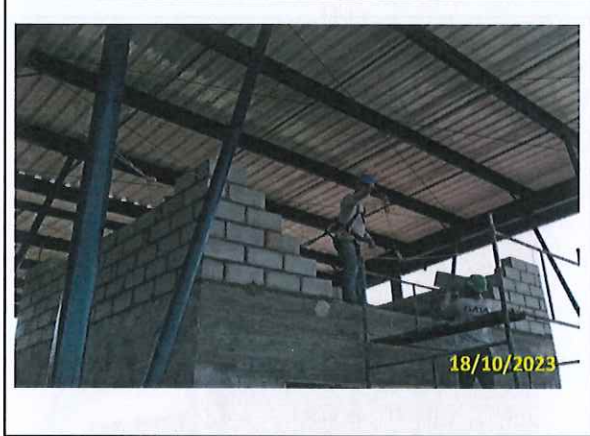
Foto 57 Alvenaria da caixa d'água
