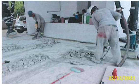
Foto 109 Demolição para instalação de piso podotátil (Plat. Padron)
