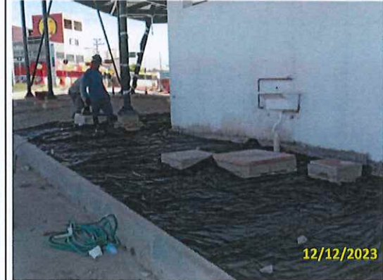
Foto 105 Preparo para concretagem do piso polido da plataforma Padron
