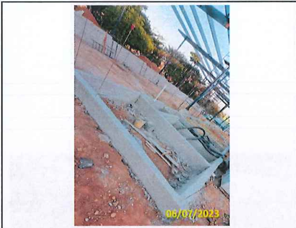
Foto 01 Impermeabilização da viga baldrame
