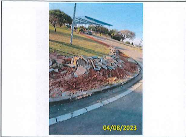
Foto 84 Demolição do passeio existente
