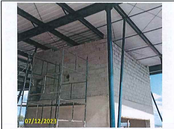
Foto 60 Finalização da alvenaria da caixa d'água
