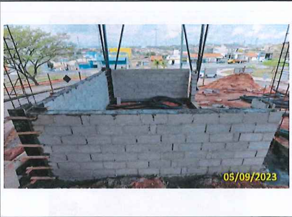
Foto 48 Concretagem das canaletas
