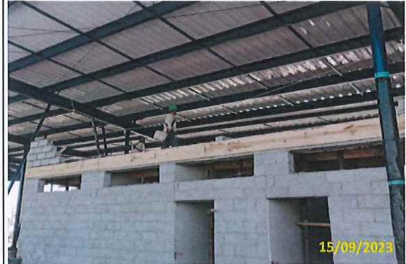
Foto 30 Alvenaria da platibanda
