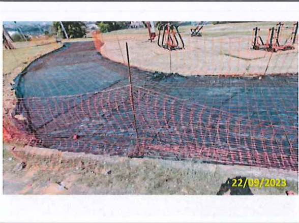
Foto 94 Readequação do passeio e ciclovia - Aplicação de lona e tela
