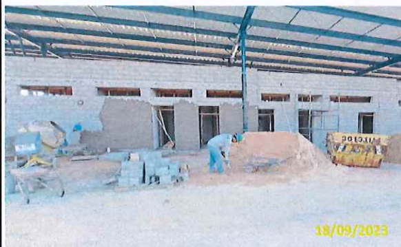
Foto 31 Início do reboco externo
