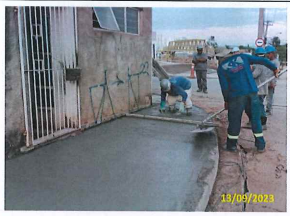
Foto 34 Concretagem do passeio
