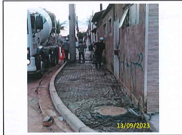
Foto 33 Instalação de lona e tela metálica
