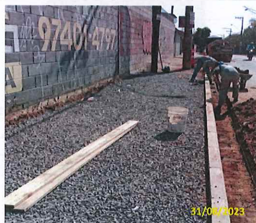
Foto 08 Nivelamento da sarjeta
