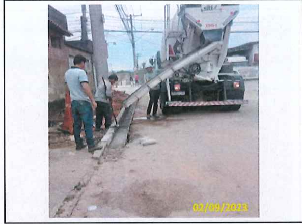
Foto 31 Concretagem da sarjeta
