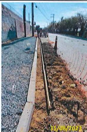
Foto 07 Montagem das fôrmas temporárias da sarjeta
