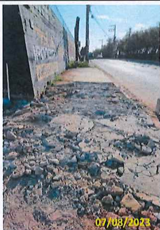
Foto 01 Demolição do passeio existente
