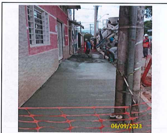
Foto 22 Concretagem do passeio
