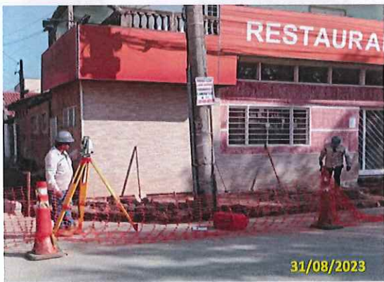
Foto 17 Marcação para nivelamento do passeio
