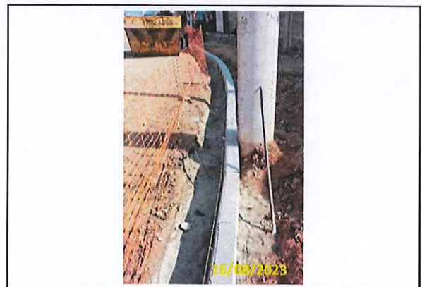
Foto 14 Assentamento de guias
