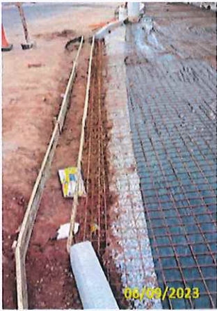
Foto 23 Montagem das fôrmas temporárias da sarjeta (2ª etapa)
