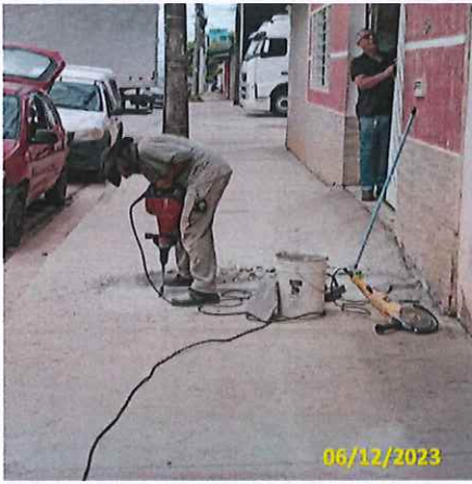
Foto 25 Corte para instalação do piso podotátil
