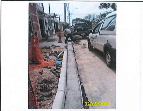
Foto 19 Concretagem da sarjeta
