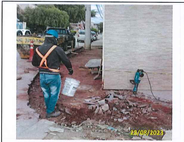
Foto 26 Demolição do passeio existente
