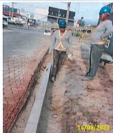
Foto 04 Assentamento de guias
