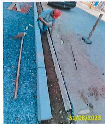
Foto 18 Montagem das fôrmas temporárias da sarjeta
