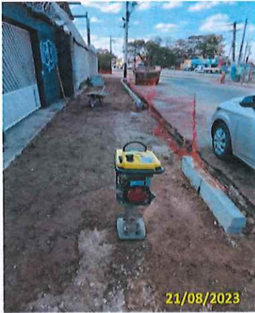
Foto 15 Compactação do aterro
