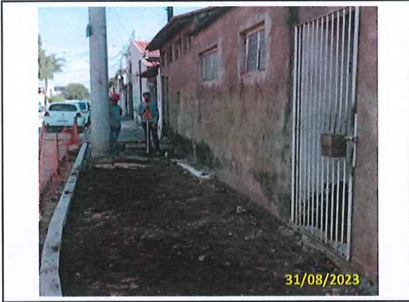
Foto 30 Nivelamento do passeio
