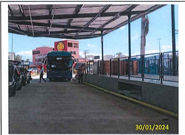
Foto 25 Instalação do bate rodas
