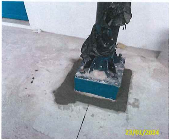
Foto 21 Arremate do pilar
