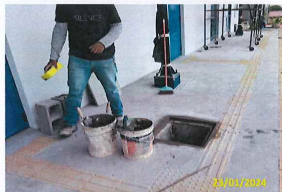
Foto 20 Arremate da caixa de passagem
