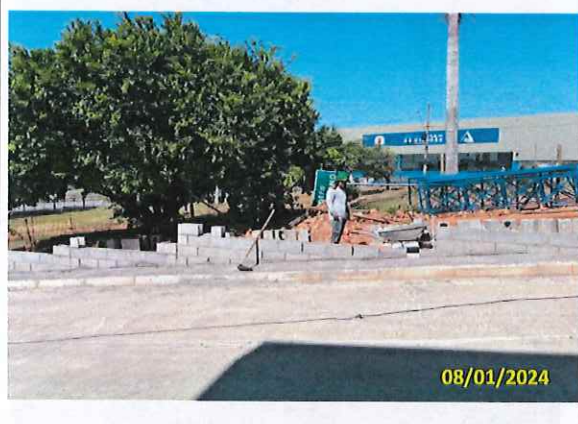
Foto 07 Execução da mureta em andamento
