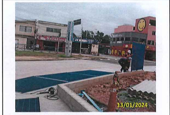
Foto 10 Início da instalação do gradil (H=2m)
