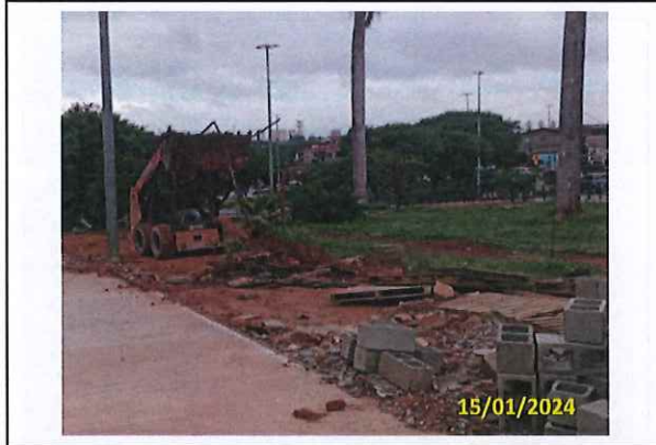
Foto 11 Início da limpeza para execução do paisagismo
