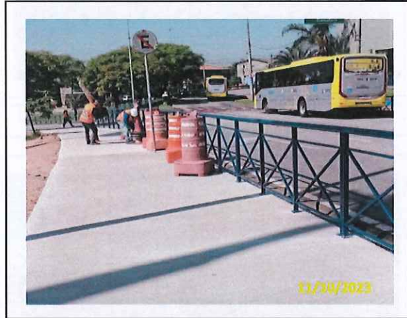
Foto 02 Instalação do gradil em andamento
