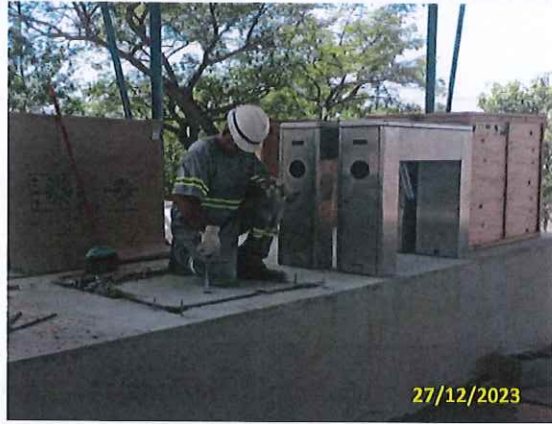
Foto 05 Recorte e instalação de conduites para catracas
