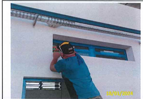
Foto 14 Limpeza da edificação em andamento
