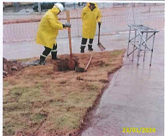
Foto 22 Base para instalação do totem de comunicação visual
