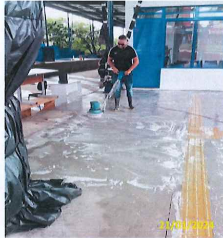
Foto 18 Limpeza pós obra
