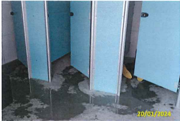
Foto 17 Limpeza da edificação
