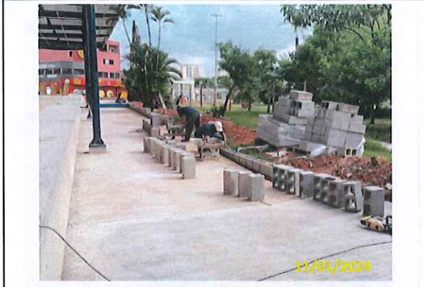
Foto 09 Execução da mureta (Lado da Plataforma BRT)
