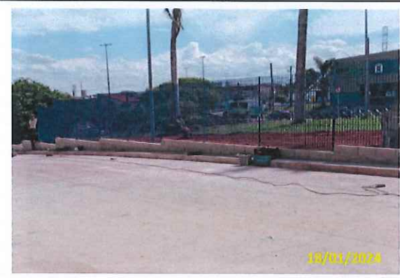
Foto 13 Instalação do gradil em andamento
