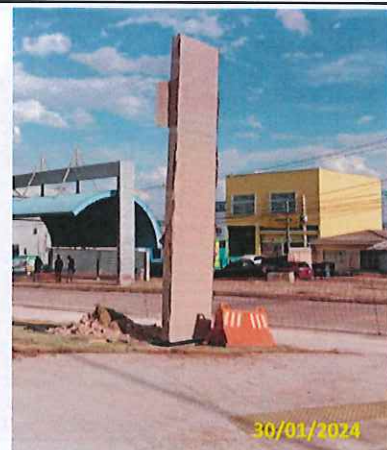
Foto 24 Instalação do totem de comunicação visual
