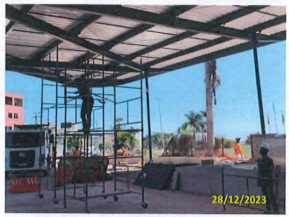
Foto 06 Instalação de perfilados da infra elétrica
