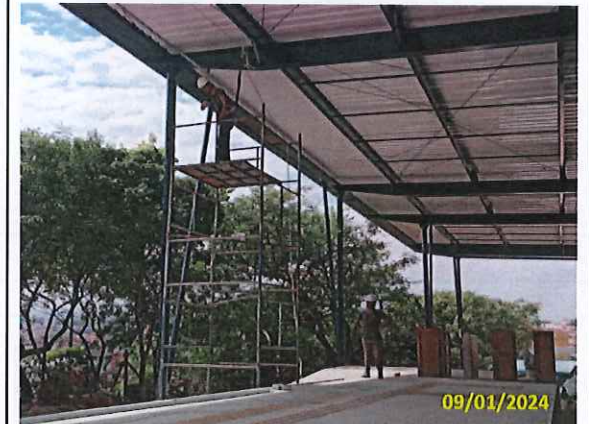
Foto 08 Instalação de infra elétrica
