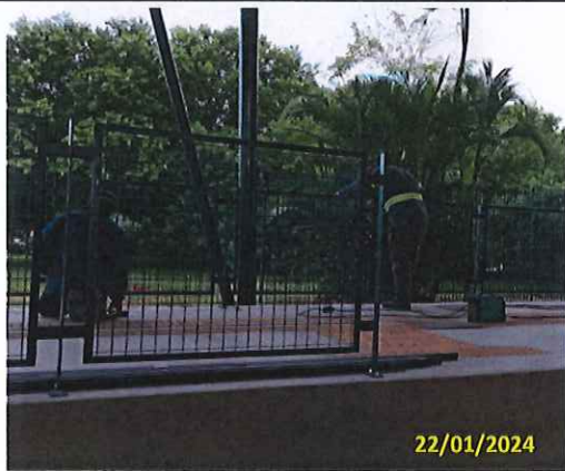
Foto 19 Instalação de gradil na Plataforma BRT
