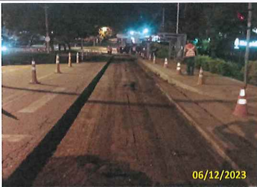
Foto 43 Fresagem realizada
