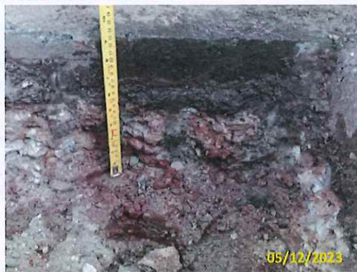
Foto 07 Sondagem do pavimento existente
