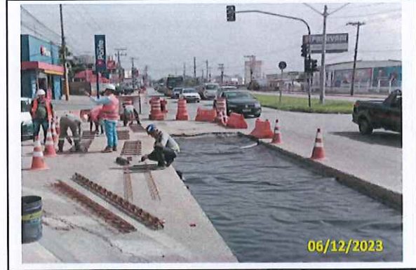
Foto 28 Aplicação de lona e montagem das barras de transferência
