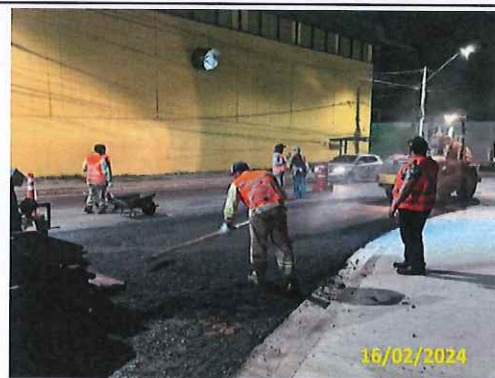
Foto 64 Aplicação da massa asfáltica em andamento
