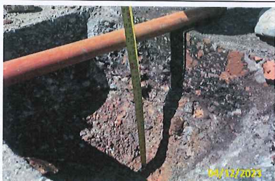
Foto 31 Sondagem do pavimento existente
