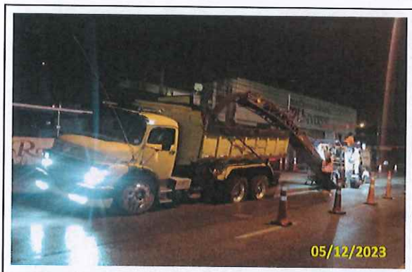
Foto 24 Fresagem em andamento
