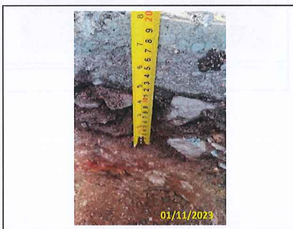
Foto 01 Sondagem do pavimento existente
