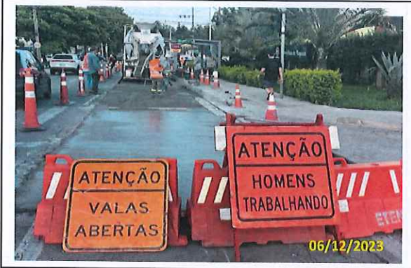
Foto 45 Aplicação do CCP em andamento
