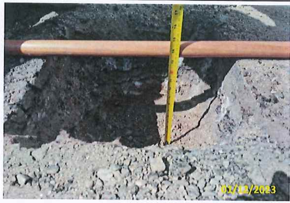
Foto 17 Sondagem do pavimento existente
