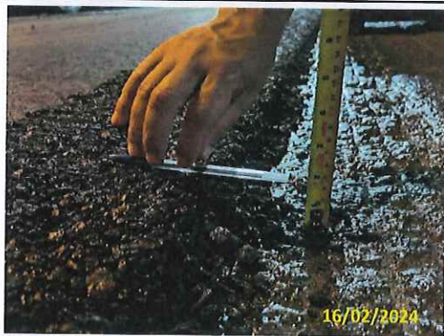
Foto 59 Controle da altura aplicada
