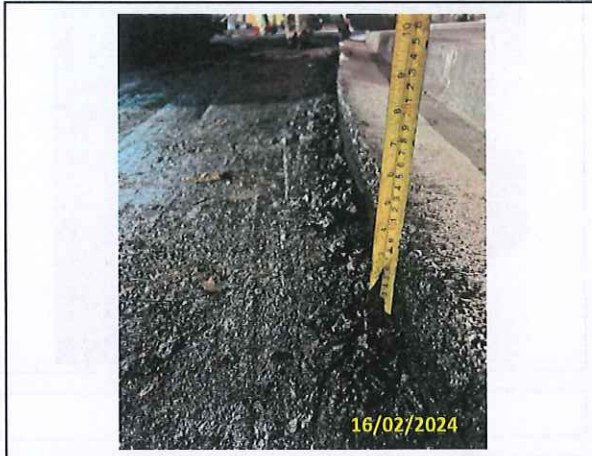
Foto 65 Controle da altura aplicada
