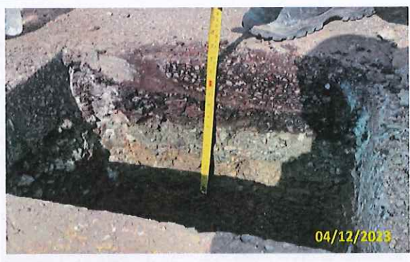
Foto 47 Sondagem do pavimento existente
