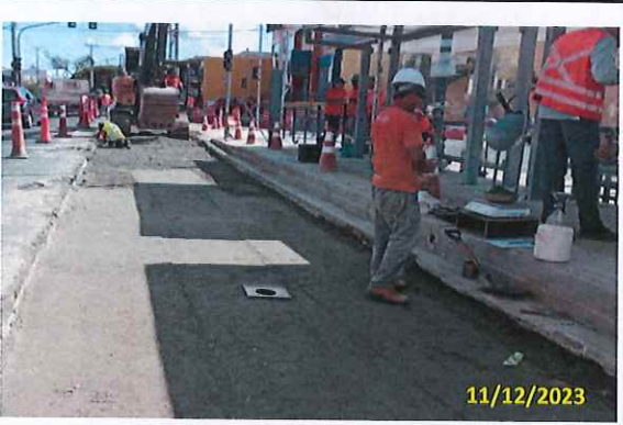
Foto 13 Ensaio de compactação do BGS
