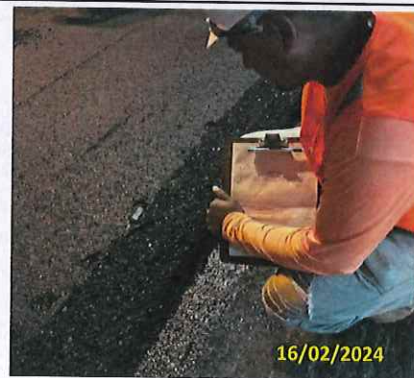
Foto 60 Controle de temperatura da massa asfáltica
