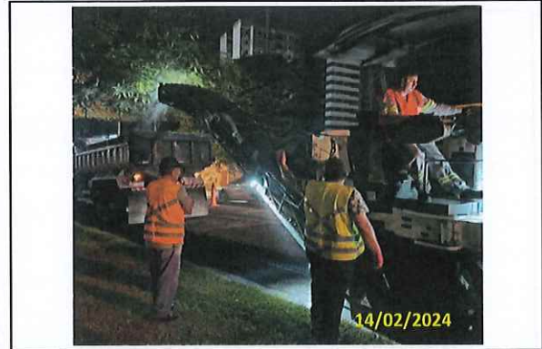
Foto 54 Fresagem em andamento
