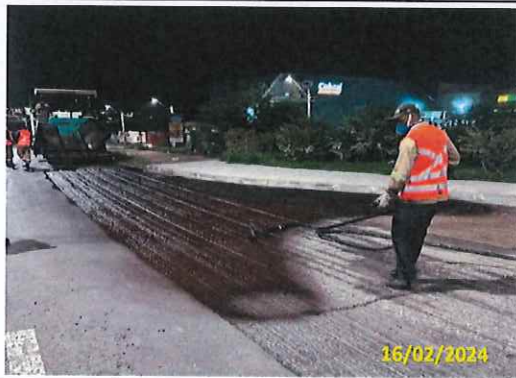
Foto 63 Pintura com imprimatura betuminosa ligante
