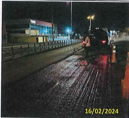
Foto 57 Pintura com imprimatura betuminosa ligante
