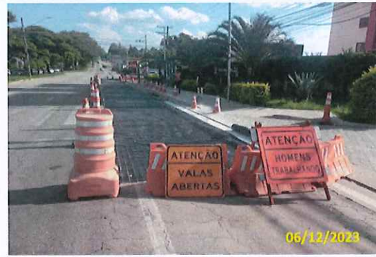
Foto 44 Aplicação de lona e tela metálica
