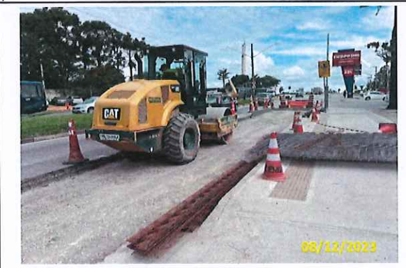
Foto 49 Compactação da sub-base
