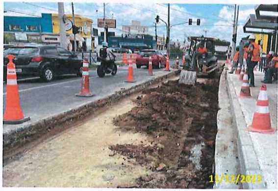
Foto 11 Escavação e remoção de solo saturado
