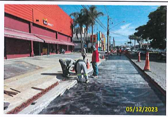
Foto 20 Aplicação de lona e montagem das barras de transferência
