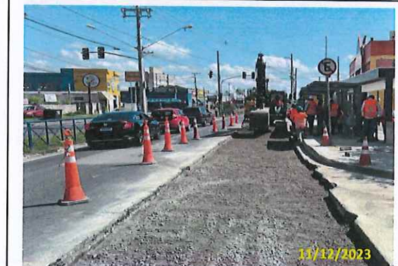
Foto 12 Aplicação de BGS em andamento
