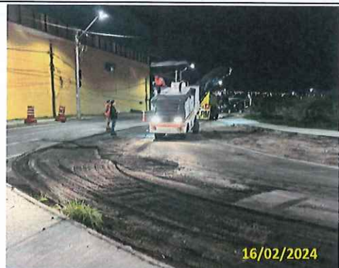
Foto 62 Fresagem do retorno
