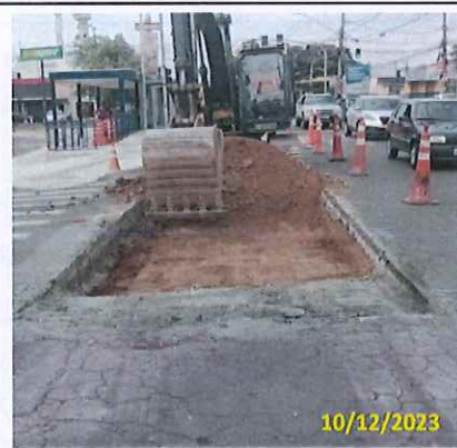
Foto 10 Escavação para execução da base
