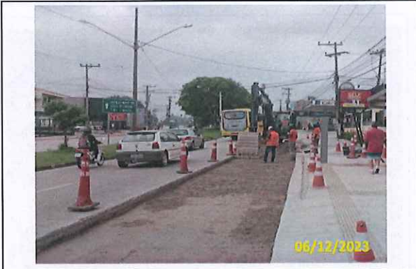
Foto 27 Aplicação de BGS em andamento
