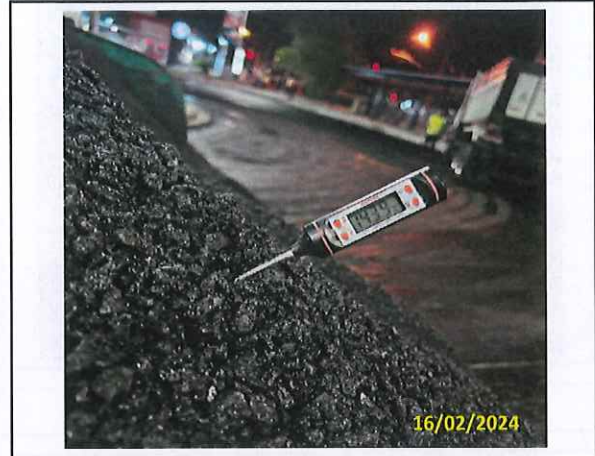
Foto 66 Controle de temperatura da massa asfáltica
