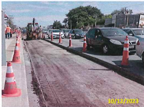
Foto 37 Fresagem realizada
