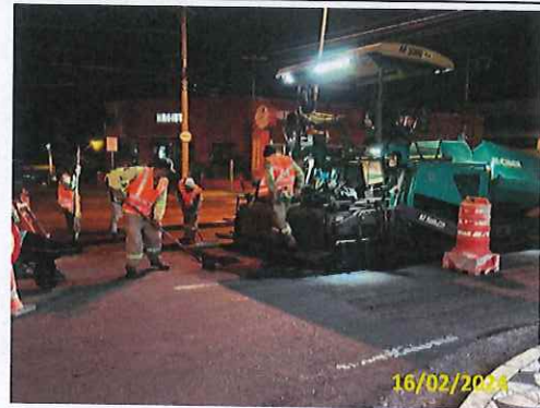
Foto 58 Aplicação de massa asfáltica
