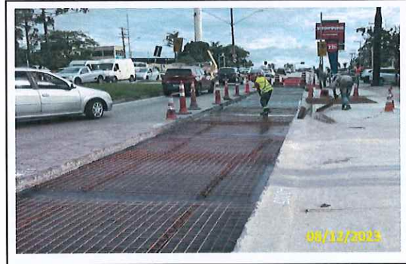
Foto 50 Aplicação de lona e tela metálica
