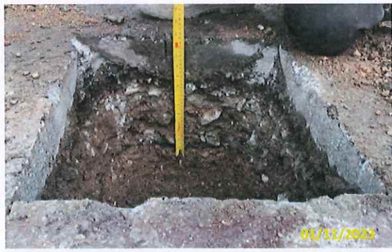
Foto 41 Sondagem do pavimento existente
