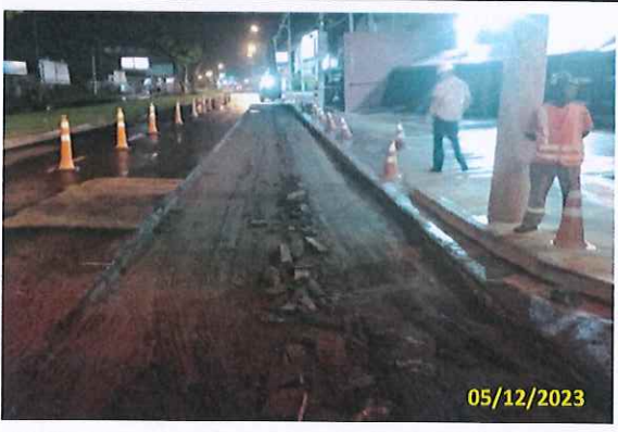
Foto 19 Fresagem executada
