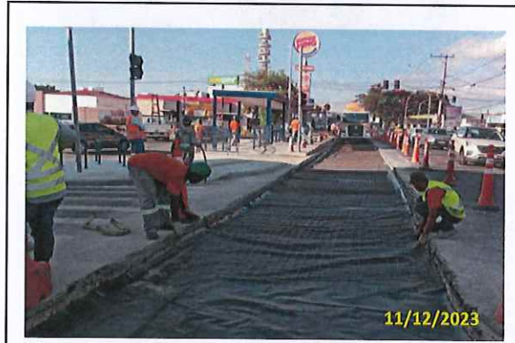
Foto 12 Aplicação de BGS em andamento
