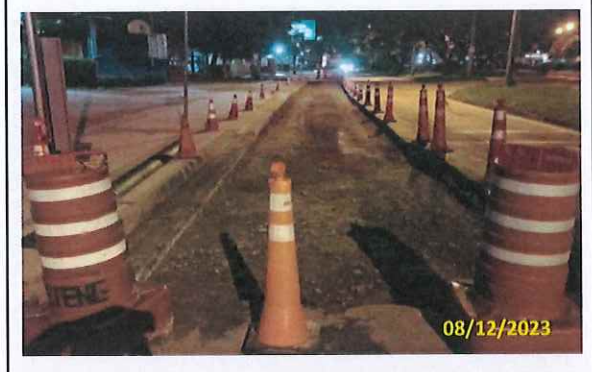
Foto 48 Fresagem realizada
