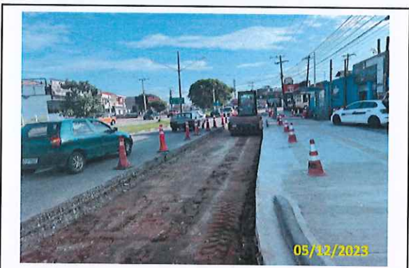
Foto 26 Compactação da vala
