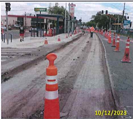
Foto 09 Fresagem realizada
