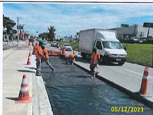
Foto 33 Aplicação de lona e tela metálica
