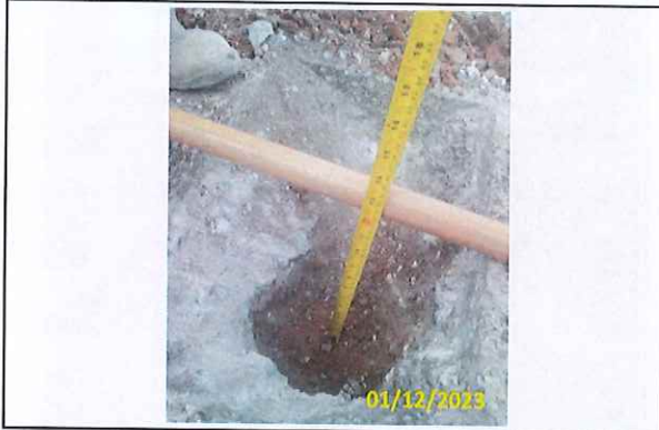
Foto 23 Sondagem do pavimento existente
