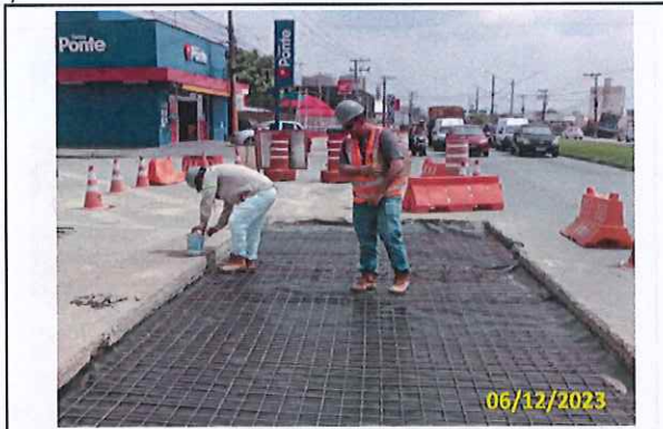
Foto 29 Marcação de cotas pela topografia
