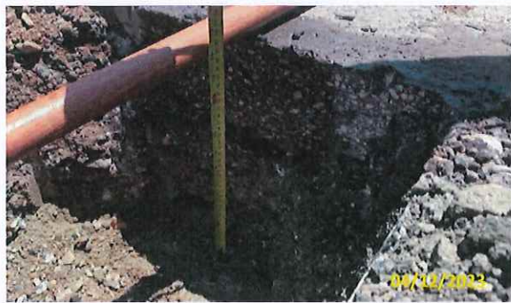
Foto 35 Sondagem do pavimento existente
