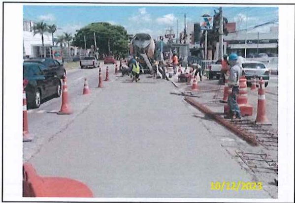
Foto 39 Aplicação de CCP em andamento
