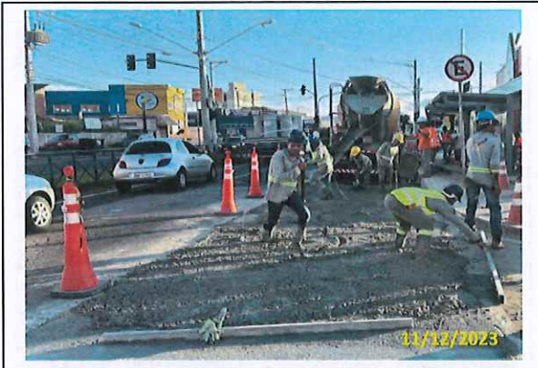
Foto 15 Aplicação do CCP em andamento
