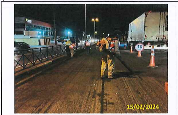
Foto 55 Limpeza para aplicação da massa asfáltica
