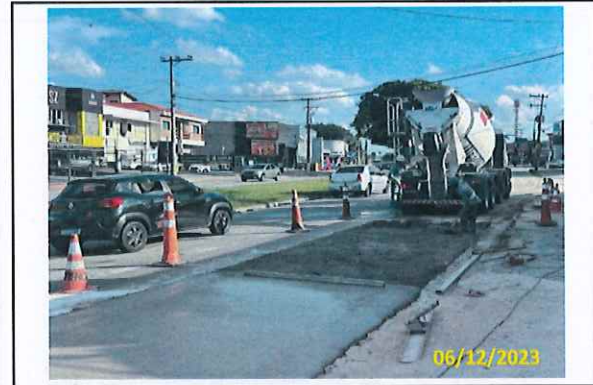
Foto 30 Aplicação de CCP
