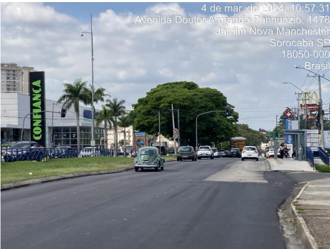
Fotos 17 e 18: Trecho 02 com o novo revestimento asfáltico.
