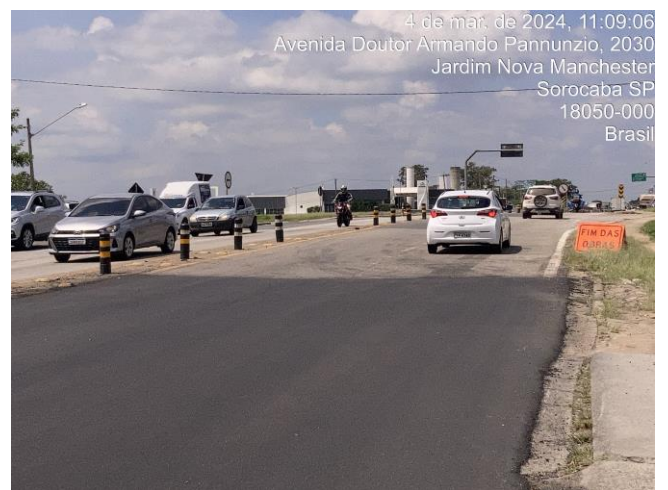
Fotos 23 e 24: Trecho 02 com o novo revestimento asfáltico, fim do trecho.
