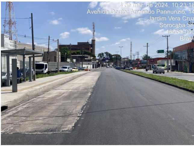
Fotos 3 e 4: Pavimento rígido executado.
