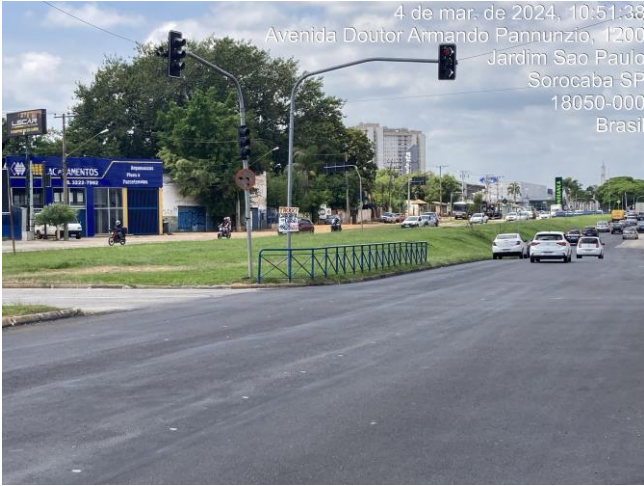
Fotos 15 e 16: Pavimento flexível e rígido executados.
