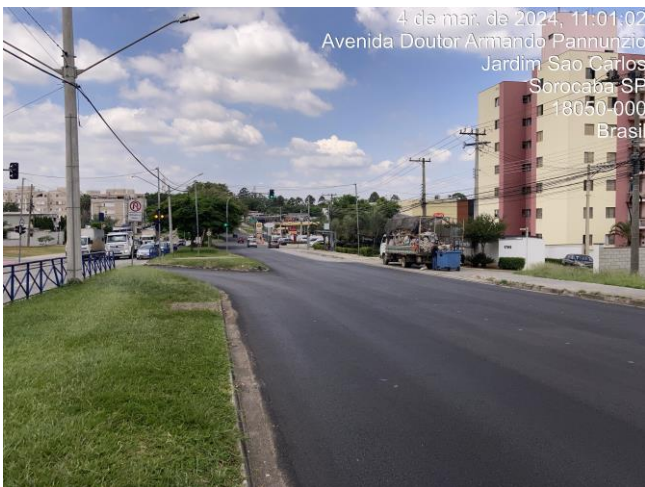
Fotos 17 e 18: Trecho 02 com o novo revestimento asfáltico.
