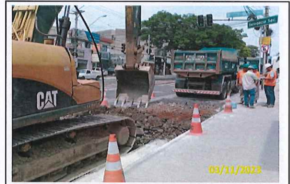
Foto 31 Início da escavação para execução da sub-base
