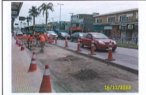
Foto 42 Limpeza da caixa
