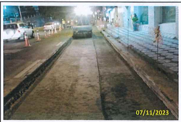
Foto 20 Compactação da camada de BGS
