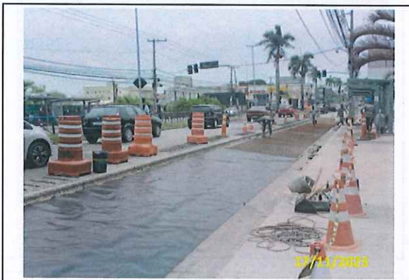
Foto 43 Aplicação de lona e tela metálica
