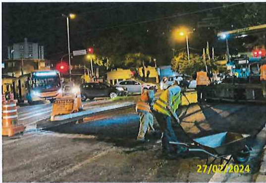
Foto 48 Início da aplicação de massa asfáltica
