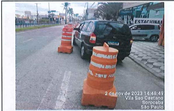
Foto 39 Sinalização para levantamento topográfico
