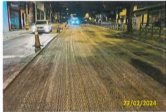
Foto 47 Trecho após fresagem
