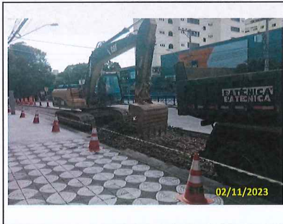
Foto 04 Início da escavação para execução da sub-base
