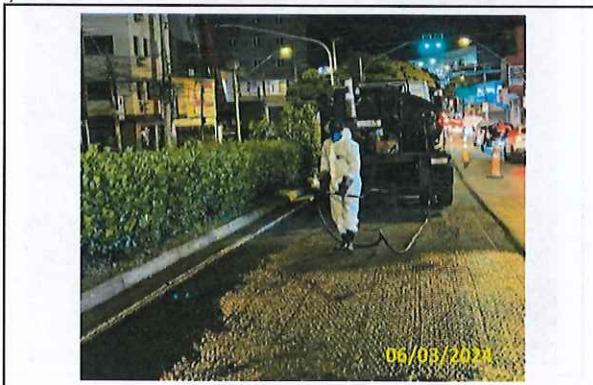
Foto 52 Aplicação do CCP em andamento
