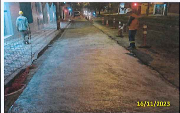
Foto 26 Pavimento concretado
