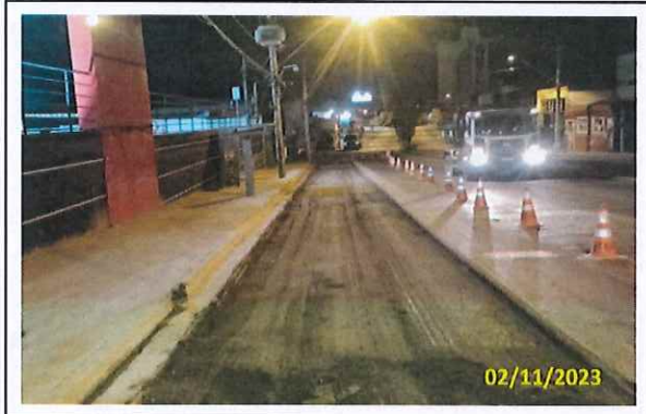
Foto 30 Fresagem realizada
