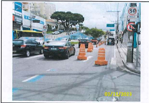
Foto 12 Sinalização para levantamento topográfico
