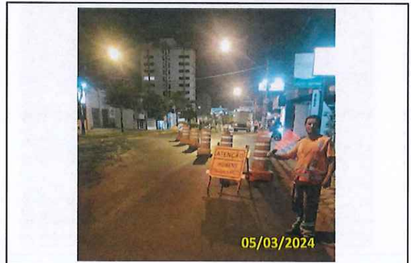
Foto 51 Sinalização para continuação da fresagem
