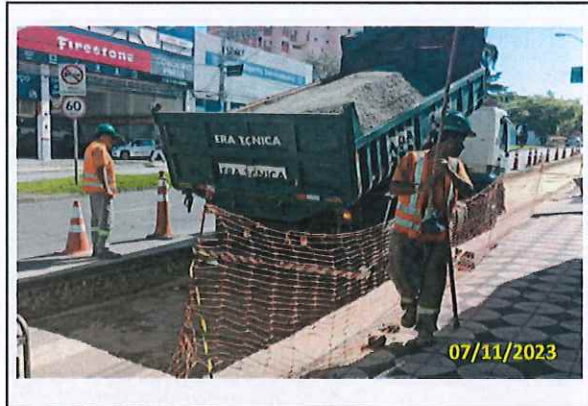
Foto 19 Aplicação de BGS
