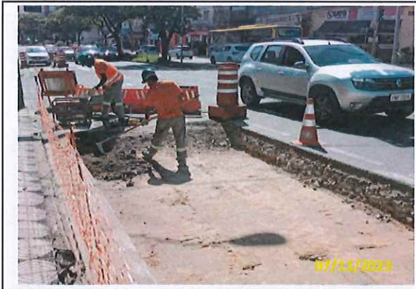
Foto 18 Demolição e ajuste de geometria da ponta da vala
