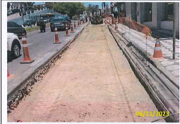
Foto 16 Regularização de fundo de vala
