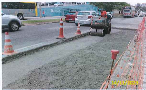
Foto 24 Compactação do CCR aplicado
