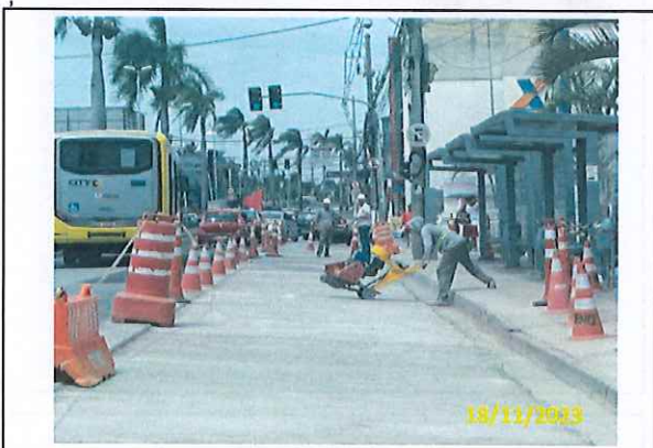
Foto 45 Corte das juntas e limpeza
