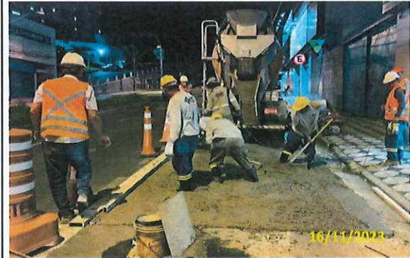
Foto 25 Aplicação de CCP
