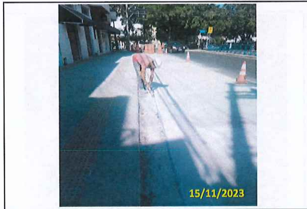
Foto 11 Tratamento das juntas
