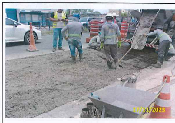
Foto 44 Aplicação de CCP
