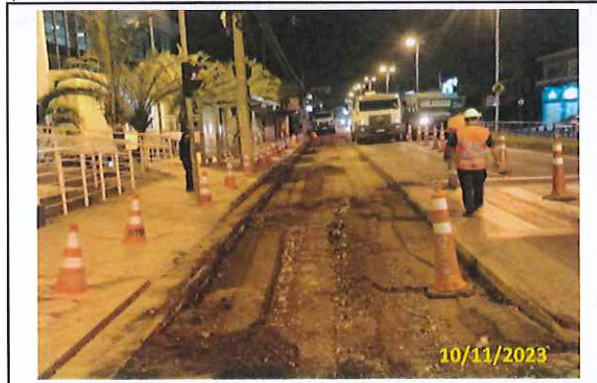
Foto 41 Fresagem realizada
