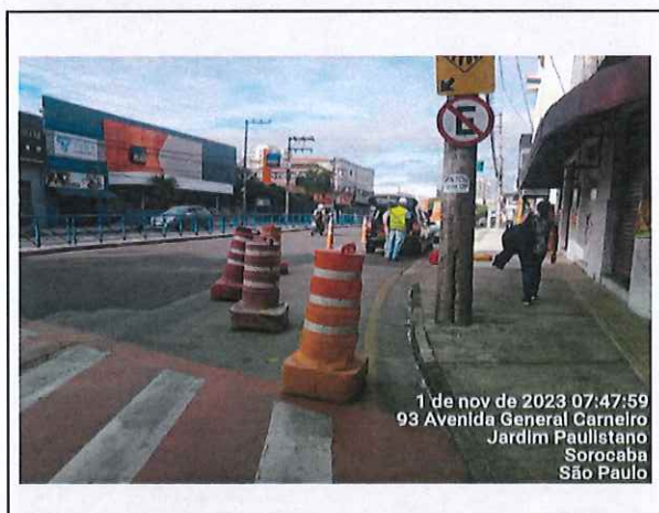
Foto 01 Sinalização para levantamento topográfico
