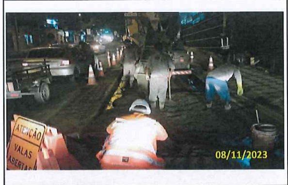
Foto 33 Aplicação de CCP em andamento
