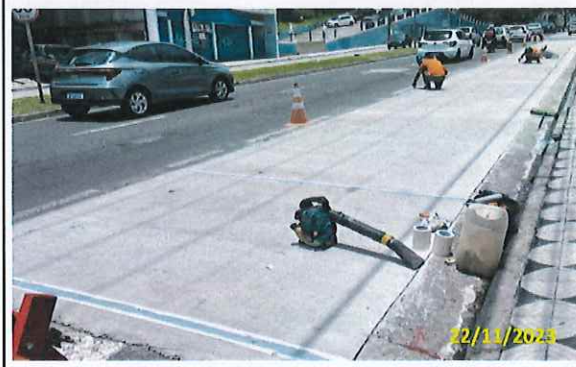
Foto 27 Tratamento das juntas
