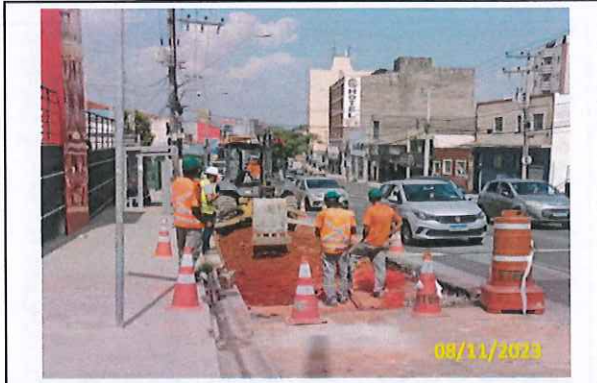
Foto 32 Tratamento do fundo de vala
