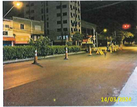
Foto 55 Nivelamento dos PV's
