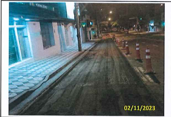
Foto 14 Fresagem realizada
