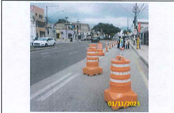
Foto 28 Sinalização para levantamento topográfico
