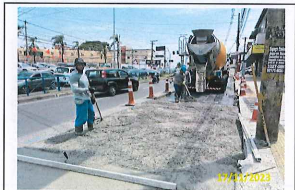
Foto 38 Aplicação de CCP
