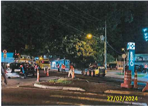
Foto 46 Sinalização para início da fresagem
