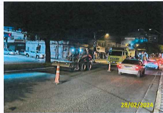
Foto 49 Aplicação de massa asfáltica em andamento
