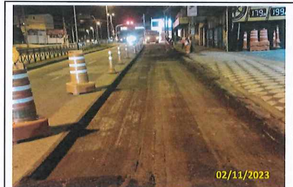
Foto 36 Fresagem realizada
