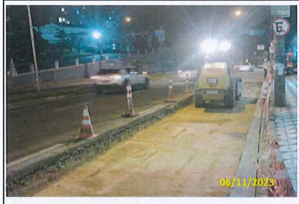
Foto 17 Compactação do fundo de vala
