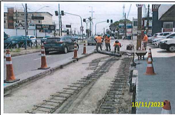
Foto 37 Corte e demolição para esquadro da caixa do pavimento rígido
