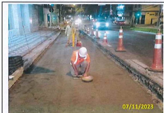
Foto 21 Ensaio de compactação in situ
