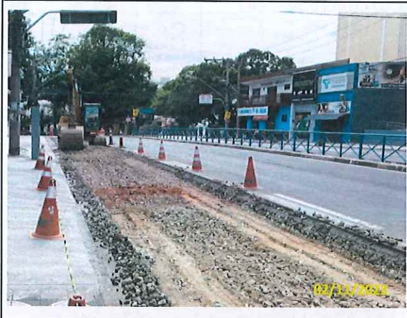
Foto 05 Escavação para execução da sub-base em andamento
