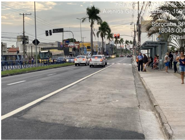
Fotos 21 e 22: Pavimento flexível e rígido executados.
