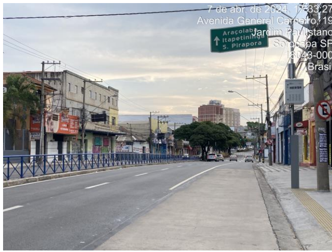
Fotos 3 e 4: Pavimento rígido executado.
