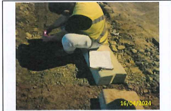
Foto 52 Marcação de cotas para assentamento das guias
