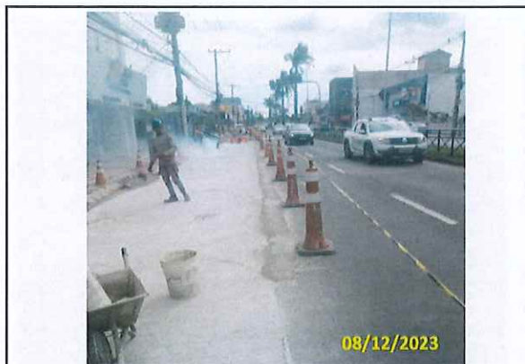
Foto 10 Acabamento entre pav. rígido e flexível (2ª frente de serviço)
