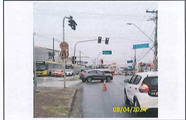
Foto 48 Remoção de poste de iluminação pública
