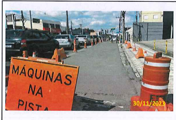
Foto 16 Acabamento do pavimento concretado
