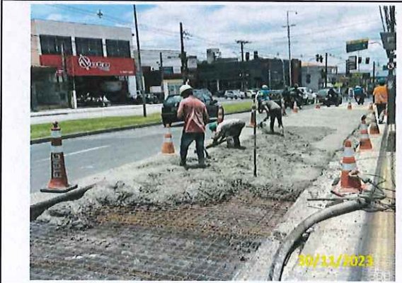
Foto 15 Aplicação de CCP em andamento
