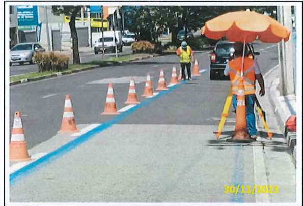
Foto 18 Marcação topográfica
