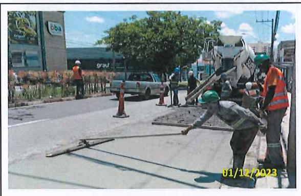
Foto 27 Aplicação de CCP
