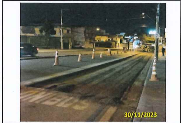
Foto 20 Fresagem realizada
