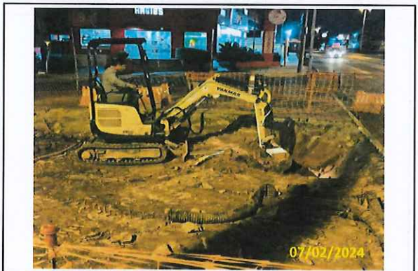
Foto 39 Remoção de solo borrachudo
