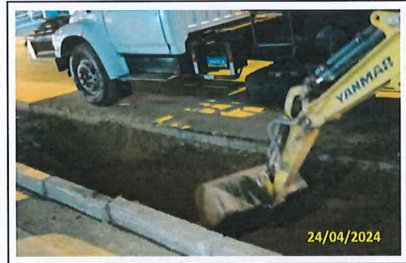
Foto 54 Remoção de solo saturado
