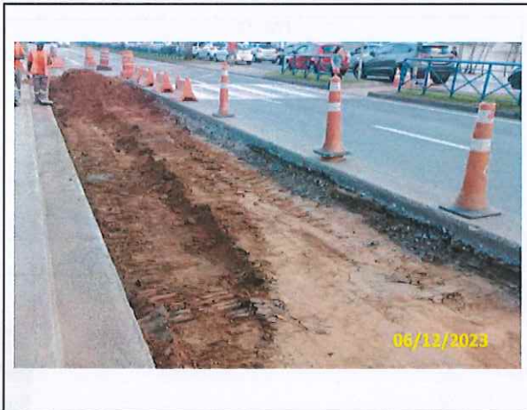
Foto 03 Tratamento de solo borrachado
