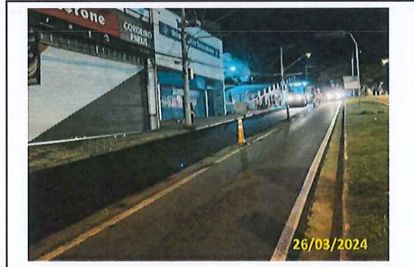
Foto 33 Aplicação de massa asfáltica entre as estacas 16 a 30
