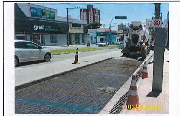
Foto 26 Aplicação de lona e tela metálica
