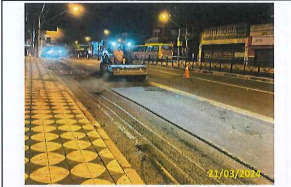
Foto 30 Fresagem entre as estacas 3 a 15
