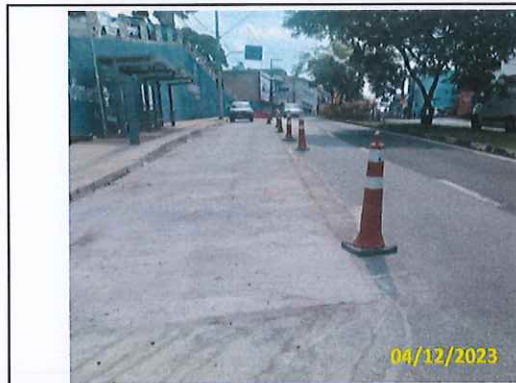
Foto 28 Acabamento entre pav. rígido e flexível
