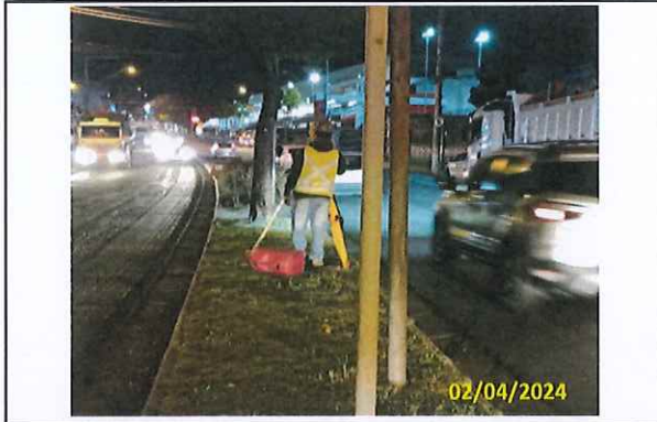
Foto 59 Marcação topográfica para abertura do canteiro
