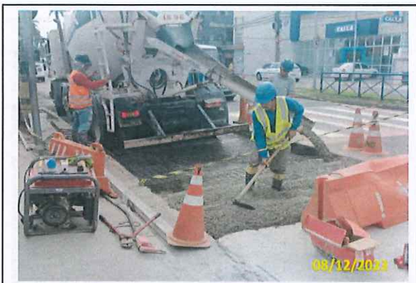
Foto 09 Aplicação de concreto
