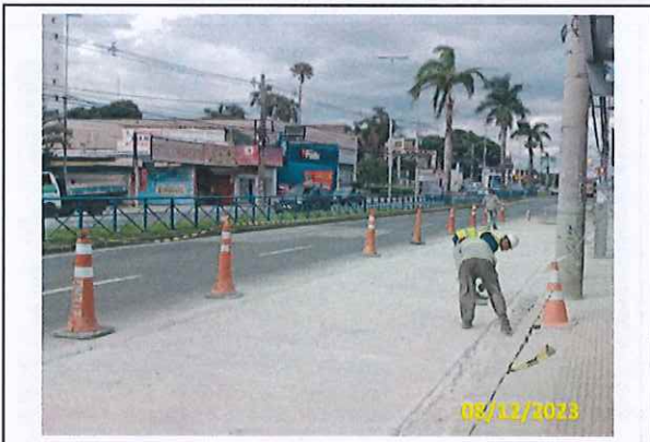
Foto 11 Tratamento de juntas (2ª frente de serviço)
