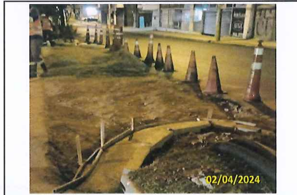
Foto 62 Assentamento de guias e concretagem de sarjeta
