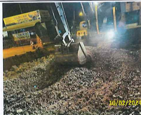
Foto 41 Aplicação de macadame
