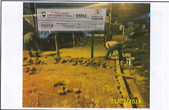
Foto 46 Recomposição de piso intertravado
