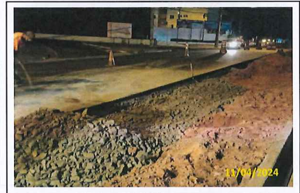
Foto 50 Aplicação de macadame
