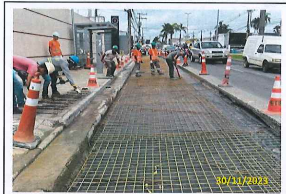
Foto 14 Aplicação de lona e tela metálica
