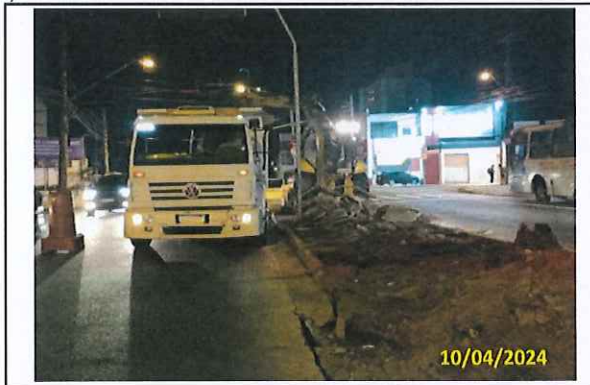
Foto 49 Escavação e demolição
