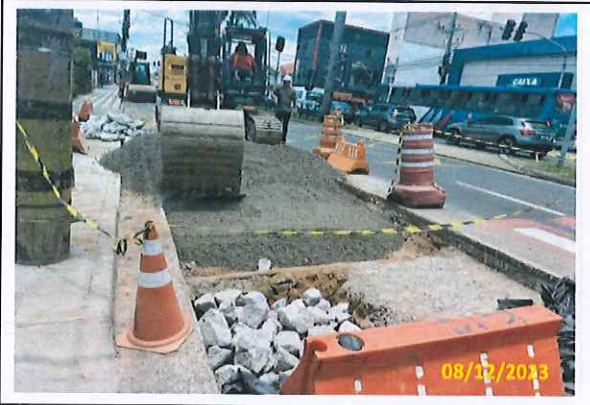
Foto 07 Tratamento de sub-base em andamento
