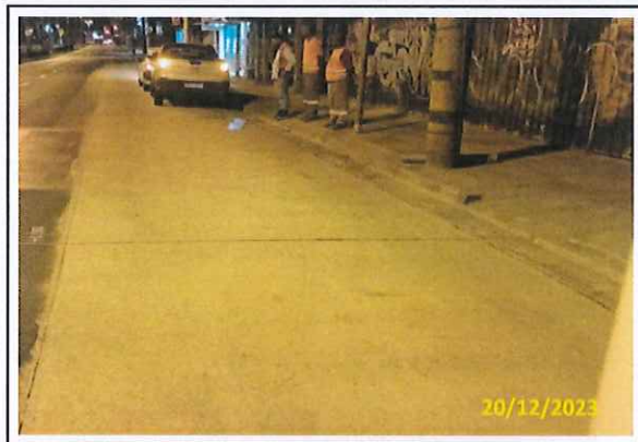
Foto 12 Tratamento de trincas concluído
