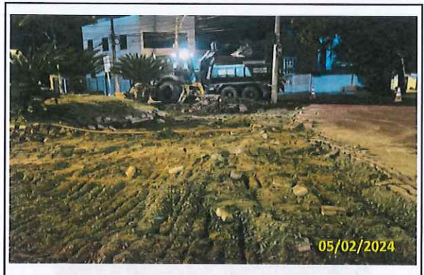
Foto 37 Remoção de piso intertravado
