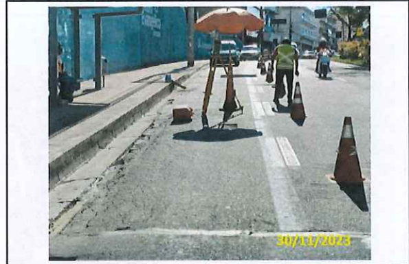
Foto 24 Marcação topográfica
