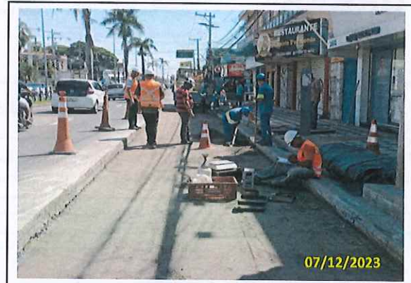
Foto 06 Ensaio de compactação do BGS
