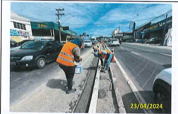
Foto 55 Concretagem de sarjeta
