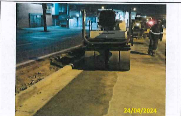
Foto 57 Compactação de BGS
