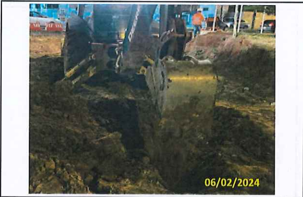
Foto 38 Abertura de caixa para avaliação do solo
