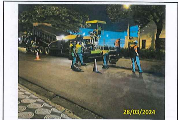
Foto 35 Continuação da aplicação de massa asfáltica
