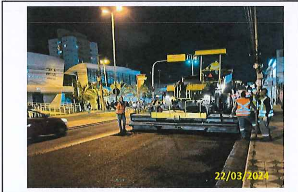
Foto 32 Aplicação de massa asfáltica em andamento
