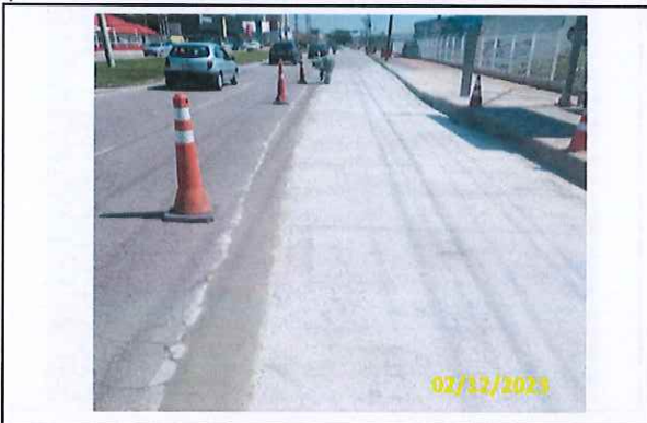
Foto 31 Acabamento entre pav. rígido e flexível
