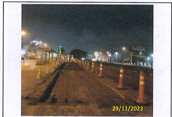
Foto 17 Fresagem realizada
