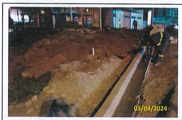
Foto 88 Concretagem da sarjeta (Praça)
