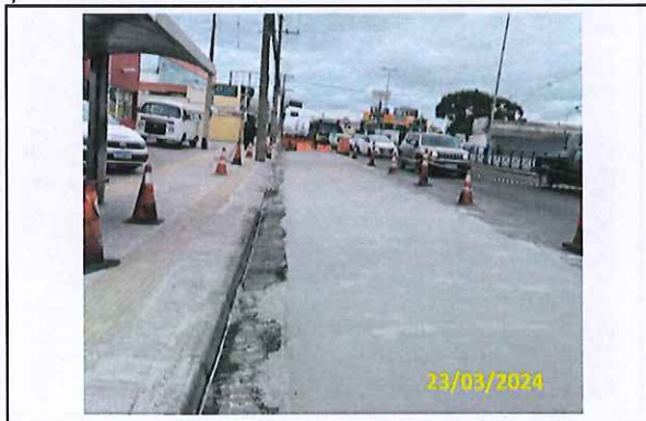
Foto 52 Pavimento concretado
