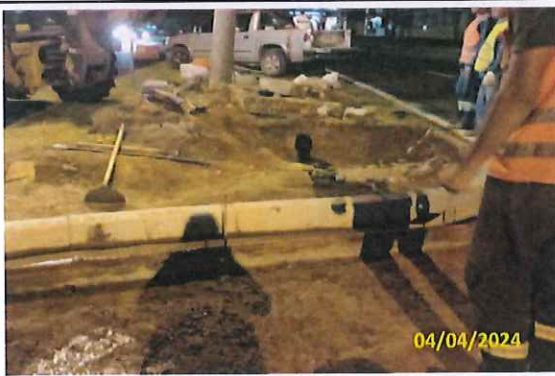
Foto 73 Concretagem de sarjeta
