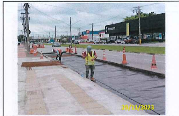
Foto 35 Marcação de cotas e montagem da armação
