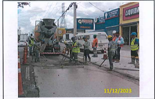
Foto 44 Aplicação de CCP em andamento
