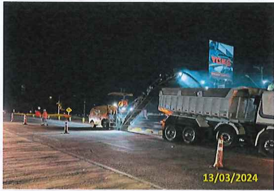
Foto 54 Início da fresagem (Estaca 243 a 218)
