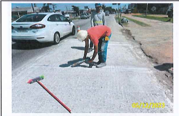
Foto 24 Tratamento das juntas
