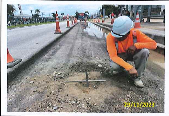
Foto 18 Perfuração na vala para avaliação da sub-base
