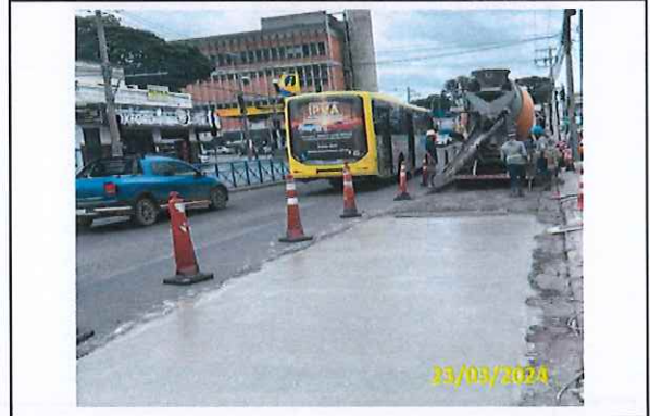
Foto 51 Acabamento da aplicação de concreto
