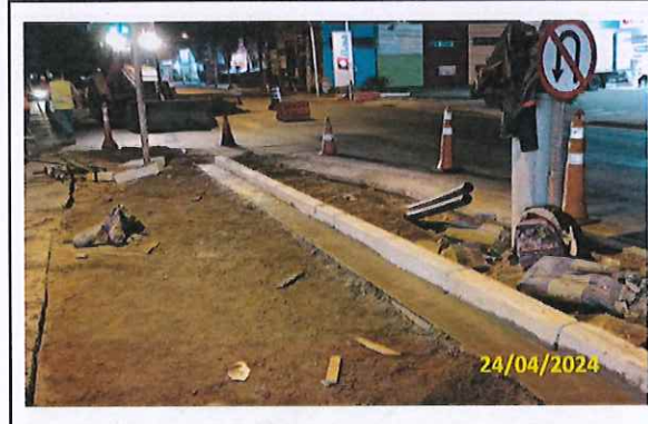
Foto 94 Assentamento de guias e concretagem de sarjeta
