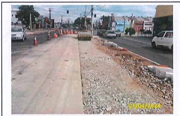
Foto 113 Espalhamento de macadame
