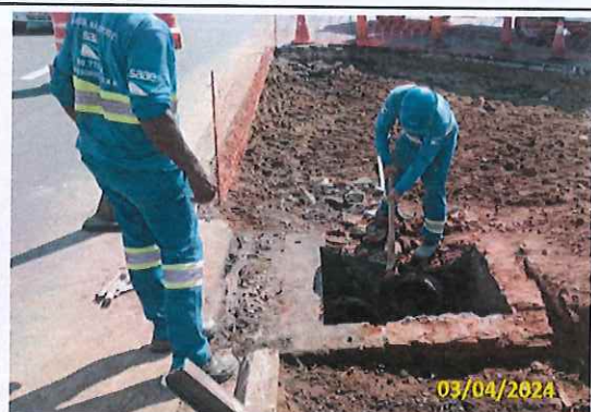
Foto 68 Execução de caixa realizada pelo SAAE
