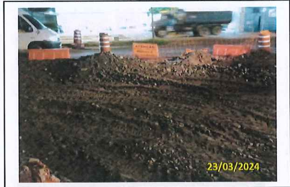
Foto 84 Espalhamento de macadame (Praça)
