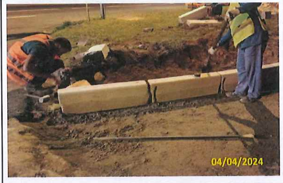
Foto 72 Assentamento de guias
