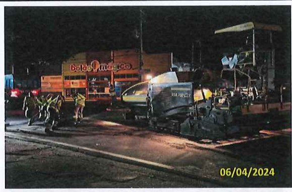
Foto 91 Aplicação de massa asfáltica
