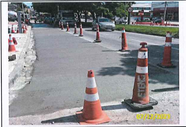
Foto 15 Pavimento concretado
