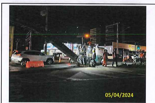
Foto 90 Fresagem em andamento
