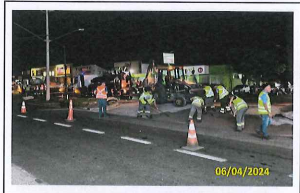
Foto 100 Ajuste no greide para aplicação de massa
