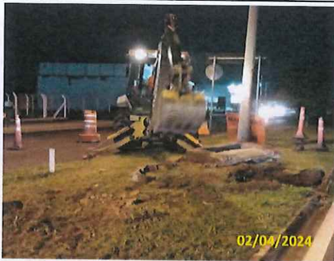
Foto 67 Início da escavação
