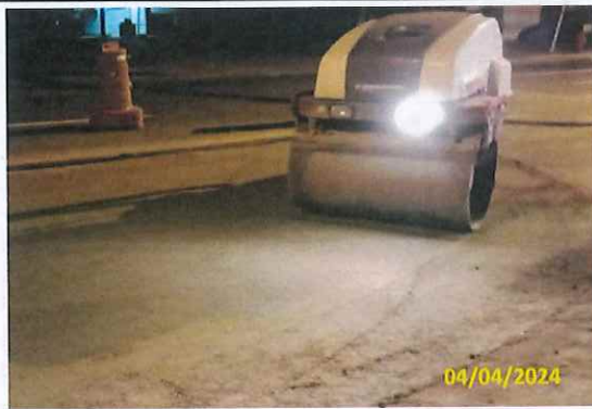
Foto 71 Espalhamento e compactação de BGS
