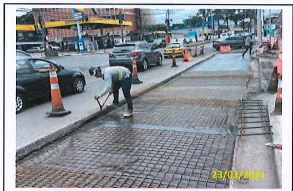
Foto 49 Aplicação de lona e tela metálica
