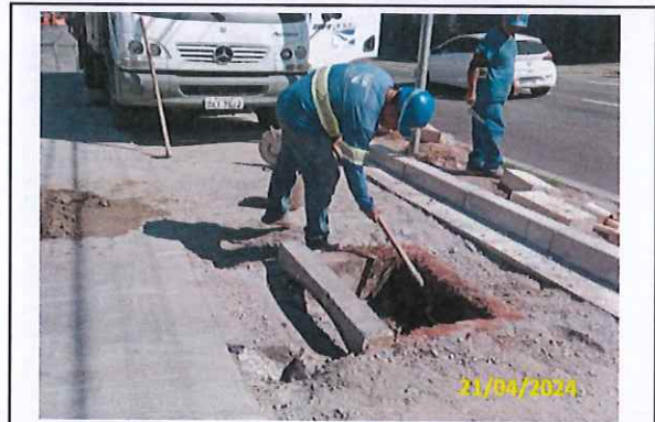
Foto 118 Execução de boca de lobo realizada pelo SAAE
