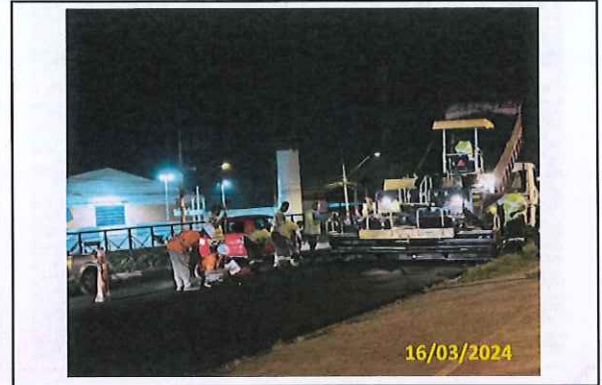
Foto 59 Aplicação de massa asfáltica (Estaca 213 a 191)
