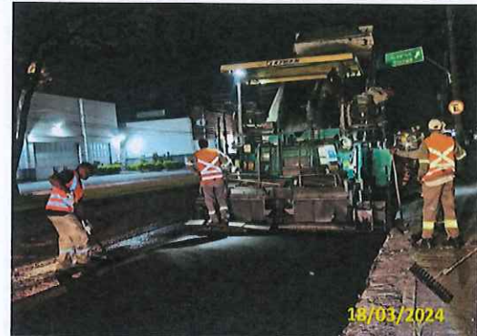
Foto 63 Aplicação de massa asfáltica (Estaca 169 a 161)
