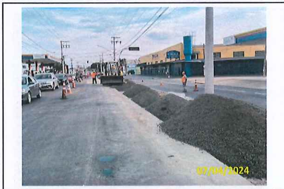
Foto 114 Aplicação de BGS
