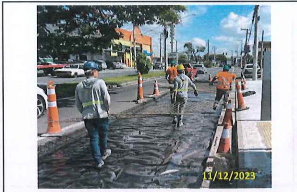
Foto 43 Aplicação de lona e tela metálica
