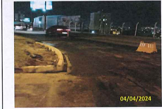
Foto 74 Aplicação de massa asfáltica concluída
