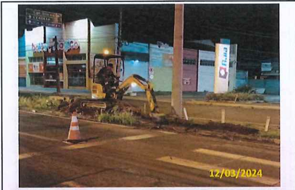
Foto 75 Escavação do canteiro central
