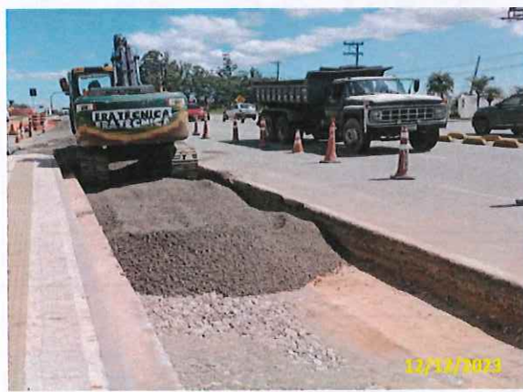
Foto 07 Aplicação de BGS
