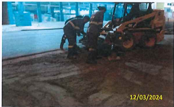
Foto 106 Aplicação de BGS
