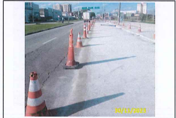
Foto 37 Acabamento entre pav. rígido e flexível
