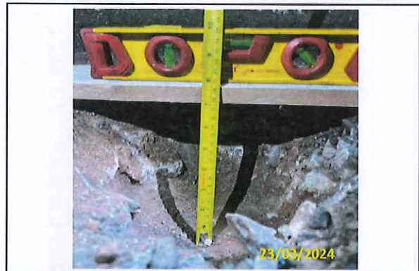
Foto 47 Sondagem para avaliação de sub-base
