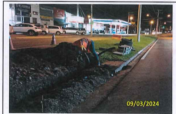
Foto 96 Locação de guias e boca de lobo
