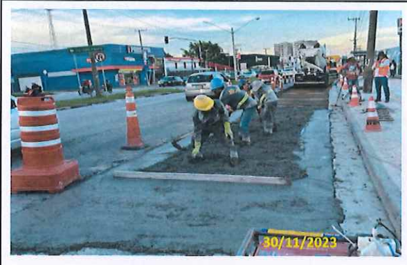
Foto 29 Aplicação de CCP em andamento
