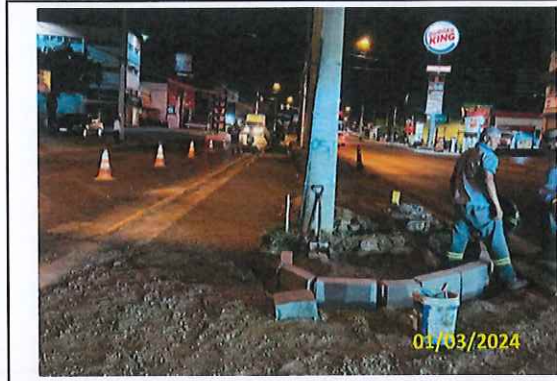
Foto 103 Alargamento do canteiro e assentamento de guias
