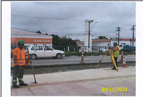
Foto 20 Marcação topográfica
