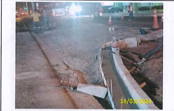
Foto 99 Concretagem de sarjeta
