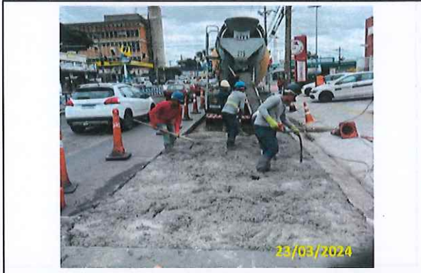
Foto 50 Aplicação de concreto em andamento
