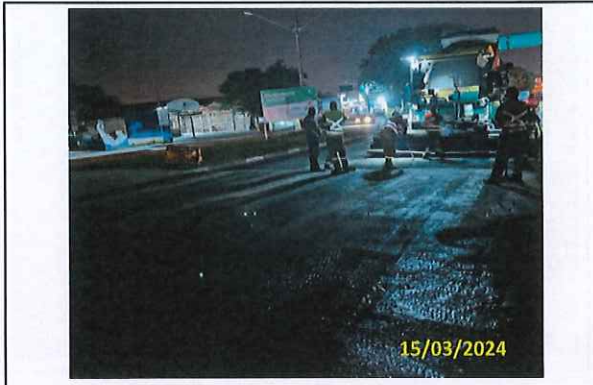
Foto 58 Aplicação de massa asfáltica (Estaca 243+10 a 223)
