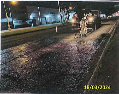
Foto 62 Imprimatura betuminosa ligante (Estaca 169 a 161)
