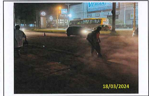
Foto 61 Limpeza da via (Estaca 169 a 161)
