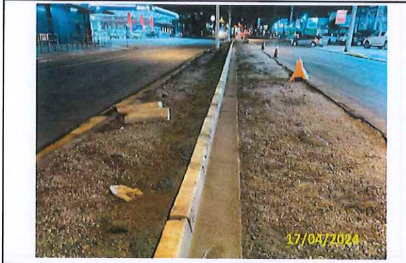
Foto 117 Concretagem de sarjeta
