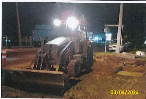
Foto 69 Limpeza e preparo da base
