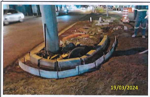
Foto 81 Preparo para concretagem da sarjeta
