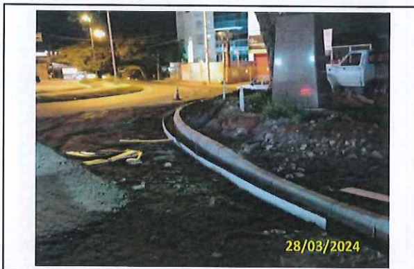
Foto 87 Preparo de forma para concretagem da sarjeta
