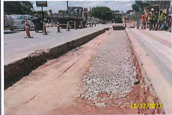
Foto 06 Aplicação e compactação de macadame
