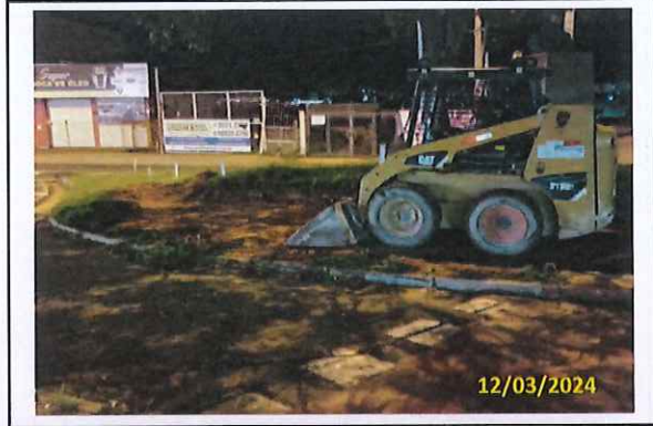
Foto 76 Escavação da praça
