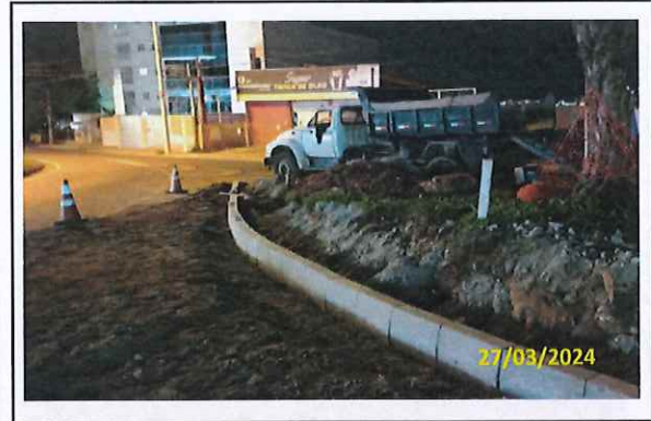
Foto 86 Assentamento de guias (Praça)
