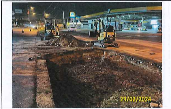
Foto 102 Escavação do canteiro
