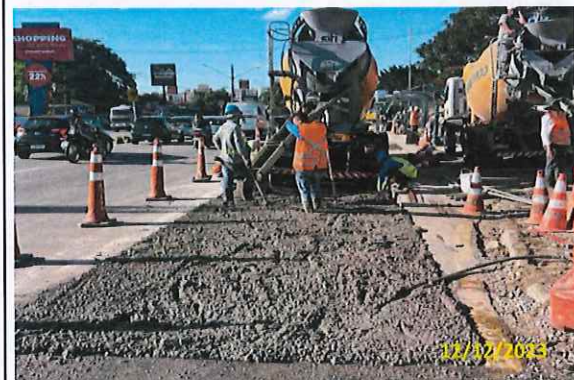
Foto 08 Aplicação de CCP em andamento
