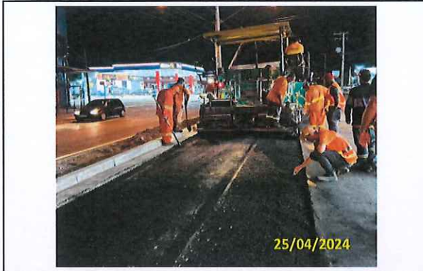
Foto 121 Aplicação de massa asfáltica
