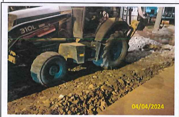
Foto 89 Aplicação de macadame (canteiro central)
