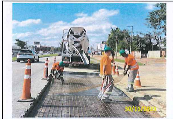
Foto 21 Aplicação de lona e tela metálica
