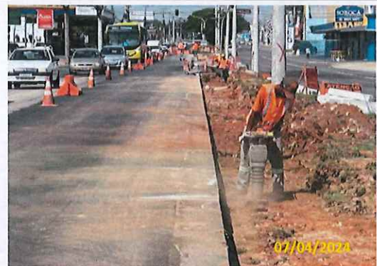
Foto 112 Regularização da vala e compactação
