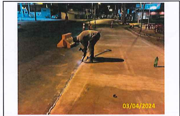
Foto 53 Tratamento de juntas com aplicação de PU
