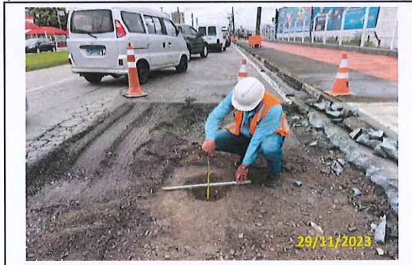
Foto 27 Perfuração na vala para avaliação da sub-base
