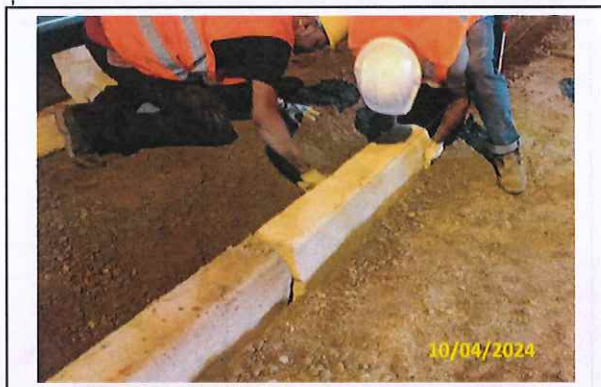
Foto 115 Assentamento de guias
