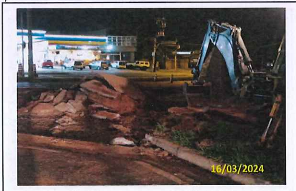
Foto 77 Demolição e escavação (Praça)
