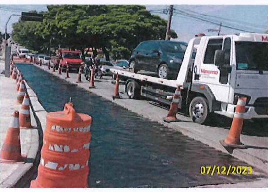
Foto 13 Aplicação de lona
