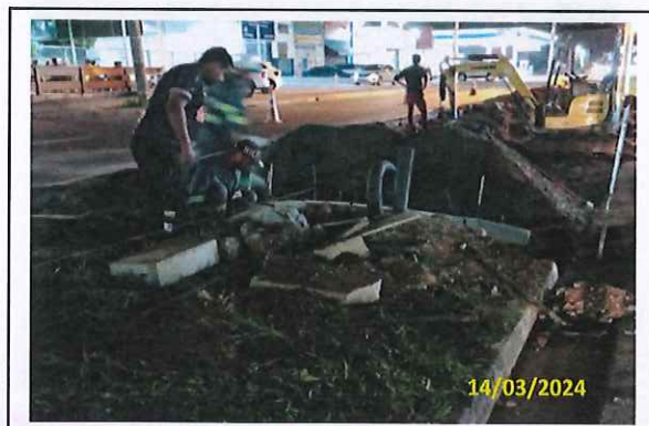
Foto 98 Assentamento de guias e preparo da base
