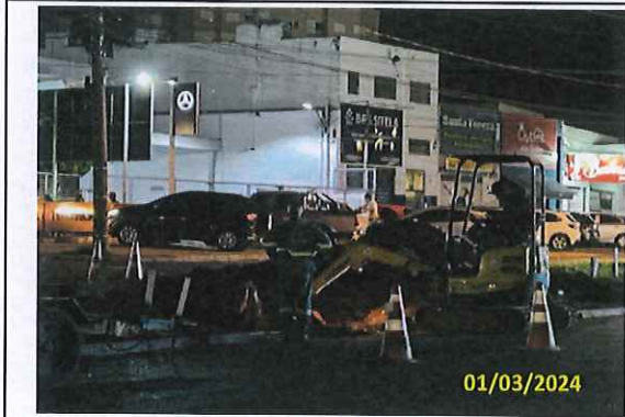
Foto 95 Escavação para abertura do canteiro central
