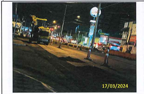
Foto 60 Fresagem (Estaca 141 a 129)
