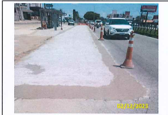
Foto 23 Acabamento entre pav. rígido e flexível
