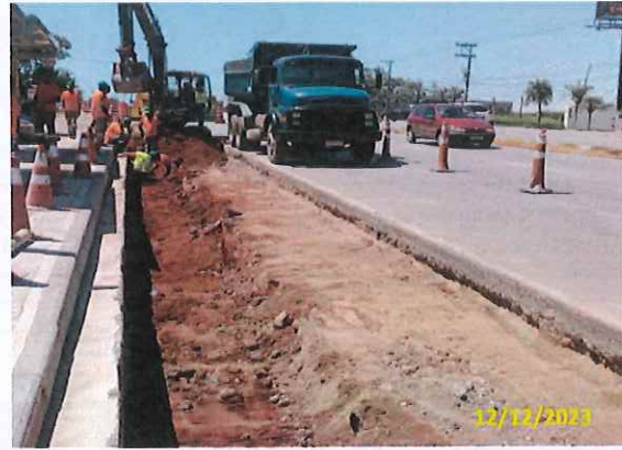
Foto 05 Remoção de solo borrachudo
