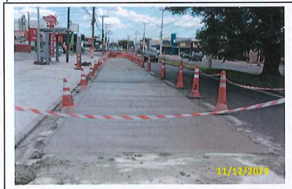
Foto 45 Pavimento concretado
