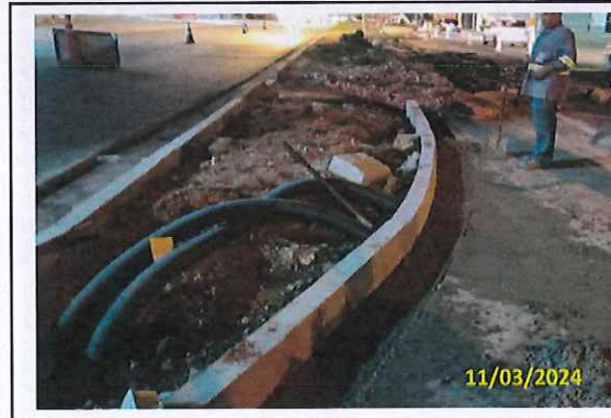
Foto 105 Concretagem da sarjeta
