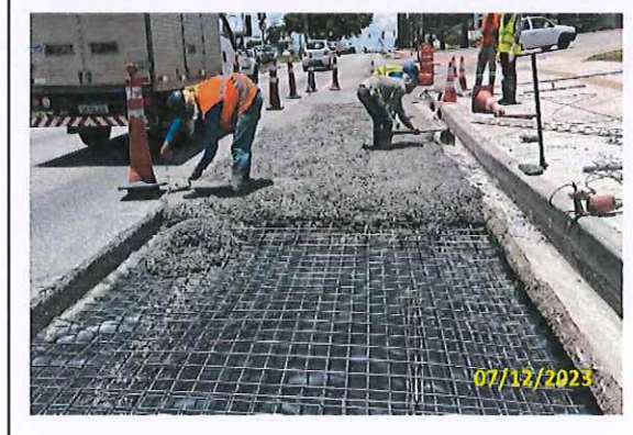
Foto 14 Aplicação de CCP em andamento
