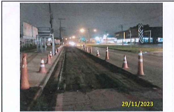
Foto 32 Fresagem realizada
