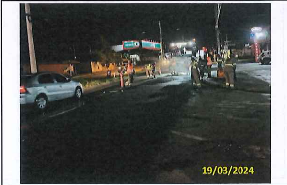
Foto 66 Continuação da aplicação de massa asfáltica
