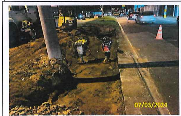
Foto 104 Compactação do canteiro
