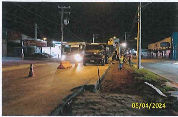
Foto 109 Início da escavação do canteiro
