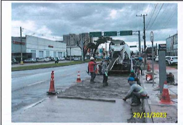
Foto 36 Aplicação de CCP
