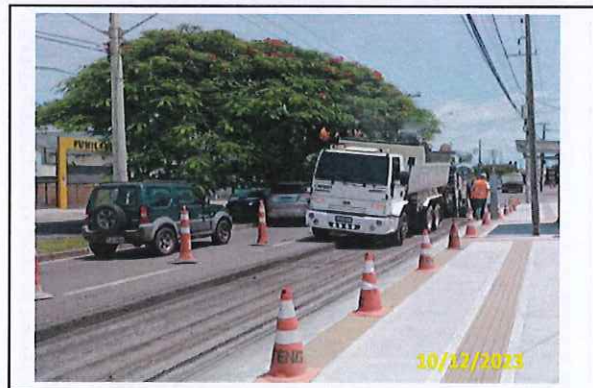
Foto 42 Fresagem em andamento
