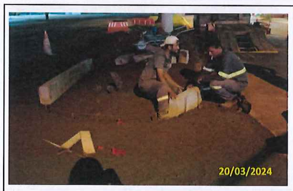
Foto 82 Assentamento de guias no canteiro central
