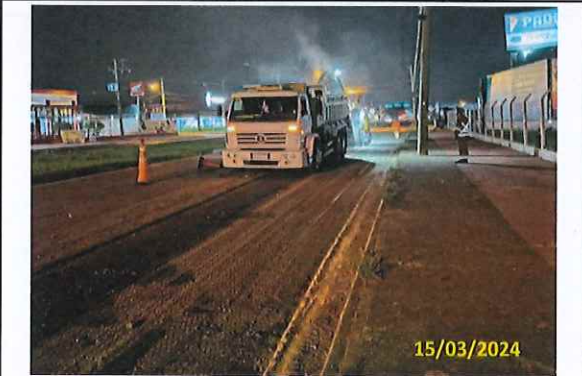
Foto 57 Fresagem em andamento (Estaca 195 a 171)
