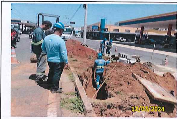
Foto 97 Realocação de boca de lobo no canteiro central
