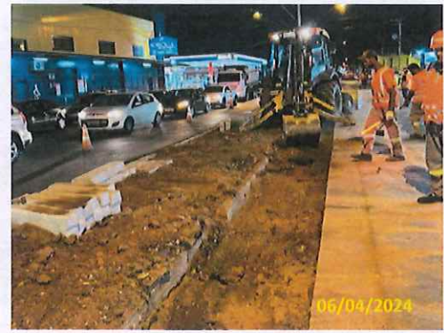
Foto 110 Escavação em andamento
