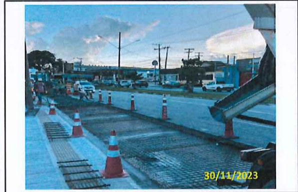
Foto 28 Montagem da armação
