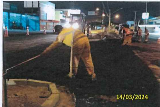
Foto 107 Pavimentação do trecho em andamento
