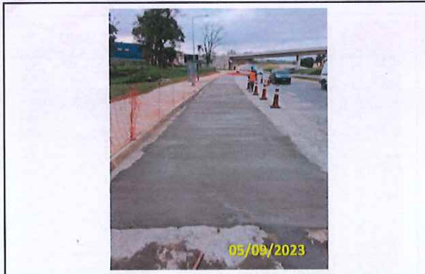
Foto 44 Pavimento concretado
