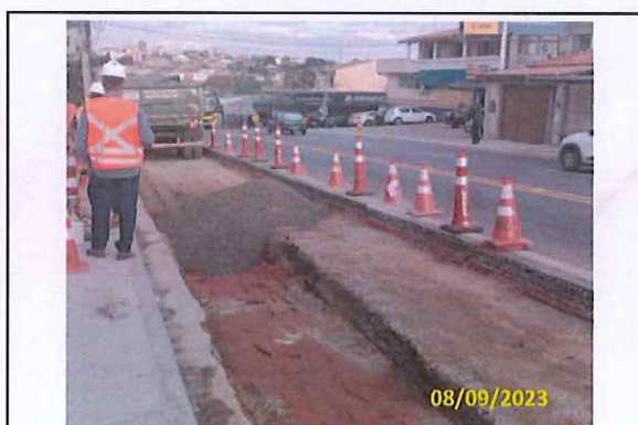
Foto 25 Aplicação de BGS
