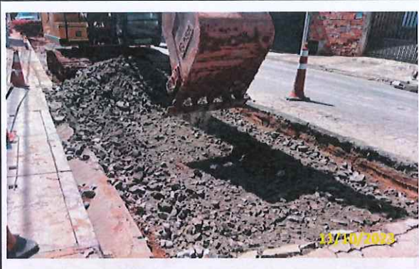
Foto 50 Lançamento de macadame para reforço de sub-base
