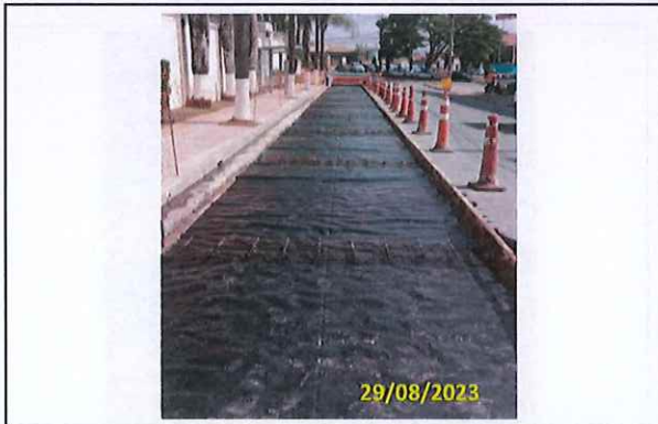
Foto 71 Instalação de lona e barras de transferência
