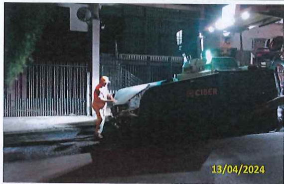
Foto 83 Aplicação de massa asfáltica (R. Benedito Ferreira Telles)
