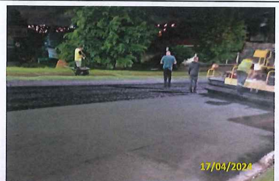
Foto 84 Aplicação de massa asfáltica em andamento
