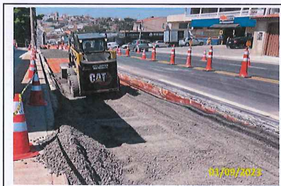
Foto 23 Aplicação de BGS
