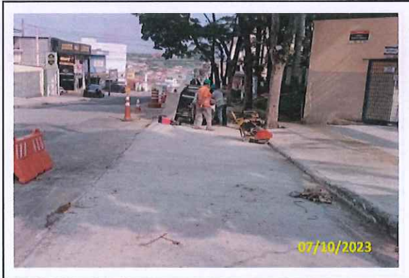
Foto 20 Tratamento de juntas e fissuras
