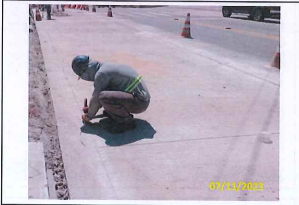
Foto 35 Tratamento das juntas
