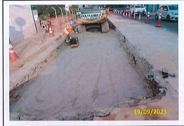
Foto 10 Aplicação de areia como reforço do sub-leito
