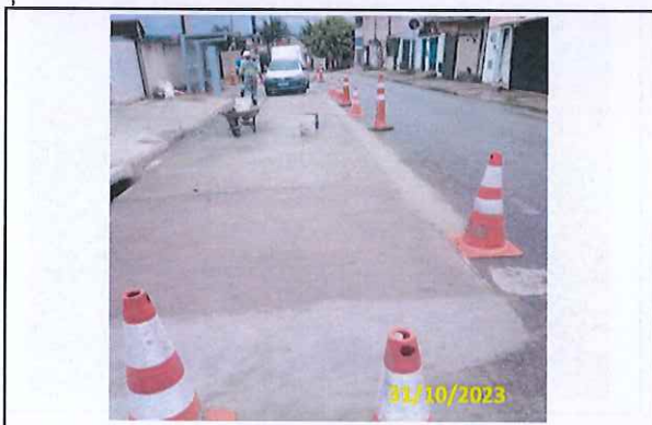
Foto 56 Acabamento entre pav. rígido e flexível
