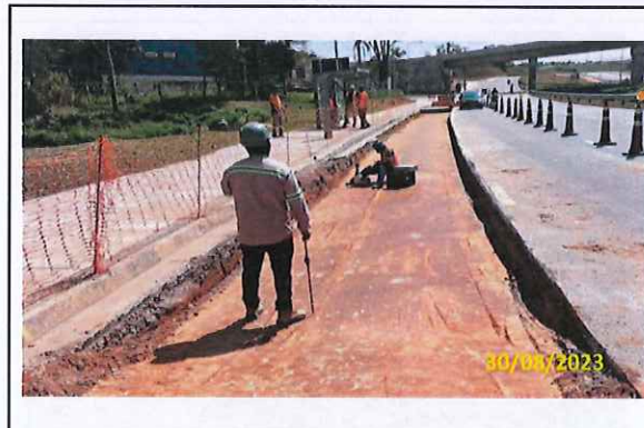
Foto 39 Ensaio de compactação e marcação topográfica
