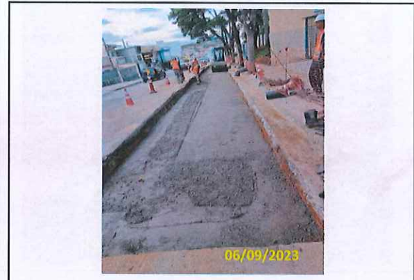
Foto 17 Aplicação e compactação de BGS
