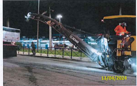
Foto 82 Fresagem (Entorno do Terminal Ipiranga)
