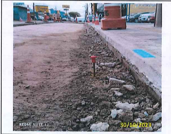
Foto 05 Relocação de cotas para o CCP
