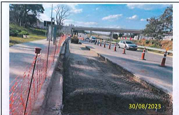
Foto 40 Aplicação de BGS
