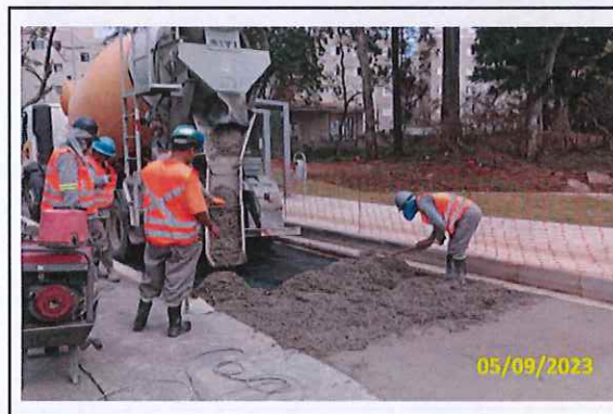
Foto 43 Aplicação de CCP
