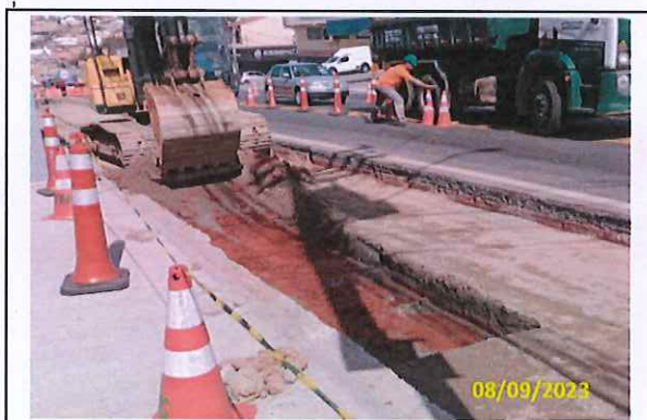
Foto 24 Remoção de solo borrachudo
