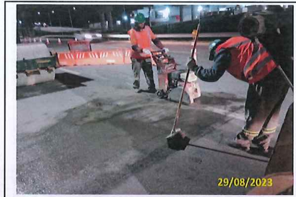
Foto 37 Corte do pavimento
