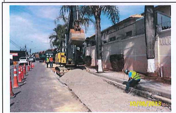
Foto 69 Lançamento de BGS
