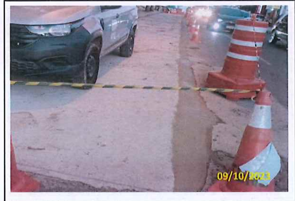
Foto 21 Acabamento entre pav. rígido e flexível
