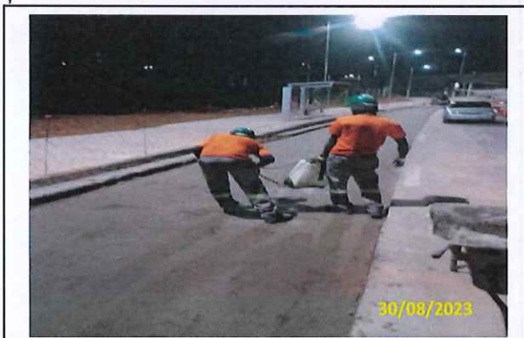
Foto 42 Aplicação de cura química na camada de CCR
