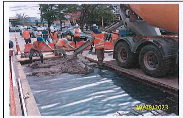
Foto 72 Aplicação de CCP
