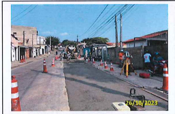
Foto 53 Aplicação de CCP
