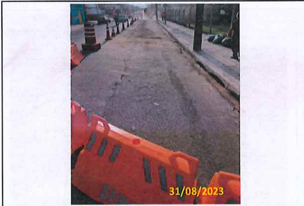
Foto 07 Corte do pavimento
