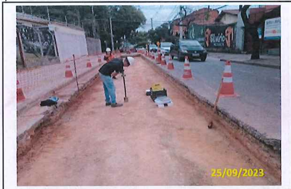
Foto 59 Ensaio de compactação
