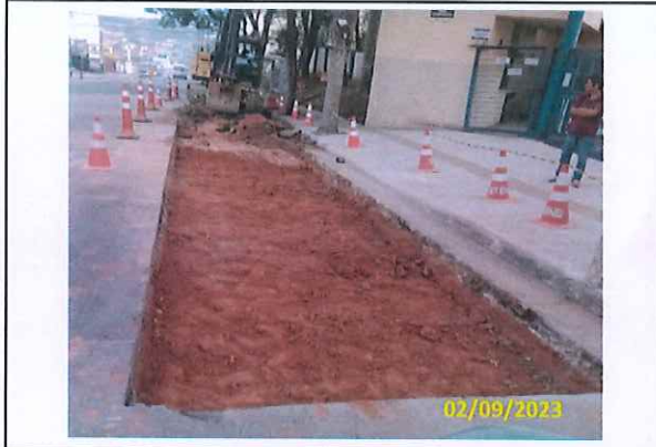
Foto 16 Escavação para execução de sub-base
