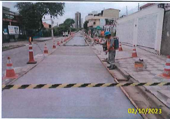
Foto 63 Aplicação de CCP
