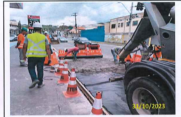
Foto 34 Aplicação de CCP
