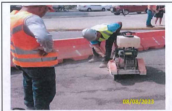
Foto 67 Corte do pavimento
