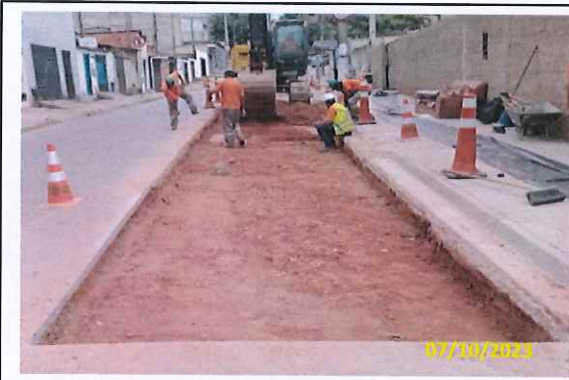
Foto 48 Escavação em andamento
