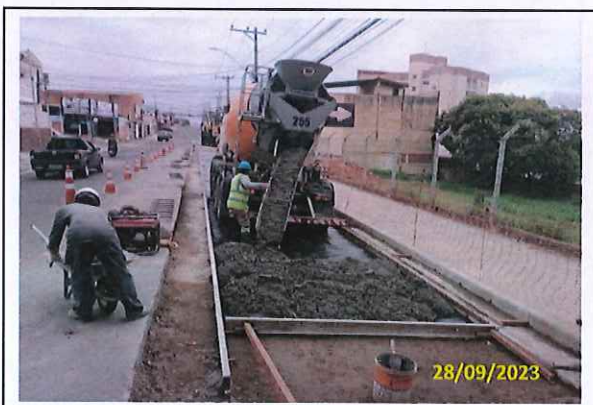
Foto 13 Aplicação de CCP
