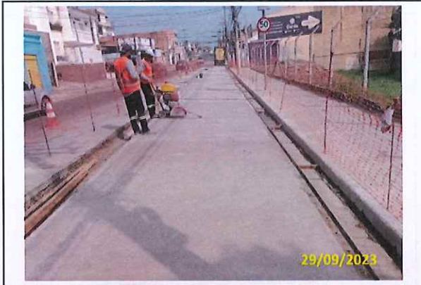
Foto 15 Corte das juntas de dilatação
