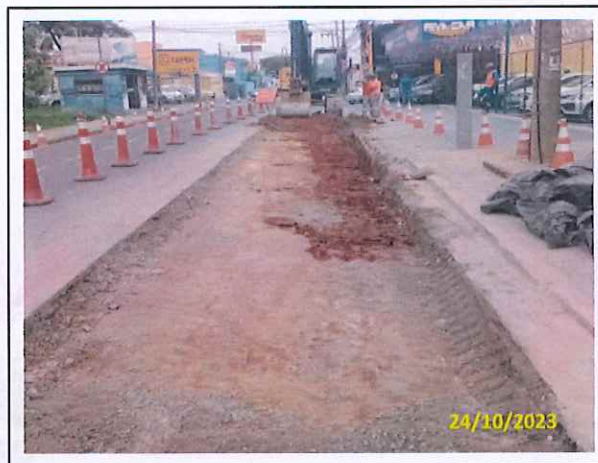
Foto 03 Tratamento de solo borrachado
