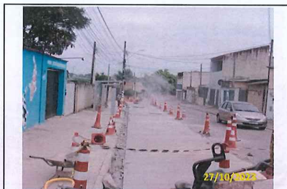
Foto 55 Corte das juntas de dilatação
