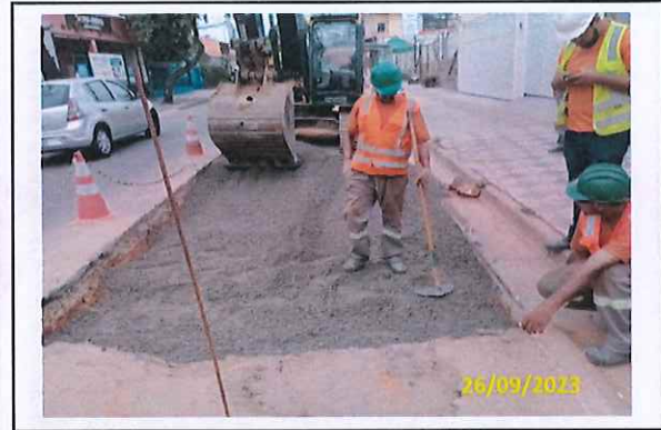
Foto 60 Aplicação de BGS
