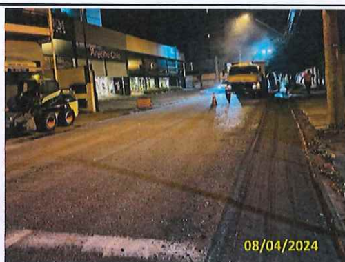
Foto 77 Fresagem em andamento (Sentido centro)
