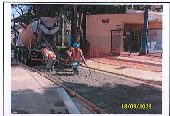
Foto 19 Aplicação de CCP
