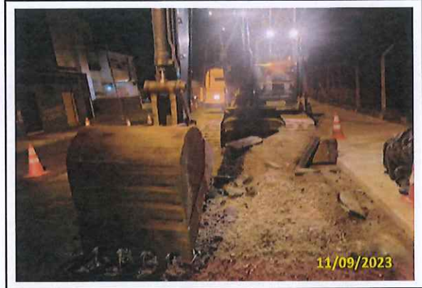
Foto 08 Demolição e escavação
