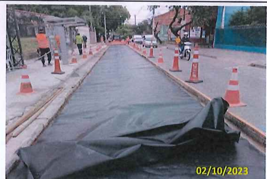
Foto 62 Instalação de lona
