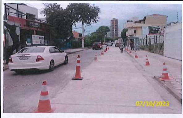
Foto 65 Tratamento de juntas e fissuras
