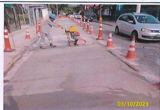
Foto 64 Corte das juntas do pavimento
