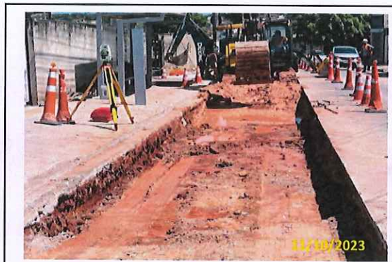
Foto 49 Remoção de solo saturado
