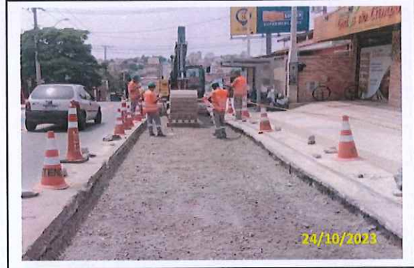
Foto 32 Aplicação de BGS
