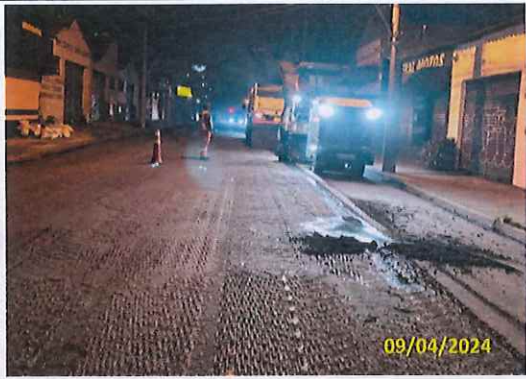
Foto 79 Continuação da fresagem (Sentido centro)
