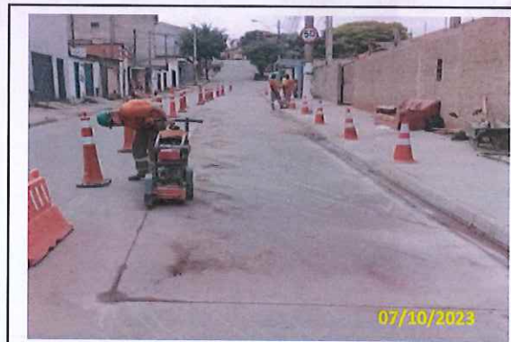
Foto 47 Corte para o pavimento rígido
