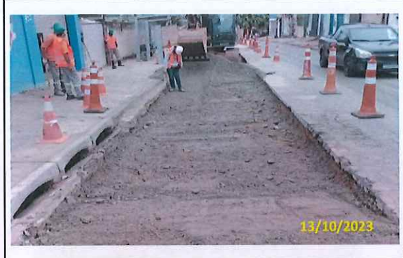
Foto 51 Lançamento de BGS
