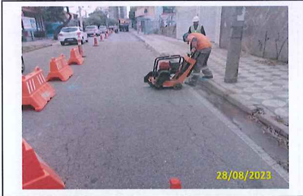
Foto 57 Corte do pavimento existente
