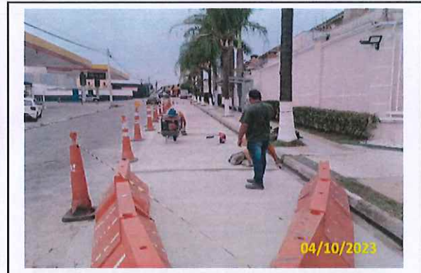
Foto 74 Tratamento de fissuras
