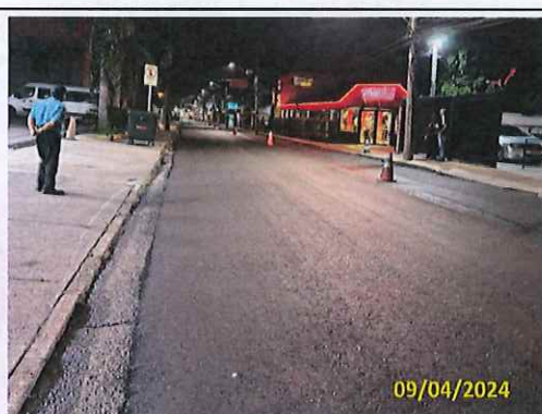
Foto 78 Aplicação de massa asfáltica (Sentido bairro)
