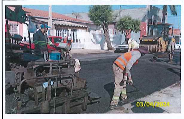
Foto 30 Aplicação de massa asfáltica
