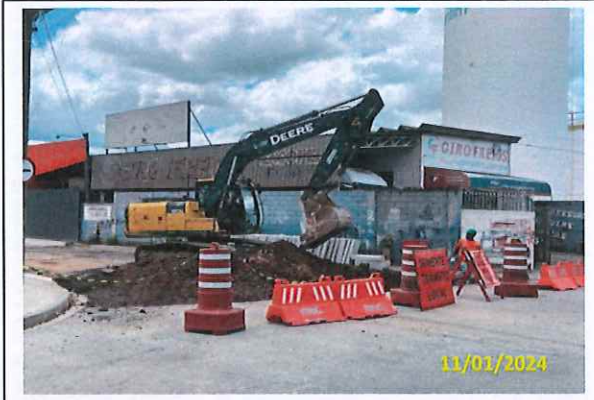
Foto 15 Início da escavação
