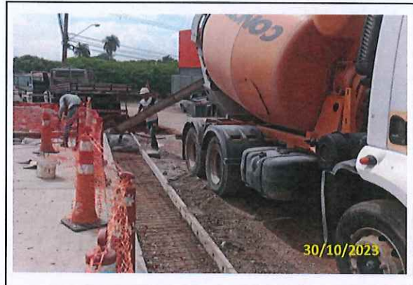
Foto 14 Concretagem do sarjetão
