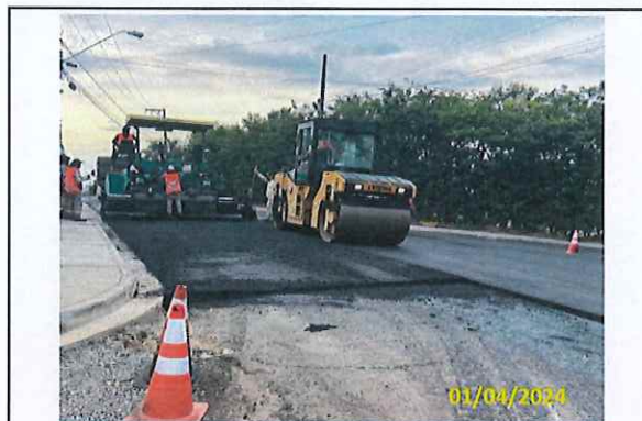
Foto 26 Aplicação de massa asfáltica em andamento
