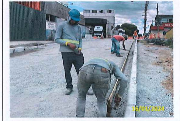
Foto 18 Montagem de formas da sarjeta
