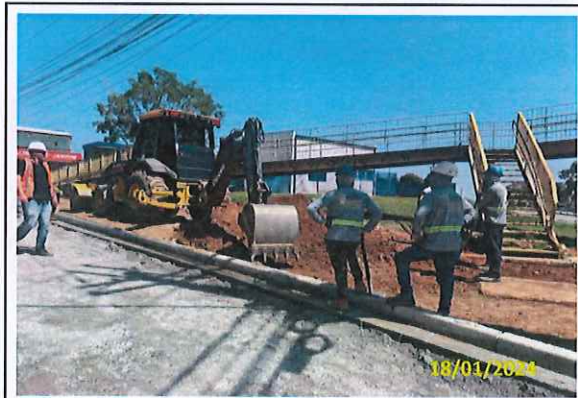
Foto 20 Nivelamento da base para execução da calçada
