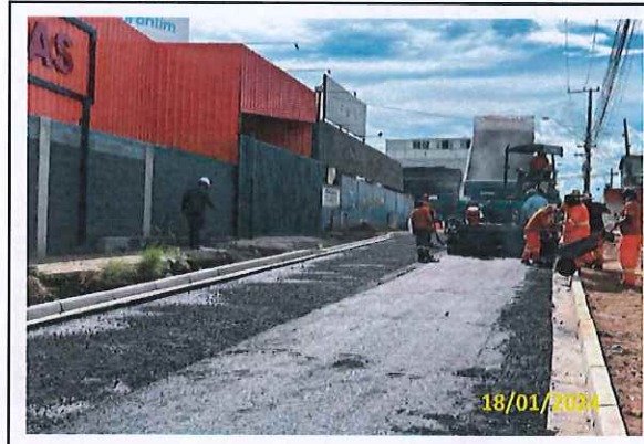
Foto 22 Aplicação de massa asfáltica
