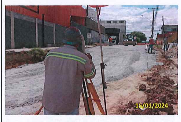
Foto 17 Marcação de cotas
