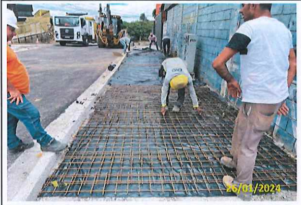
Foto 23 Aplicação de lona e tela metálica
