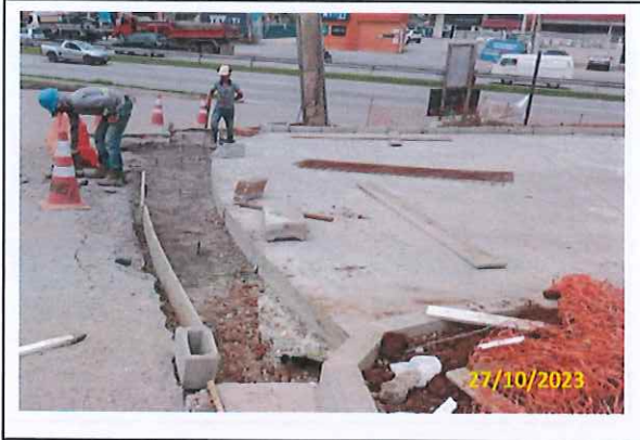
Foto 13 Montagem de formas para o sarjetão
