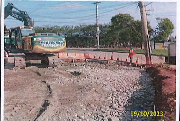
Foto 08 Aplicação de rachão
