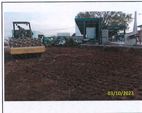
Foto 02 Compactação com rolo de pé carneiro
