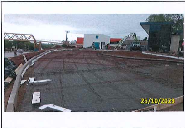
Foto 11 Preparo para aplicação do CCP
