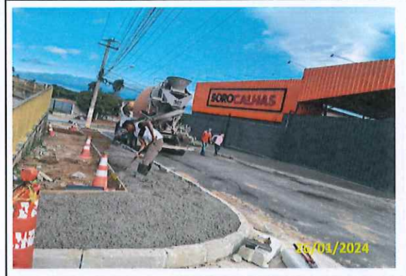
Foto 24 Concretagem do passeio
