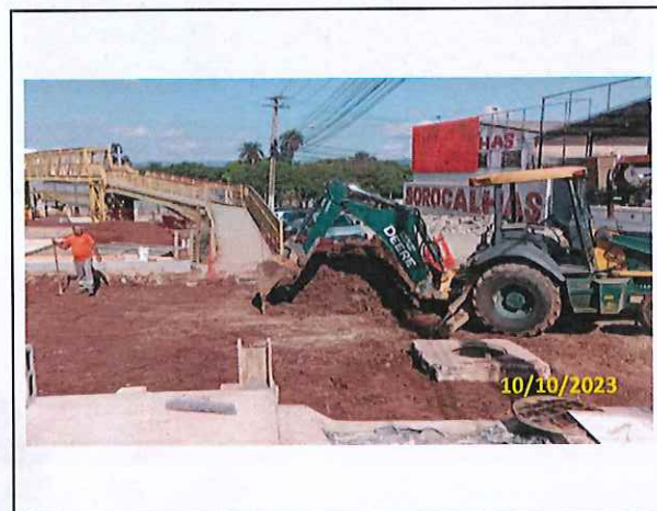
Foto 03 Remoção de camada saturada de solo
