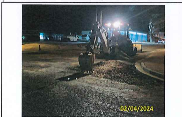
Foto 27 Escavação para reforço de sub-base
