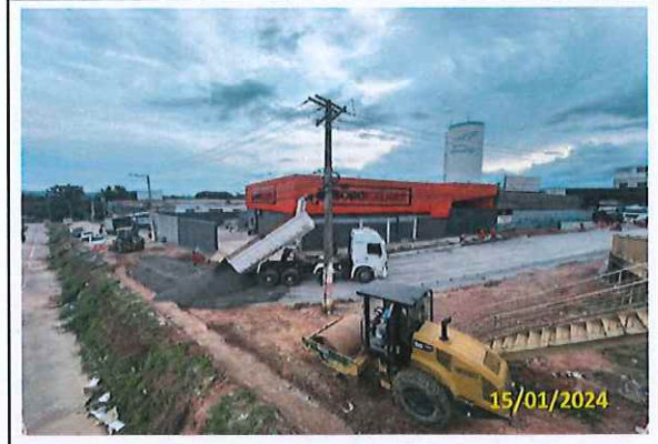
Foto 16 Aplicação de BGS
