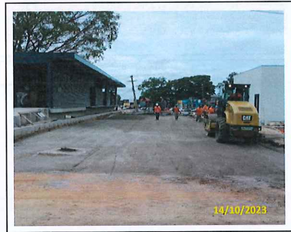
Foto 04 Aplicação de BGS
