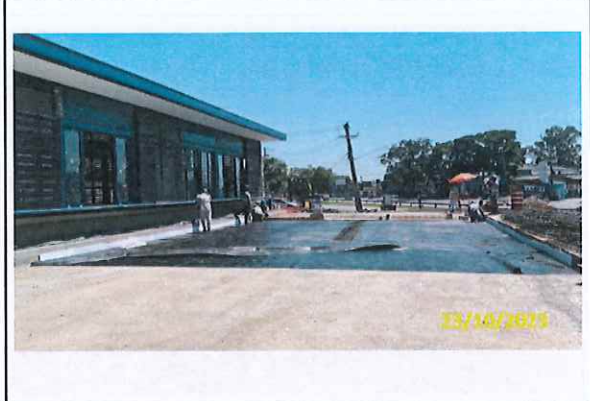
Foto 10 Instalação de lona, isopor e barras de transferência
