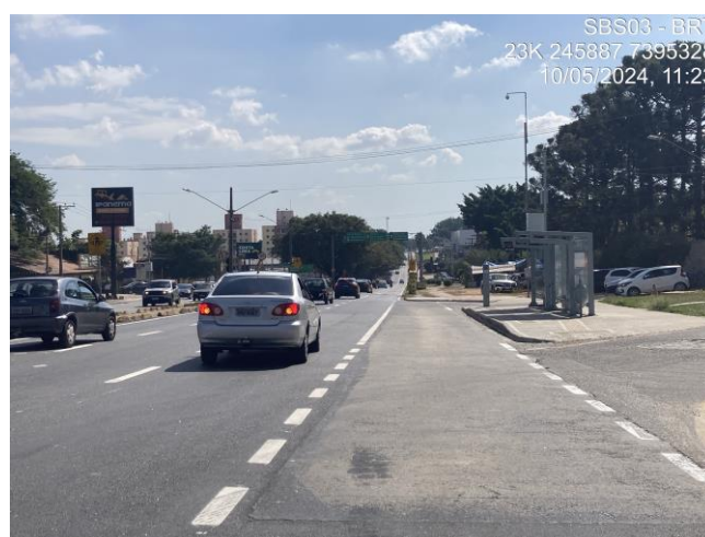
Fotos 1 e 2: Início do trecho 01 – Estaca 240, pavimentação flexível e ponto de parada (Pav. Rígido).
