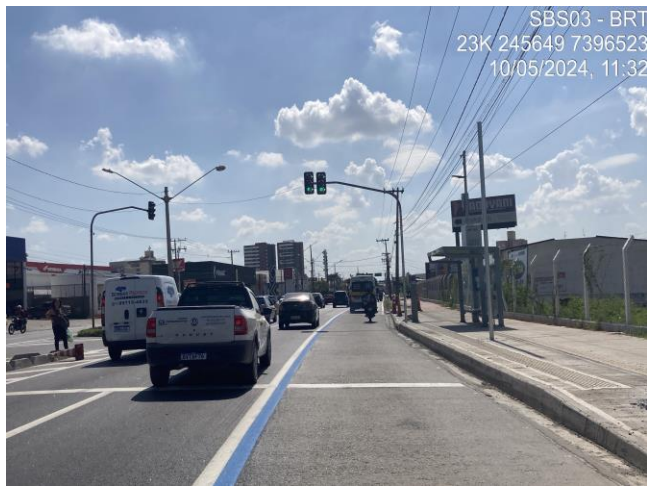
Fotos 9 e 10: Pavimento flexível e rígido executados.
