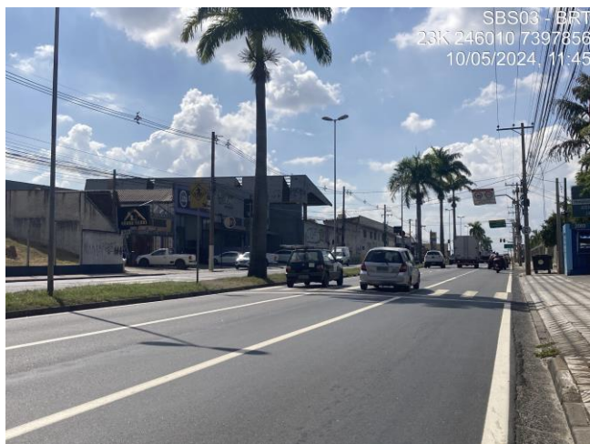
Fotos 21 e 22: Trecho 03 com o novo revestimento asfáltico, fim do trecho.
