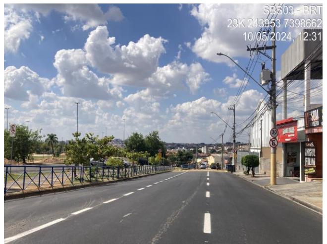
Fotos 01 a 18: Trecho 05 com o novo revestimento asfáltico e Pontos de Paradas com pavimento rígido. Sentido Bairro.
