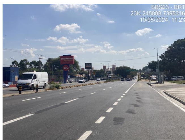
Fotos 1 e 2: Início do trecho 01 – Estaca 240, pavimentação flexível e ponto de parada (Pav. Rígido).
