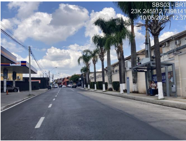
Fotos 19 a 32: Trecho 05 com o novo revestimento asfáltico e Pontos de Paradas com pavimento rígido. Sentido Centro.
