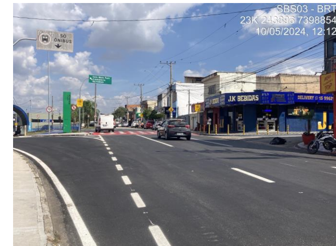
Fotos 01 a 18: Trecho 05 com o novo revestimento asfáltico e Pontos de Paradas com pavimento rígido. Sentido Bairro.
