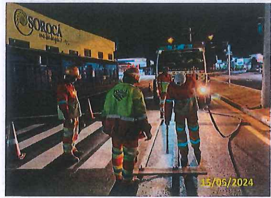
Foto 14 Pintura da travessia em andamento
