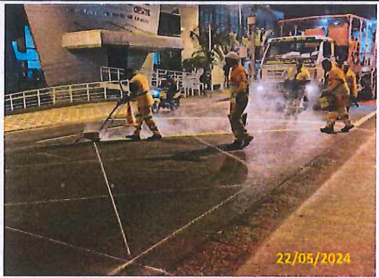
Foto 16 Pintura da área de conflito em andamento
