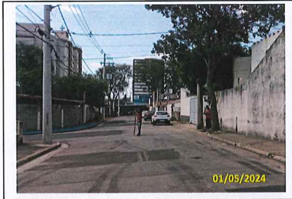
Foto 11 Instalação de placas (Rua Santa Teresa)
