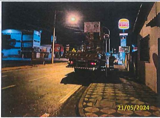
Foto 15 Instalação de placa
