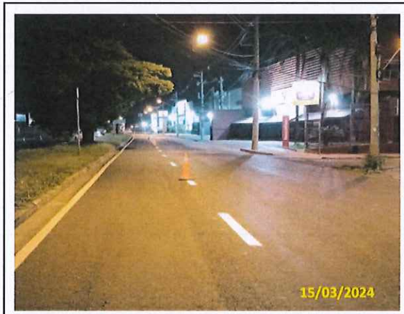
Foto 04 Pintura da faixa seccionada
