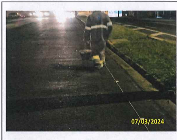
Foto 02 Demarcação para sinalização horizontal
