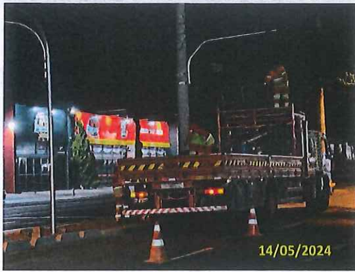
Foto 13 Instalação de placa
