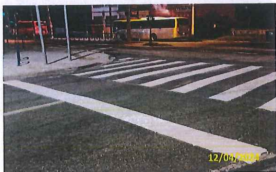
Foto 07 Pintura de travessia
