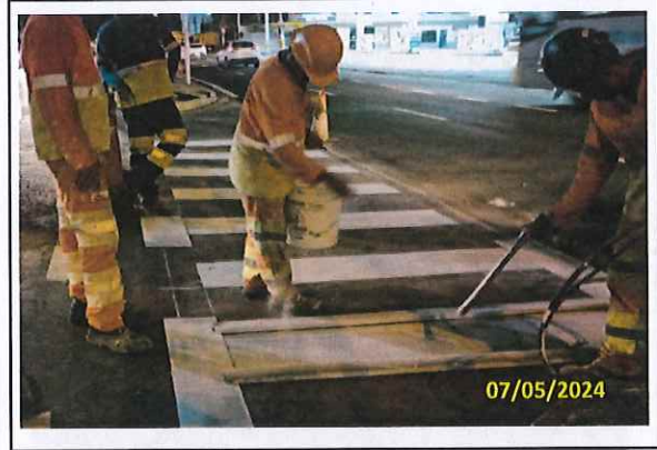
Foto 12 Pintura da travessia de pedestres (Próx. a R. Içara)
