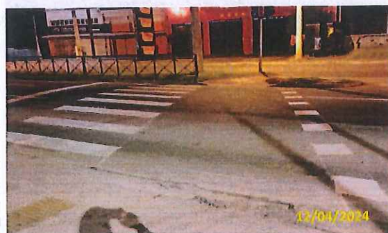
Foto 08 Pintura de travessia
