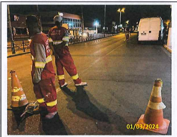
Foto 01 Início da marcação para sinalização horizontal
