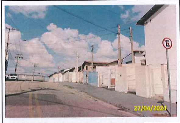
Foto 10 Instalação de placas
