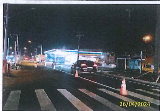
Foto 05 Demarcação em andamento
