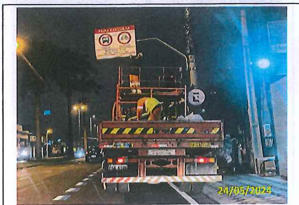
Foto 13 Instalação de placa
