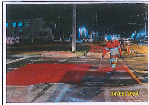
Foto 14 Pintura de travessia
