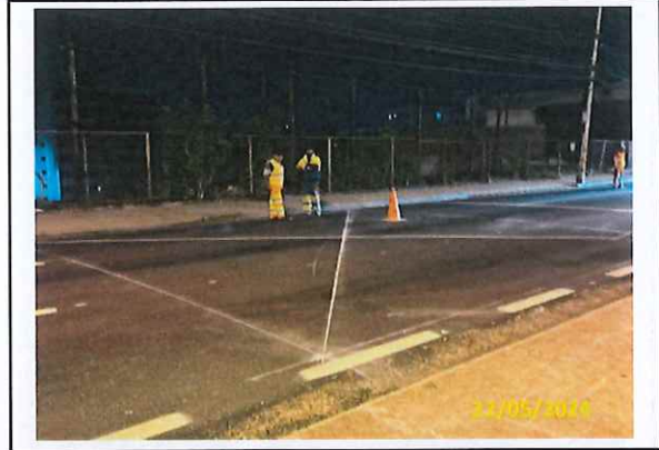
Foto 10 Marcação para pintura da área de conflito
