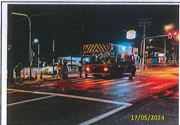
Foto 08 Pintura de travessia
