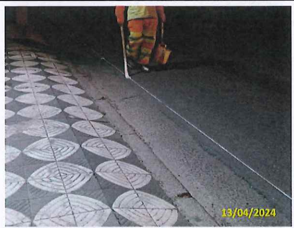
Foto 01 Demarcação para sinalização horizontal em andamento
