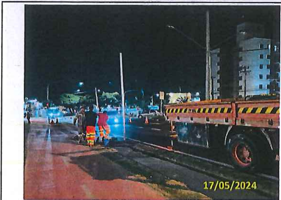
Foto 07 Instalação dos postes de sinalização
