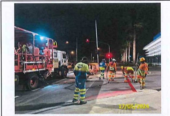
Foto 09 Pintura de travessia
