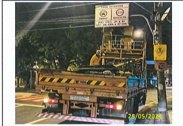
Foto 10 Instalação de placas
