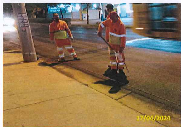
Foto 01 Demarcação para sinalização horizontal em andamento
