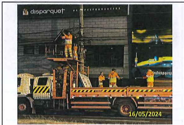
Foto 07 Instalação de placas
