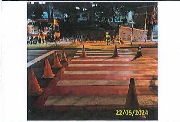
Foto 09 Pintura de travessia
