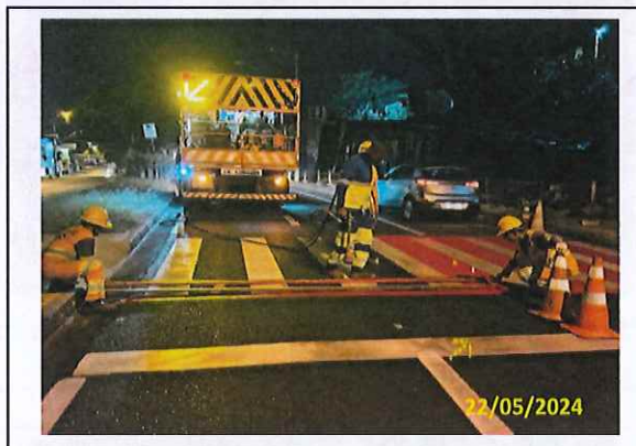
Foto 08 Pintura de travessia
