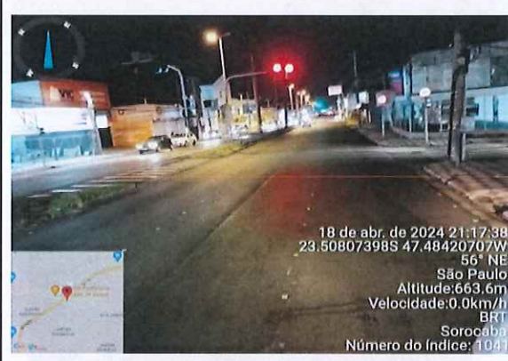
Foto 02 Demarcação para sinalização horizontal
