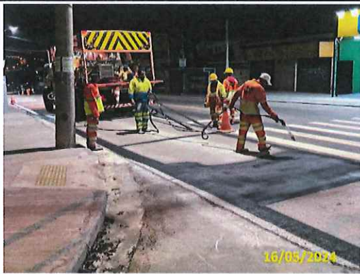
Foto 11 Sinalização horizontal em andamento
