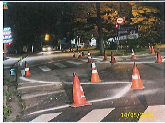
Foto 10 Sinalização horizontal executada
