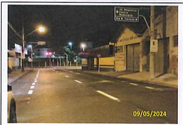
Foto 07 Pintura das faixas seccionadas
