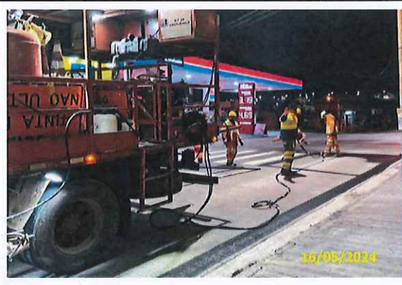
Foto 12 Sinalização horizontal em andamento
