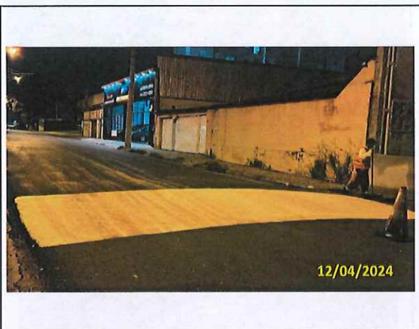
Foto 01 Pintura de lombada
