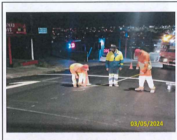
Foto 02 Pintura horizontal em andamento
