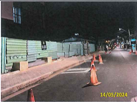
Foto 09 Sinalização horizontal executada
