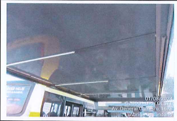
Foto 101 Interior do abrigo secundário
