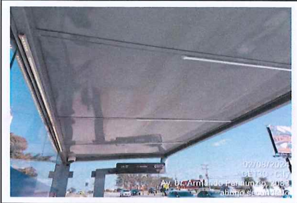
Foto 72 Interior do abrigo secundário
