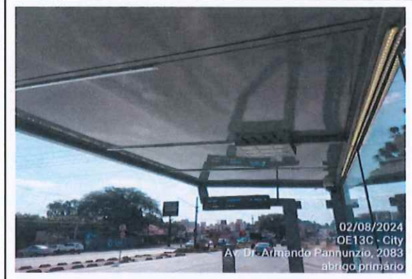
Foto 71 Interior do abrigo primário
