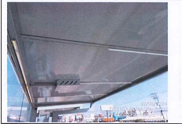
Foto 58 Interior do abrigo secundário
