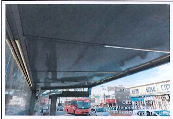
Foto 102 Interior do abrigo terciário
