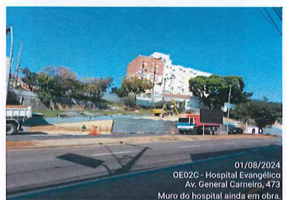
Foto 04 Abrigo removido conf. solicitado para a obra do Hospital Evangélico
