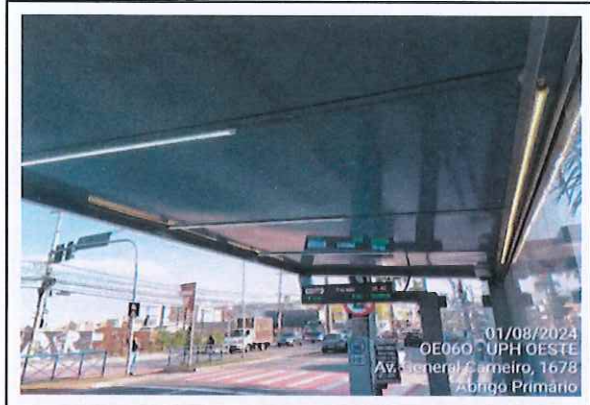
Foto 100 Interior do abrigo primário
