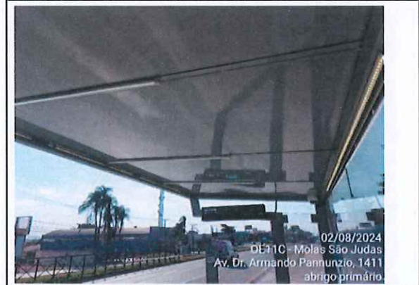
Foto 57 Interior do abrigo primário
