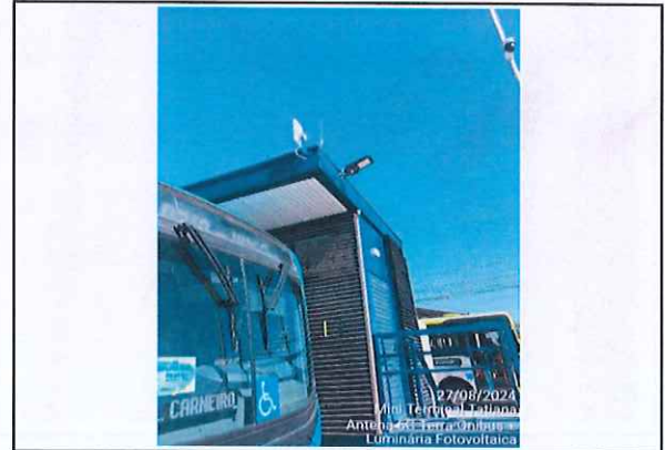
Foto 207 Antena 5G e luminária fotovoltaica
