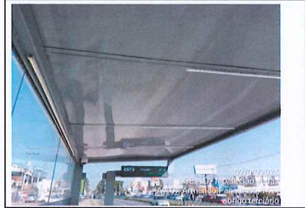
Foto 59 Interior do abrigo terciário
