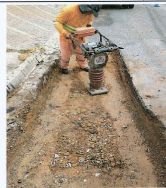
Abertura de caixa na Rua A. Scudeler
