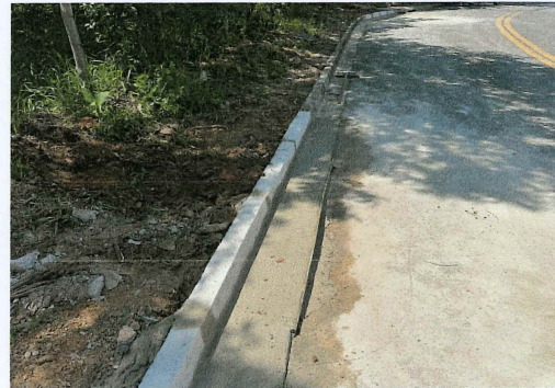
Reparo em Guias e sarjetas - Rua A. Scudeler
