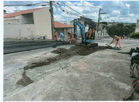
Reforço de Sub-leito na Rua A. Scudeler
