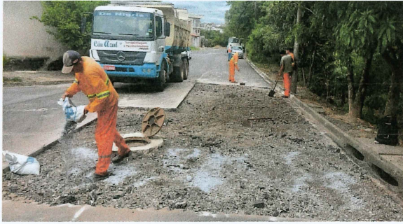
Reforço de Sub-leito na Rua A. Scudeler
