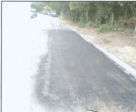
Aplicação de Binder na Rua A. Scudeler
