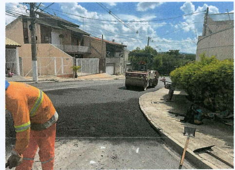
Aplicação de CBUQ na Rua A. Scudeler
