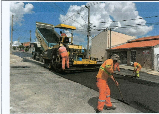
Aplicação de CBUQ na Rua A. Scudeler
