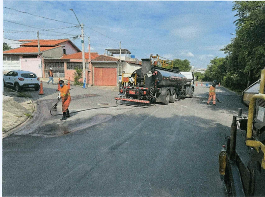
Imprimadura ligante na Rua A. Scudeler
