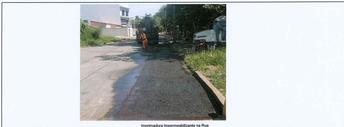
Imprimadura impermeabilizante na Rua
