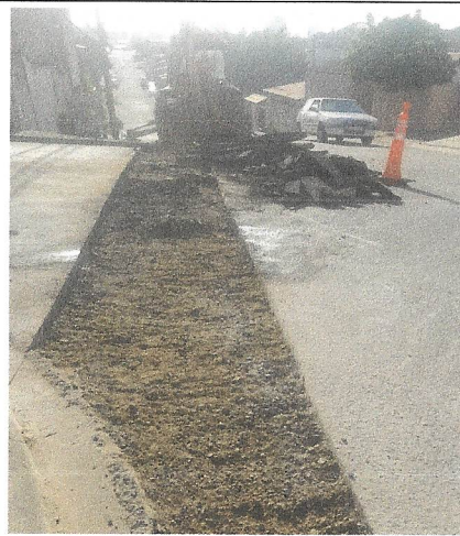
Demolição de pavimento na rua Matheus Haddad
