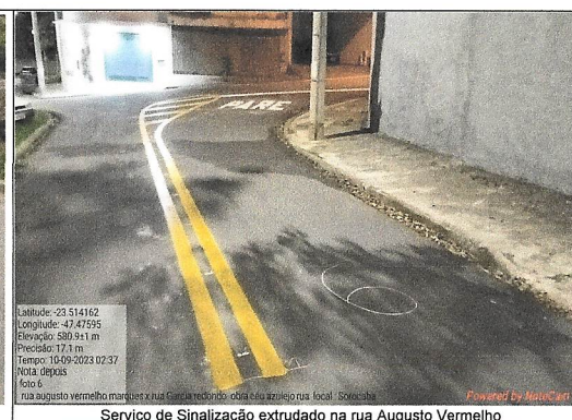
Serviço de Sinalização extrudado na rua Augusto Vermelho
