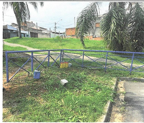
Pintura de gradil na rua José Rodrigues
