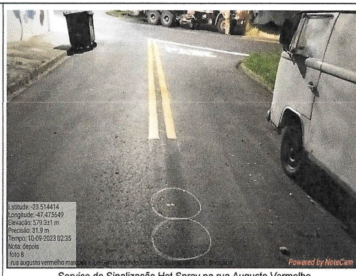
Serviço de Sinalização Hot Spray na rua Augusto Vermelho
