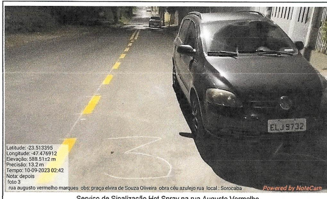
Serviço de Sinalização Hot Spray na rua Augusto Vermelho
