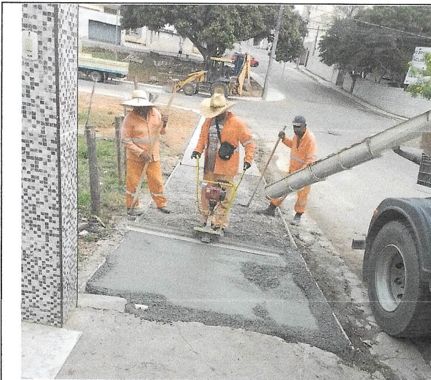
Execução de calçada na R. Augusto Vermelho
