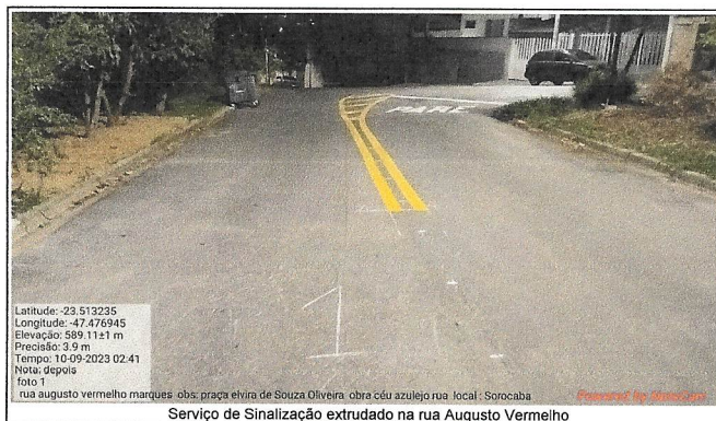
Serviço de Sinalização extrudado na rua Augusto Vermelho
