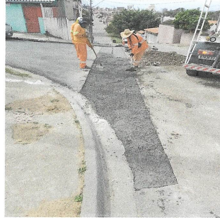
Execução de sarjetão na rua Matheus Haddad
