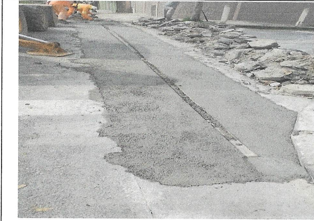
Execução de sarjetão na rua Matheus Haddad
