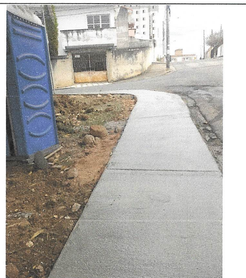
Execução de calçada na R. Augusto Vermelho
