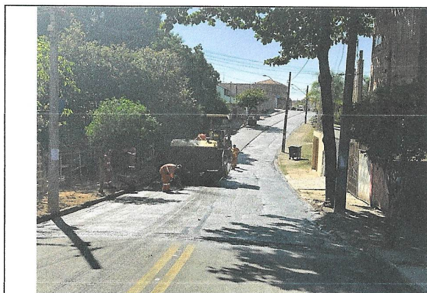
Aplicação de CBUQ na rua Cesarmino Pires
