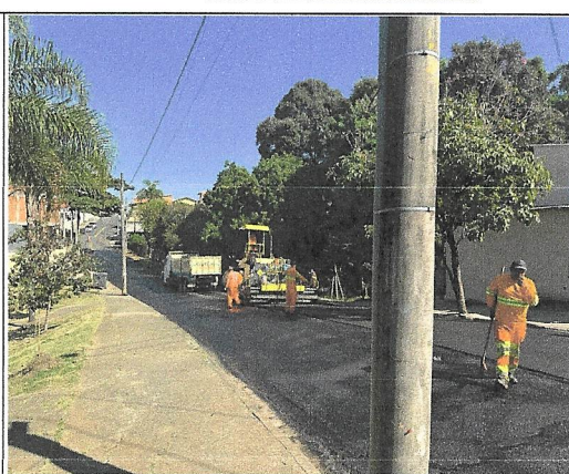
Aplicação de CBUQ na rua Cesarmino Pires
