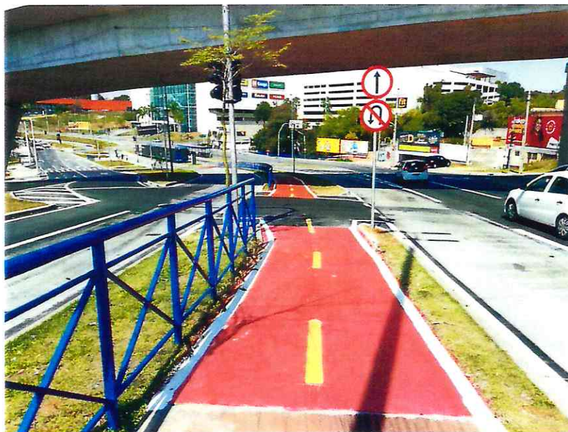
Foto 35 - Pintura executada conforme solicitado pela fiscalizadora.
