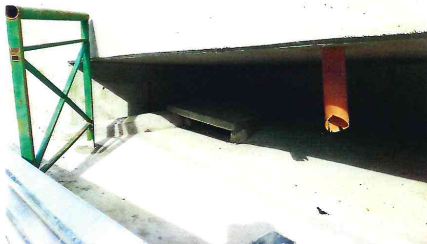
Foto 16 - Execução de tampa de concreto em caixa de captação de água.
