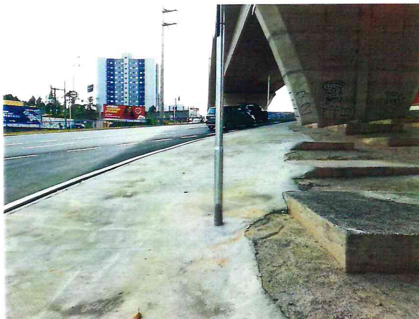
Foto 03 - Melhora no acabamento do concreto utilizado no chumbamento do poste. Com esta solução obteve-se um melhor aspecto no acabamento.
