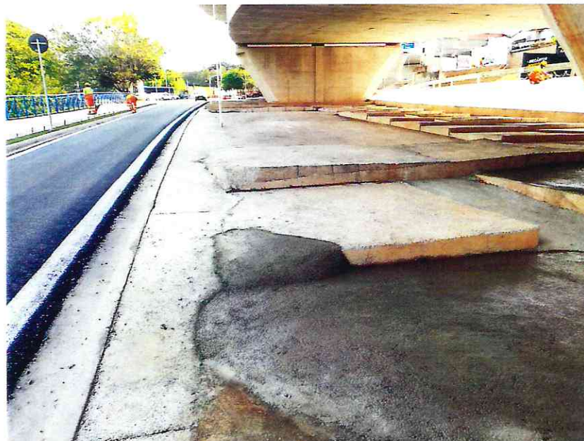
Foto 32 - Execução de reparo em base de concreto.
