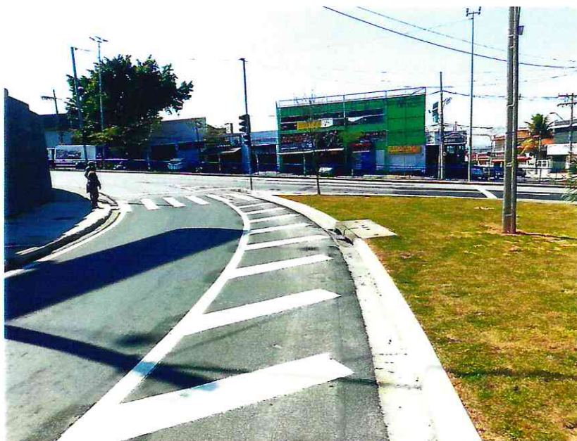
Foto 12 - Execução de pintura horizontal e instalação de tachão.
