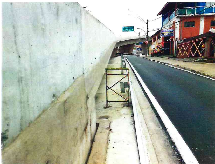
Foto 18 - Instalação de gradil com função de impedir o trânsito de pedestres.
