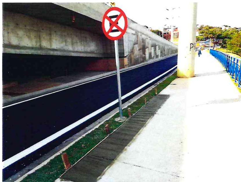
Foto 02 - Execução de reparo de calçada, atendendo a solicitação da fiscalizadora.
