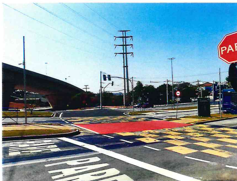
Foto 36 - Pintura executada parcialmente.
