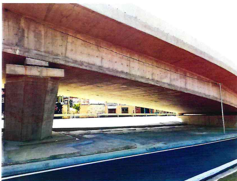
Foto 21 - Cabos aparentes e mal tensionados.
