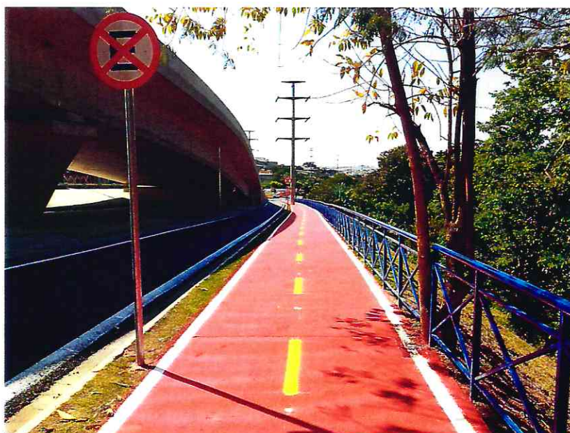
Foto 23 - Execução de pintura de ciclovia.
