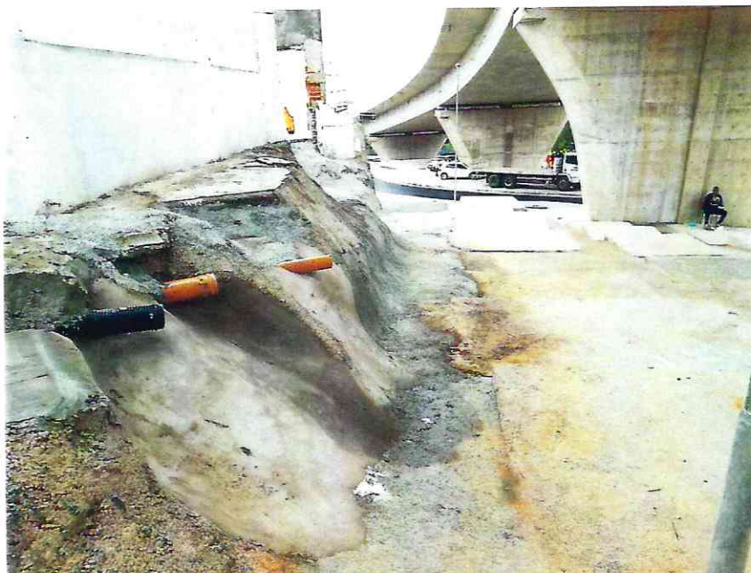
Foto 05 - Reparo em ponto de saída de água.
