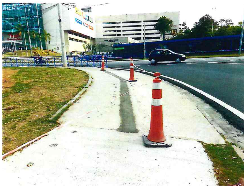
Foto 26 - Execução de remoção de piso tátil direcional excedente.
