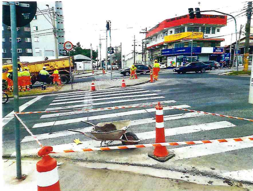
Foto 11 - Execução de calçada no canteiro central e rebaixamento de guia.
