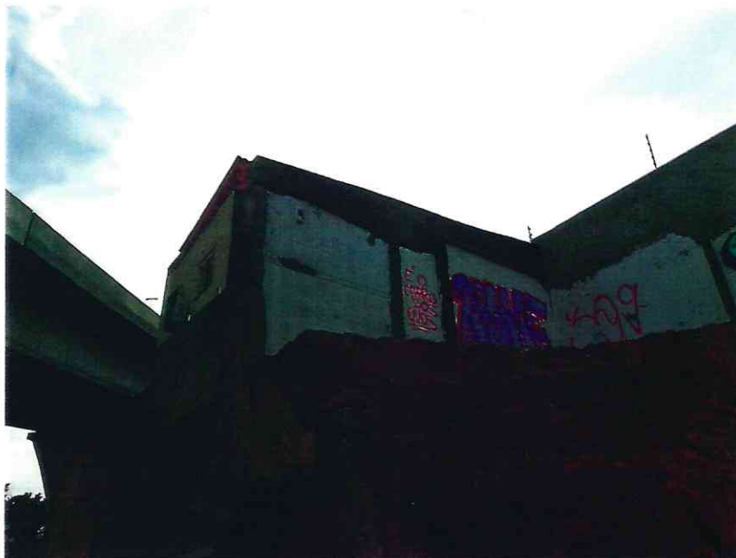
Foto 30 - Reparo de muro residencial danificado durante a obra.
