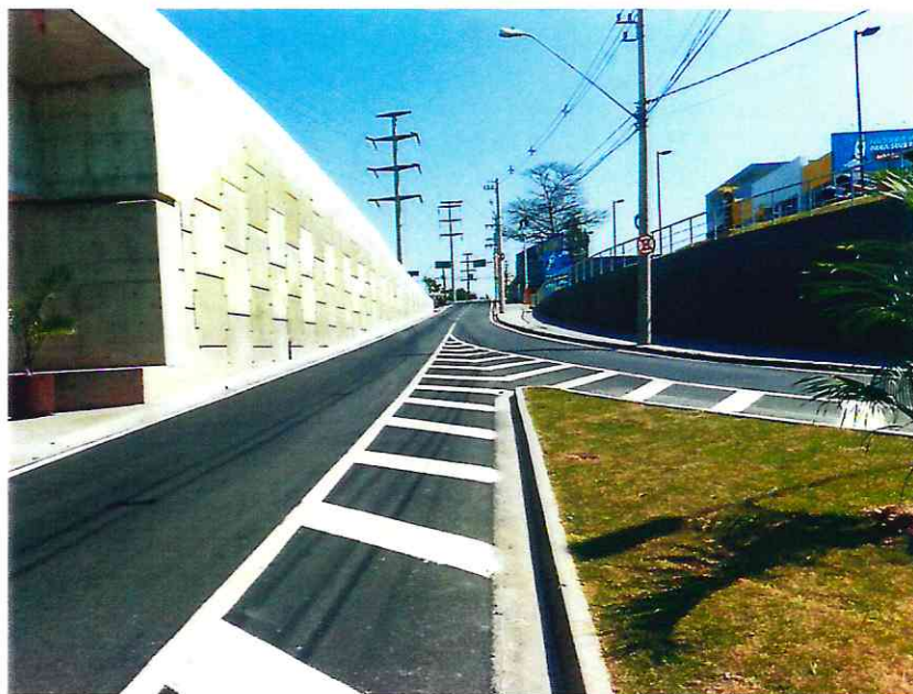
Foto 28 - Ausência de tachão.
