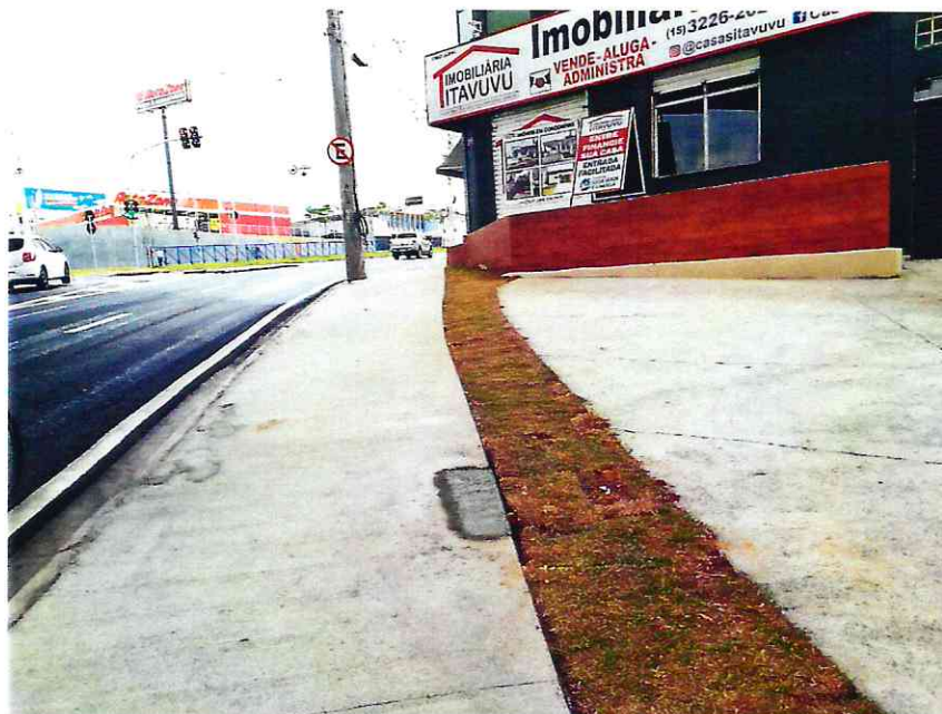
Foto 25 - Execução de reparo de calçada, atendendo a solicitação da fiscalizadora.
