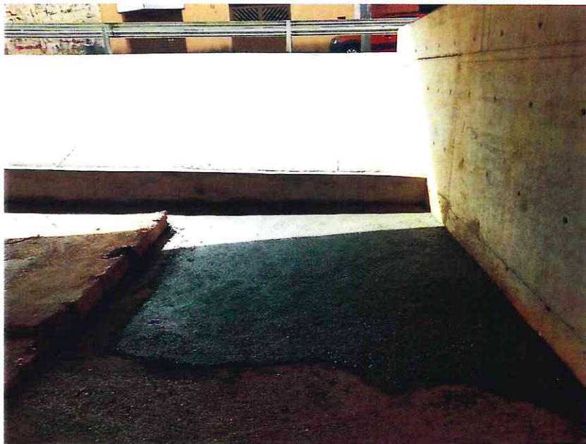
Foto 22 - Correção no caimento de contra piso de concreto.
