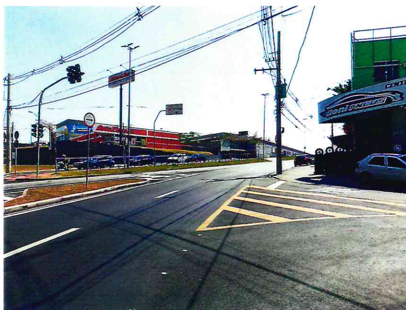
Foto 13 - Faixa zébrada amarela sem concordância.
