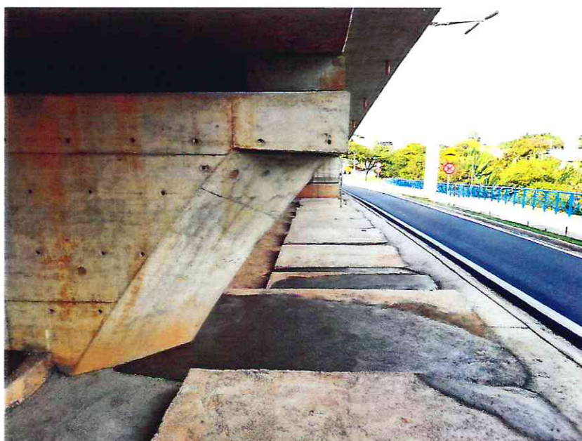
Foto 19 - Correção no caimento de contra piso de concreto.
