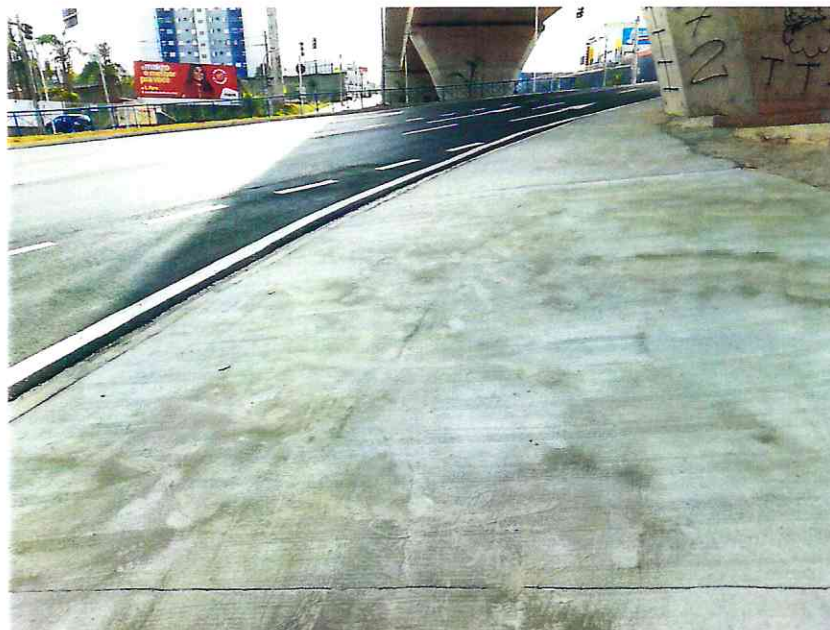
Foto 09 - Execução de reparo em calçada com fissuras.
